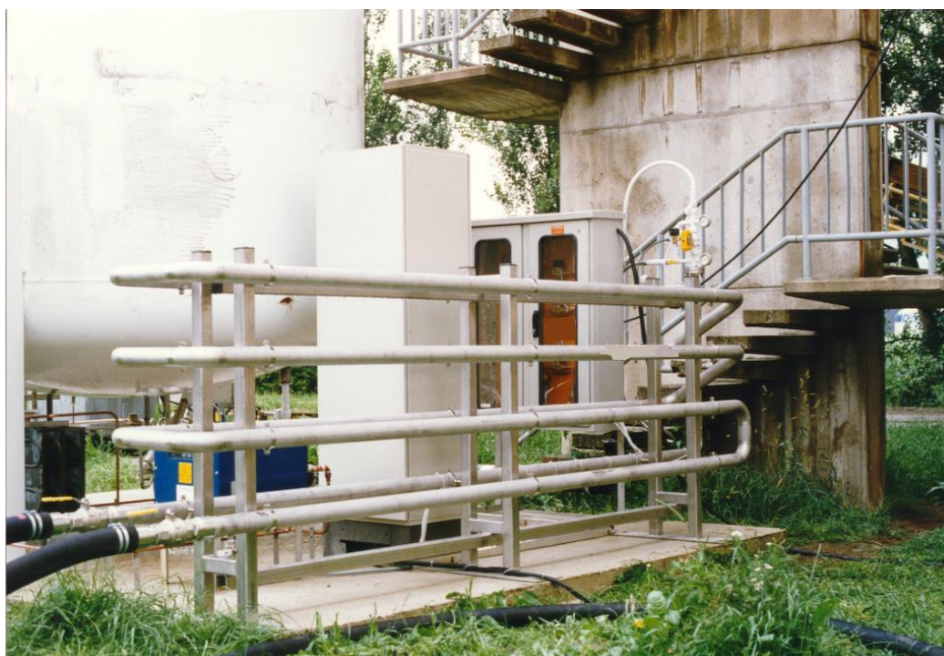
Obr. 7 Príklad realizácie rúrkového neutralizačného reaktora
