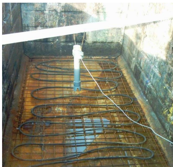
Obr. 10 Zaplyňovací rošt v nádrži
