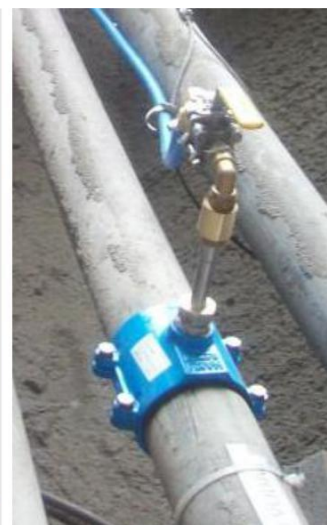
Obr. 4 príklad realizácie dávkovania CO 2 do potrubia
