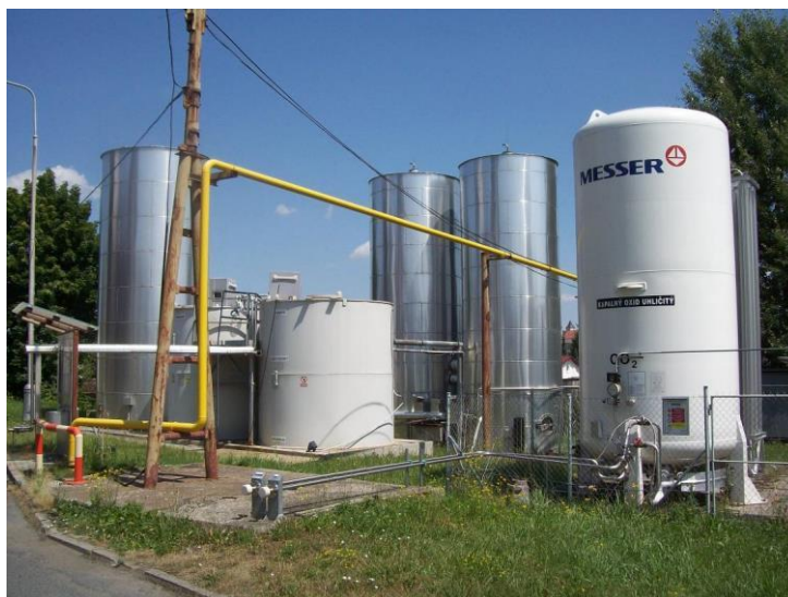
Obr. 5 Príklad inštalácie CO 2 stanice ako náhrady za H 2 SO 4 (mliekareň v ČR)
