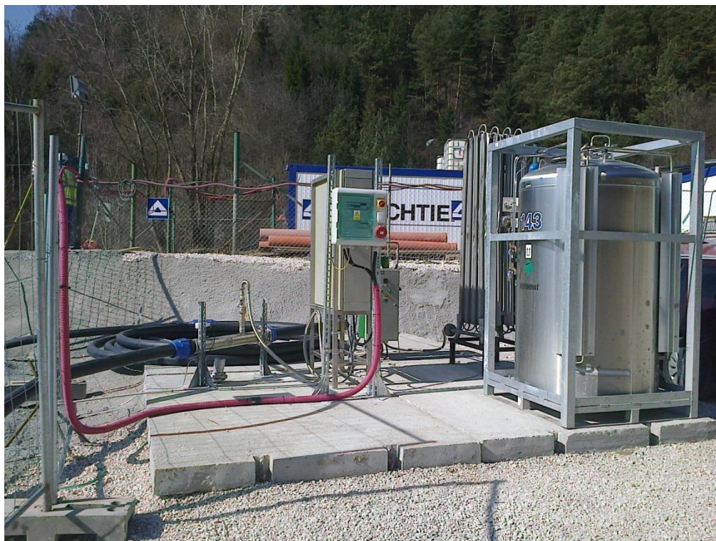
Obr. 8 Príklad inštalácie pri razení tunela.
