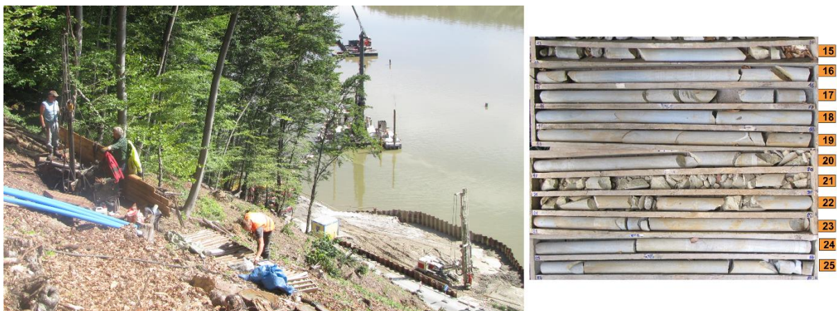
Obr. 10 Realizácia inklinometrického vrtu a geologická dokumentácia vrtného jadra
