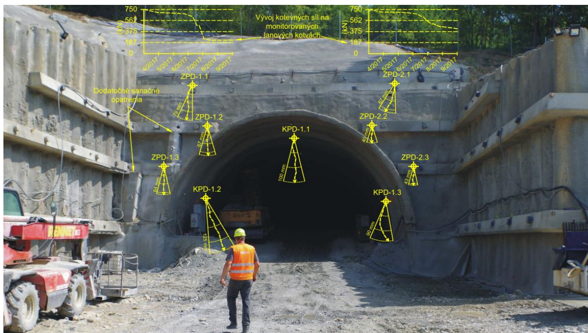
Obr. 6 Vývoj deformácií čela portálovej steny (body ZPD) a prvého konvergenčného profilu (body KPD).
