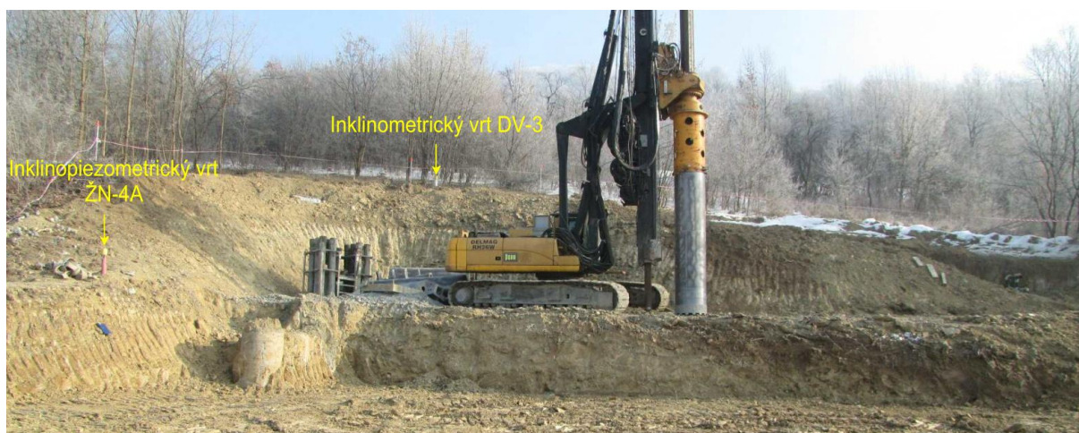
Obr. 4 Pozícia inklinometrických vrtov a realizácia pilótovej steny
