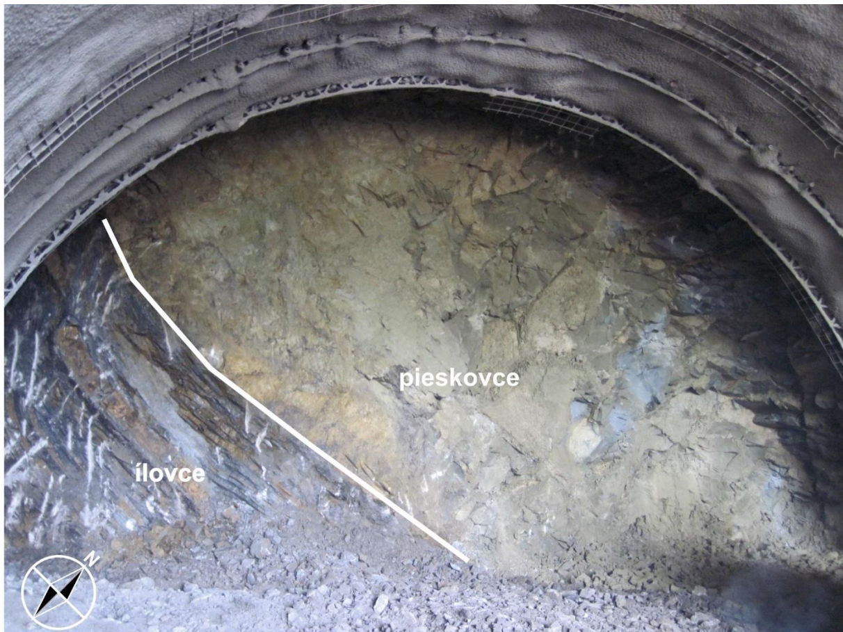
Obr. 3 Kalota VK-0023 – ilovce na kontakte s pieskovcami. Staničenie kaloty: 836,5m (foto: Szabó).
