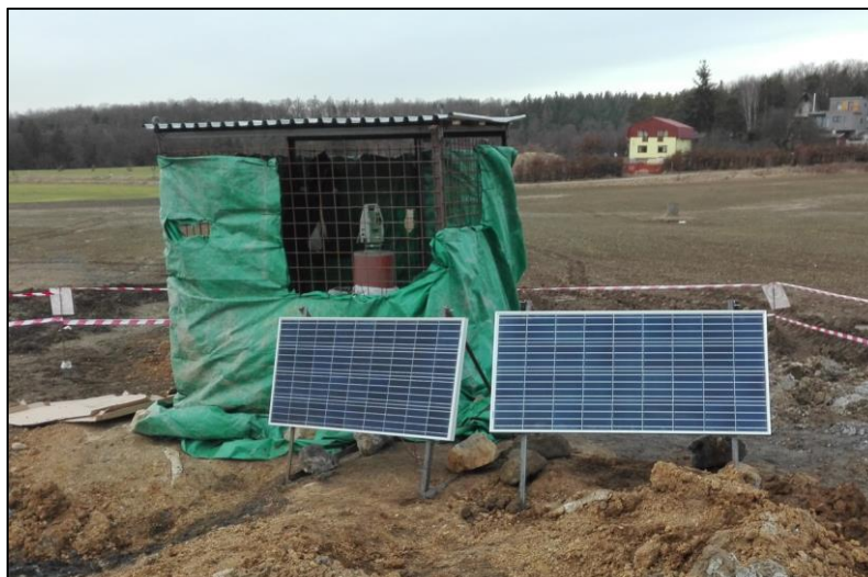
Obr. 6 Stanoviště automatického monitorovacího systému Zdroj: společnost GEOTest - Angermeier
