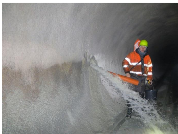
Obr. 5 Meranie prietoku v odtokovom žľabe prieskumnej štôlne a prítok vody STR Fig. 5 Measurement of flow in the drainage trough of the exploration gallery and water inlet STR Zdroj: Coplák, M., et al. 2018, CAD-ECO, a.s., Bratislava
