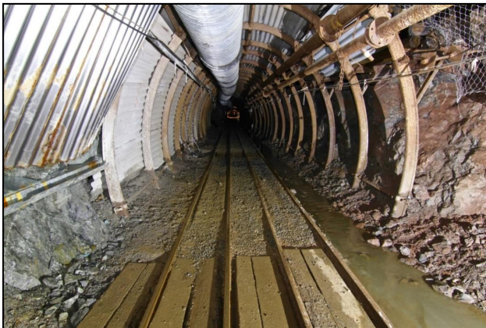
Obr. 5 Výztuž profilu hlavního překopu BZ-XIII
