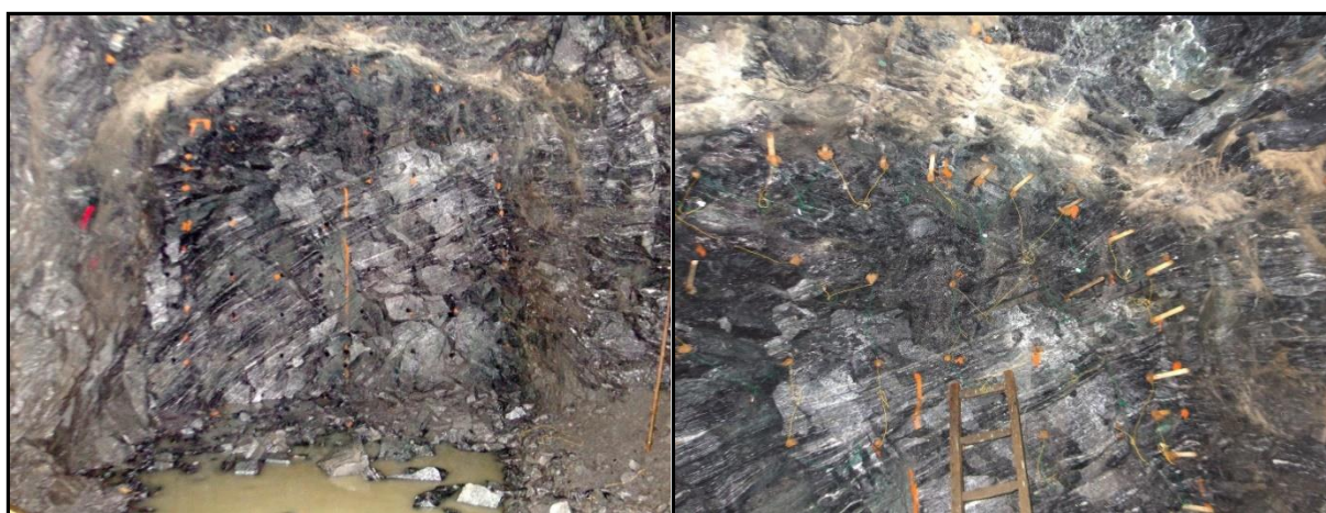
Obr. 8 Ukázka navrtané čelby pro přípravu trhací práce a detail nabité čelby v ZK-1
