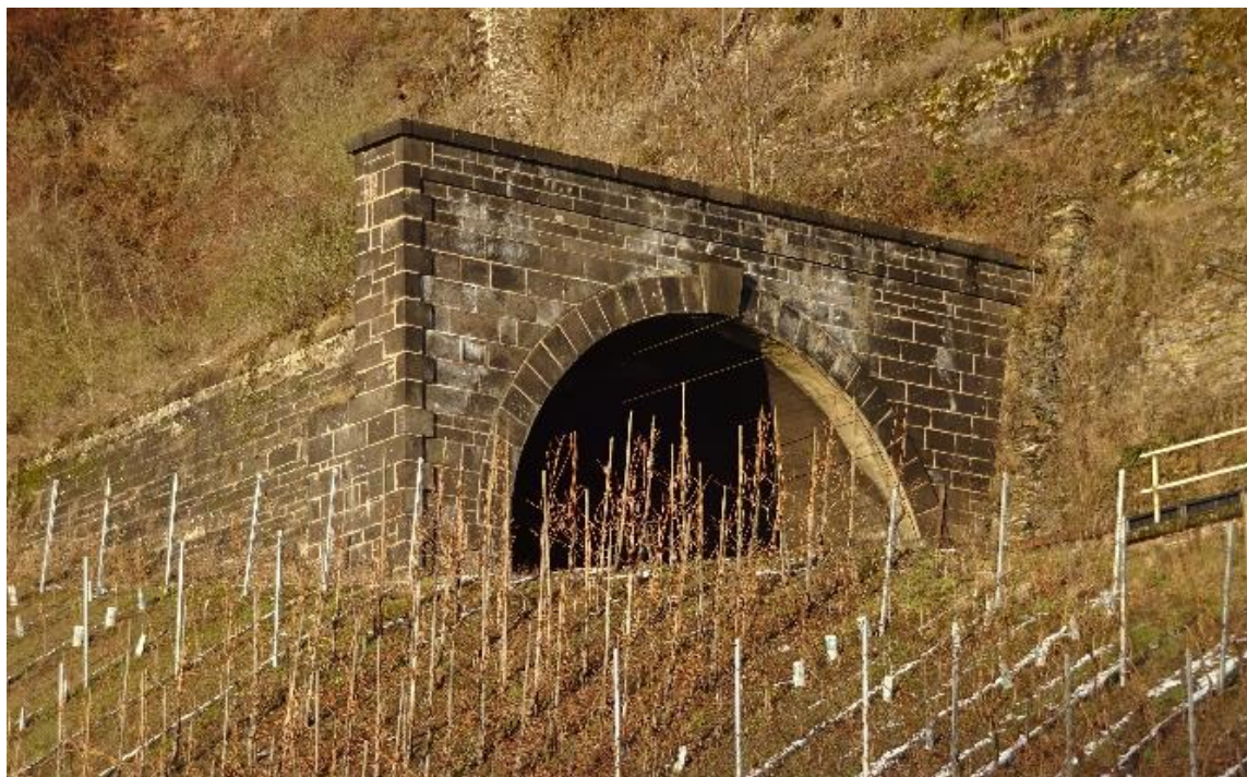
Obr. 3 Južný portál tunela (pôvodný stav)
