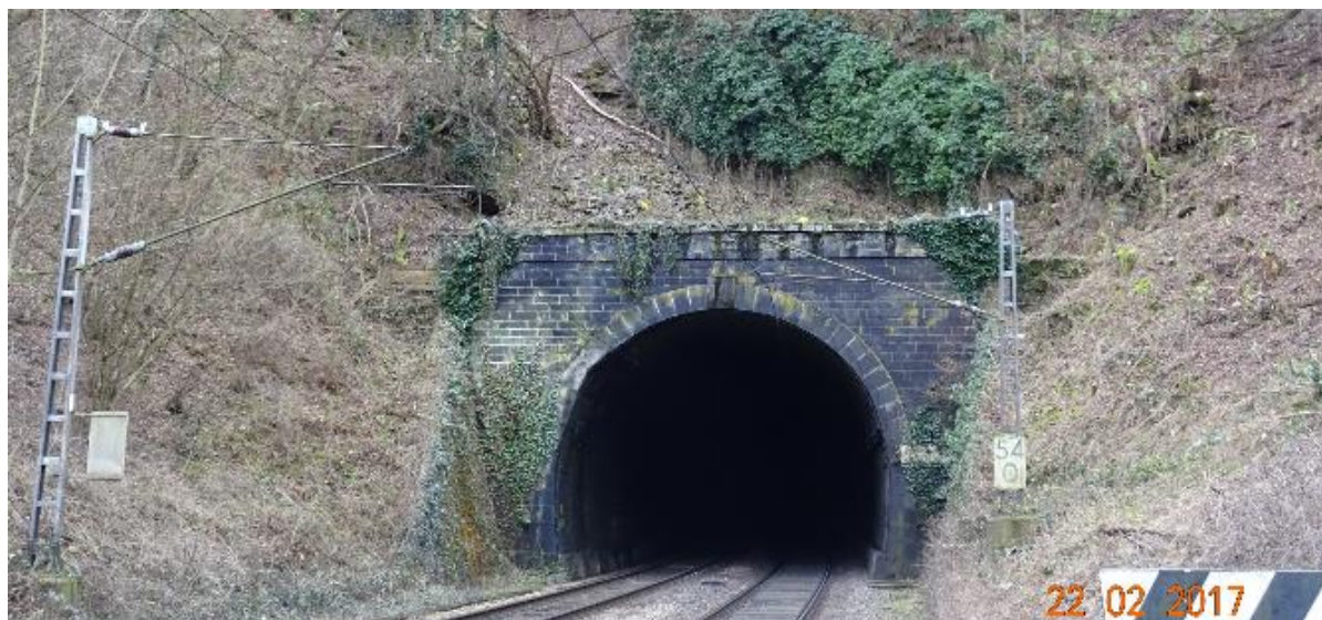
Obr. 4 Severný portál tunela (pôvodný stav)
