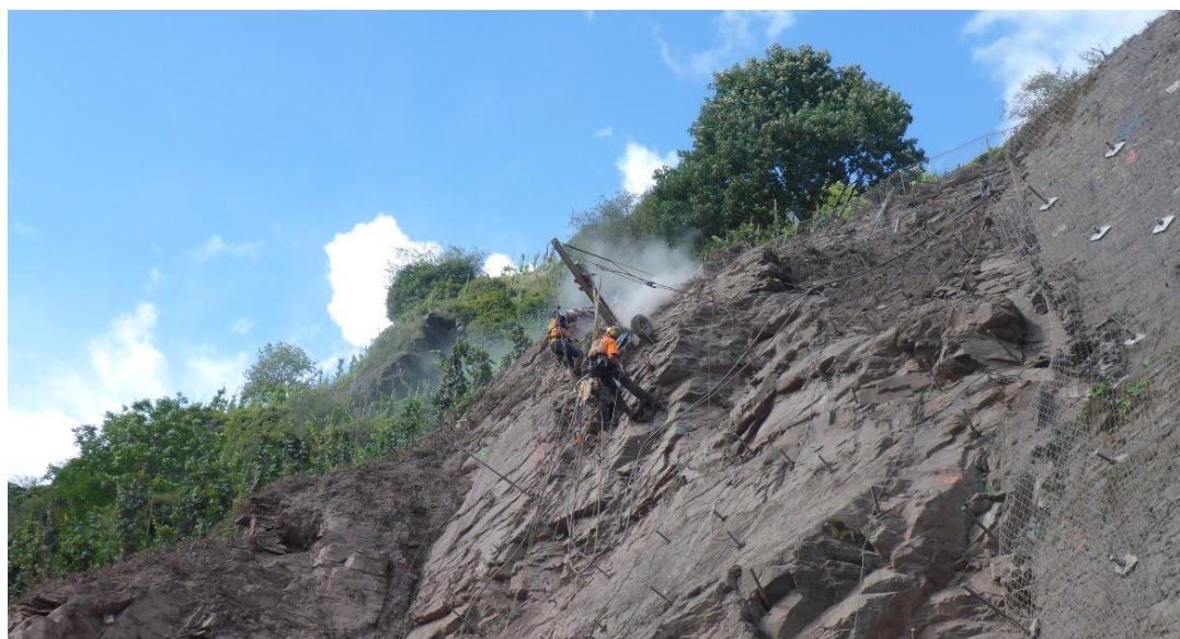
Obr. 5 Zaist'ovacie práce na svahu nad južným portálom
