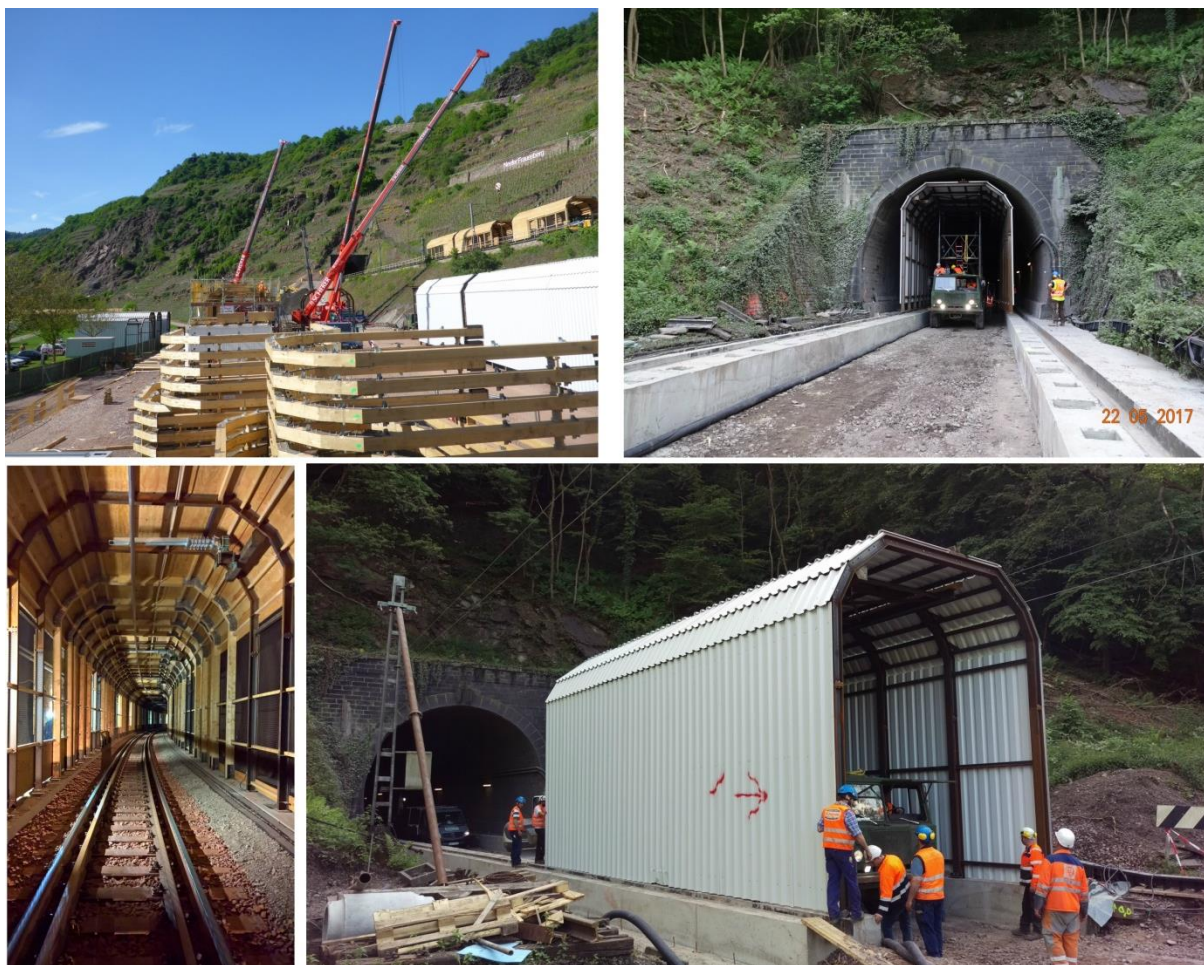
Obr. 9 Montáž ochrannej konštrukcie
