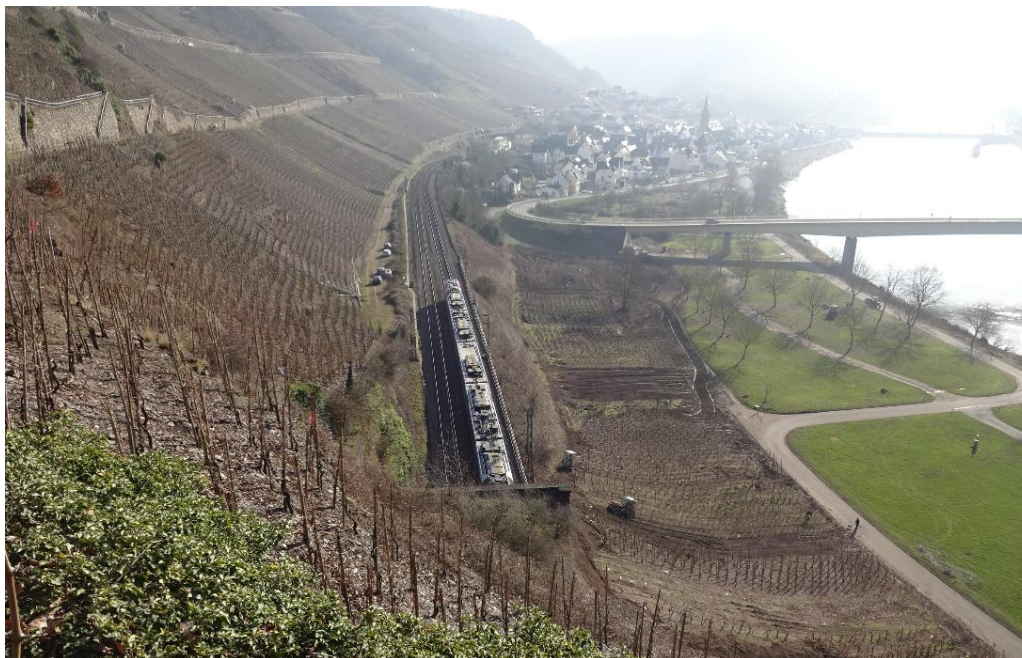
Obr. 1 Pôvodná situácia na mieste budúceho zariadenia staveniska (južný portál)
