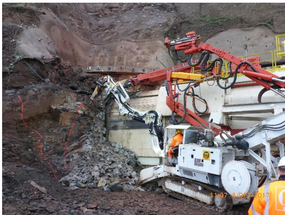
Obr. 14 Tunelový raziaci stroj ITC 112 počas výlomových prác na južnom portály
