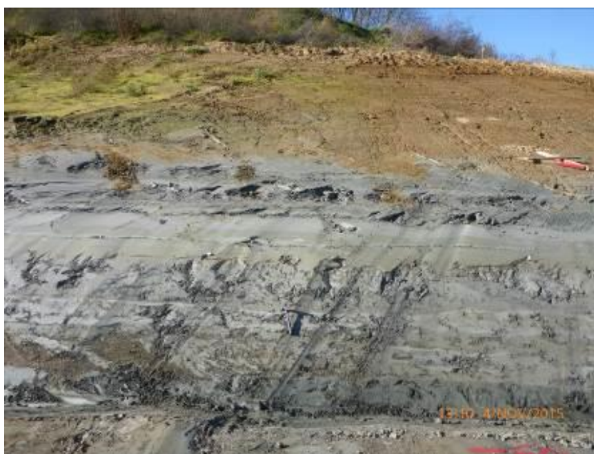
Obr. 16 Jemnozrnné jezerní sedimenty, překryté zvětralinami neogénních sedimentů, údolí Granitztal, stavební jáma přesypaného tunelu
