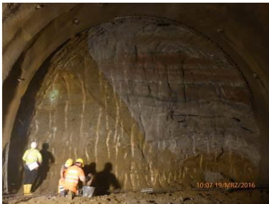
Obr. 6 Tektonická porucha oddělující slepence (pravá strana) a písčité prachovce, tunel Deutsch Grutschen 1
