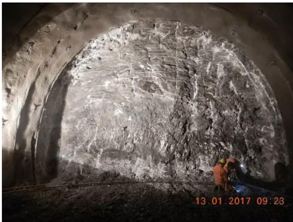
Obr. 10 Čelba v prostředí Werfenského souvrství, jemnozrné pískovce, jílovité břidlice, žilky sádrovce a anhydritu. Langer Berg 1, TM 1802,20
