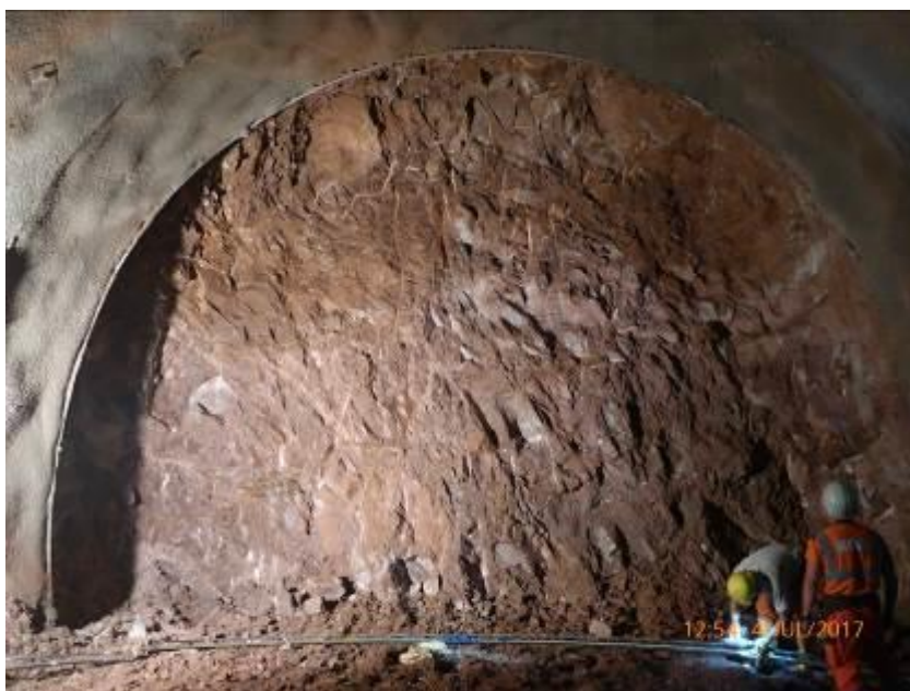
Obr. 14 Kalota v permských hrubozrnných pískovcích (spodní část) a jemnozrnných pískovcích až prachovcích (horní, tmavší část), Langer Berg 1, TM 2550,1
