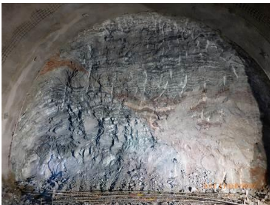
Obr. 9 Vrstevnaté dolomity a vápence, s patrnou „strukturou kostkového cukru“, tunel Langer Berg 2, TM 1886,3
