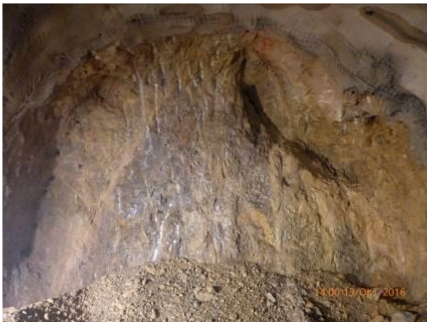
Obr. 8 Dolomit, dolomitická breccie, zkrasovatělý úsek tunelu Langer Berg 1, TM 1542,8 Fig. 8 Dolomite, dolomitic breccia, karstic part of the tunnel Langer Berg 1, TM 1542.8
