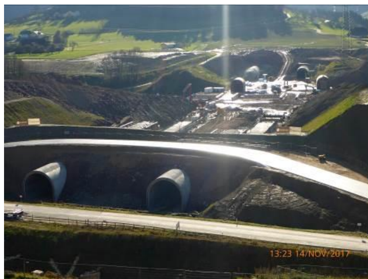
Obr. 26 Celkový pohled na stavební jámu Granitztal, původní komunikace, přeložka, podkladní betony pro betonáž, most SA1, severní portály tunelů Langer Berg. Fig. 26 Overall view on the Granitztal excavation, original road, relaying, concrete beds, bridge SA1, North portals of the Langer Berg tunnels
