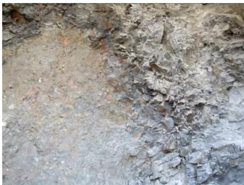
Obr. 5 Detail kontaktu čediče s tepelně zpevněnými slepenci tunel Deutsch Grutschen 1. Fig. 5 A detail of the contact of basalt with thermally solidified conglomerates in the tunnel Deutsch Grutschen 1.
