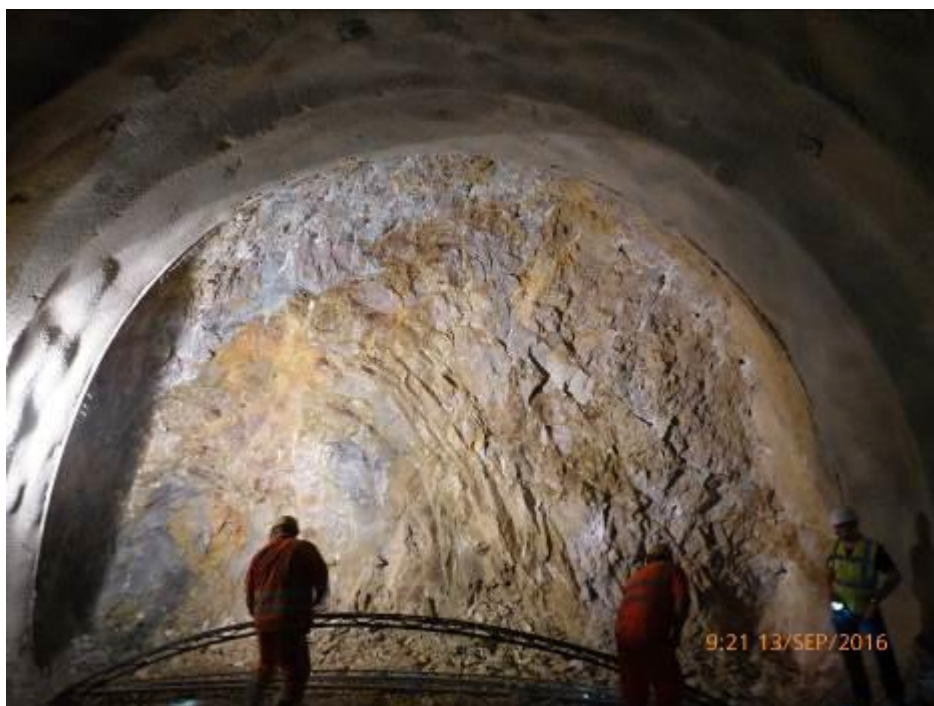
Obr. 7 Vápence a dolomity souvrství Gosau, tunel Langer Berg 1, TM 1402,4 Fig. 7 Limestones and dolomites in the Gosau group, tunnel Langer Berg 1, TM 1402.4
