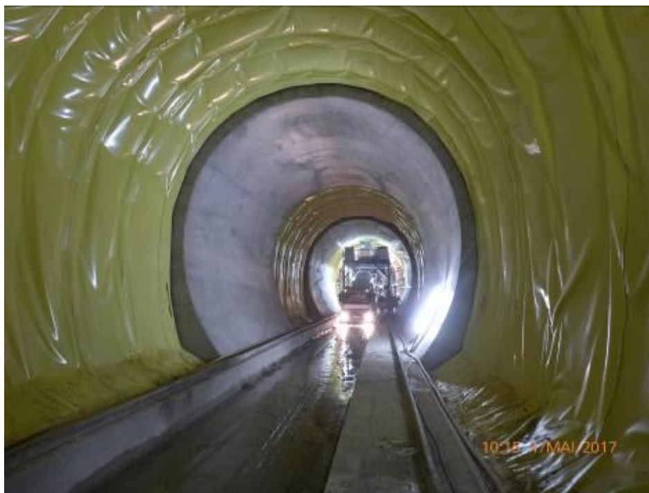
Obr. 27 Bloky definitivního ostění a izolace, střídavá betonáž bloků.
