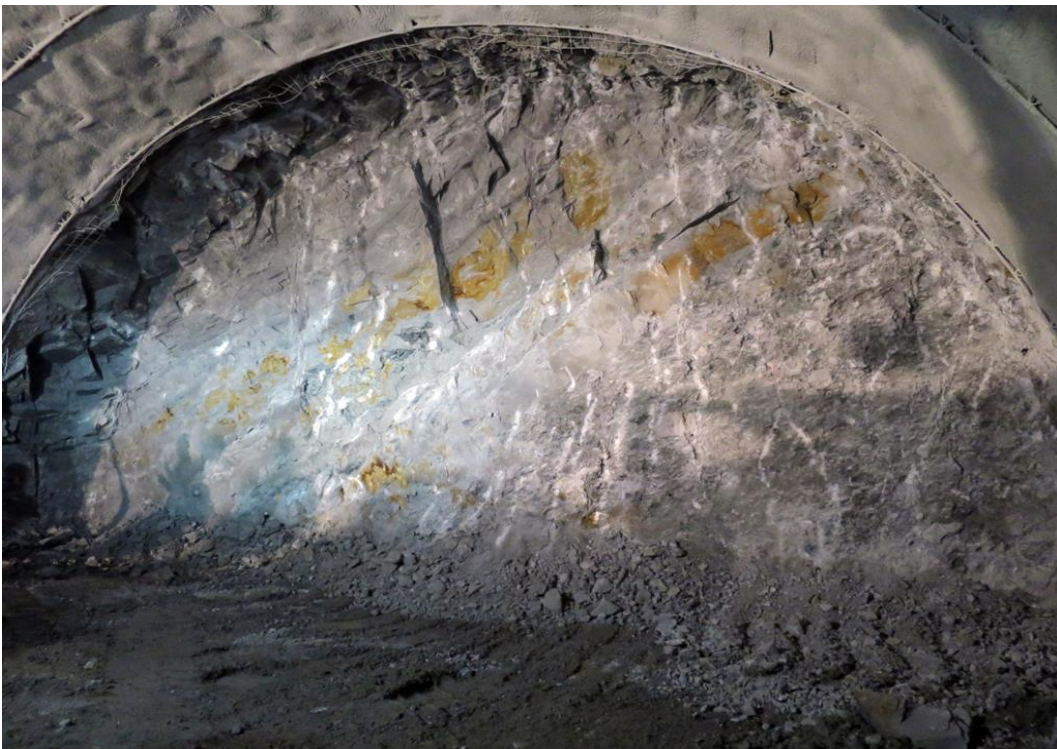
Obr. 9 Čelba v ílovcoch a pieskovcoch
