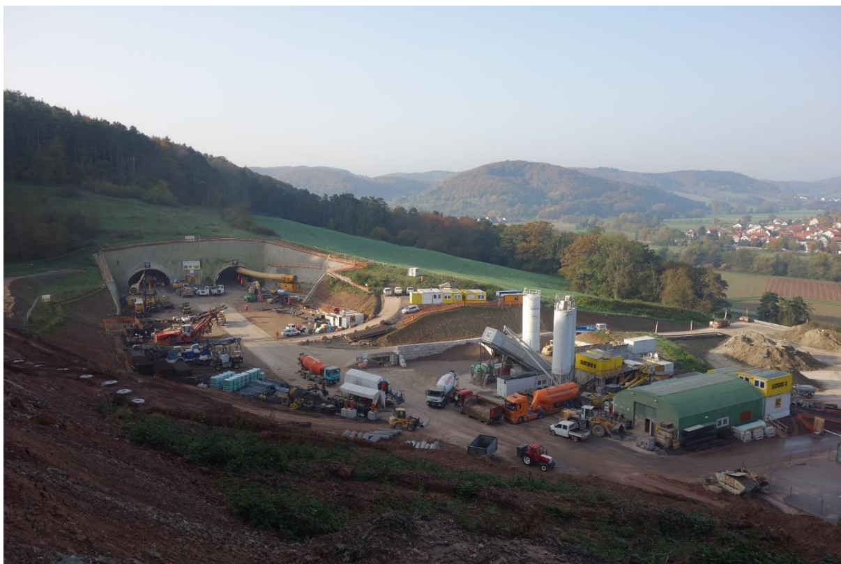
Obr. 2 Zařízení staveniště na severním portálu Zdroj: ARGE Tunel Spitzenberg + trasa BA2
