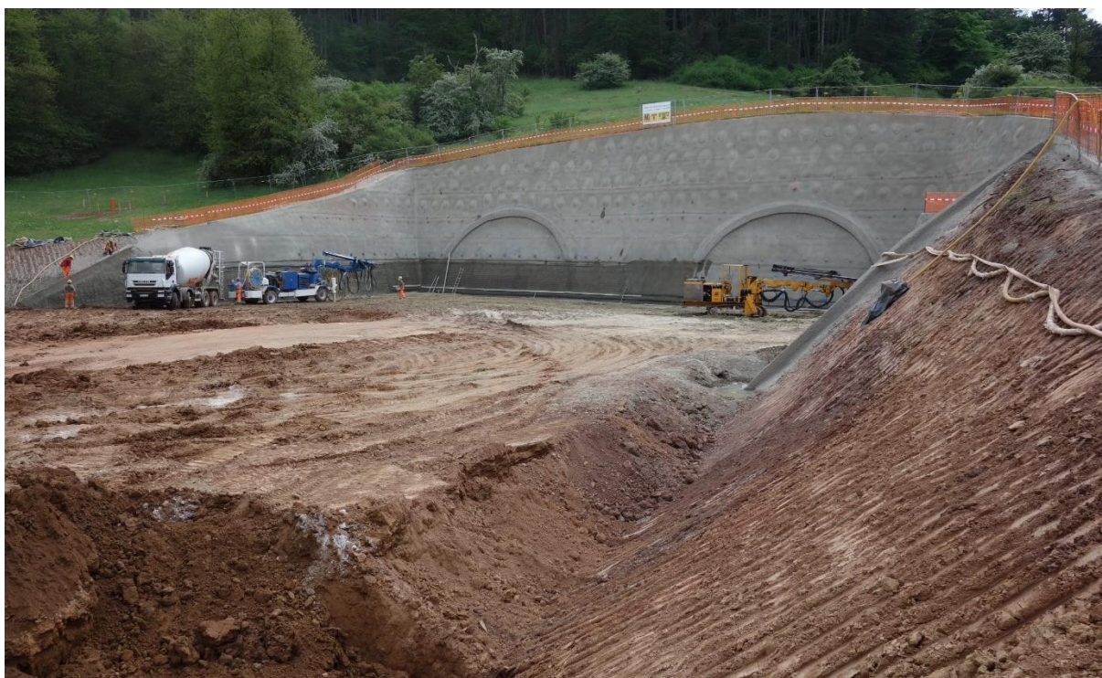
Obr. 4 Výstavba jižního portálu Zdroj: ARGE Tunel Spitzenberg + trasa BA2
