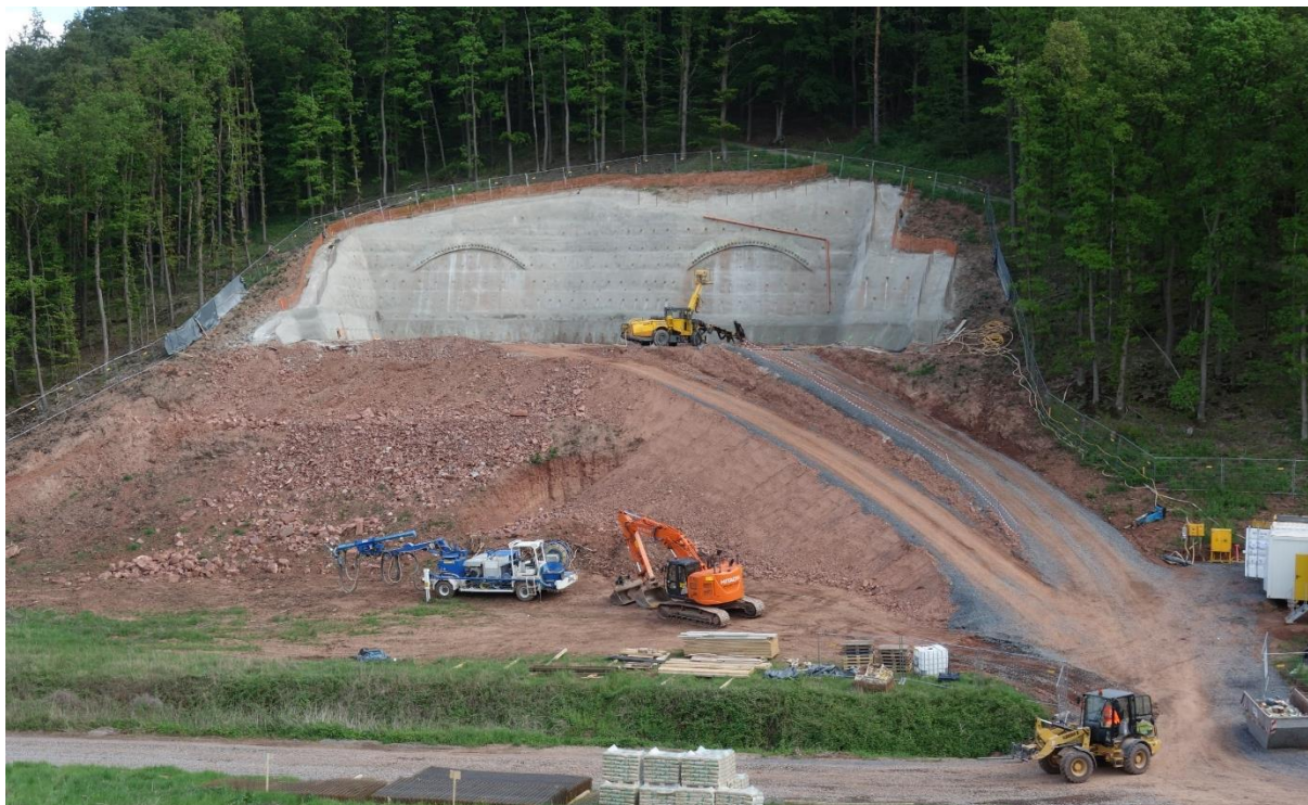
Obr. 3 Výstavba jižního portálu Zdroj: ARGE Tunel Spitzenberg + trasa BA2
