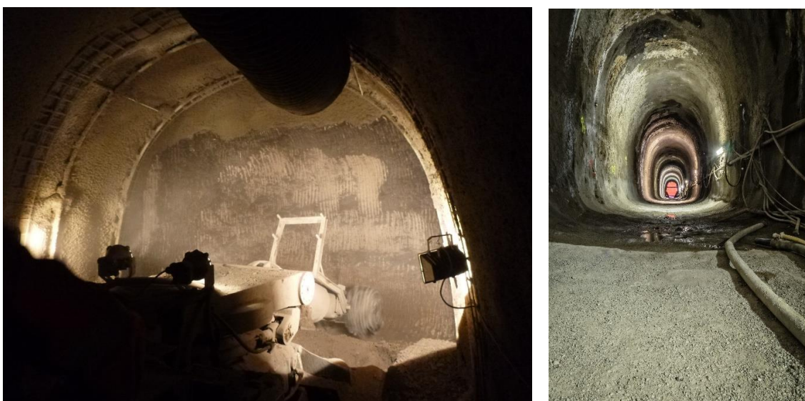
Obr. 8 a 9 Ražba mechanickým rozpojováním pomocí razícího kombajnu Alpine AM50 (vlevo); hlavní kolektorová trasa po proražení a profilaci primárního ostění (vpravo) ZDROJ: (Obr. 8 fotoarchiv sdružení, Obr. 9 autor Vladimír Dinda)
