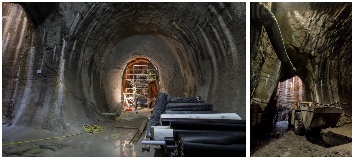
Obr. 5 a 6 Pohled na průnik technické komory TK103 se štolou kolektorové trasy (vlevo) a propojem do šachty J103 (vpravo).
