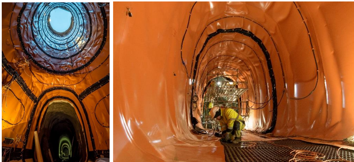
Obr. 10 a 11 Průnik šachty J104 a kolektorové trasy s nainstalovaným kompletním hydroizolačním systémem (vlevo)
