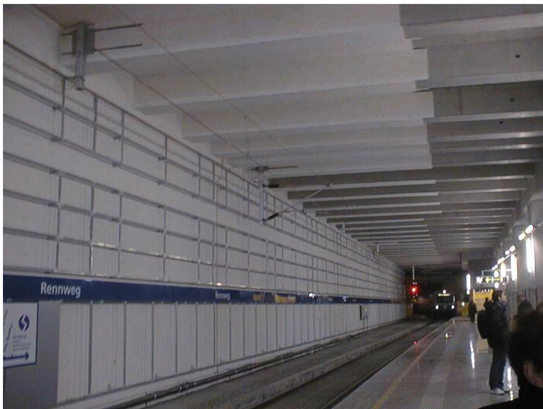
Obr. 6 Obklad betónových konštrukcií v tuneli vo Viedni Fig. 6 Clading of concrete structure in tunnel in Vienna
