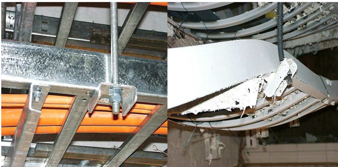
Obr. 2 Ukážky skúšobných vzoriek – káblový rošt (pred a po skúške) Fig. 2. Example of tested samples – cable ladder (before and after test)
