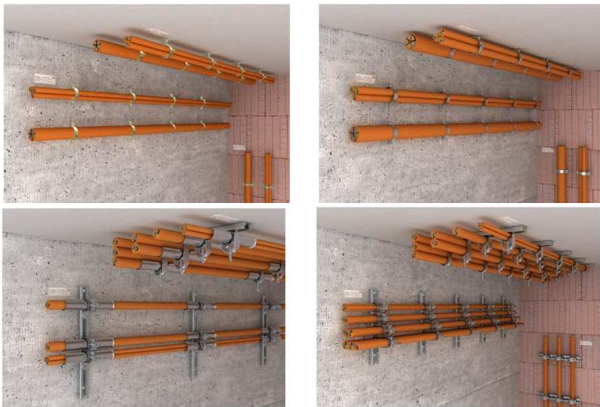
Obr. 3 Príklady uchytenia káblov pomocou samostatných príchytiiek Fig. 3 Examples of cable installation by using individual cable clamps
