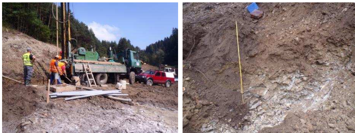
Obr. 7 Realizace monitorovacích vrtů a kopaných sond v prostoru středové jámy.
