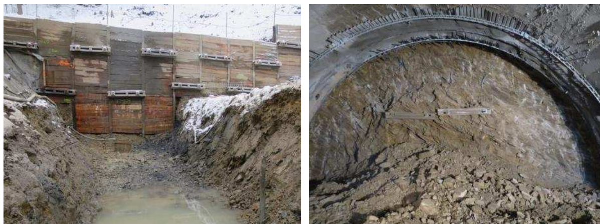
Obr. 12 Portálová stěna úvodního úseku ražby za želvou ve střední části (vlevo); zajištění přístropí za želvou na západním portálu pomocí profilů UNION a IBO kotev (vpravo).
