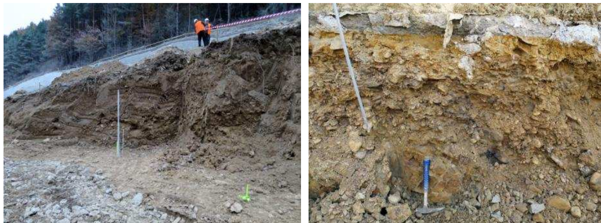
Obr. 4 Jílovito-kamenité svahoviny zastižené při hloubení středové jámy (vlevo), terasové písčité štěrky zastižené při hloubení jámy západního portálu (vpravo).
