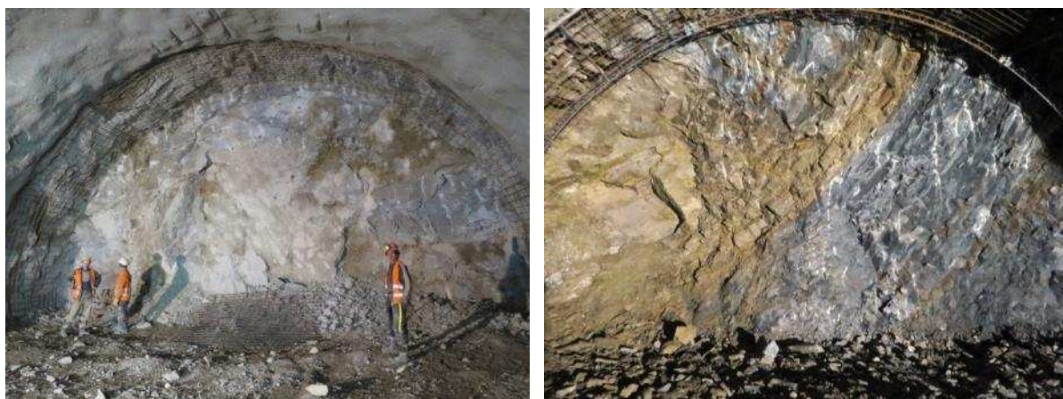
Obr. 13 Ražba v prostředí masivních slepenců vysoké pevnosti – vystrojovací třída VT 4.1 s délkou záběru až 4,0 m (vlevo); ražba v prostředí tektonicky porušených a zvětralých slínovců – vystrojovací třída VT 5.1 s délkou záběru do 1,7 m (vpravo).
