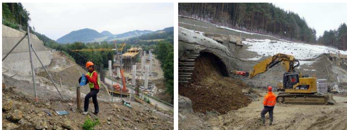
Obr. 6 Sledování vlivu stavby na pokles hladiny podzemní vody v oblasti východního portálu tunelu (vlevo); dokumentace zahájení ražeb ze středového portálu (vpravo).
