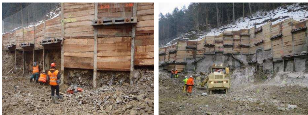
Obr. 9 Dokumentace hloubení středové jámy (vlevo); stěna východního portálu jižní tunelové roury zajištěna záporovým pažením i betonovým zástříkem (vpravo).
