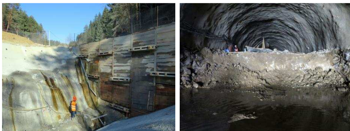
Obr. 5 Severovýchodní část středové jámy s intenzivními přítoky z poloh kvartérních uloženin (vlevo); přítoky podzemní vody ze zvodnělých puklin při dobírce stupně (vpravo).
