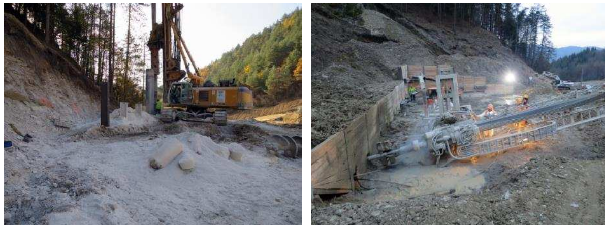
Obr. 8 Dokumentace vrtů pro záporové a lanové kotvy pro zajištění stěn středové jámy.
