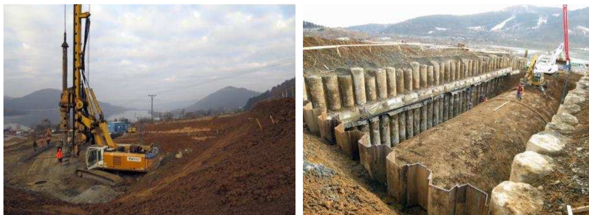
Obr. 11 Realizace pilot pro zajištění portálové jámy (vlevo); profilování želvy (pravo).
