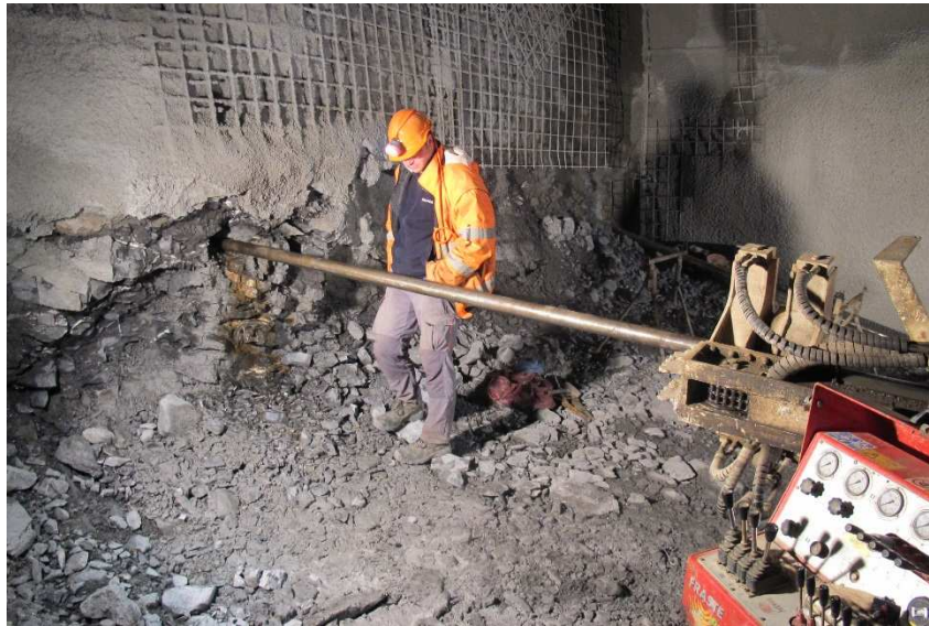
Obr. 8 Realizácia dilatometrických skúšok v tuneli Čebrať Fig. 8 Realization of dilatometer tests in the tunnel Čebrať
