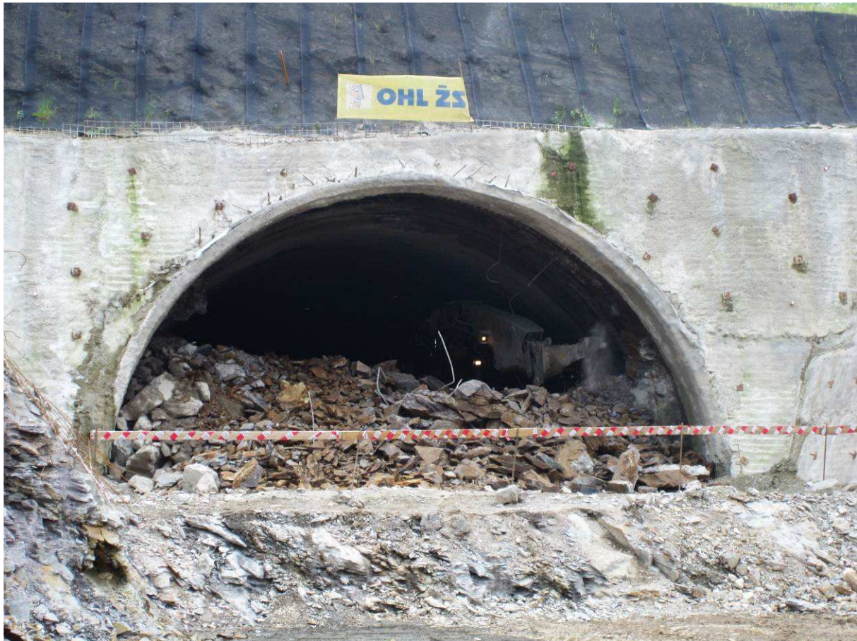
Obr. 6 Prorážka kaloty severního portálu Fig. 6 Top heading breakthrough of the north portal
