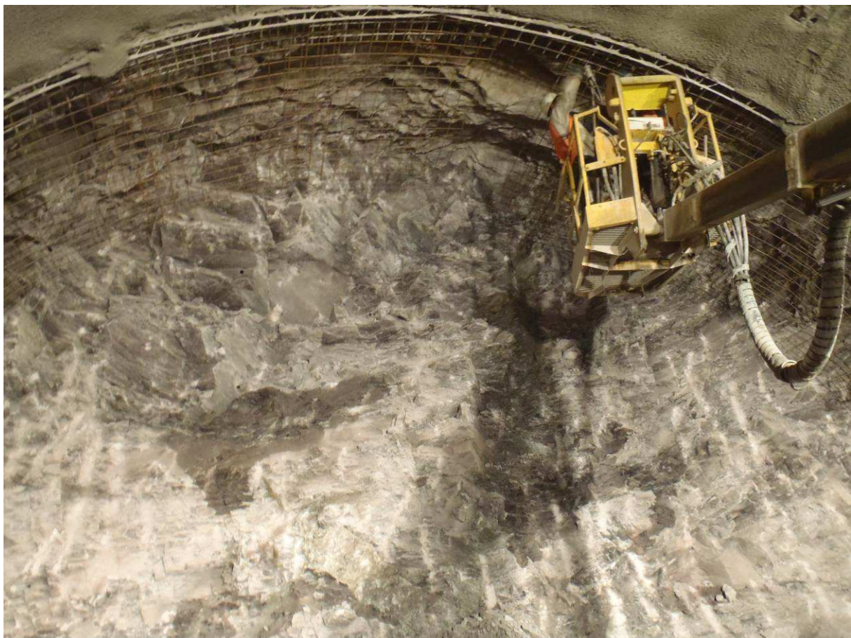
Obr. 5 Stavební práce ve zdravých rulách Fig. 5 Construction works in sound gneiss
