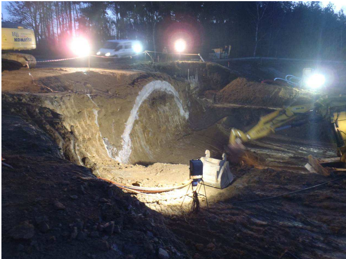
Obr. 4 Začátek ražeb – jižní portál Fig. 4 Beginning of the excavation – south portal
