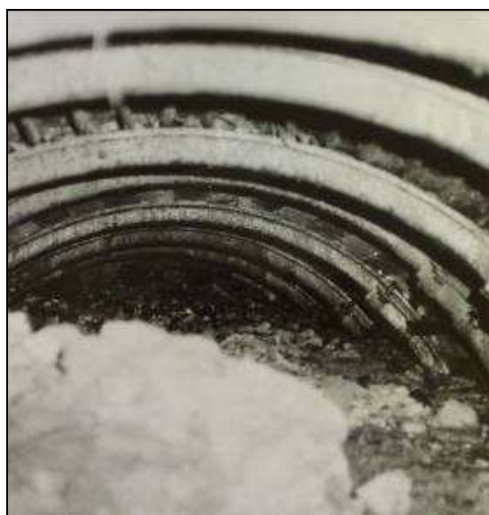
Obr. 4 a 5 Zával ve štole stoky „P“ a jeho detail Fig. 4 and 5 Collapse of the sewer „P“ and the detail
