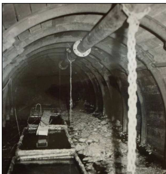
Obr. 4 a 5 Zával ve štole stoky „P“ a jeho detail Fig. 4 and 5 Collapse of the sewer „P“ and the detail
