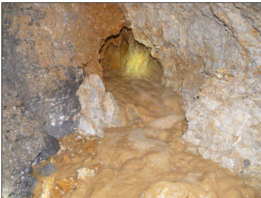
Obr. 10 Prítok podzemní vody z krasové pukliny v lochkovském souvrství, který způsobil částečné zatopení dna průzkumné štoly
