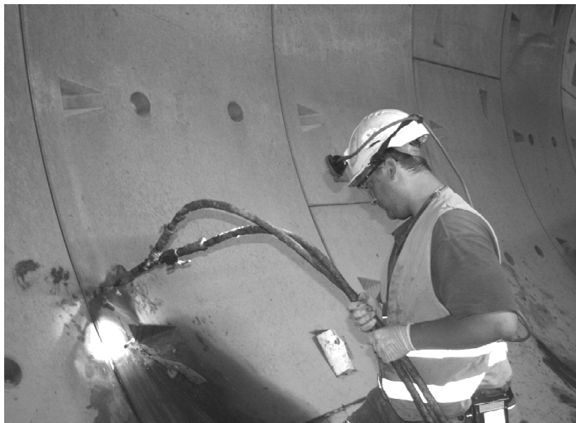
Obr. 8 - Utěsňující injektáž průsaku v místě kapsy šroubového spoje.
