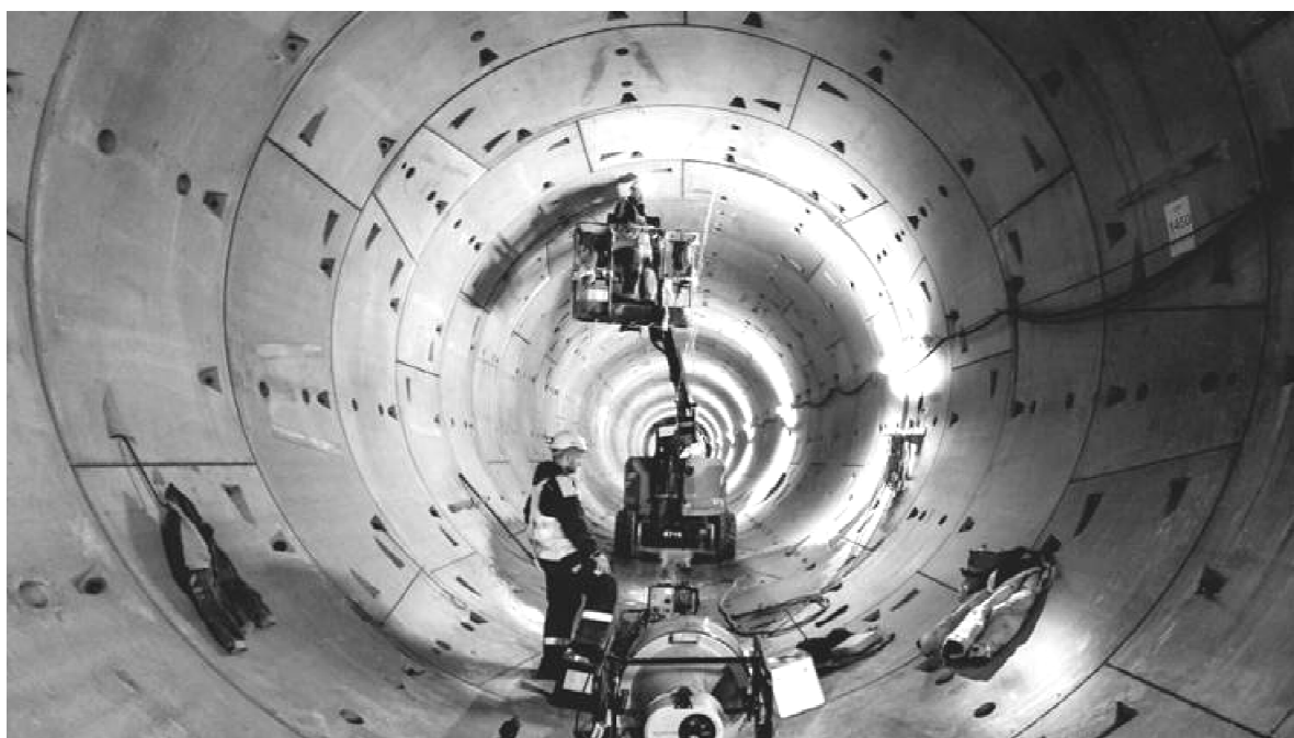
Obr. 1 - Typický pohled na pracoviště, kde probíhaly sanační práce. Pracovní osádka zpočátku tvořili: 1 technik, který práce řídil a dokumentoval, 2 dělníci-specialisté, provádějící injektáže a 1 pomocný dělník pro obslužné činnosti. Po zavedení a nastavení všech pracovních a kontrolních mechanismů již nebyla nutná trvalá přítomnost technika na každém z pracovišť, jako tomu bylo na začátku. Práce probíhaly v nepřetržitém pracovním sledu, současně mohlo být obsazeno až šest pracovišť v jedné pracovní směně.
