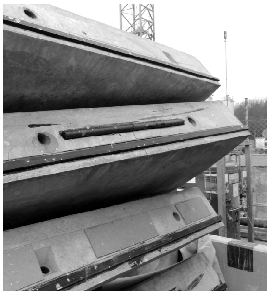
Obr. 9 - Pohled na prvky segmentového ostění, tzv. tybinky. Patrné je gumové ostění po obvodu každého z prvků, zde lepené do drážky. Otvory na hranách jsou montážní, kterými prochází šrouby. Roznášecí podložky mezi otvory šroubového spoje (viz spodní segment) pomáhají roznést bodové zatížení od přitlačných lisů tunelovacího stroje do celého segmentu.
