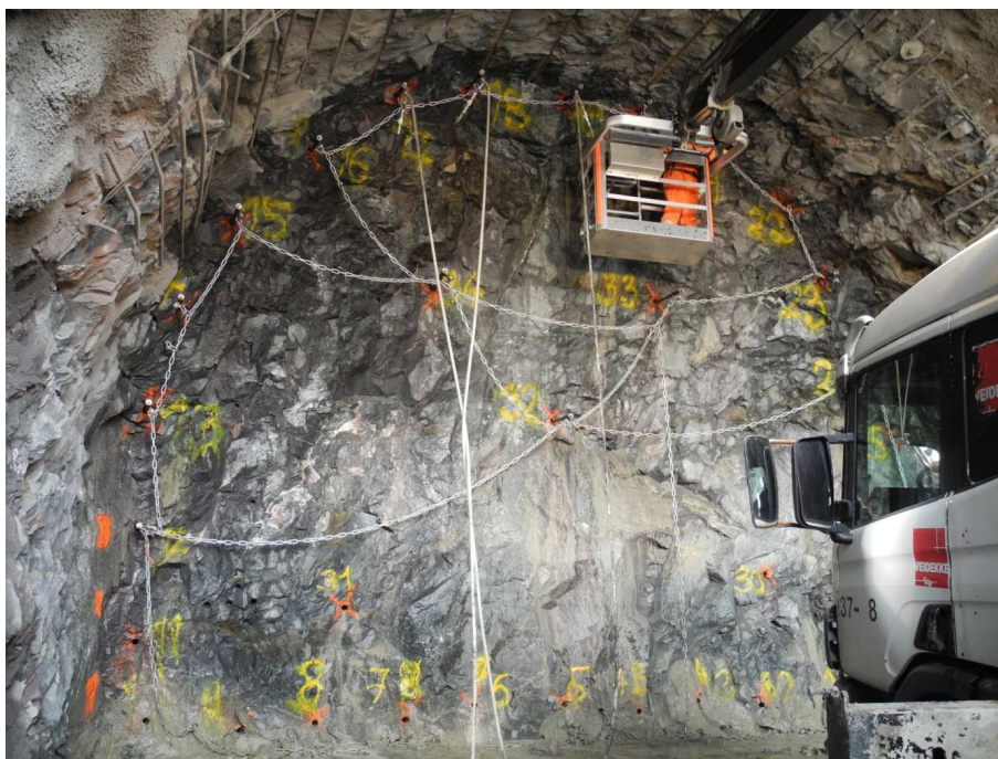
Obr. 5 Injektáž prístupového tunela R13 Fig. 5 Grouting of the access R13 tunnel
