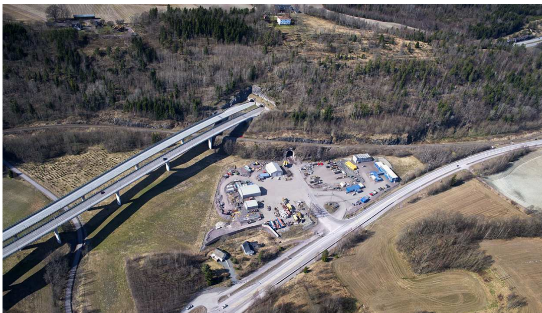
Obr. 2 Letecký pohľad na stavenisko a portál tunela R13 Fig. 2 Aerial view of the site area and R13 tunnel portal
