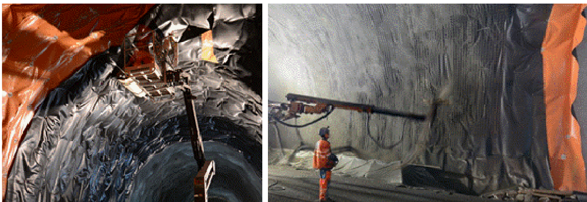
Obr. 6 Pohľad na MAPEPLAN PROTECTION finálnu aplikáciu striekaním
