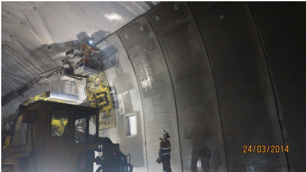
Obr. 3 Montáž prefabrikovaných betónových elementov Fig. 3 Installation of precast concrete elements
