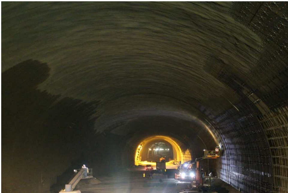
Obr. 11 Profil „trumpety“ s osadenou PE penou + kari sieťovinou a nedokončenou prvou vrstvou striekaného betónu
