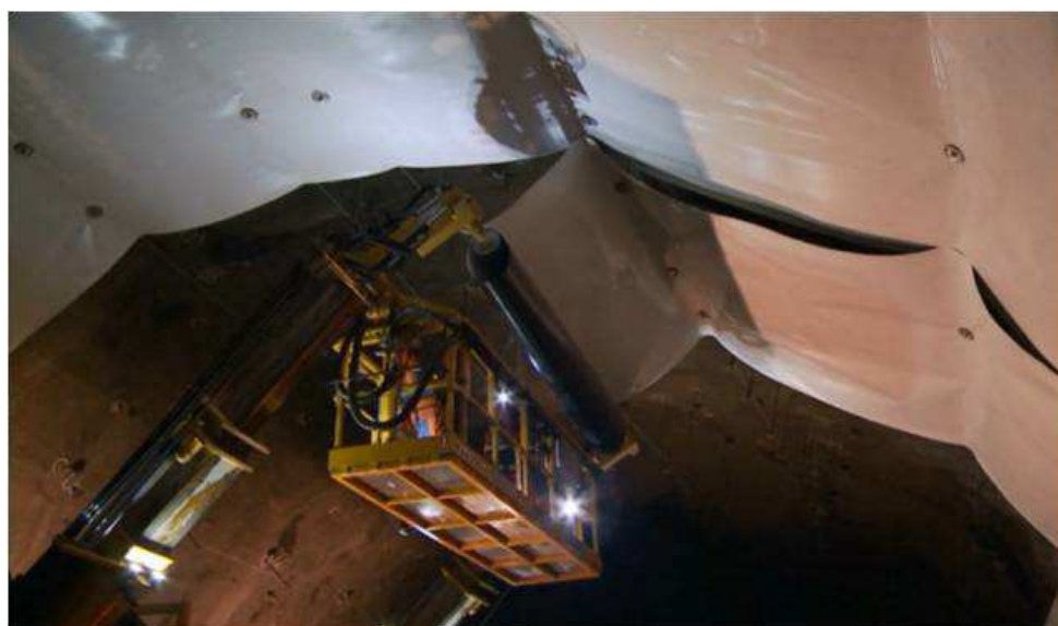
Obr. 2 Montáž hydroizolačnej membrány prostredníctvom mechanizovaného voza Fig. 2 Installation of waterproof insulation membrane with mechanized platform
