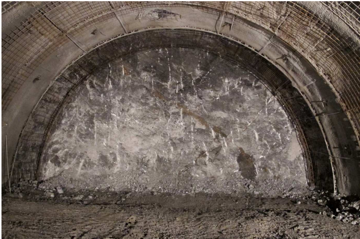
Obr. 2 Pohľad na čel'bu kaloty Fig. 2 View on the top heading face
