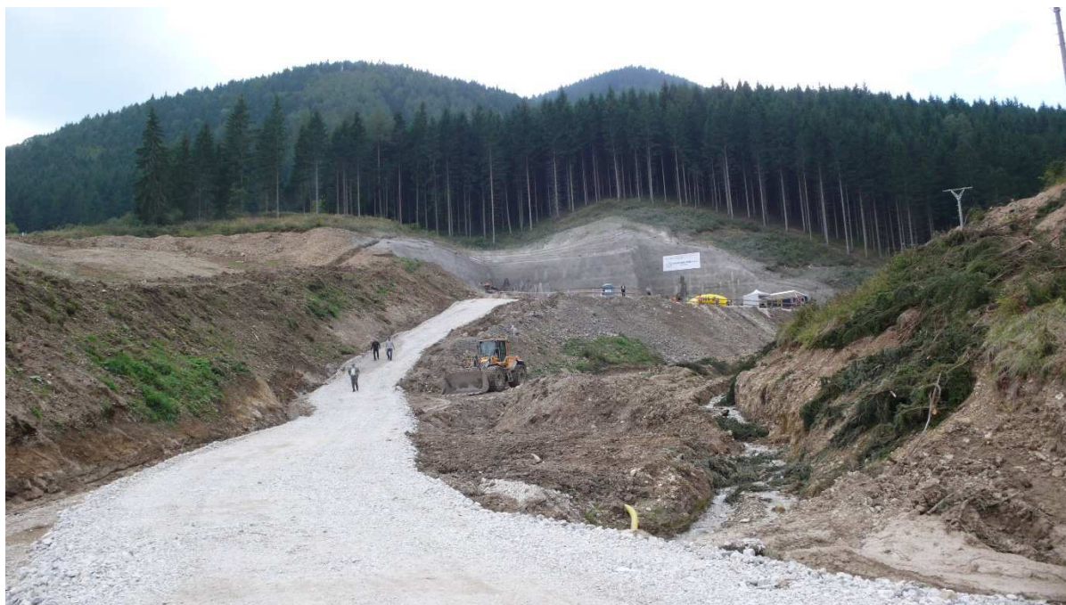
Obr. 1 Pohľad na východný portál tunela Fig. 1 View on the eastern tunnel portal
