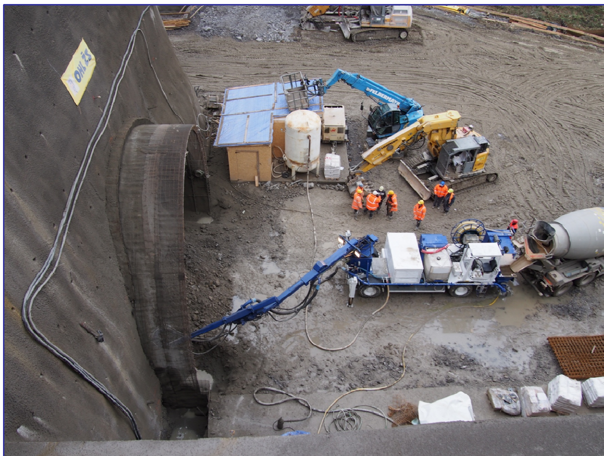
Obr. 4 Pohľad na zárodok južnej tunelovej rúry. Fig. 4 View on the entrance structure south tunnel tube
