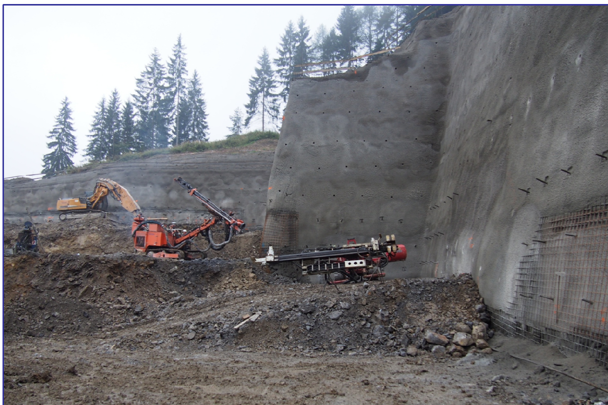
Obr. 3 Odt'azovanie a zabezpečovanie stavebnej jamy východného portálu. Fig. 3 East portal cut, excavation and stabilisation.
