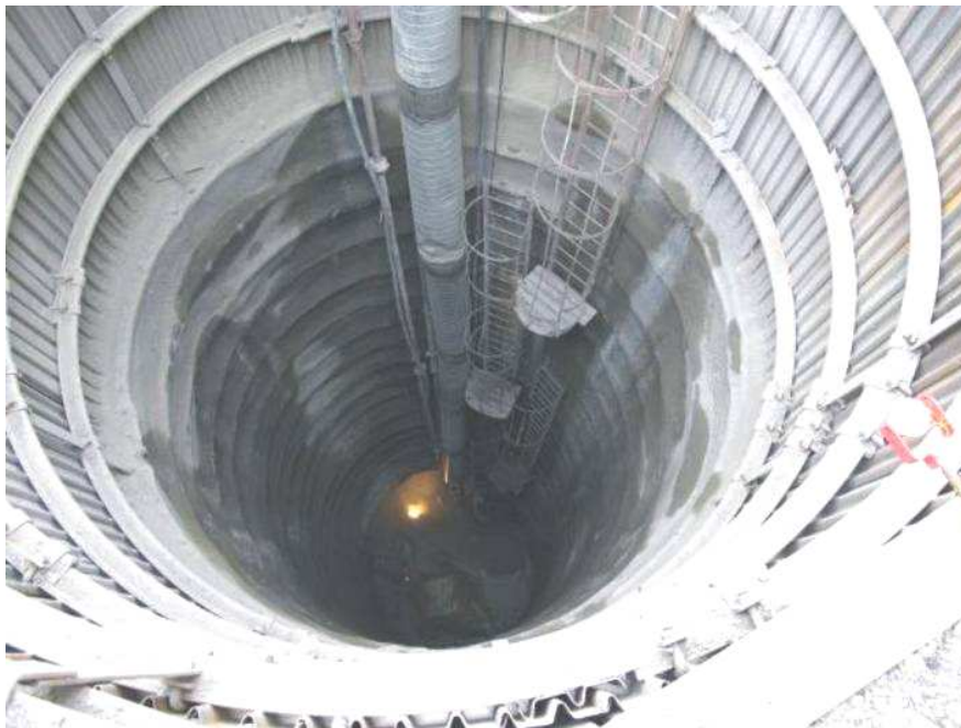
Obr. 2 Poddajná konstrukce šachty Fig. 2 Flexible shaft structure
