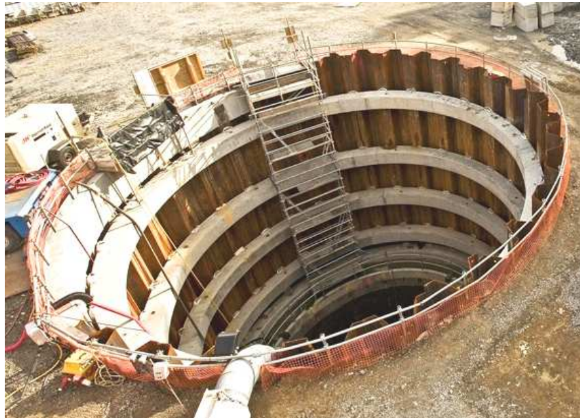
Obr. 4 Polotuhá konstrukce šachty Fig. 4 Semirigid shaft structure
