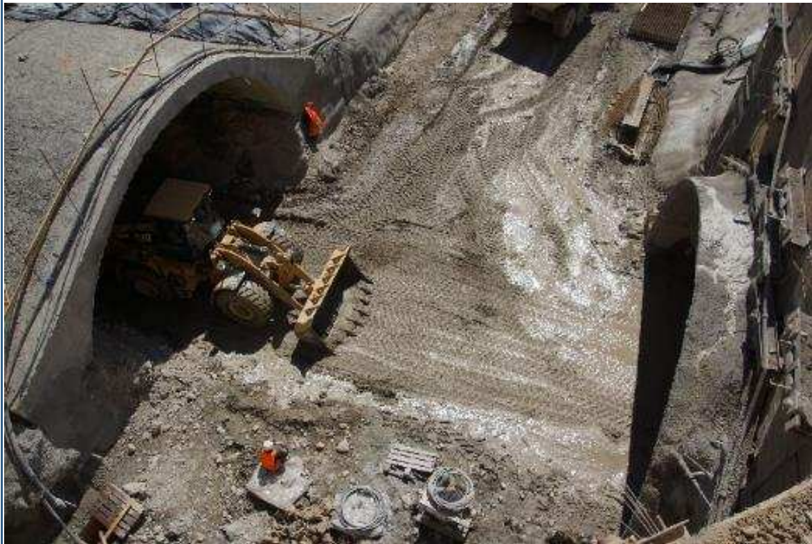
Obr. 20 Stísněné poměry ve střední stavební jámě Fig. 20 Constrained conditions in the mid-point of construction pit
