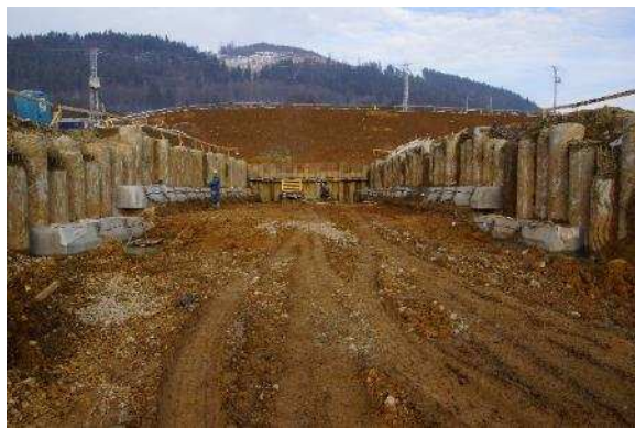
Obr. 6 Odtěžení stavební jámy do úrovně převážek Fig. 6 Excavation of the construction pit down to the level of walers
