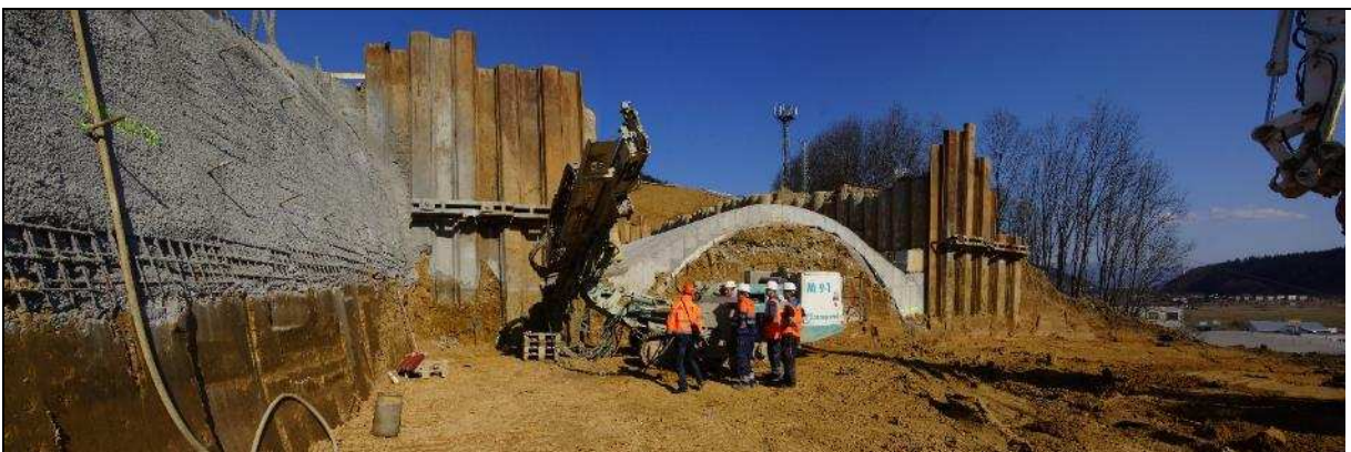
Obr. 5 Zajištění čela jámy štětovicovou stěnou Fig. 5 Excavation front end supported with a sheet pile wall
