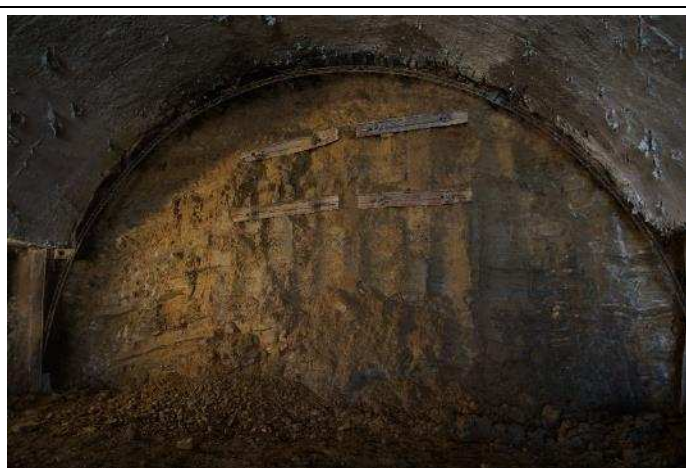
Obr. 21 Čelba na rozhraní želvy a úseku NRTM na západním portále
