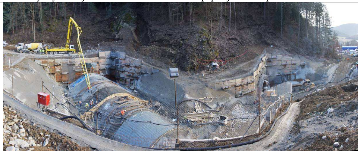
Obr. 16 Celkový pohled na východní svah stavební jámy
