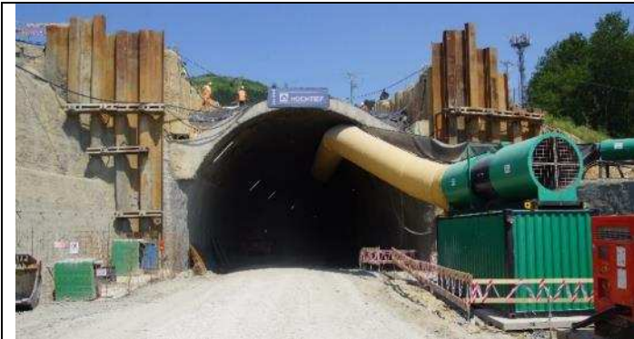
Obr. 10 Vyražení opěří pod želvou a podstříkání jejích patek primárním ostěním Fig. 10 Excavation of the bench under the “tortoise shell” structure and application of shotcrete under its footings as a part of the primary lining
