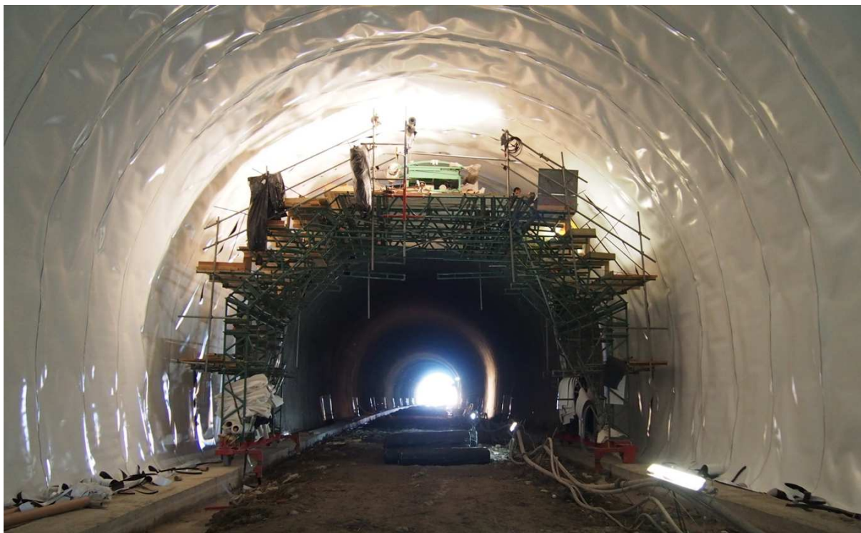
Obr. 6 Montáž hydroizolace
