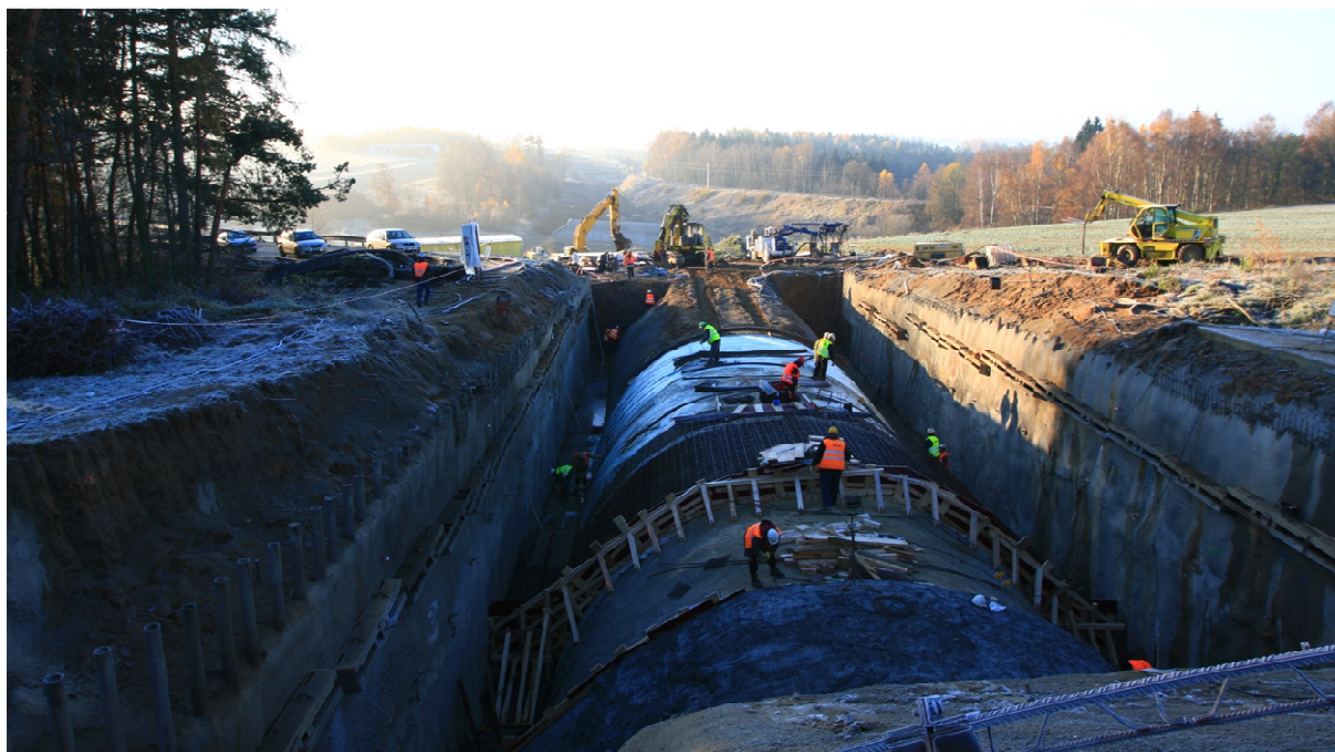
Obr 4 Realizace bloků „želvy“ v otevřené stavební jámě Fig. 4 The structure of the cover-and-cut vault in an open building pit
