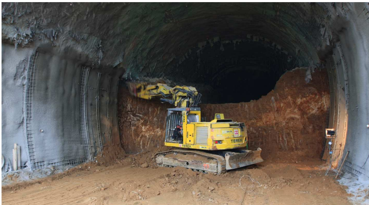
Obr. 5 Ražba opěří tunelu v TTV 5c v úseku pod ochranou „želvy“
