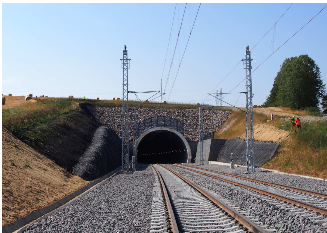
Obr. 8 Pohled na dokončený severní portál tunelu Fig. 8 View of the completed northern portal of the tunnel
