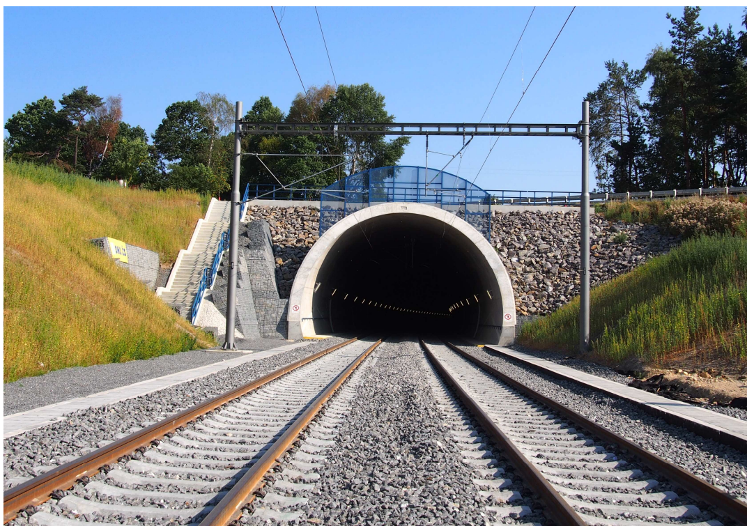
Obr. 7 Pohled na dokončený jižní portál tunelu Fig. 7 View of the completed southern portal of the tunnel
