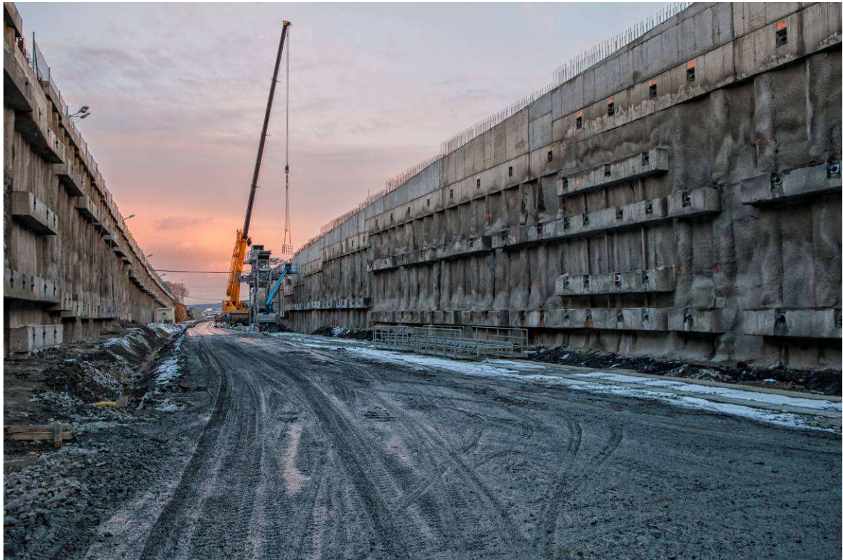
Obr. 4. Konštrukcia zárezu navezujúceho na portálovú stenu tunelov Fig. 4. Pile wall of the open cut in front of the tunnel portal
