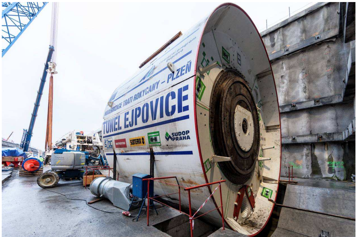
Obr. 5 Montáž tunelovacieho stroja v predportáli ejpovického tunelu Fig. 5 Assembly of the tunneling machine in front of the Ejpovice tunnel portal
