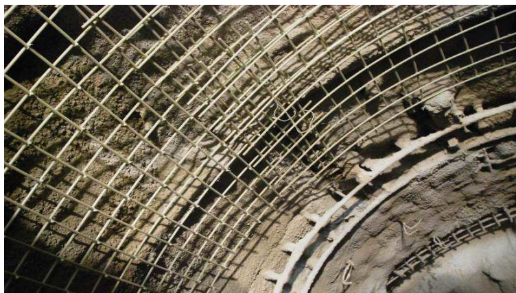
Obr. 3 Kompozitové sítě Fig. 3 Composite nets
