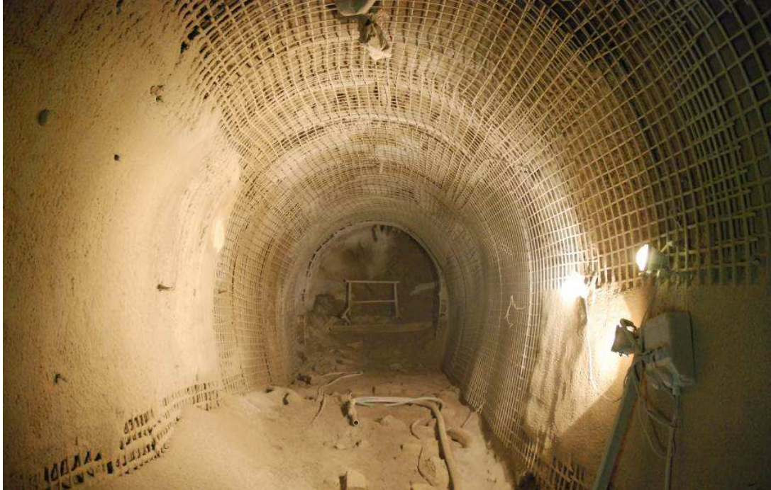
Obr. 6 Drenážní štola – v průběhu ražby Fig. 6 Drainage tunnel – during excavation
