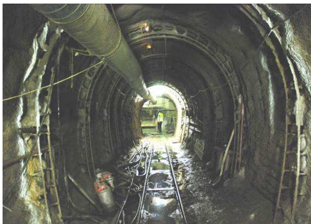
Obr. 4 Přístupová štola Fig. 4 Access tunnel
