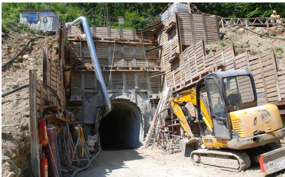
Obr. 2 Portál drenážní štoly Fig. 2 Portal of drainage tunnel
