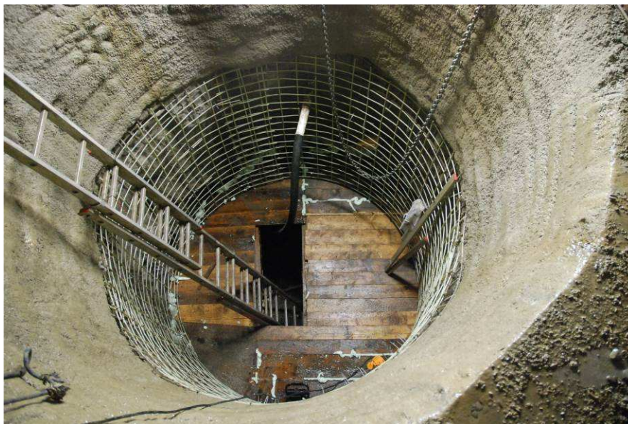
Obr. 8 Pohled do drenážní šachty Fig. 8 The view to drainage shaft
