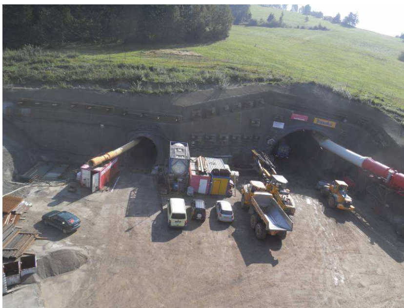
Obr.4 Pohľad na dokončený západný portál Fig. 4 View of the completed western portal
