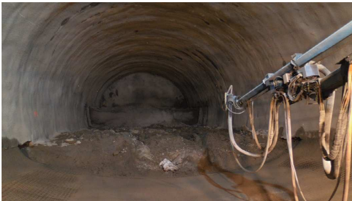
Obr.7 Zástrek spodnej klenby SB (na obr. je vidieť horizontálne členenie výrubu) Fig. 7 Applying shotcrete to invert (the horizontal excavation sequence can be seen in the picture)
