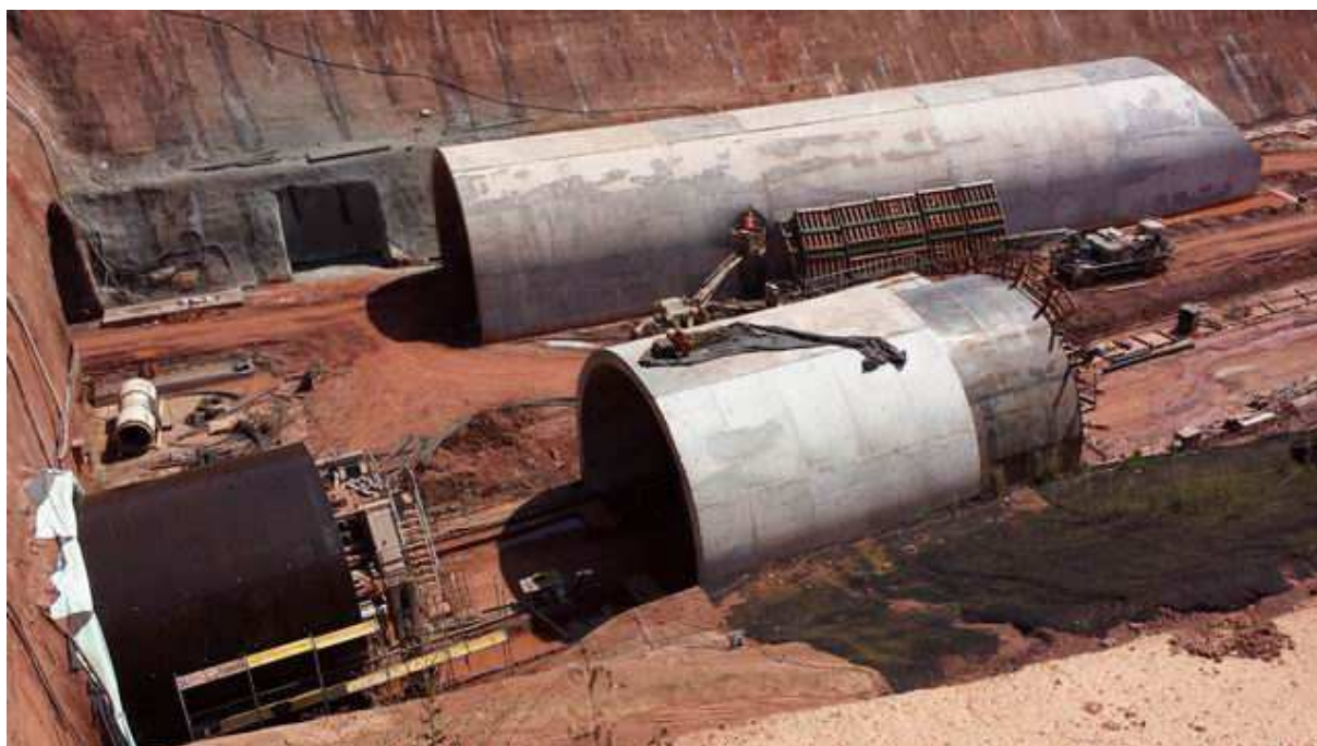
Obr. 20 Betonáž sekundární obezdívky probíhala za využití dvou nezávislých forem Fig. 20 For concreting of secondary lining were utilized two independent formworks
