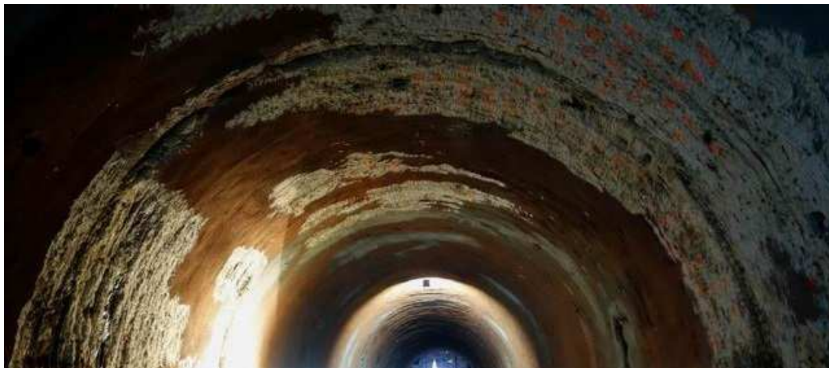
Obr. 19 Pravá trouba po reprofilaci vyvolané velkými konvergencemi primární obezdívky Fig. 19 Right Tube after re-profiling demanded by heavy deformation of primary lining
