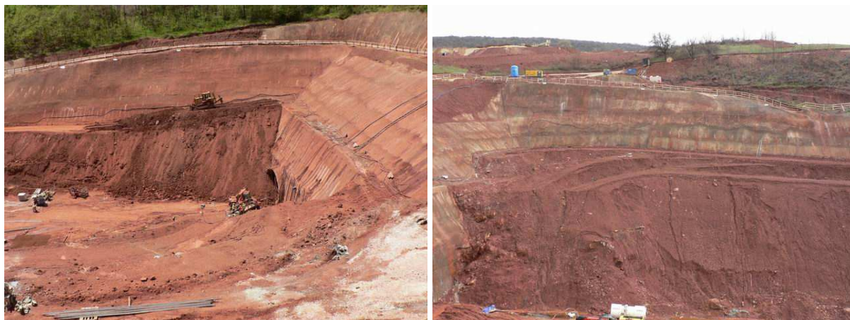
Obr. 9, 10 Budování dlouhých úzkých násypů pro získání přístupu do horních partií svahů Fig. 9, 10 Creation of long narrow berms to access the slopes with use of minimum backfill
