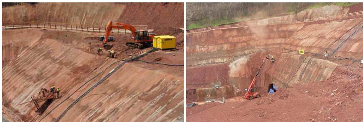
Obr. 11, 12 Ruční vrtání a instalace kotev ze zavěšené nebo vysokozdvížné plošiny Fig. 11, 12 Hand drilling and install of anchors from hanged or high elevating platform
