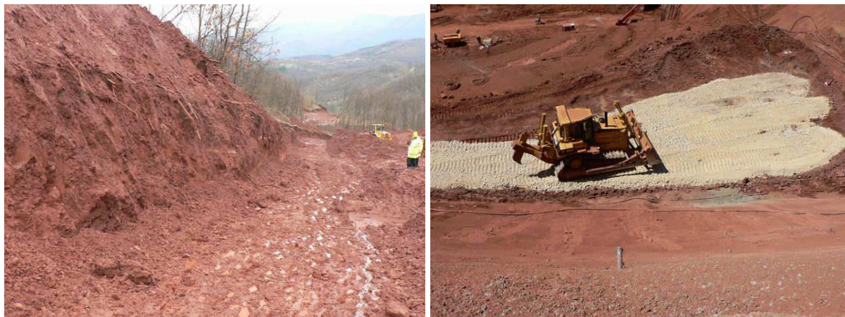
Obr. 13, 14 Dopad špatného počasí na přístupy k vysokým svahům po úzkých násypech – nárůst nákladů kvůli přerušení prací a opakovanému zpevňování povrchu komunikací štěrkem Fig. 13, 14 Bad influence of weather on access to the berms – born of additional costs due to suspension of works and repeating road improvements by spreading of gravel
