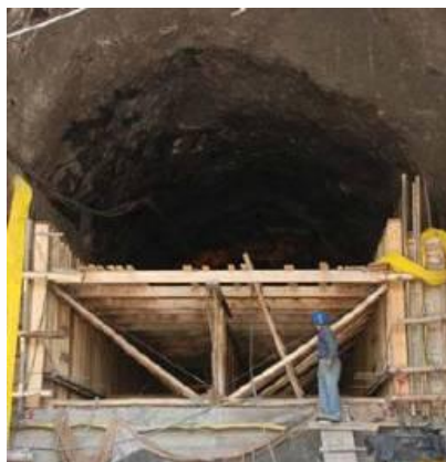
Pohľad z portálovej časti tunela
