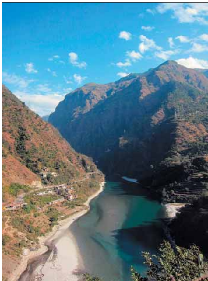
Obr. 2 Pohled na oblast stavby s příkrými svahy a stávající dvoupruhovou silnicí na levé straně
