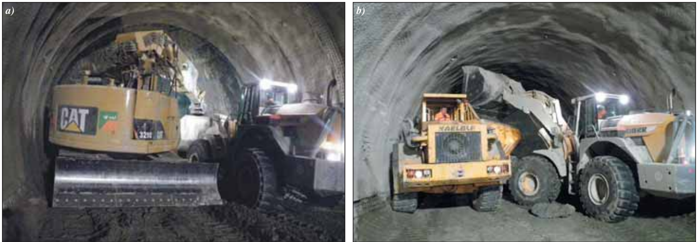
Obr. 7 Rozpojování a nakládání rubaniny v „malém“ průřezu KAT 1 Fig. 7 Excavation and loading of mucking material in the “small” KAT 1
