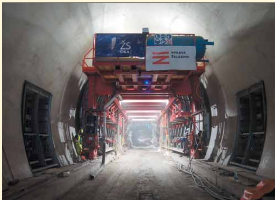
Obr. 6 Betonáž sekundárního ostění Fig. 6 Concreting secondary lining
