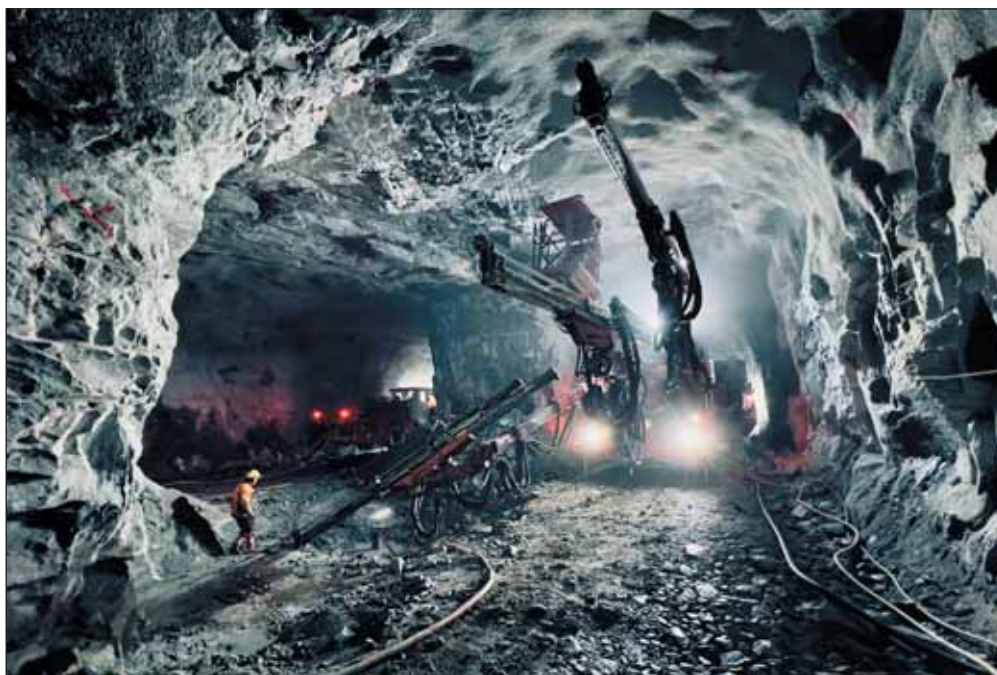
Obr. 1 Ražba traťových tunelů metodou Drill and Blast Fig. 1 Driving running tunnels using the Drill and Blast method
