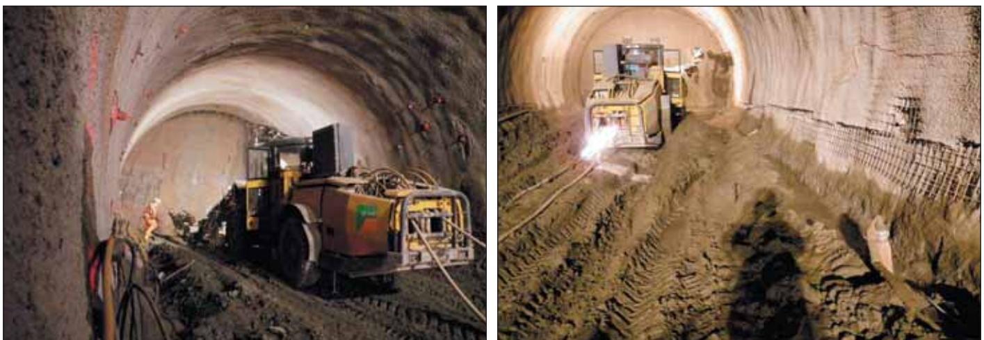
Obr. 8 Příkopy pro odvodnění (vlevo) a vzhled příkopu a dopravní cesty v horninách citlivých na vodu Fig. 8 Ditches for dewatering (left) and appearance of ditch and roadway in water sensitive ground conditions
