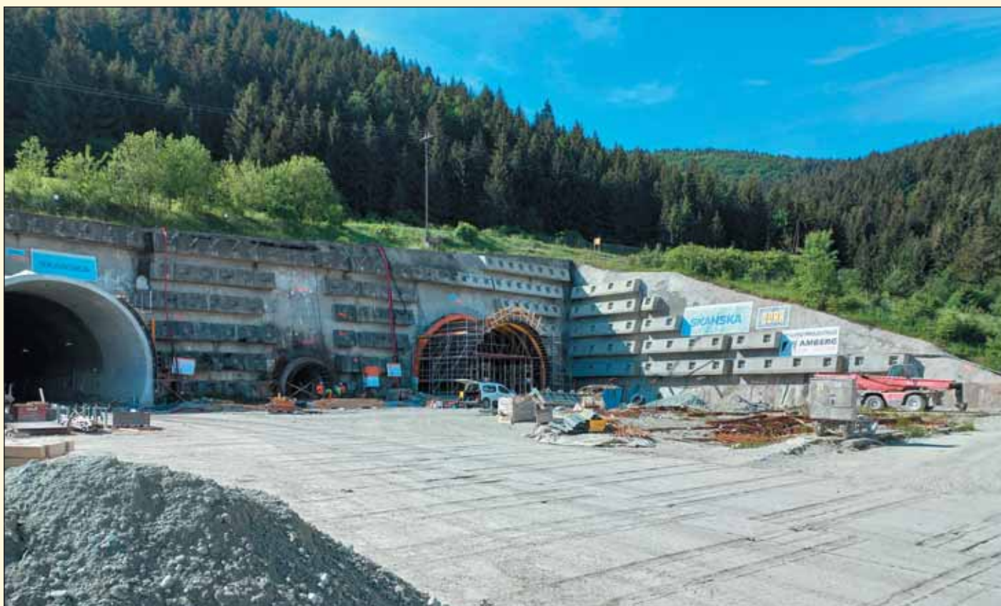
Obr. 10 Hĺbené tunely na západnom portáli tunela Višňové Fig. 10 Cut-and-cover tunnels at the western portal of the Višňové tunnel
