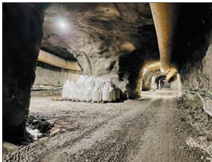
Obr. 3 Pohled do jižního traťového tunelu (Soderspar tunnel)
