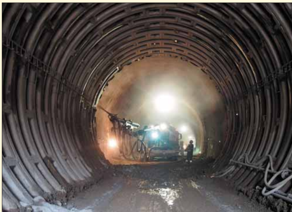
Obr. 5 Realizace primárního ostění – pohled ze stávajícího profilu tunelu Fig. 5 Work on primary lining – viewed from existing tunnel profile
