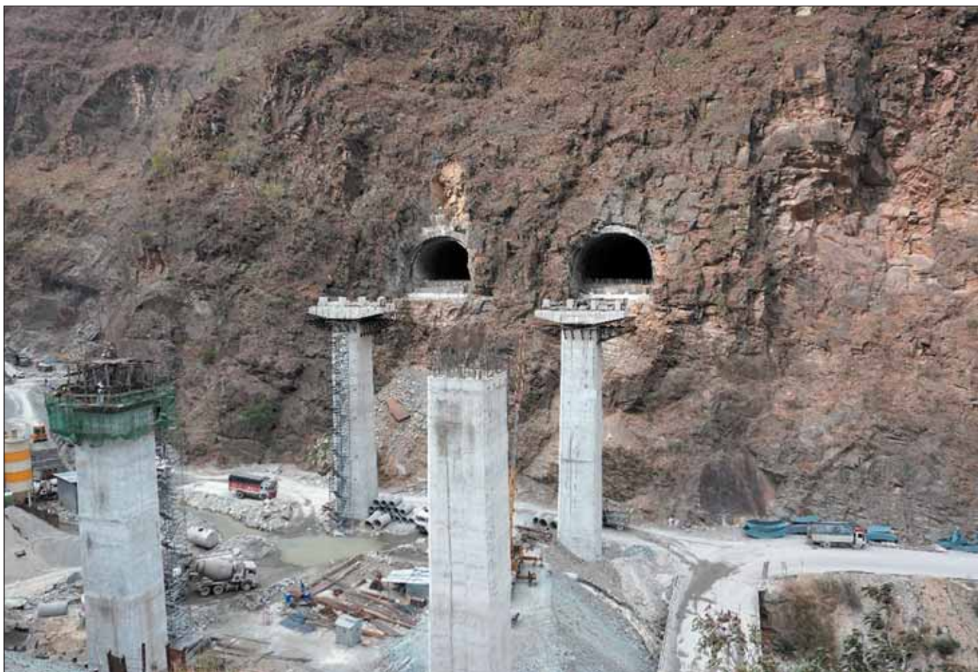
Obr. 5 Integrovaní opěry mostu do sekundárního ostění tunelu Fig. 5 Steep natural slope at tunnel portal
