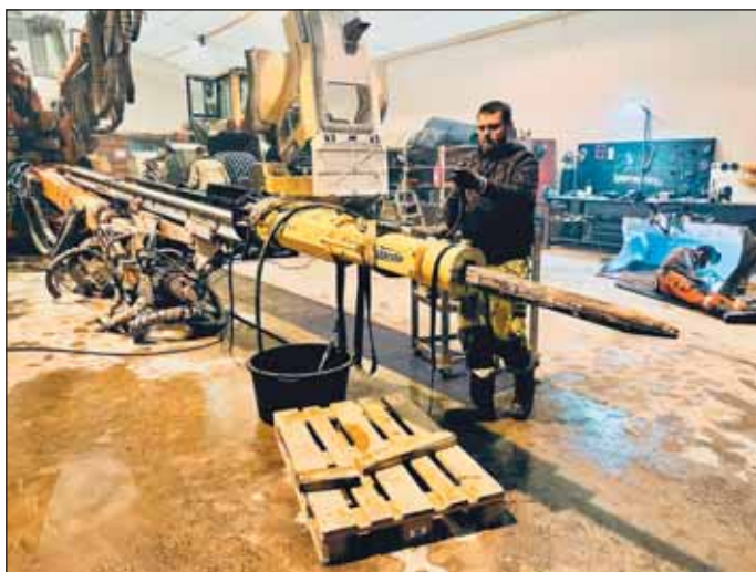
Obr. 7 Použitý hydraulický trhací klín Darda C20 umístěný na lafetě vrtného vozu
