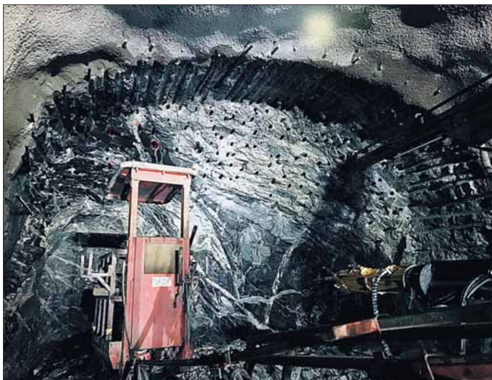
Obr. 8 Čelba po dokončení mechanického rozpojování horniny trhačím klínem Fig. 8 Face after completion of mechanical breaking of rock using the splitting wedge
