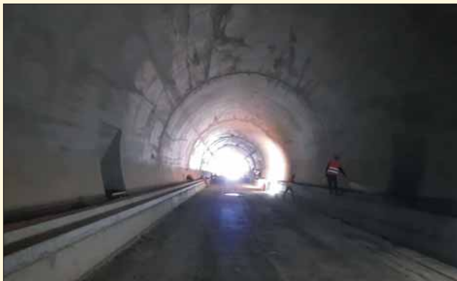
Obr. 8 Stav prác pred realizáciou vozovky v tuneli Bikoš
