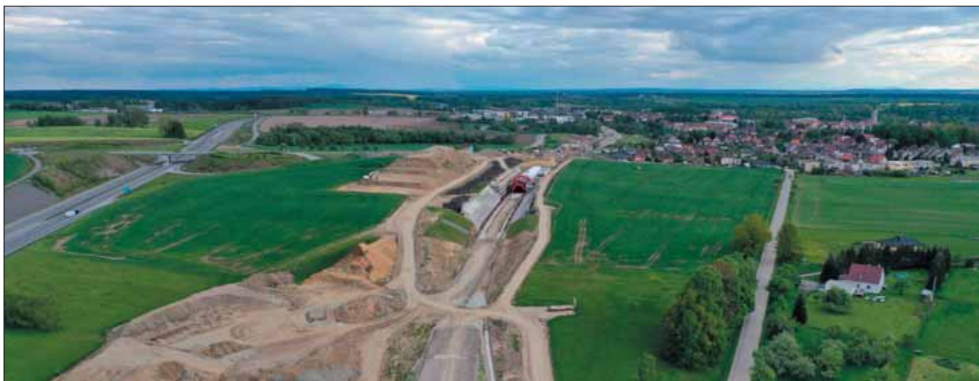
Obr. 13 Stavba v těsné blízkosti města Soběslav a dálnice D3
