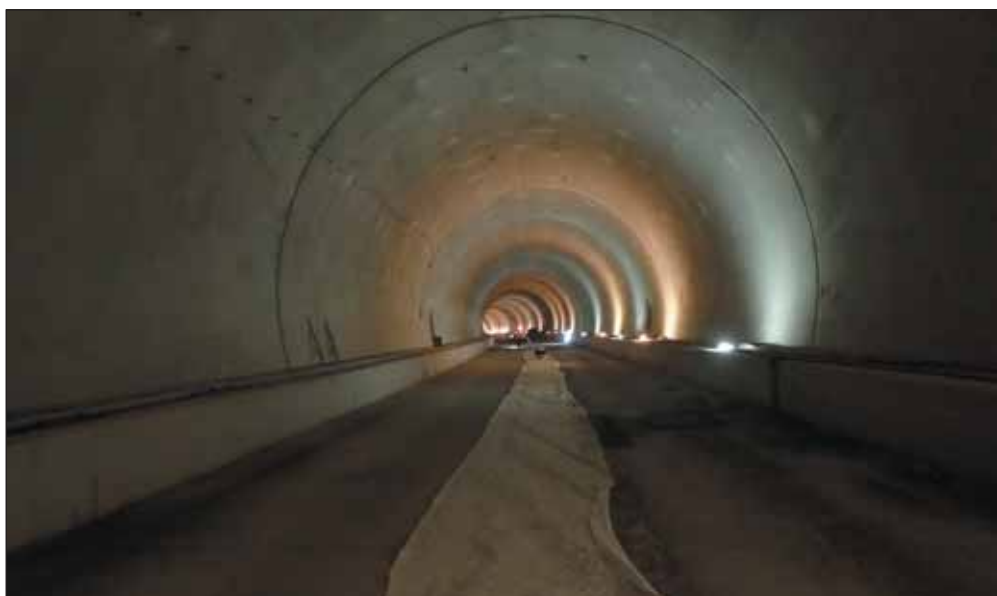
Obr. 8 Tunel po dokončení betonáží
