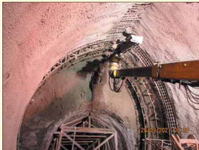
Obr. 2 Probíhající ražby na VO-OL při rozšiřování profilu průzkumné štoly na budoucí tvar dvoukolejného traťového tunelu
