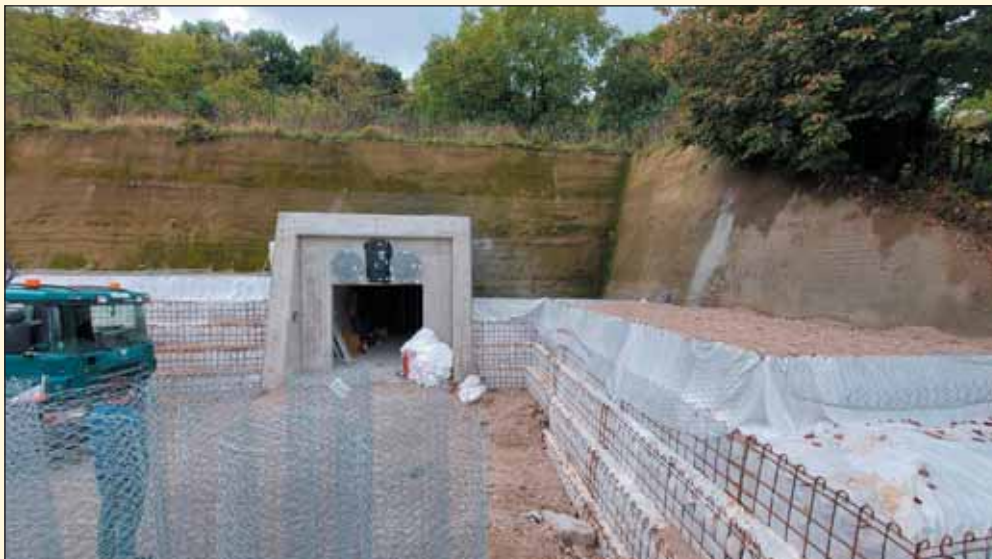
Obr. 9 Portál únikovej štôľne tunela Milochov Fig. 9 Portal of Milochov tunnel escape gallery
