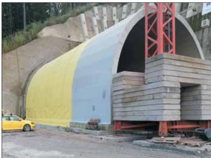
Obr. 13 Rozhraní fóliové a stříkané hydroizolace na západním portálu Fig. 13 Interface of the sheet, and the sprayed waterproofing of western portal
