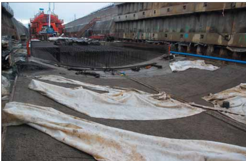
Obr. 6 Podkladní betony a výztuž spodní klenby Fig. 6 Base slab concretes and invert vault reinforcement
