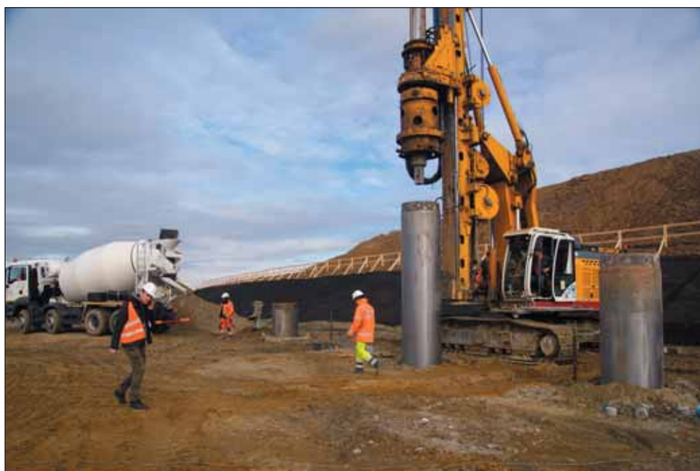
Obr. 11 Střídané vrtání pilot pro ověření geotechnických podmínek Fig. 11 Alternated drilling of piles for verification of geotechnical conditions
