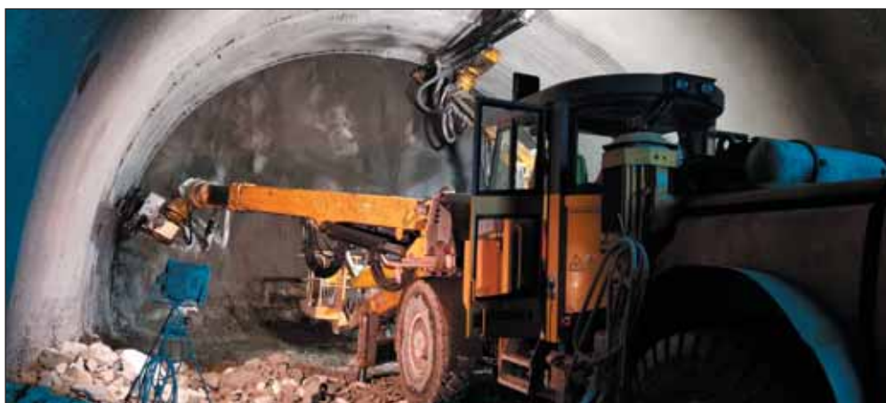
Obr. 5 Přímkový laser pro ustavení vrtacího stroje a vrtací stroj Boomer připravený k vrtání pro trhačí práce
