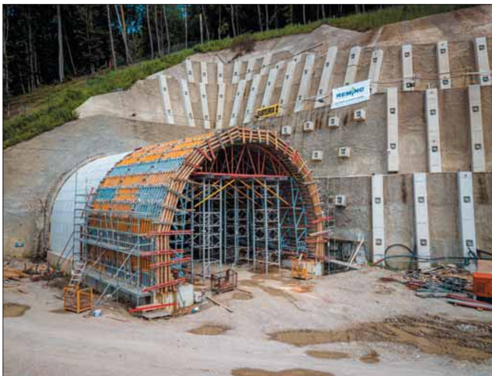
Obr. 5 Realizace definitivního ostění hloubené části západní portál Fig. 5 Implementation of the final lining of the open cut part of the western portal
