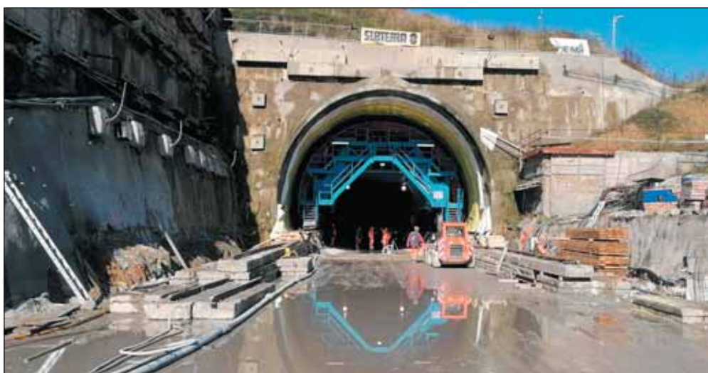
Obr. 6 Zahájení betonáže definitivního ostění v tunelu Fig. 6 Commencement of concreting of the final lining in the tunnel
