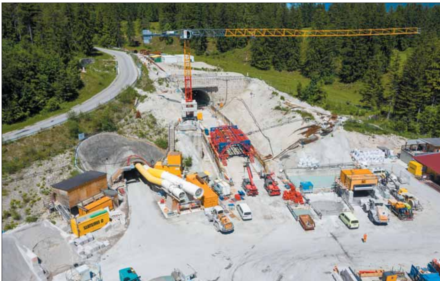
Obr. 5 Letecký pohled na portál jižního tunelu a únikové štoly Fig. 5 Aerial view of the portal of the southern tunnel and the escape gallery
