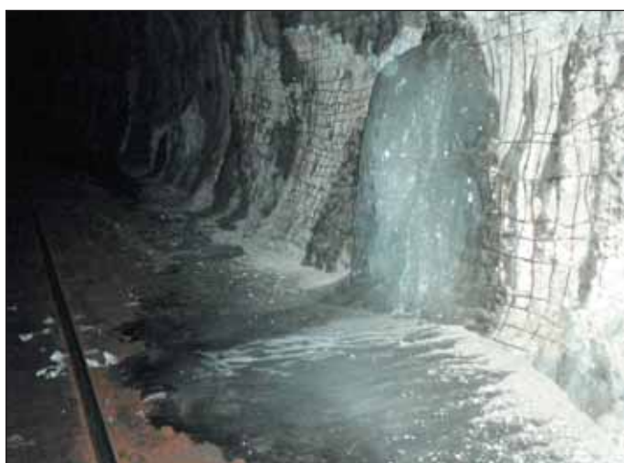
Obr. 6 Příklad zaledování tunelu Fig. 6 Example of an icefall in the tunnel
