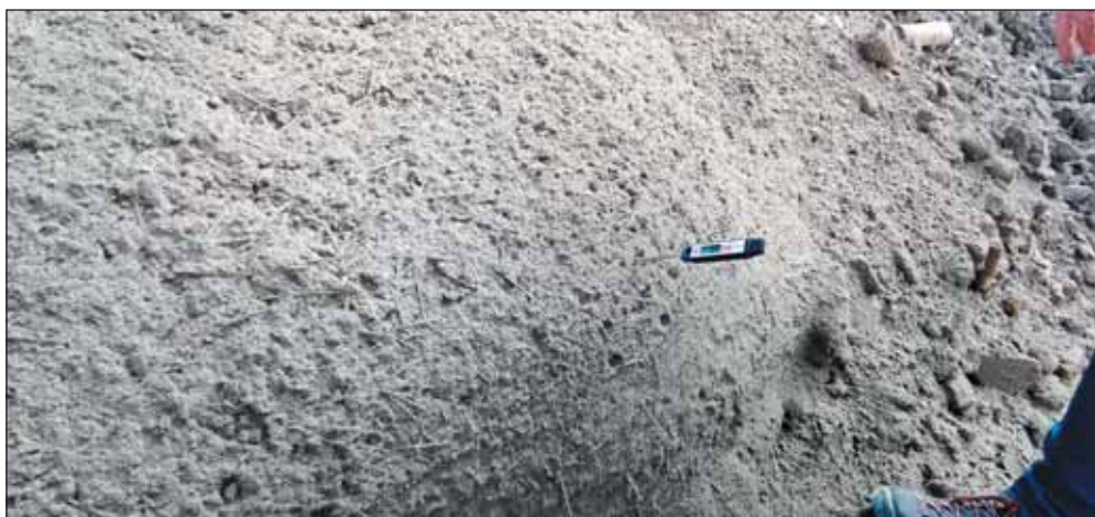
Obr. 6 Pohled na primární ostění ze strikaného betonu s rozptýlenou výztuží a detail struktury jeho povrchu Fig. 6 View of the fibre reinforced shotcrete primary lining and detail of the structure of its surface
