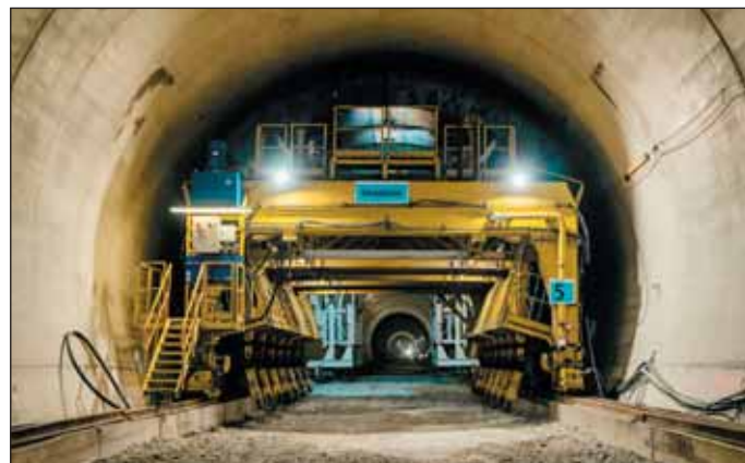
Obr. 6 Debniaci voz číslo 5 v tunelovej rúre Fig. 6 Formwork traveller No. 5 in tunnel tube
