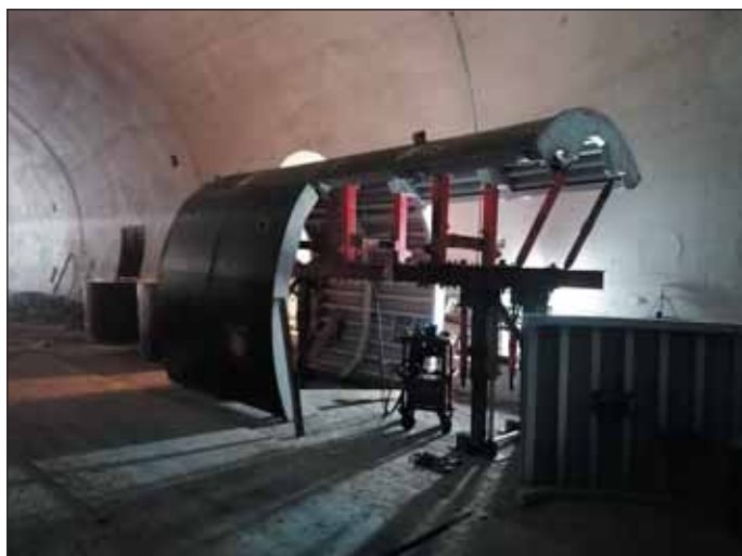
Obr. 10 Montáž ocelové formy do únikové štoly Fig. 10 Installation of a steel mold in the escape gallery
