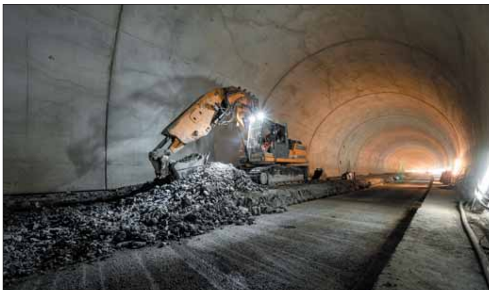
Obr. 7 Dobírání rubaniny pro spádové betony
