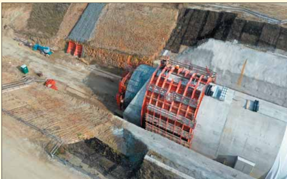
Obr. 5 Poslední blok betonáže ostění tunelu Zvěrotice Fig. 5 Last block of the lining being concreted, Zvěrotice tunnel
