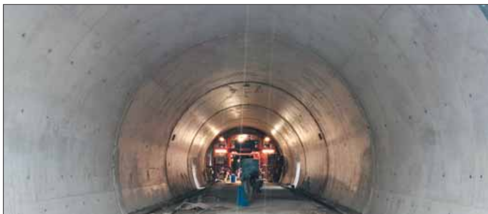
Obr. 10 Pohled na tunelovou formu s kontrabedněním a pohled do vybetonované části přesypané tunelu Fig. 10 A view of the tunnel formwork with counter-formwork and a view of the concreted part of the cut-and-cover tunnel
