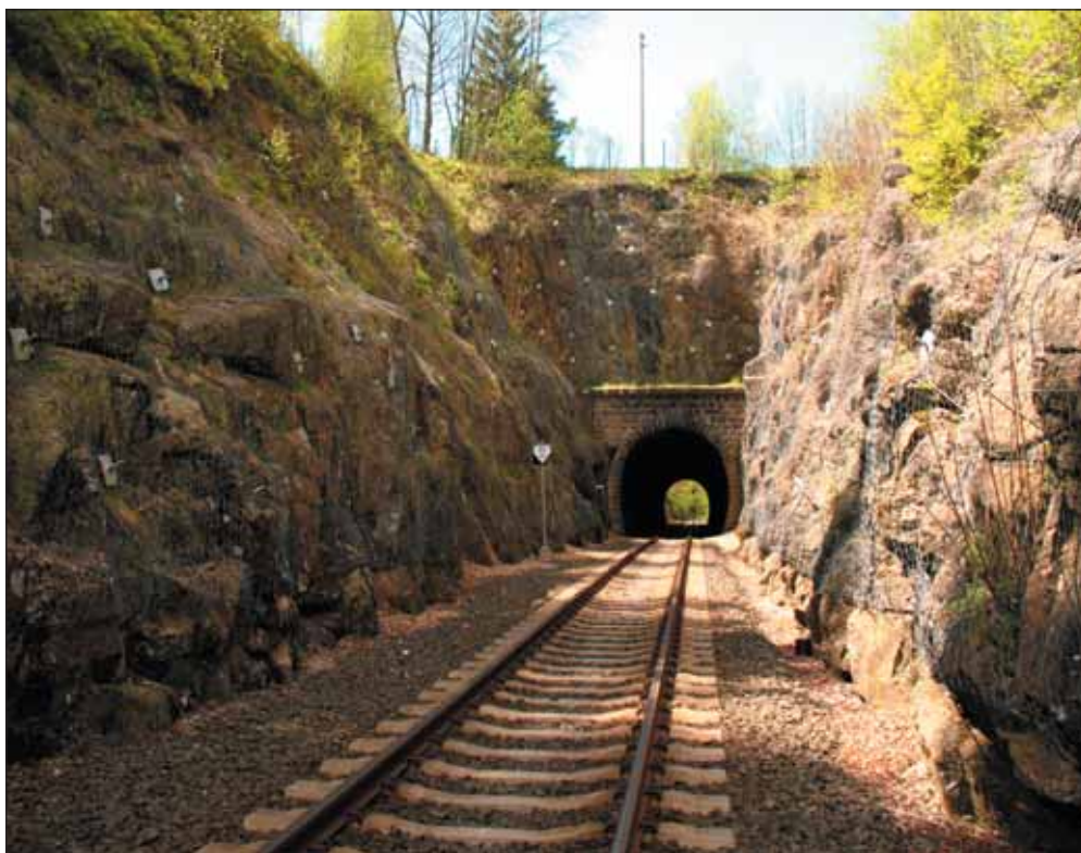
Obr. 13 Skalní zářez před portálem Fig. 13 Rock cutting in front of the portal
