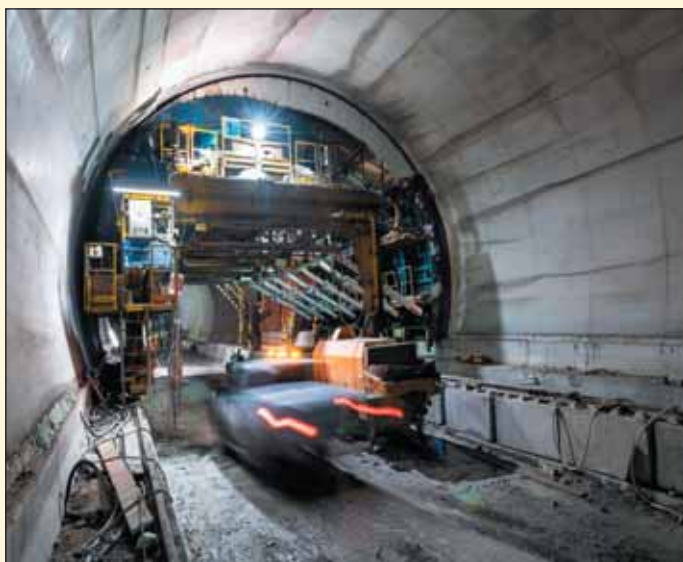
Obr. 7 Príprava debniaceho vozu pre betonáž ostenia v núdzovom zálive tunela Višňové
