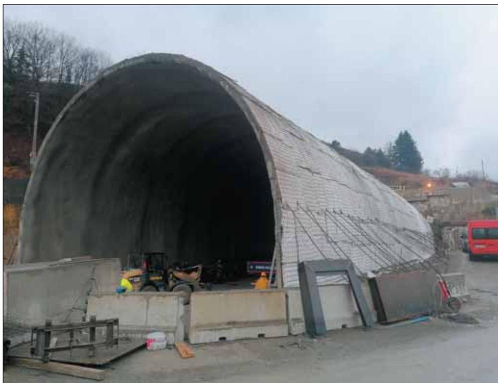
Obr. 4 Falešné primární ostění po dokončení Fig. 4 False primary lining after completion
