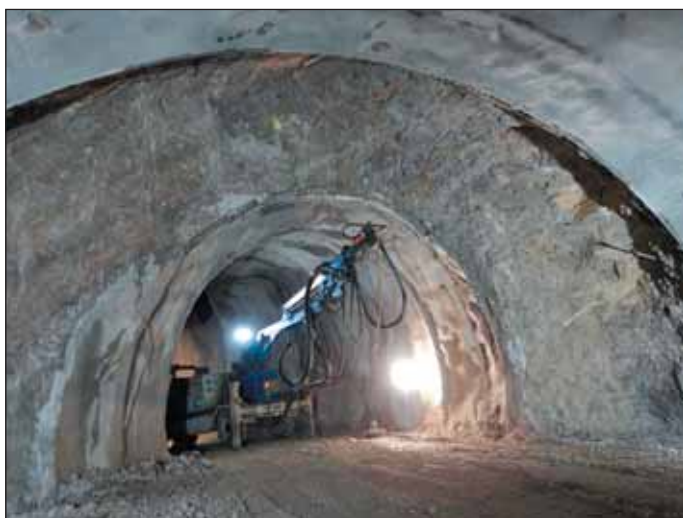
Obr. 12 Přeražba pomocné štoly
