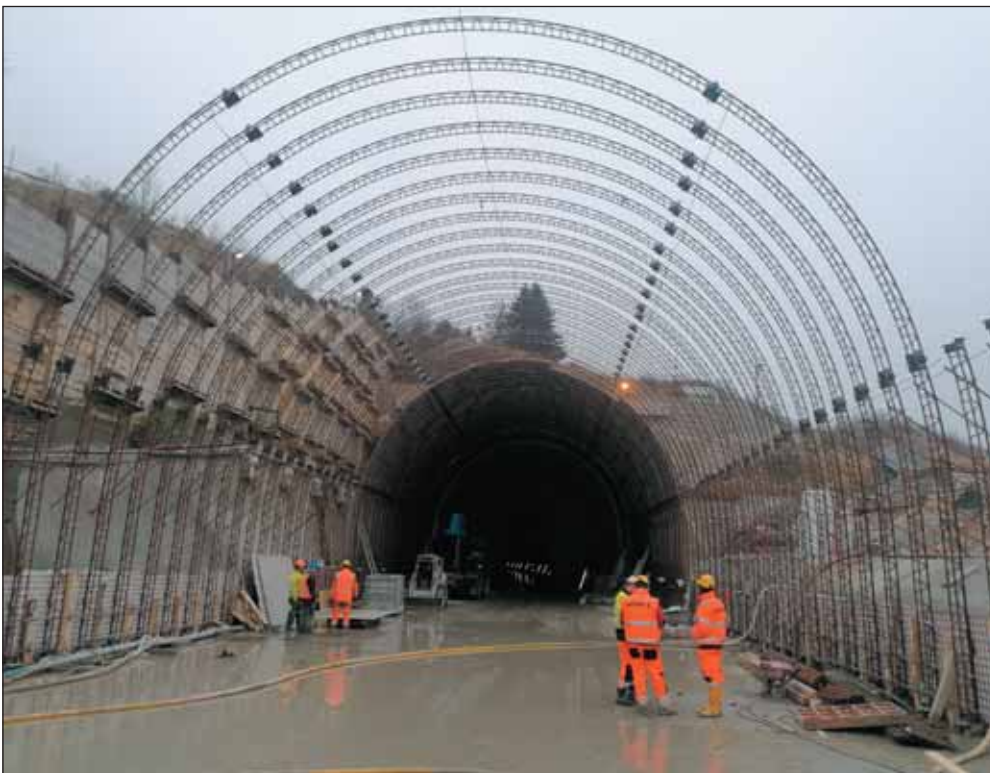
Obr. 3 Realizace falešného primárního ostění Fig. 3 Implementation of false primary lining
