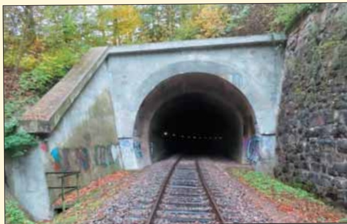
Obr. 9 Současný stav jižního – vjezdového – portálu Litického tunelu. Nová betonová konstrukce z let 1968–1973 byla o 3 m přesunutá před historický vstup. [Foto: K. Doležal, SŽ OŘ HK SMT]
