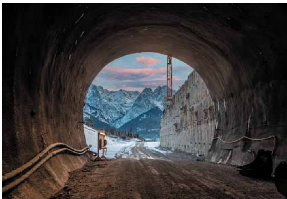
Obr. 1 Pohled z tunelu na masiv Zugspitze, jižní portál Fig. 1 View from the tunnel on the Zugspitze massif, southern portal
