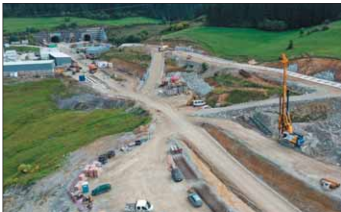
Obr. 1 Práce na diaľnici pred západným portálom tunela Fig. 1 Work on the motorway in front of western portal of the tunnel
