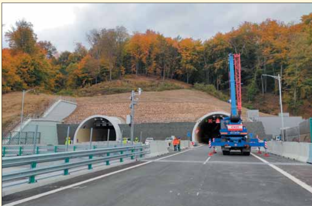
Obr. 6 Východný portál tunela Prešov Fig. 6 Eastern portal of Prešov tunnel
