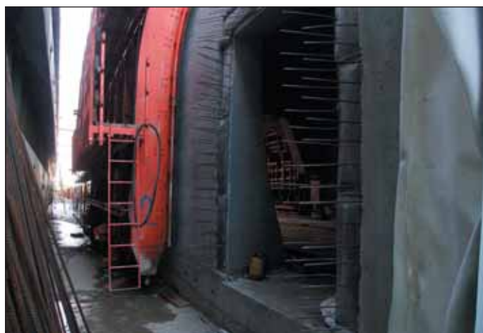
Obr. 3 Bednění vůz mezi pilotami – vzdálenost k pilotové stěně Fig. 3 Formwork gantry between pilots – distance to the pile wall
