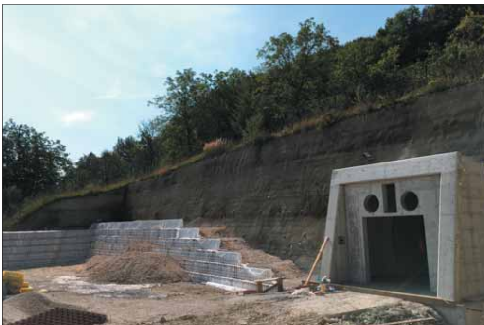
Obr. 15 Rozpracované terénní úpravy portálu únikové štoly Fig. 15 Work in progress of the landscaping of the escape gallery portal
