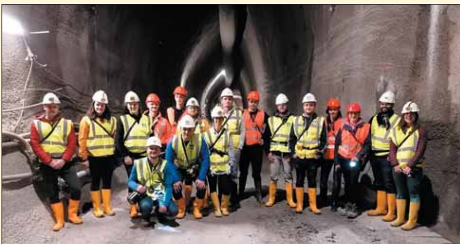
Obr. 3 Návštěva tunelových staveb Doplíkového geologického průzkumu úseku Metra I.D1 v Praze na Pankráci
