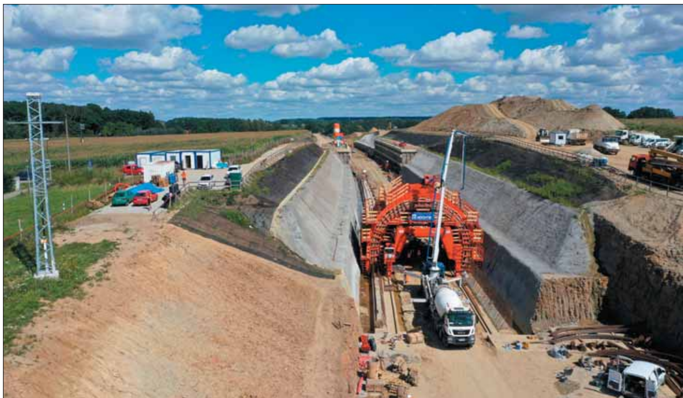
Obr. 5 Skutečný rozsah svahované stavební jámy a zajištění pilotovými stěnami Fig. 5 Actual extent of the sloped construction pit and the pile walls
