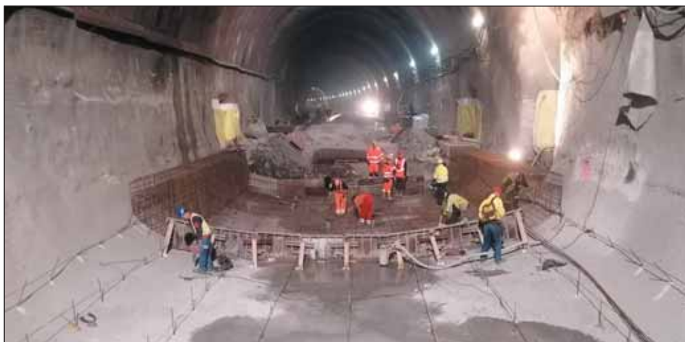
Obr. 2 Armování protikleneb Fig. 2 Invert vault reinforcement
