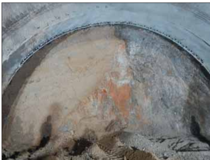
Obr. 14 Protiražba jih – kombinace dolomitických souvrství a šterkopísků Fig. 14 Counterdrive south – a combination of dolomitic formations and gravel sands
