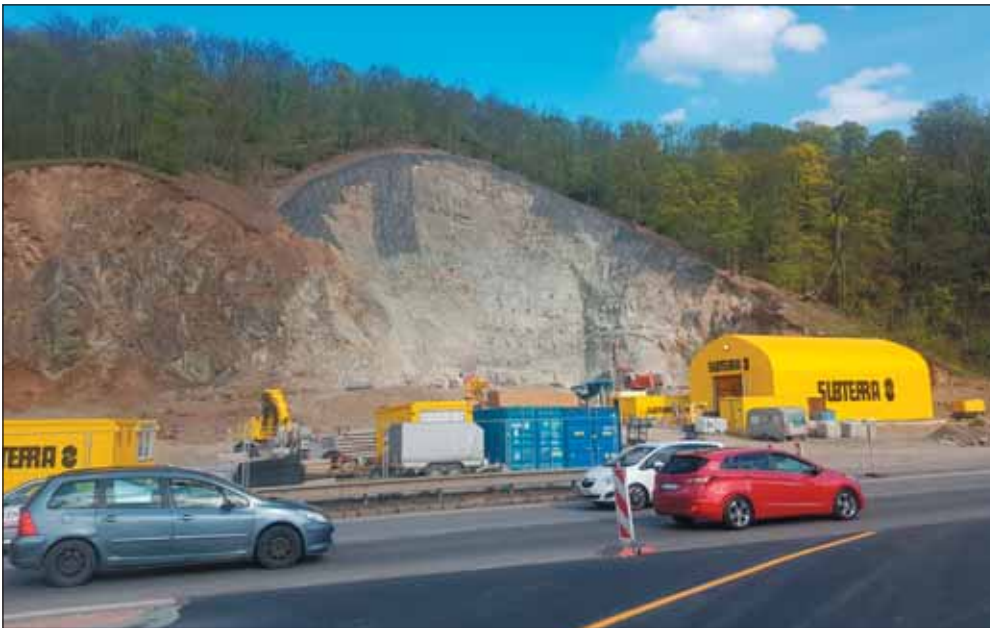
Obr. 8 Zajišťování skalního svahu severního portálu tunelu s nájezdovou rampou Fig. 8 Stabilising the rock slope at the northern portal of the tunnel with the entry ramp
