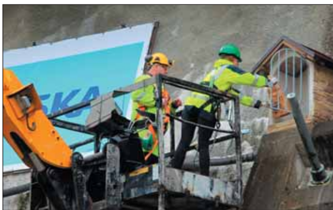
Obr. 3 Osadenie sošky sv. Barbory na západnom portáli tunela Fig. 3 Installation of St. Barbara statuette at western portal of the tunnel
