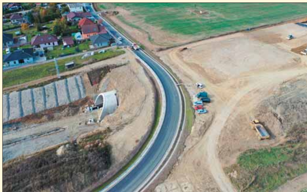
Obr. 4 Nová komunikace nad tunelem Zvěrotice Fig. 4 New road above the Zvěrotice tunnel
