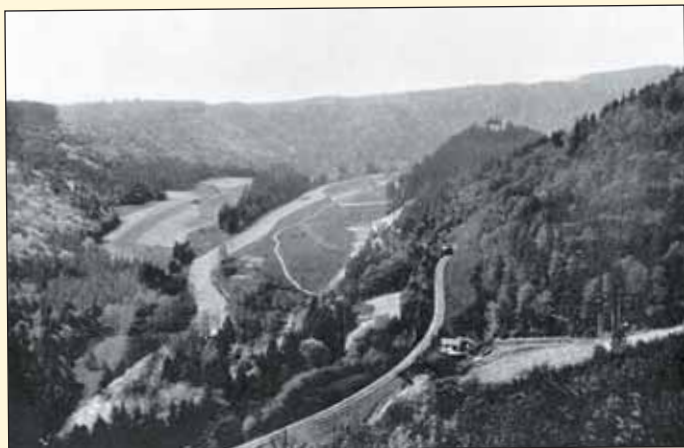
Obr. 6 Romantický pohled na údolí řeky Orlice, trať a Litický tunel. 1895 [7] Železnice je vedena půvabným údolím Divoké Orlice, která zde obtéká Hradní kopec (451 m. n. m.) se zříceninou hradu Litice (v pozadí).
