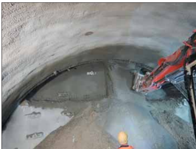
Obr. 15 Dílčí výrub čelby – ražba z jižního portálu (s čelbovým klínem) Fig. 15 Partial face excavation – excavation from the southern portal (with the face berm)
