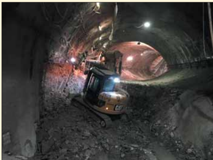
Obr. 1 Probíhající ražby na PAD4 při rozšiřování profilu průzkumné štoly na budoucí tvar přestupní chodby
