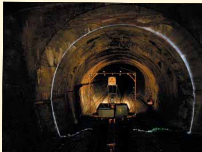
Obr. 12 Měření prostorové průchodnosti v tunelu fotogrammetrickým strojem FS3. [Foto: K. Doležal, SŽ OŘ HK SMT]. Z obr. 8 a 9 je patrný neporušený profil a celkově dobrý stav ostění tunelu.
