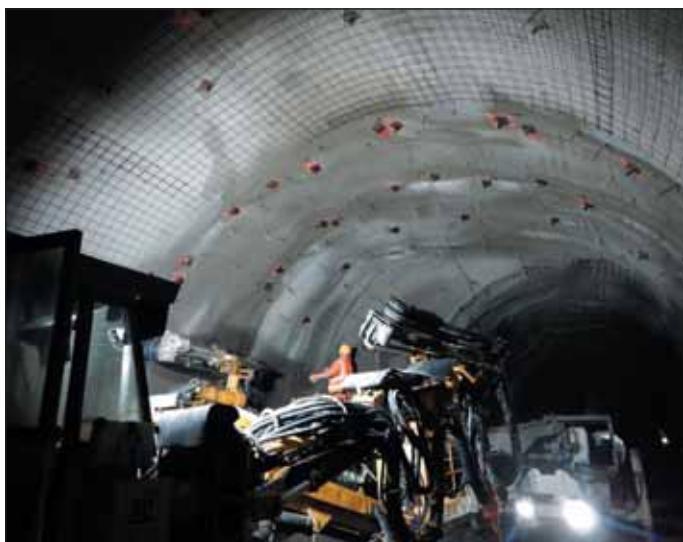
Obr. 17 Sanace nadprofilu v únikové štolce
