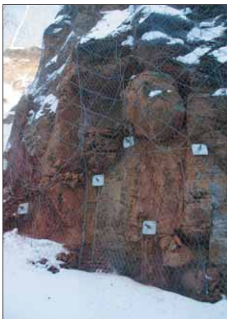
Obr. 2 Blokovitá odlučnost – skalní zářez před portálem Fig. 2 Block jointing – rock cutting in front of portal
