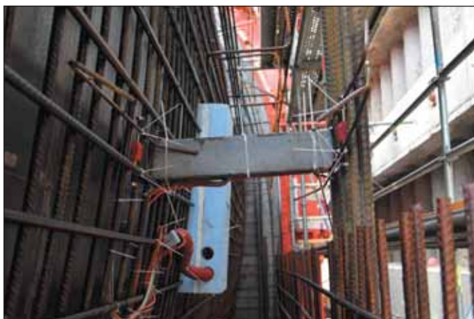
Obr. 12 Měřický profil pro sledování teploty v ostění Fig. 12 Measuring profile for monitoring the temperature in the lining
