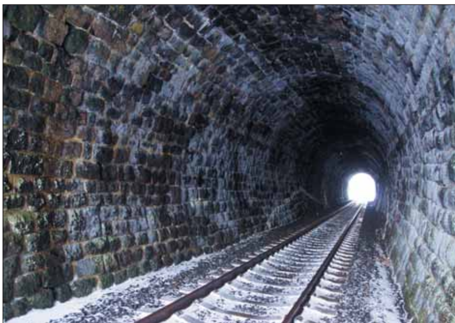
Obr. 3 Stav obezdívky v suchém období Fig. 3 Condition of the lining in dry season
