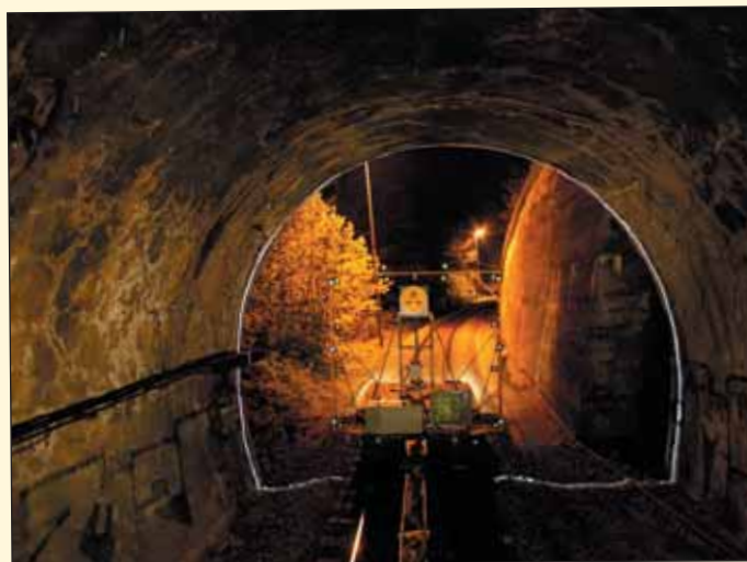
Obr. 11 Měření prostorové průchodnosti u severního – výjezdového – portálu. Noční výhled směrem k žst. Litice n/Orlicí. Srovnaj s obr. 2 a 3. [Foto: K. Doležal, SŽ OŘ HK SMT]
