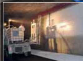
Náhrada betonu a ochranné systémy
