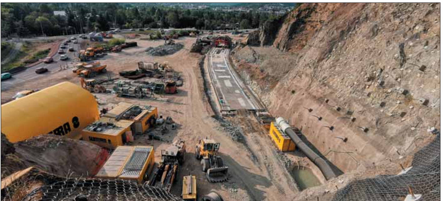
Obr. 9 Pohled shora na severní portál se zázemím pro ražbu tunelu a výstavbou přesypané části tunelu Fig. 9 View of the northern portal with background facilities for tunnel excavation and construction of the cut-and-cover part of the tunnel
