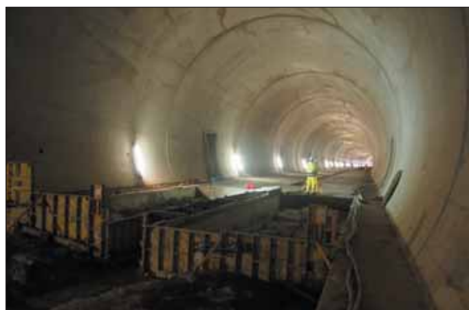
Obr. 6 Betonáž sekundárního ostění a dna tunelu Fig. 6 Concreting of secondary lining and tunnel bottom
