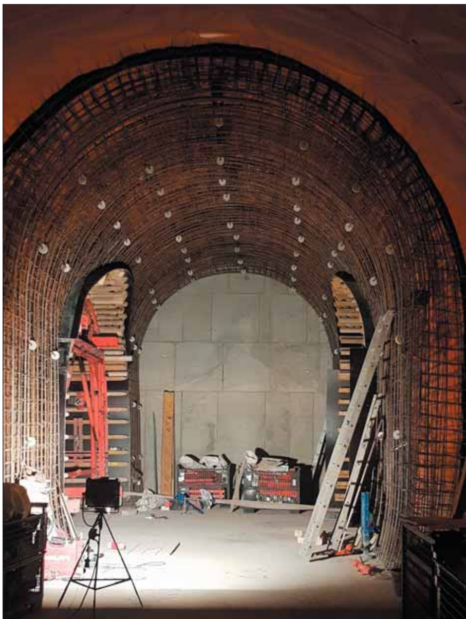
Obr. 7 Armování definitivního ostění křížení přestupní chodby Fig. 7 Placement of reinforcement of transfer gallery final lining crossing
