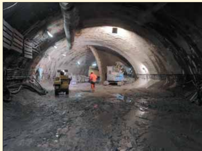
Obr. 3 Lokalita PAD4, pohled na ražbu a členění čelby štoly Fig. 3 Locality PAD4, a view of the excavation and the gallery excavation sequences
