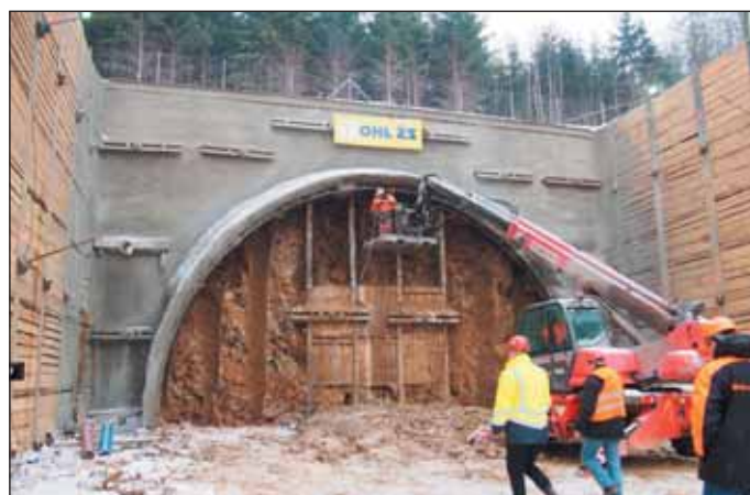
Obr. 2 Zahájení ražby ze stavební jámy výjezdového portálu Fig. 2 Beginning of tunnel excavation from construction pit at entrance portal
