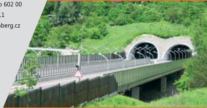
Pisárecký tunel, stavba roku 1998
