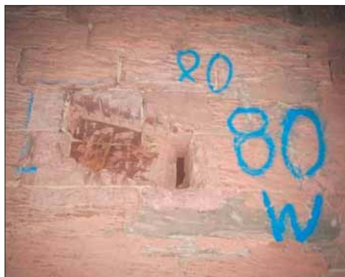
Obr. 8 Úprava otvoru před položením hydroizolace Fig. 8 Adjustment of the hole before installation of waterproofing membranes
