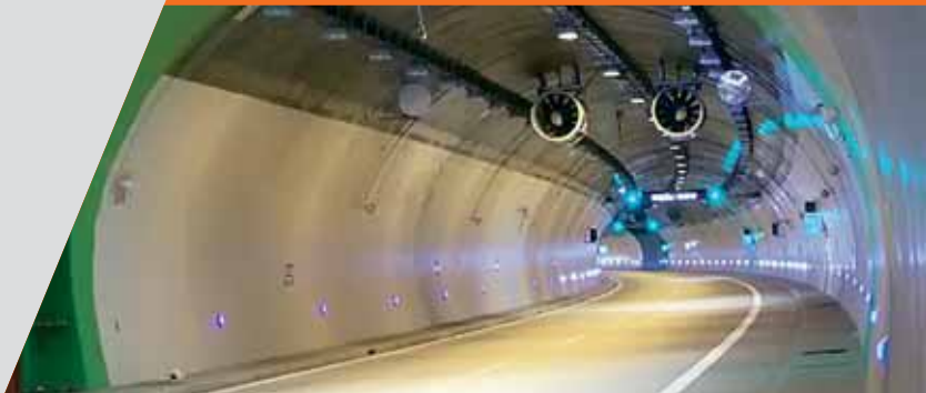
Tunel Klimkovic, stavba roku Moravskoslezského kraje 2008
