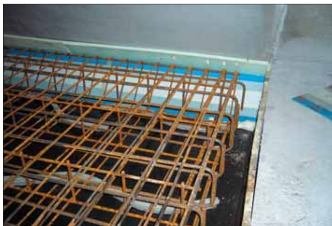
Obr. 2 Vyztuž a uložení desek mezistropů na ložiscích MAGEBA
