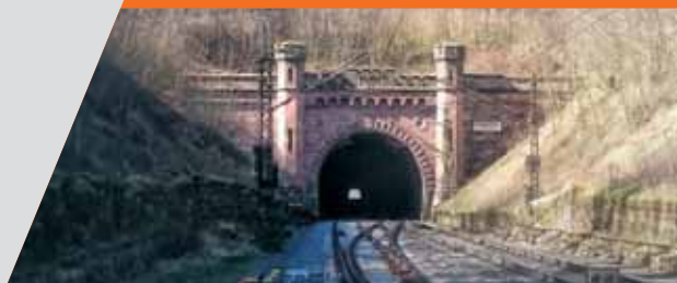
Cornberg tunel, rok 2020
