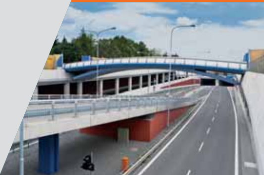
Královopolský tunel, stavba roku 2013
