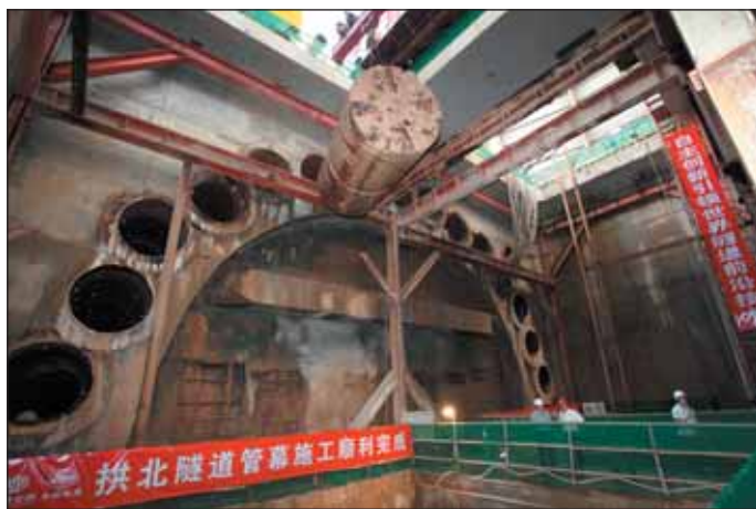
Obr. 9 Realizace pipe-roofingu pomocí AVN 1200 na silničním tunelu Gongbei v Číně
