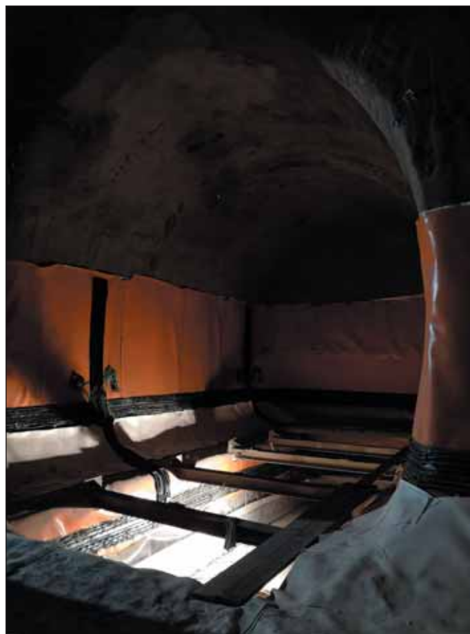
Obr. 6 Prostup do stanice s dočasnými rozpěrami Fig. 6 Opening to the station with temporary bracing
