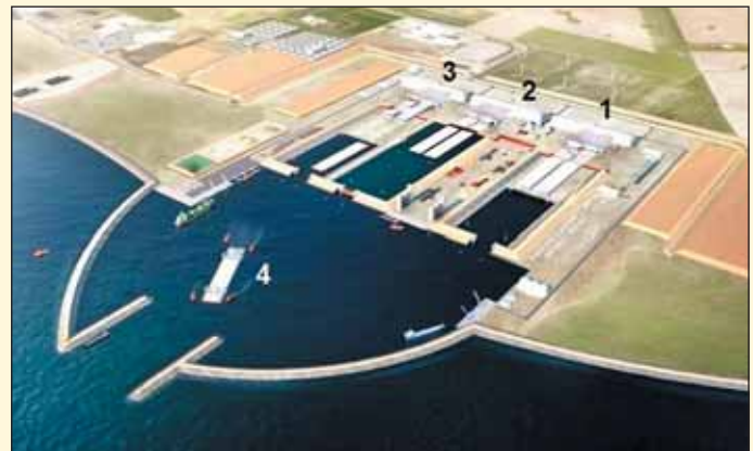
Obr. 4 Výrobní dok tunelových dílců v dánském Rodbyhavn 1 – výroba tunelových dílců 2 – nappuštění doku vodou 3 – vypuštění plovoucího dílce z doku 4 – doprava
