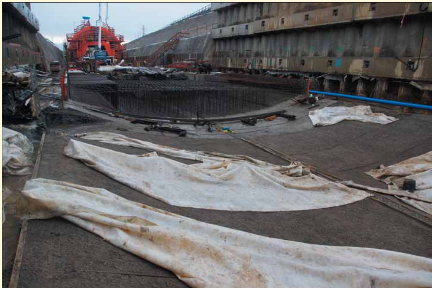
Obr. 6 Montáž výztuže spodní klenby tunelu Zvěrotice Fig. 6 Assembly of reinforcement of the inverted vault in the Zvěrotice tunnel
