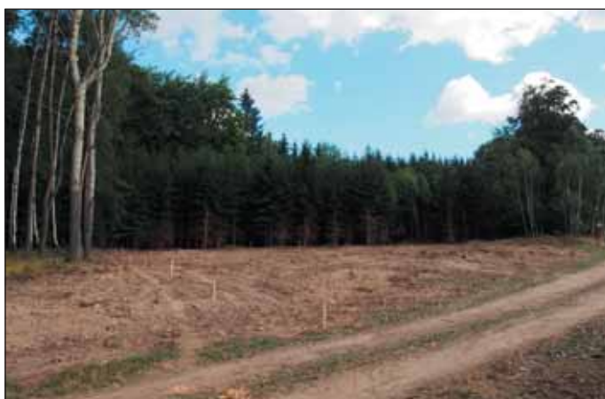
Obr. 1 Příprava hloubení stavební jámy výjezdového portálu Fig. 1 Preparation of excavation of construction pit at entrance portal
