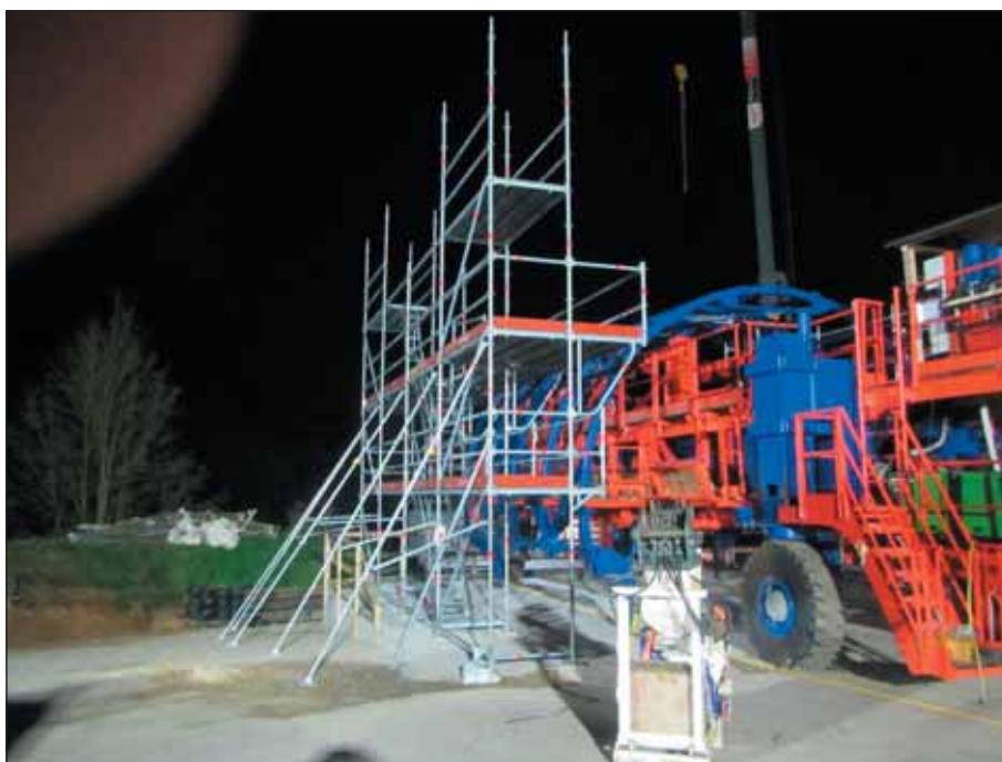
Obr. 6 Montáž bednicí formy Fig. 6 Assembly of formwork
