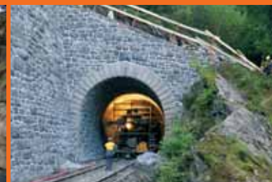
Rekonstrukce Podhradského tunelu, rok 2020
