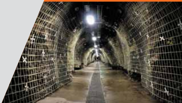
Odvodňovací štola VD Šance, stavba roku 2014 (ČKAIT)
