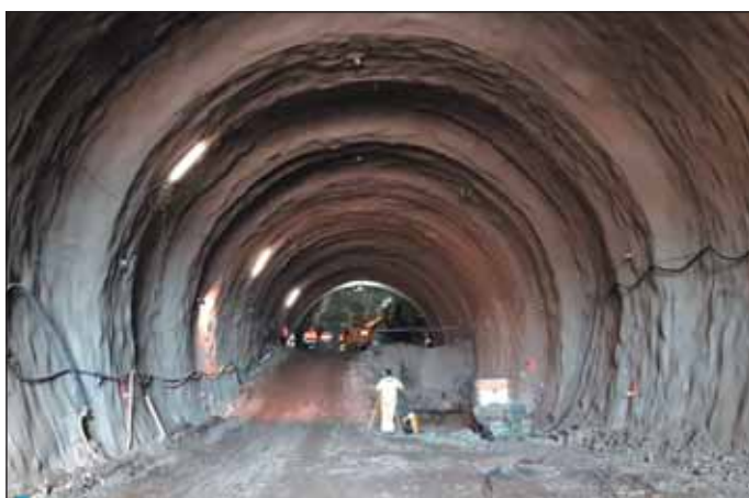
Obr. 3 Ražba tunelu ve vstrojovací třídě 5a a 4 Fig. 3 Tunnel excavation in support classes 5a and 4
