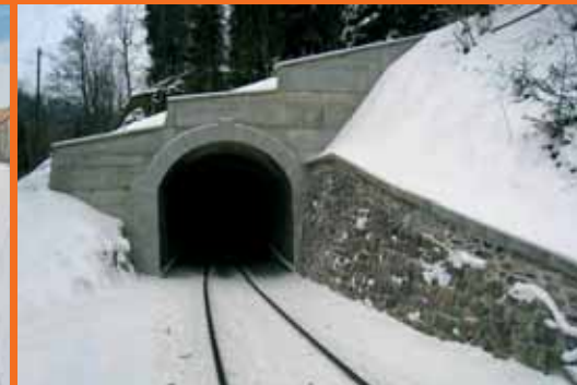
Rekonstrukce Domašovského tunelu, rok 2013
