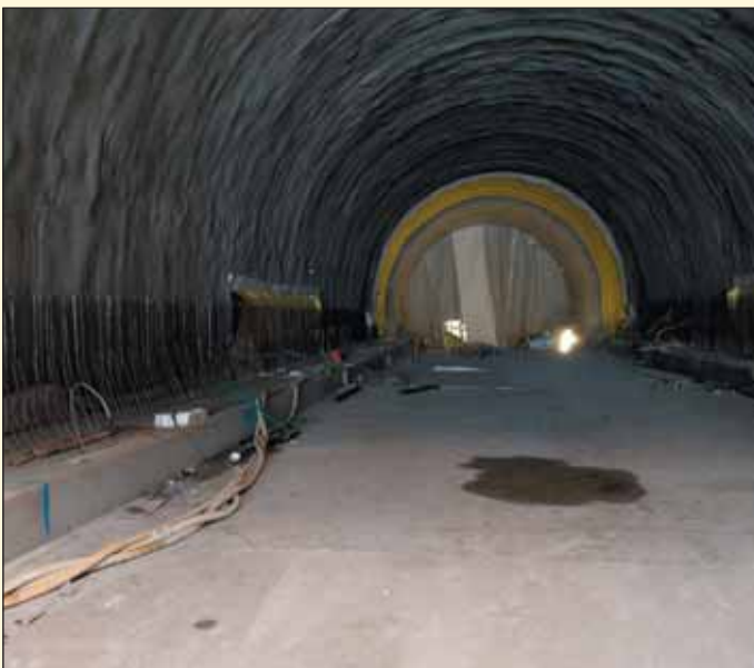
Obr. 8 Falošný primár hĺbenej časti na východnom portáli tunela Milochovo Fig. 8 False primary lining of the cut-and-cover part at the eastern portal of the Milochovo tunnel.
