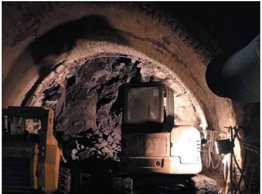
Obr. 4 Ražba kaloty přestupní chodby Fig. 4 Excavation of transfer gallery top heading
