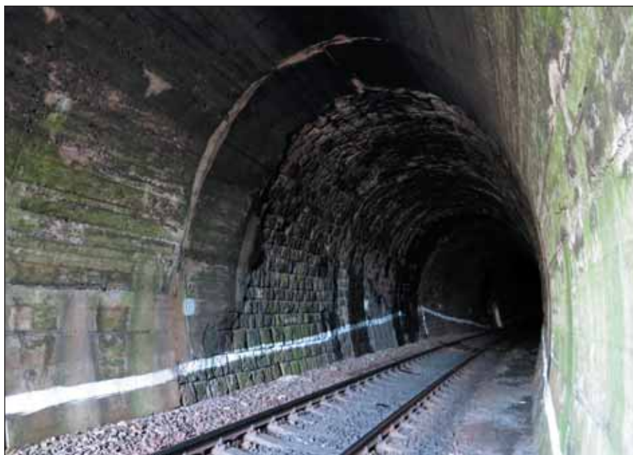
Obr. 3 Štubniansky tunel Fig. 3 Štubná tunnel
