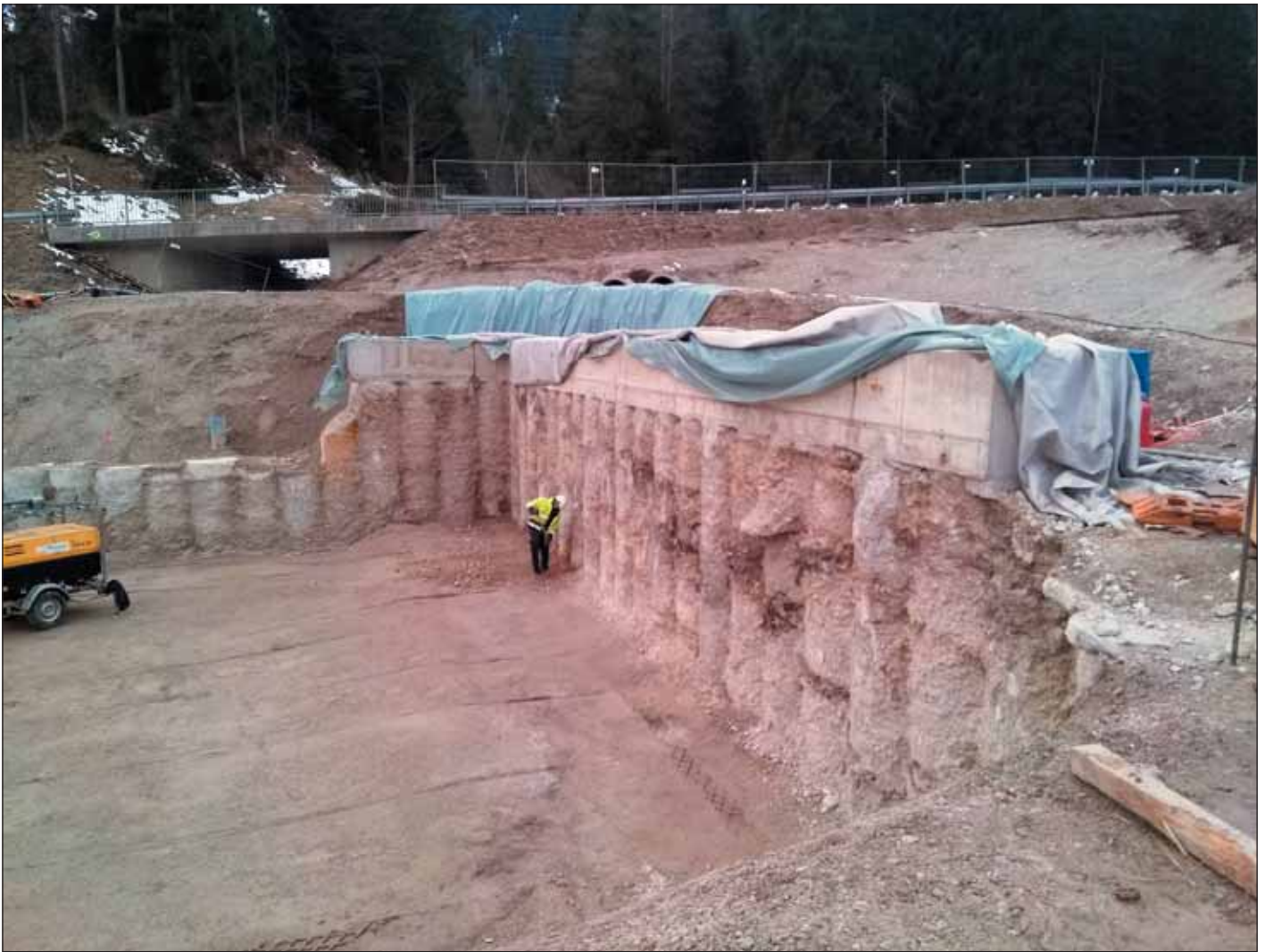
Obr. 5 Hloubená část jih Fig. 5 Cut-and-cover part south
