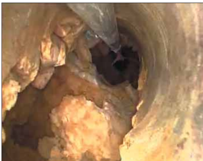
Obr. 12 Fotografie pořízené při kamerové dokumentaci vrtů: horní obrázek představuje zastížené zkrasování, dolní je záznamem ze zvodnělého vrtu v místě přítoku vody do vrtu z otevřené pukliny
