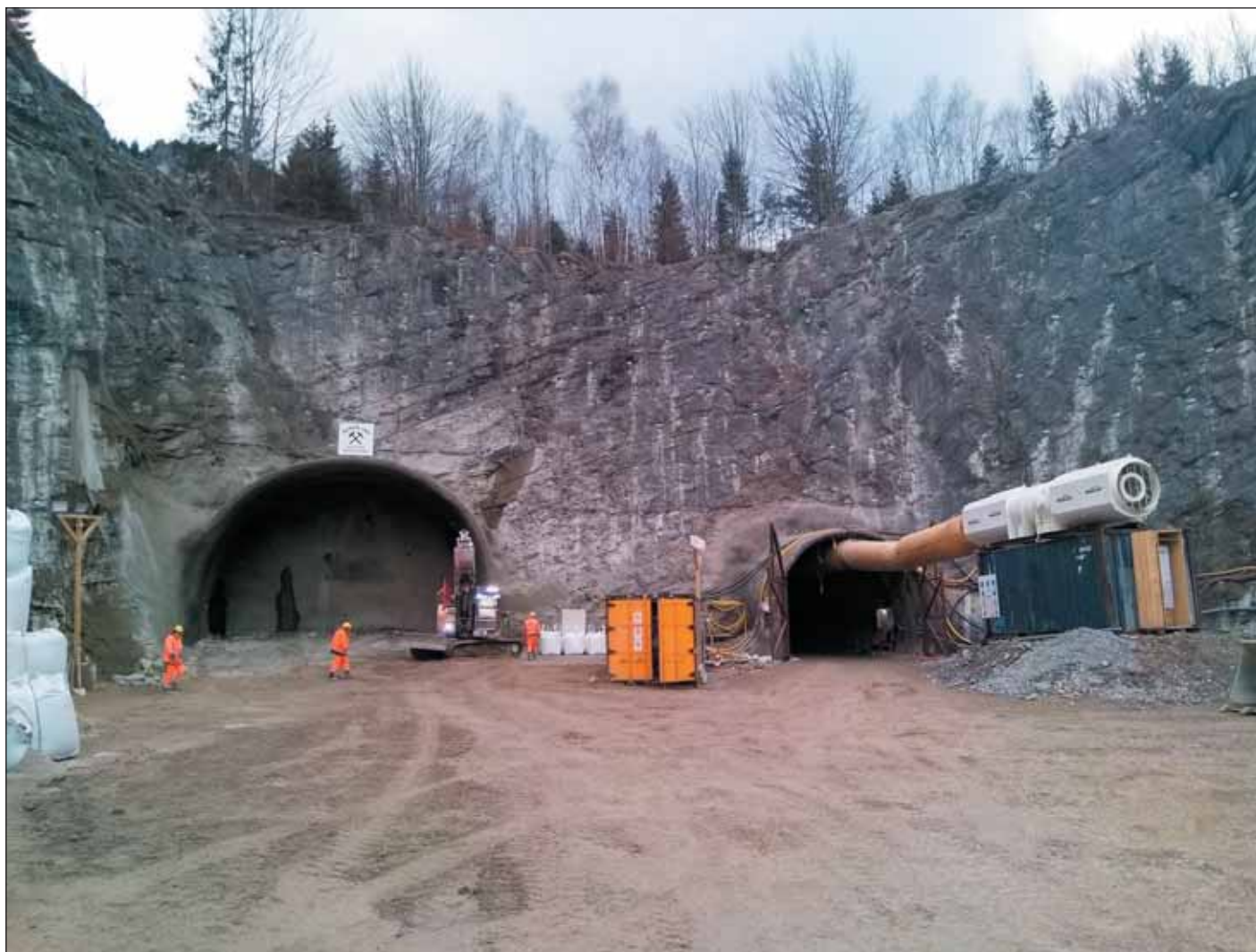
Obr. 4 Hloubená část sever před zahájením ražeb
