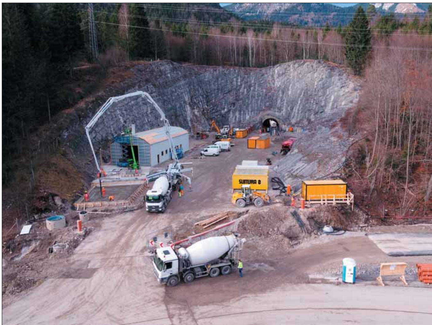
Obr. 2 Zařízení staveniště, portál sever
