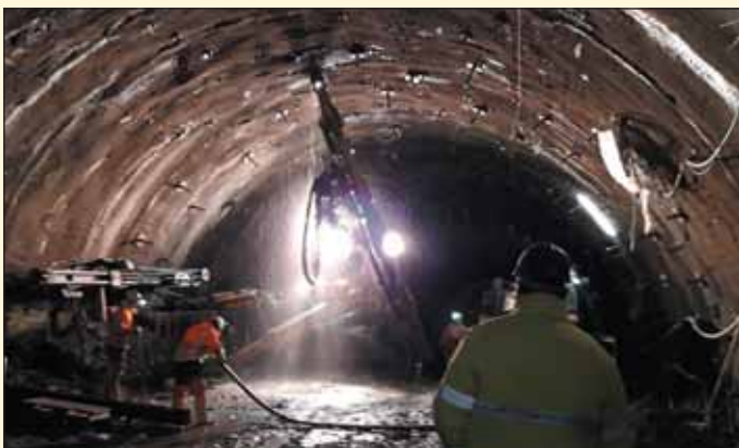
Obr. 5 Vrtání dodatečných kotev IBO R51L délky 12 m Fig. 5 Drilling for additional 12m long IBO R51L anchors
