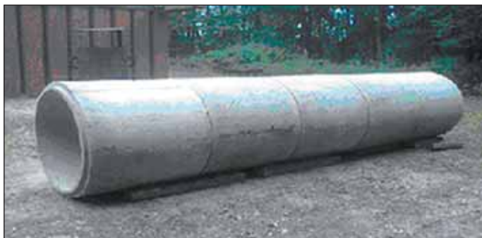
Obr. 1 Pohled na uspořádání zkušební trouby Fig. 1 A view of the assembly of the rings
