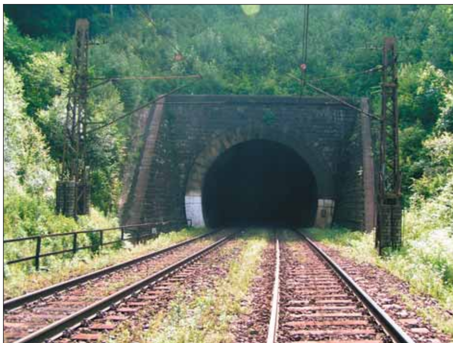
Obr. 5 Bujanovský tunel – Margecanský portál Fig. 5 Bujanov tunnel – Margecany portal
