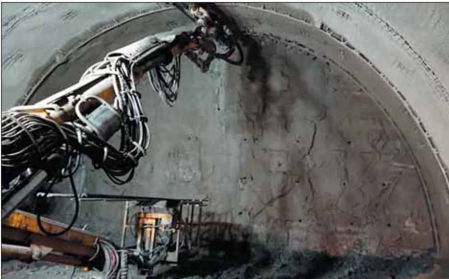
Obr. 8 Tunel Prešov, razenie kaloty
