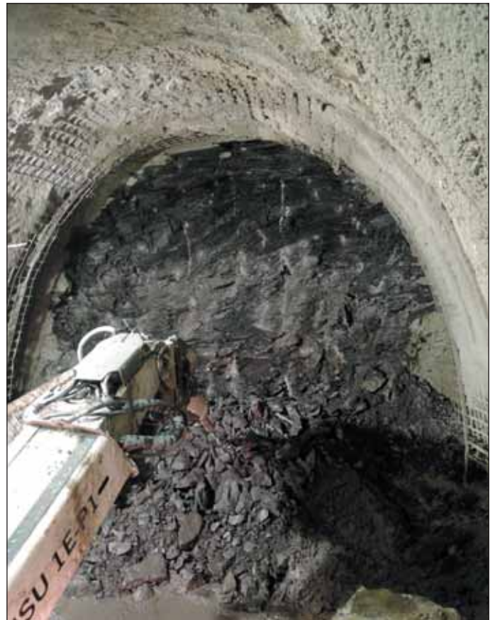
Obr. 6 Čelba ve zdravých zahořanských břidlicích, staničení 19,7 m úseku J38-TK5
