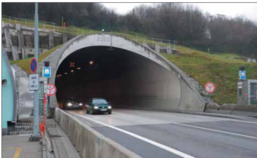
Obr. 9 Tunel Horelica, severný portál
