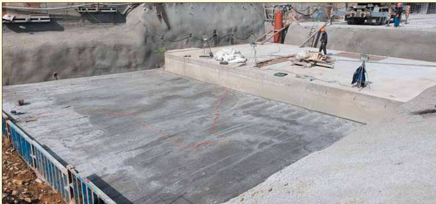
Obr. 8 Zakladanie hĺbeného tunela VP tunela – východný portál, Milochov Fig. 8 Foundation of the cut-and-cover tunnel at the EP of the Milochov tunnel
