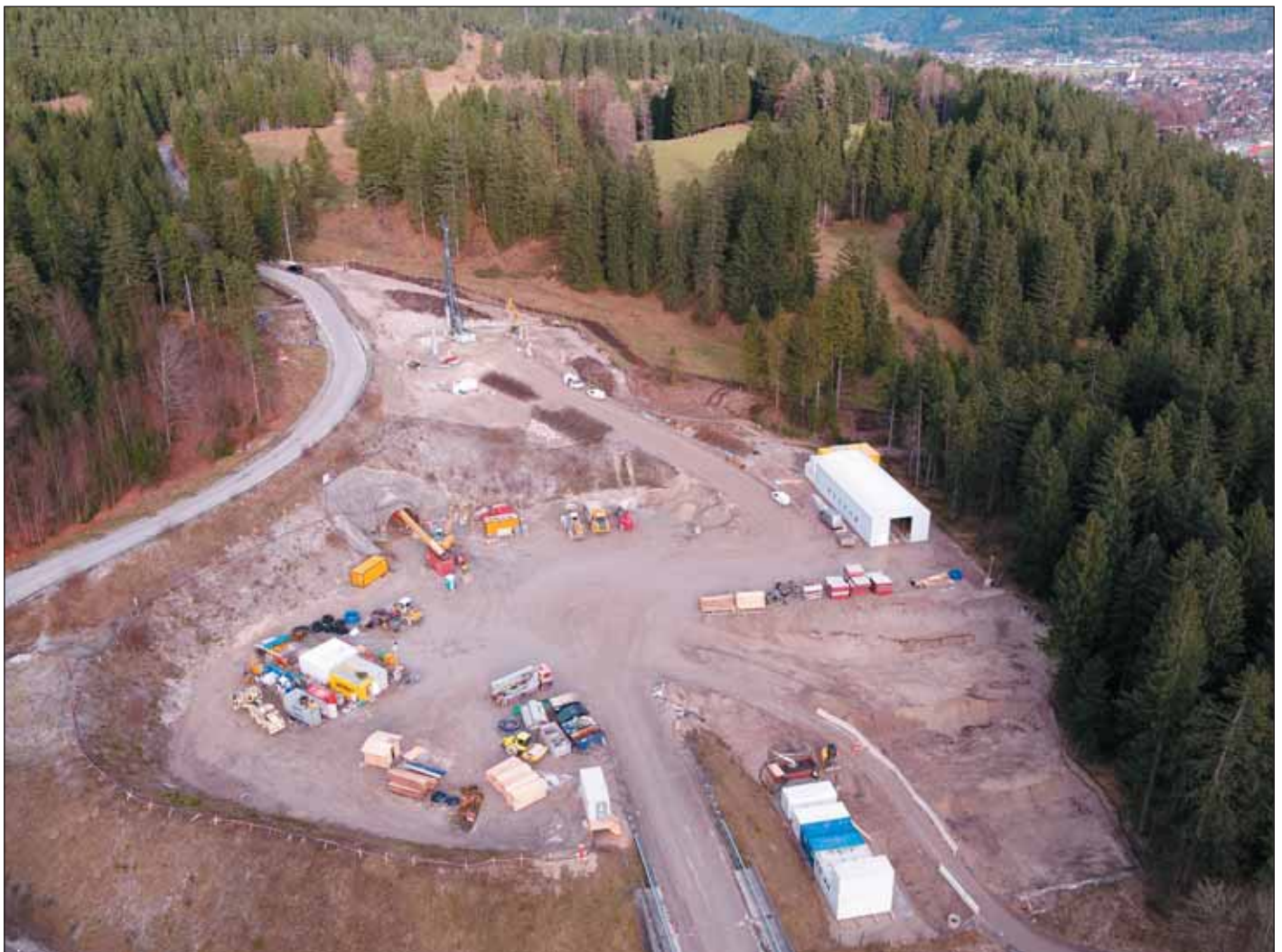
Obr. 3 Zařízení staveniště, portál jih
