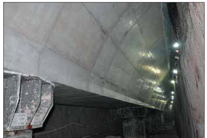
Obr. 7 Pohled na zhotovený podélný trám v jedné ze středních horních štol, vlevo je část konstrukce hlavy ocelobetonového sloupu
