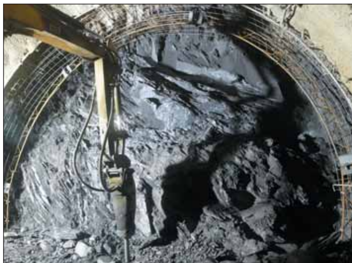
Obr. 4 Fotografie čela výrubu z úseku II přístupové chodby Fig. 4 Picture of excavation face from section II of the access gallery
