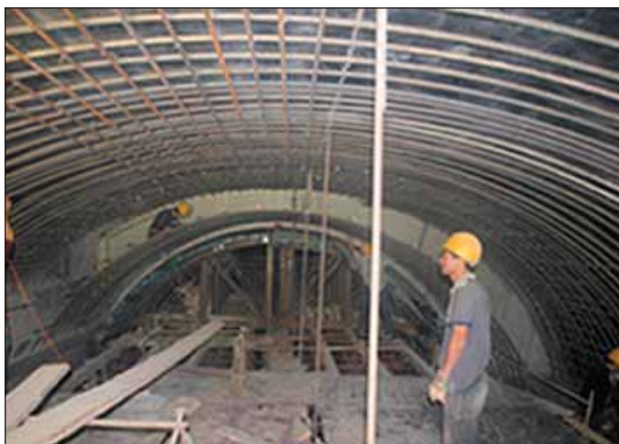
Obr. 8 Výstavba klenby Fig. 8 Construction of a vault
