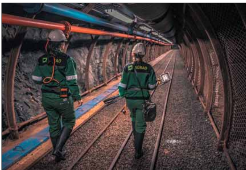
Obr. 2 Přístupová chodba BZ-XIIJ v PVP Bukov Fig. 2 The BZ-XIIJ access corridor at the Bukov URF
