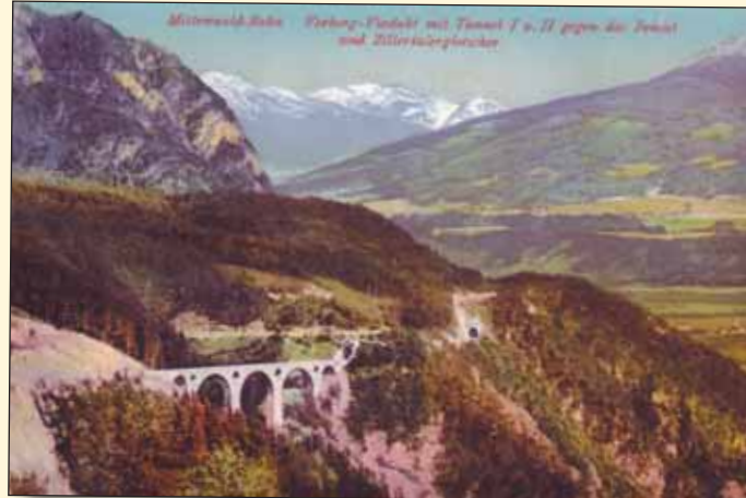
Obr. 3 Mittenwaldská dráha. Viadukt Vorberg s tunely I a II proti údolí Innu a ledovci v údolí Zilleru. Kolorovaná fotografie. Purger & Co., München. Photochromiekarte Nr. 12618. Cca 1910. [sbírka autorů]
