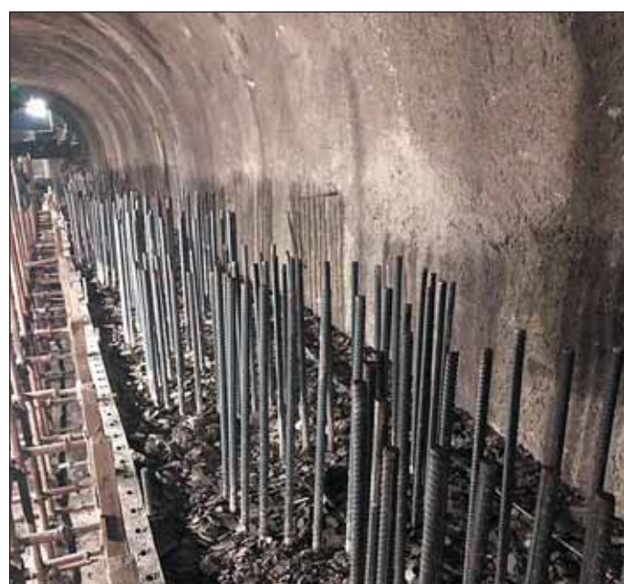
Obr. 5 Pohled na vyústění pilotové stěny v horní vnější pomocné chodbě
