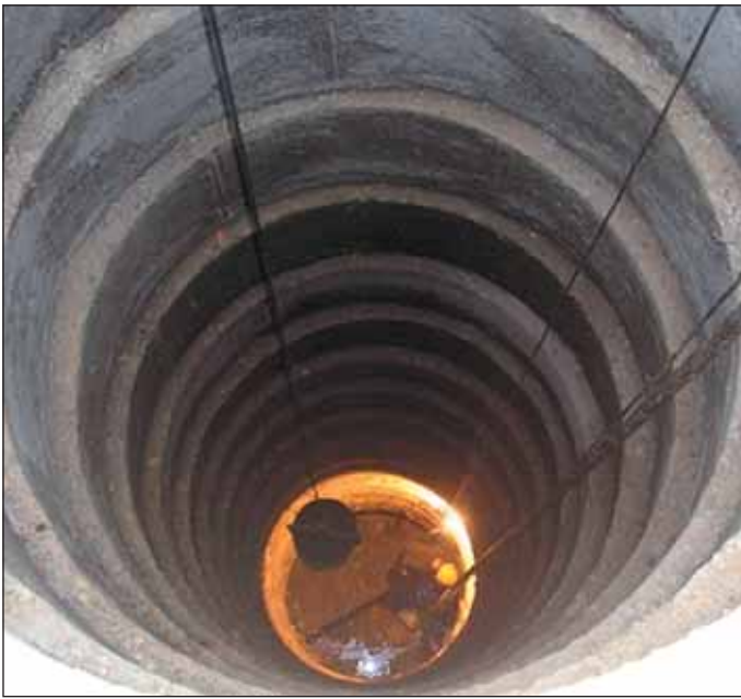
Obr. 6 Pohled z horní vnitřní pomocné chodby na ruční hloubení šachtice před instalací ocelobetonového sloupu (vlevo) a instalované ocelobetonové sloupy (vpravo)
