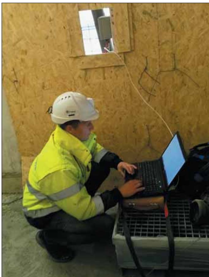
Obr. 8 Měření tenzometrického profilu na ohlubni šachty Š2 v objektu Václavská 2068/14
