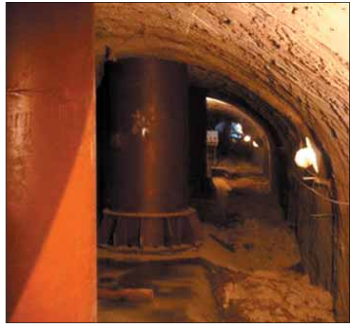
Obr. 6 Pohled z horní vnitřní pomocné chodby na ruční hloubení šachtice před instalací ocelobetonového sloupu (vlevo) a instalované ocelobetonové sloupy (vpravo)
