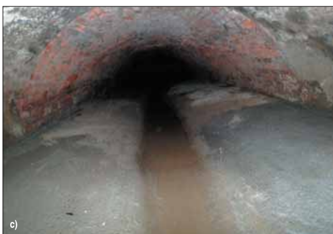
Obr. 2 Fotografie příčných zděných profilů potoka, a) cihlové zdivo – 1100/1500, b) cihlové zdivo – 1800/2000, c) cihlové zdivo – 1500/2500, d) cihlové zdivo – 1550/2500
