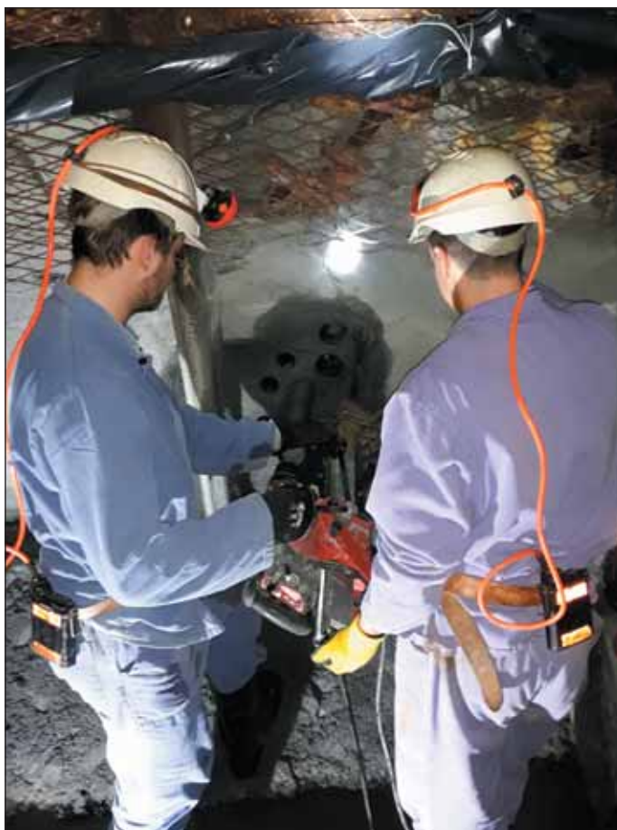
Obr. 7 Odvrtávání vzorků z nastříkaného betonu v PVP Bukov Fig. 7 Drilling of sprayed concrete samples at the Bukov URF
