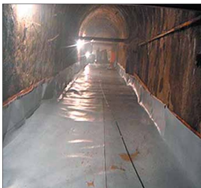
Obr. 4 Pohled na zhotovený základový pás v dolní pomocné chodbě s položenou hydroizolací
