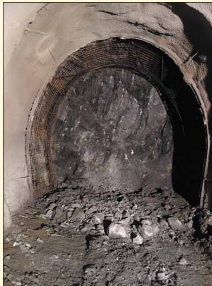
Obr. 8 Razenie únikovej štôľne tunelu Milochovo Fig. 8 Excavation of the escape gallery of the Milochovo tunnel
