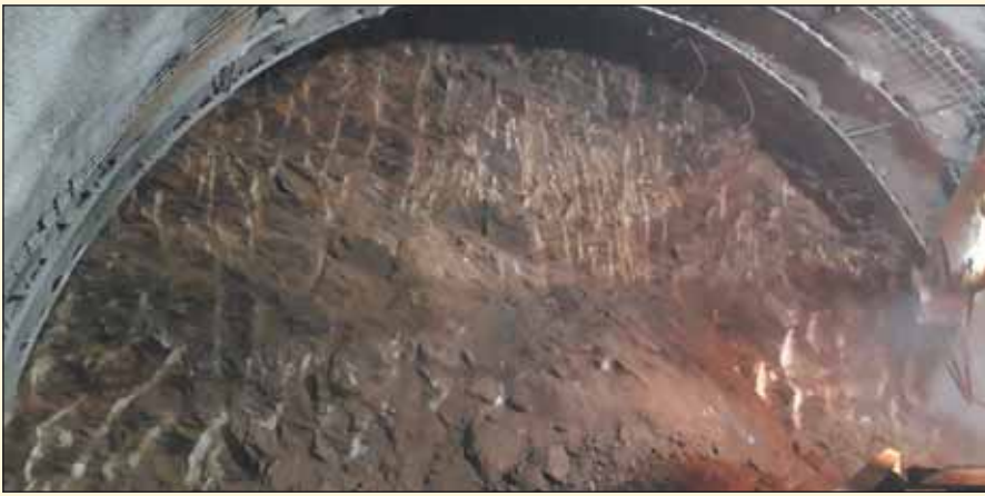
Obr. 4 Čelba kaloty tunelu Deboreč v TM 535
