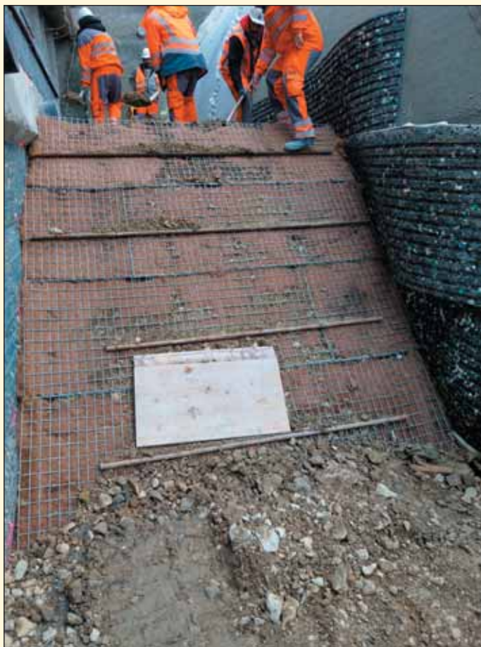
Obr. 7 Realizácia konečných terénnych úprav západného portálu Diel Fig. 7 Final ground shaping at the western portal of the Diel tunnel
