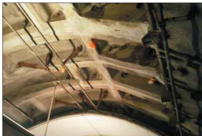
Obr. 7 Upevnění měřicích konvergenčních bodů na ostění stávající stanice metra Karlovo náměstí
