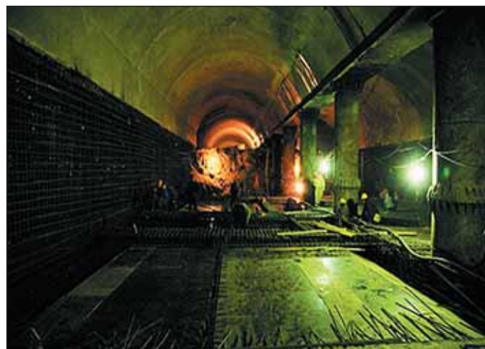
Obr. 9 Pohled na odtěženou horní etáž budované stanice Fig. 9 View of the excavated upper level of the station under construction
