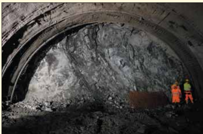
Obr. 9 Tunel Milochovo – čelba v kalote
