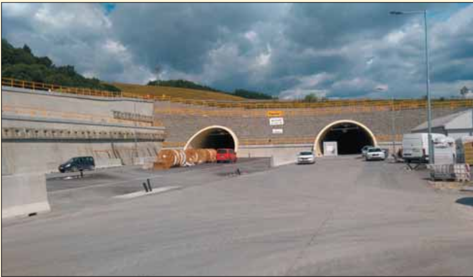
Obr. 3 Tunel Ovčiarско – východný portál Fig. 3 Ovčiarско tunnel – eastern portal
