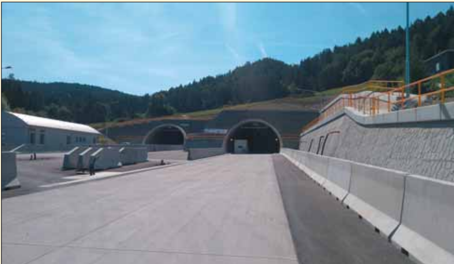
Obr. 4 Tunel Ovčiarско – západný portál Fig. 4 Ovčiarско tunnel – western portal
