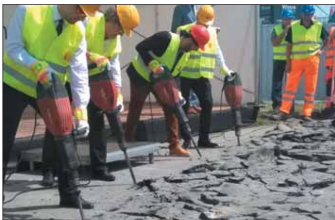
Obr. 3 Zahájení stavby čtvrté trasy metra linky D dne 19. června 2019 Fig. 3 Commencement of construction of the fourth metro line, line D, on 19 th June 2019
