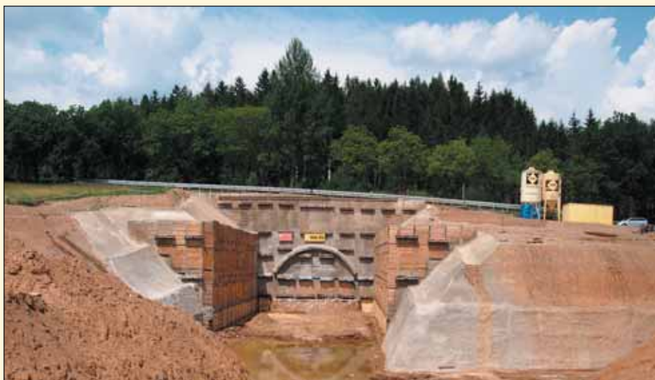
Obr. 2 Stavební jáma vjezdového portálu tunelu Deboreč Fig. 2 Construction pit for the entrance portal of Deboreč tunnel
