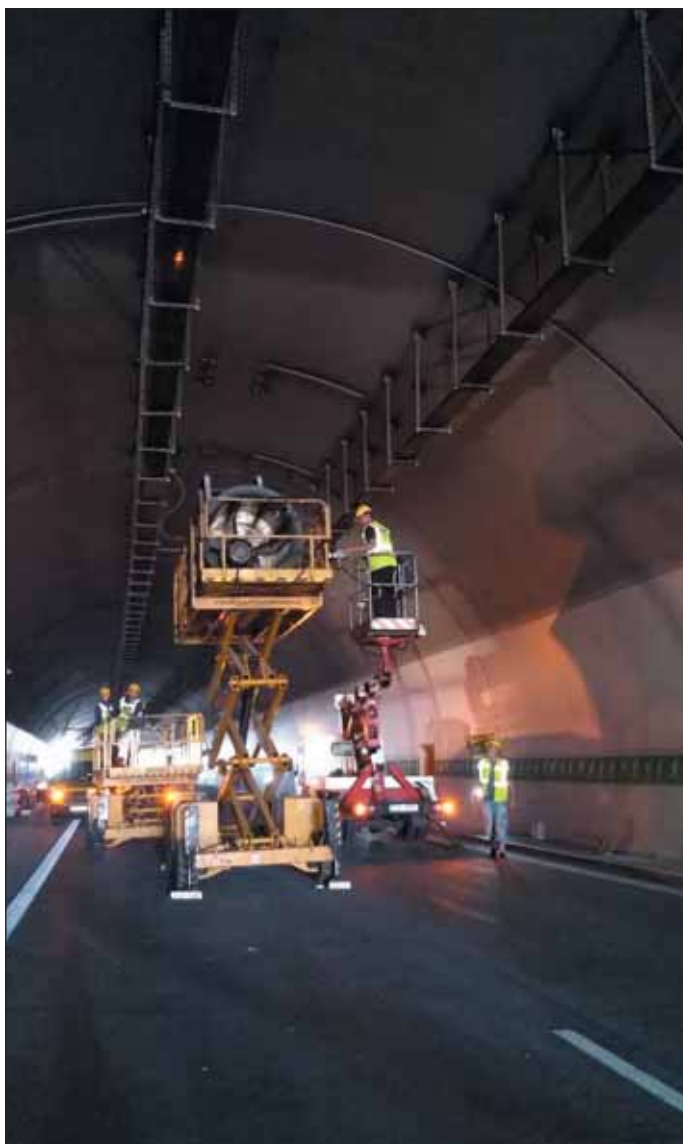
Obr. 1 Demontáž proudového ventilátoru Fig. 1 Disassembly of a jet fan
