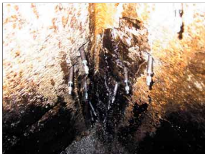
Obr. 5 Osazení pakry Fig. 5 Installation of packers
