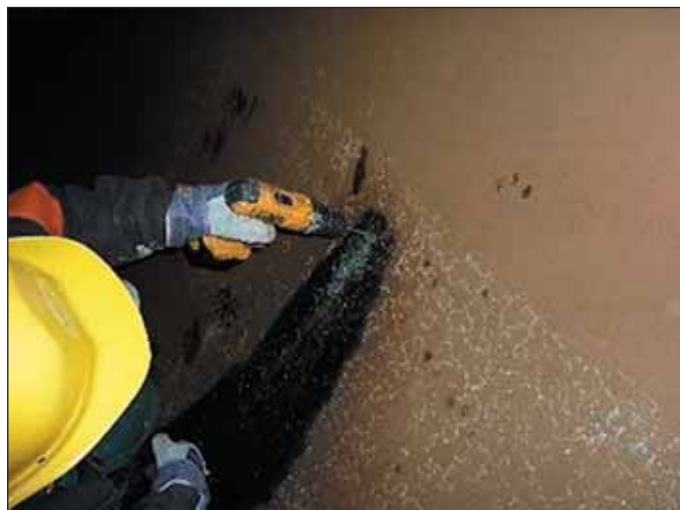
Obr. 3 Vrtání otvoru pro injektážní pakr přes zátku Fig. 3 Drilling of a hole through a plug for grouting packer
