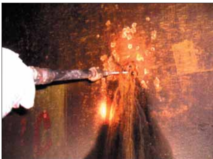
Obr. 4 Tlaková injektáž přes zátku Fig. 4 High-pressure grouting through a plug
