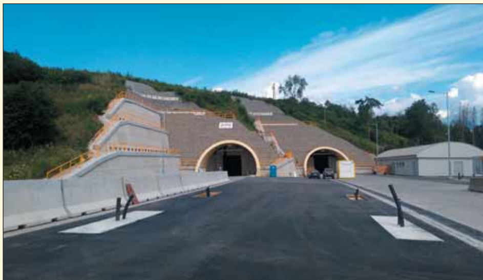
Obr. 6 Tunel Žilina – východný portál
