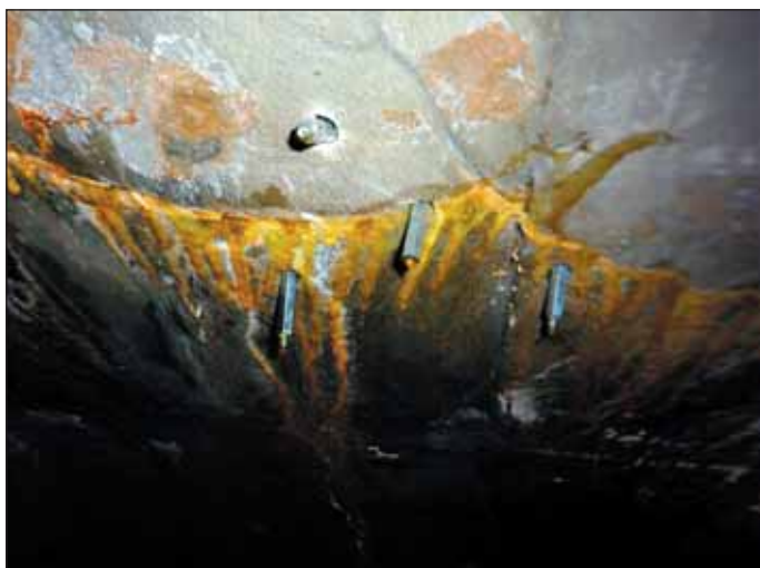
Obr. 9 Utěsnění stropního průsaku Fig. 9 Sealing of a leak under the ceiling
