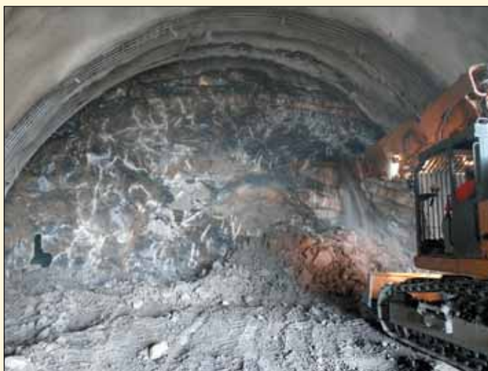
Obr. 7 Prerážka tunela Diel Fig. 7 Diel tunnel breakthrough
