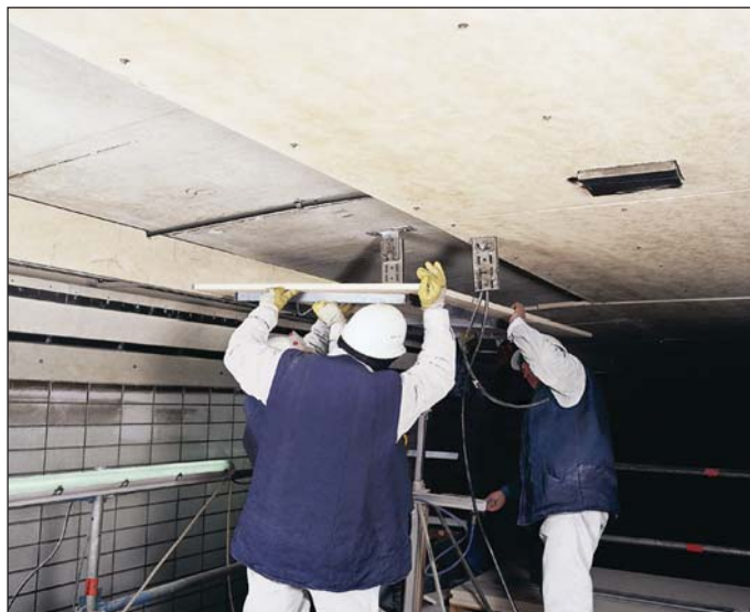
Obr. 14 Dodatečný obklad požárně ochrannými deskami Fig. 14 Additional cladding with fire protection slabs
