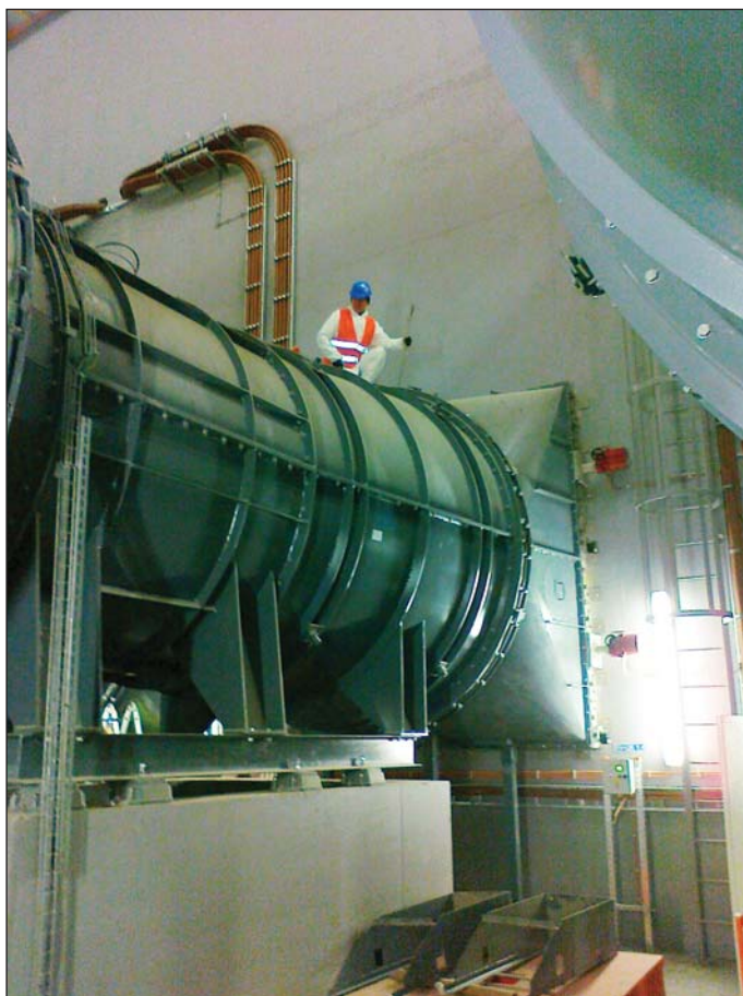
Obr. 6 Měření tlaku na hlavních ventilátorech pro ověření dosažení projektovaných hodnot výkonu odvodu
