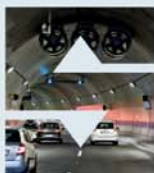
Tunelový komplex Blanka Zkušební provoz
