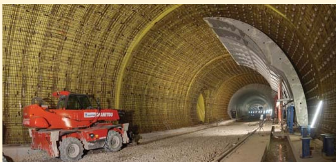
Obr. 1 Tunel Považský Chlmec Fig. 1 Považský Chlmec tunnel
