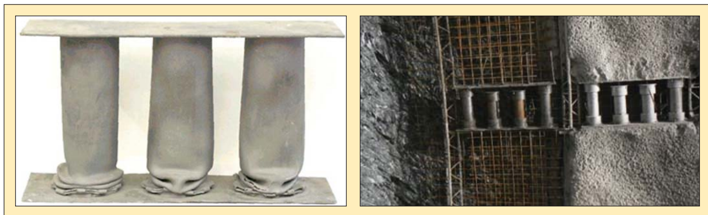
Obr. 5 Skupina poddajných prvků, nalevo první generace instalovaná v poruchové zóně na tunelu Galgenberg v Rakousku; napravo zlepšený systém použitý například na Tauerském tunelu
