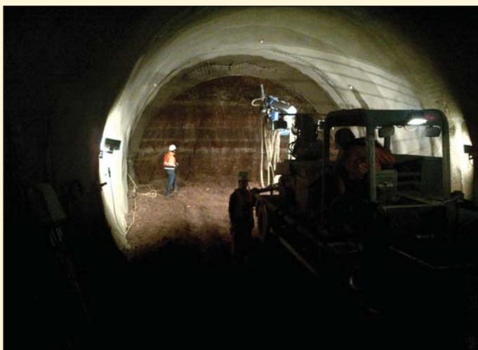
Obr. 4 Ražba kaloty s viditelným směrem proložených anhydridových vrstev Fig. 4 Top heading excavation with interlayered anhydrite stratum
