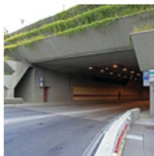
Tunel Mrázovka, Praha
