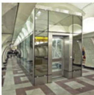
Bezbariérové zpřístupnění stanice metra Anděl, Praha
