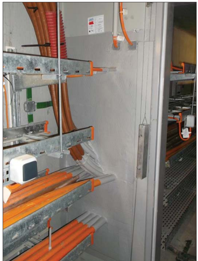
Obr. 5 Požární těsnění prostupů kabelů Fig. 5 Fire-stop sealing of openings for cables
