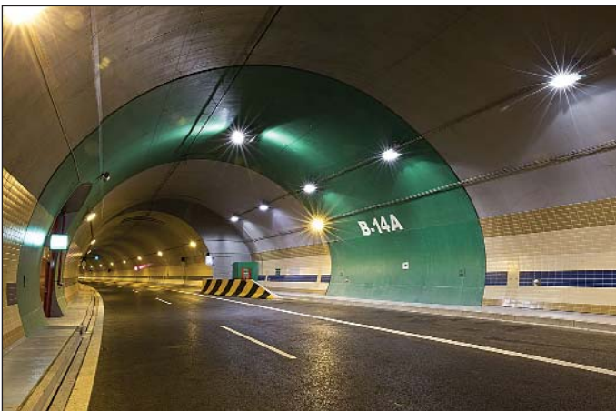
Obr. 5 TKB – odstavný záliv v Bubenečském tunelu
