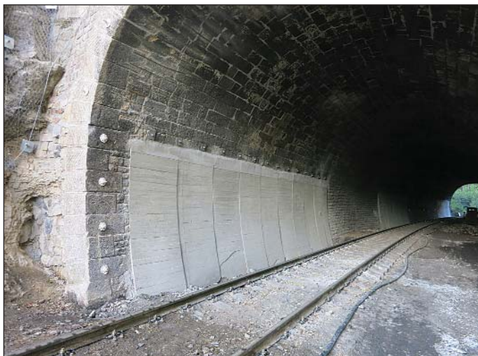
Obr. 9 Finální pohled na nově vybetonované opěry v pásu č. TP6 Fig. 9 Final view of the newly cast concrete sidewall in block TP6
