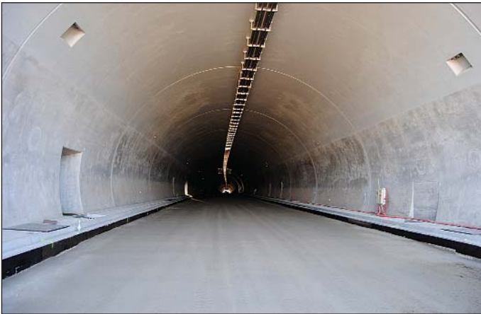
Obr. 1 D8 – hotové definitivní ostění a cementobetonový kryt vozovky tunelu Radejčín
