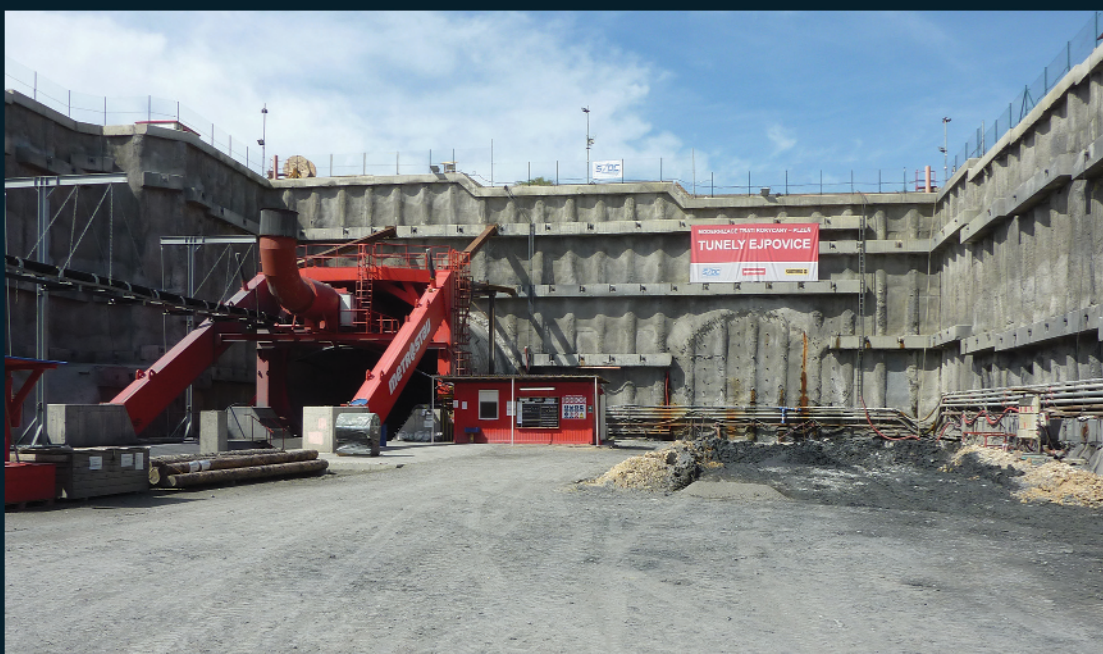
Modernizace trati Rokycany - Plzeň, výstavba tunelů Ejovice
