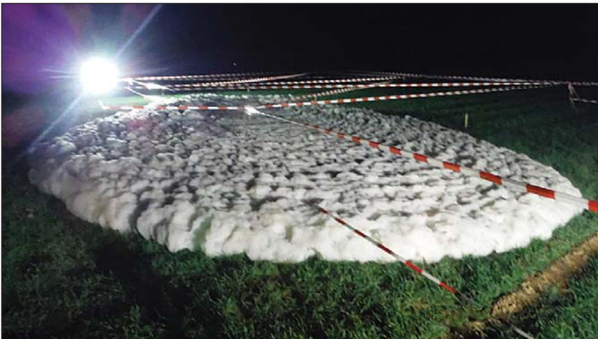
Obr. 8 Únik pěn sloužících pro úpravu rubaniny na povrch území Fig. 8 Escape of the muck-modifying foams to the terrain surface
