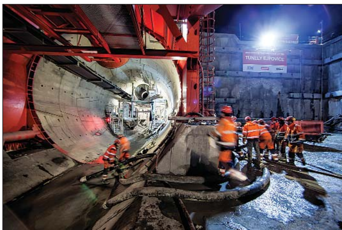
Obr. 1 Práce před jižní tunelovou troubou Ejpvických tunelů se smontovaným drátkobetonovým segmentovým ostěním Fig. 1 Working in front of the southern tube of the Ejpvické tunnels with completed steel fibre reinforced segmental lining
