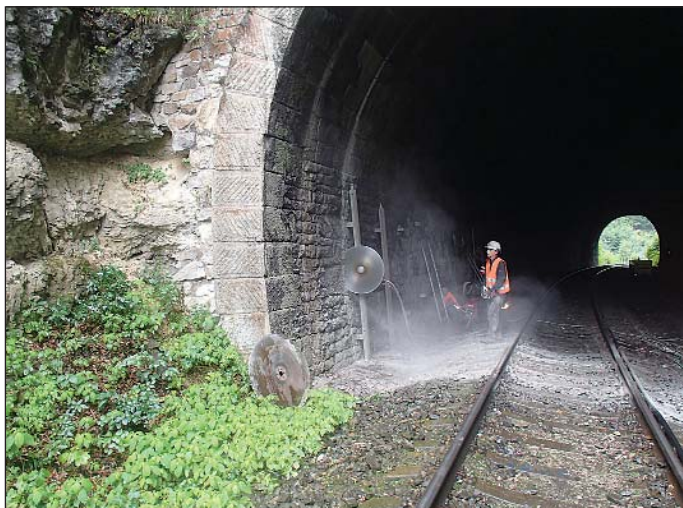
Obr. 4 Dělení stávajícího ostění na pruhy šířky 1,4 m pomocí vertikální příložné diamantové kotoučové pily
