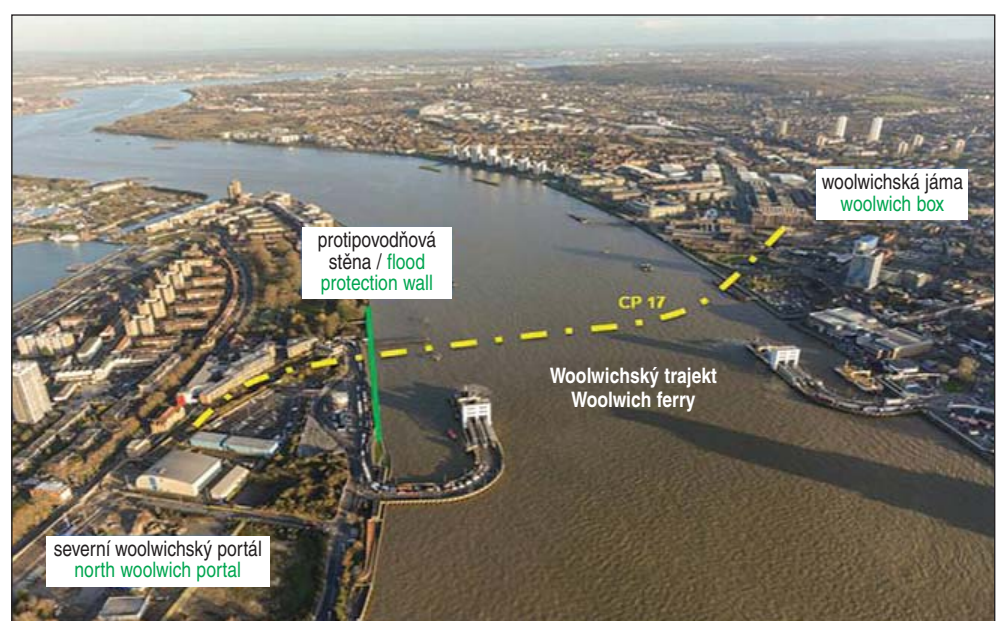
Obr. 3 Letecký snímek ražeb pod řekou Temží Fig. 3 Tunnelling underneath the River Thames
