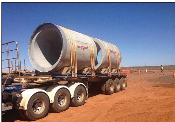
Obr. 10 Betonové protlačované potrubí (vnější průměr = 2,45 m) dodané na stavbu Fig. 10 Concrete Jacking Pipes (OD=2.45m) being delivered to the Project Site
