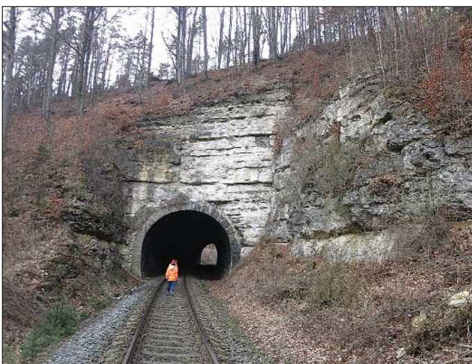
Obr. 2 Pohled na východní výjezdový portál Sedlejevického tunelu
