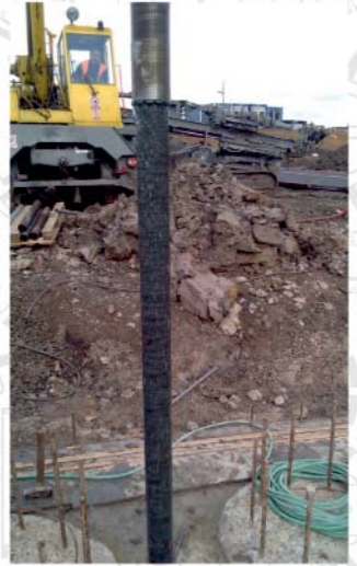
HLUBINNÉ JÁDROVÉ VRTÁNÍ
