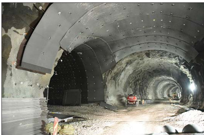
Obr. 6 Veitastrond – instalace izolací proti vodě a promrzání Fig. 6 Veitastrond – installation of insulation against water seepage and frost penetration
