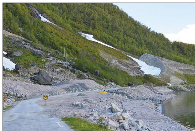
Obr. 4 Veitastrom – optimalizace komunikace a protilavinový val Fig. 4 Veitastrom – optimisation of the road and the avalanche protection embankment
