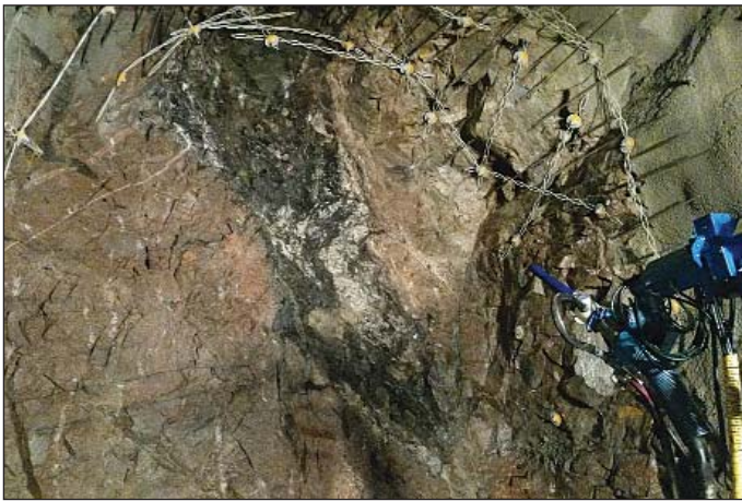
Obr. 5 Veitastrom – skalní pásy před zastříkáním betonem Fig. 5 Veitastrom – rock strips before covering them with shotcrete
