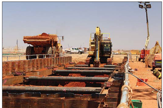
Obr. 13 Hloubení stavební jámy Fig. 13 Shaft Excavation Works
