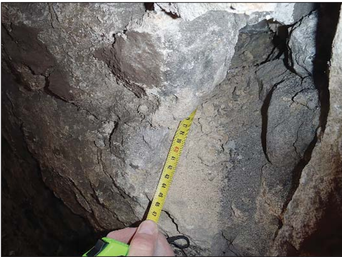
Obr. 3 Kopaná sonda do kamenného ostění tunelu Sedlejšovice a měření hloubky volného prostoru za obezdívkou
