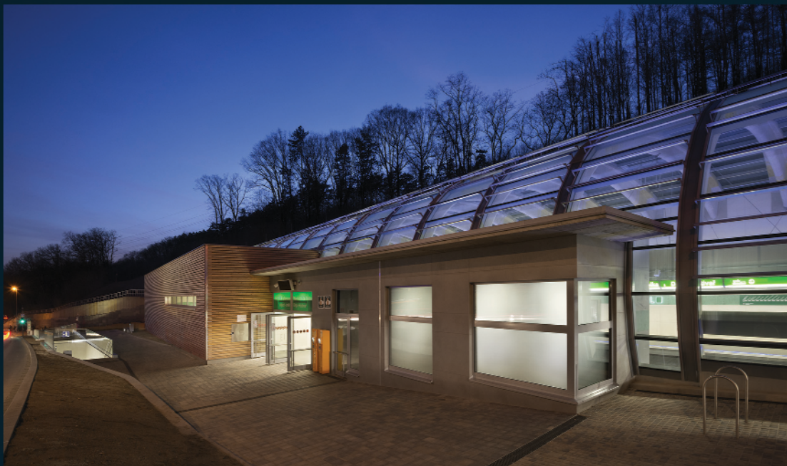
Trasa A pražského metra, stanice Nemocnice Motol
