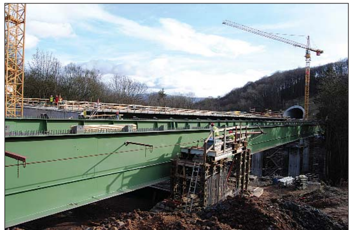
Obr. 4 D8 – ocelová nosná konstrukce levého mostu mezi tunely
