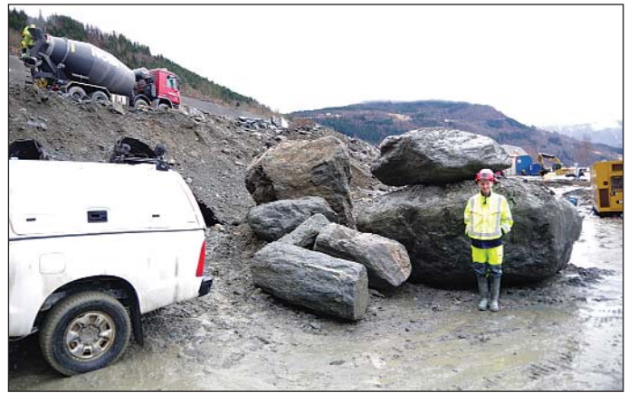
Obr. 8 Joberg – balvany z hloubení zářezu v ledovcové moréně Fig. 8 Joberg – boulders from the excavation of the cutting in the glacier moraine
