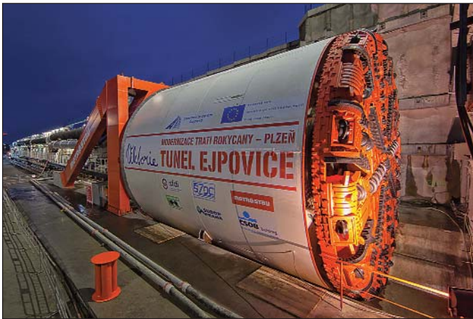
Obr. 4 Viktorie – konvertibilní tunelovací stroj pro ražbu Ejpvických tunelů Fig. 4 Viktorie – the convertible TBM for driving the Ejpvovice tunnels
