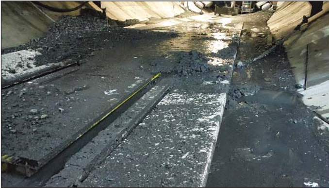
Obr. 7 Znečištění tunelovacího stroje zvodnělou rubaninou Fig. 7 Tunnelling machine smeared with water-bearing muck
