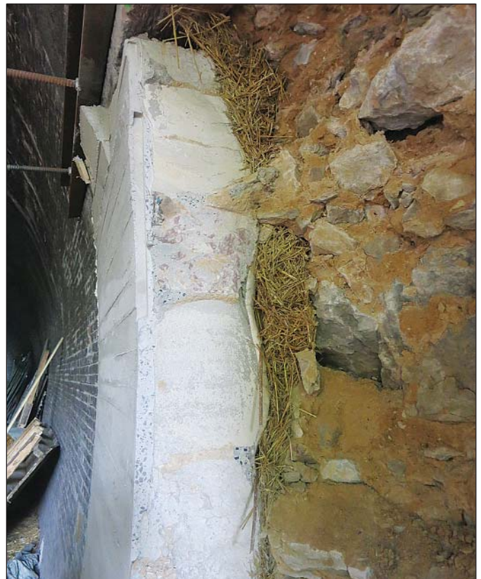
Obr. 7 Dokončená nová betonová opěra v řezu; zprava: drenážní vrstva slámy, separační geotextilie 500 g/m 2 a opěra z prostého betonu C 25/30 XC2 XF1 Fig. 7 Completed new straw drainage layer, 500g/m 2 separation geotextile and the unreinforced concrete sidewall
