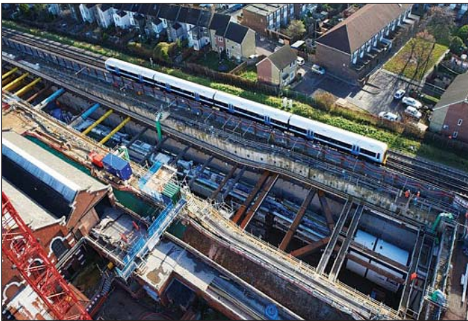
Obr. 2 Startovací jáma v oblasti západního portálu Plumstead Fig. 2 Launching shaft at the location of west Plumstead portal
