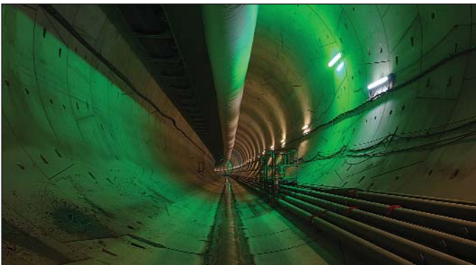
Obr. 11 Tunel Ejovice – pohled na hotový tunel ze segmentového ostění Fig. 11 Ejovice tunnel – a view of the finished segmentally lined tunnel
