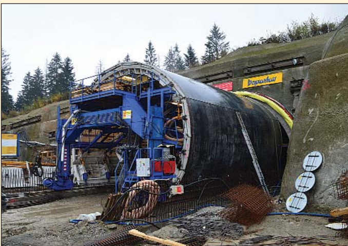
Obr. 1 Tunel Poľana – betonársky vozík Fig. 1 Poľana tunnel – concrete casting carriage
