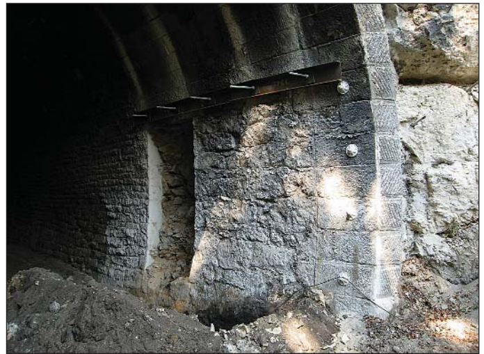
Obr. 5 Vyřiznutý pruh ostění a odhalená základová spára v tunelovém pásu č. TP6
