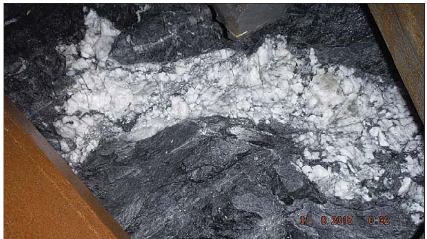
Obr. 9 Čelba tunelu s křemennou žílou
