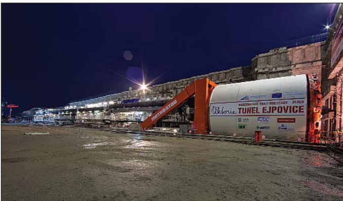
Obr. 9 Tunel Ejovice – smontovaný tunelovací stroj Viktorie na vjezdovém portálu Fig. 9 Ejovice tunnel – assembled Viktorie TBM at the entrance portal
