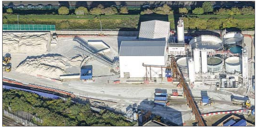
Obr. 6 Letecký pohled na separační zařízení Fig. 6 Slurry Treatment Plant
