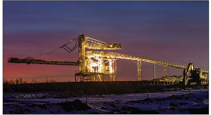
Obr. 8 Tunel Ejovice – ocelová konstrukce tunelového pasu a otočného ramena pro výsyp rubaniny na meziskládku Fig. 8 The Ejovice tunnel – the steel structure of the tunnel belt conveyor and the slewing arm for unloading muck to the intermediate stockpile
