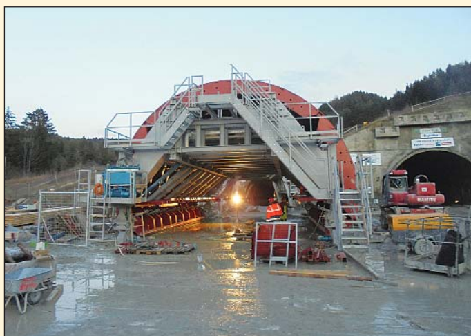
Obr. 2 Tunel Ovčiarsko – forma na sekundárne ostenie STR Fig. 2 Ovčiarsko tunnel – secondary lining formwork of NTT
