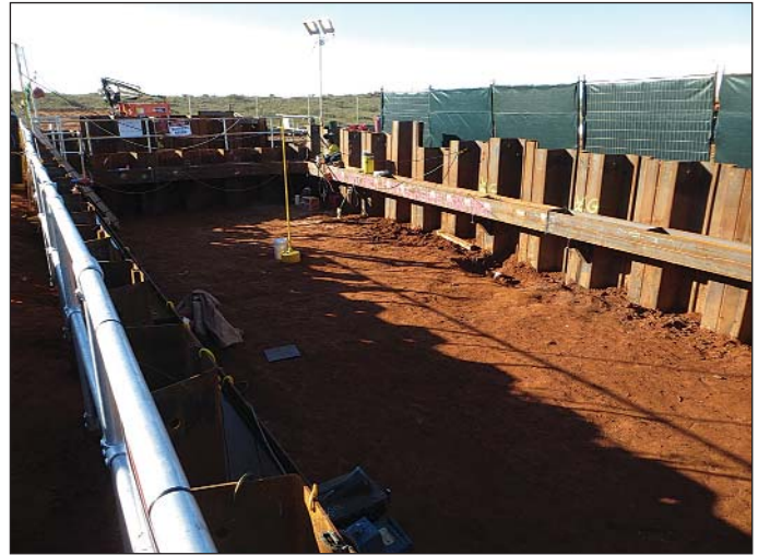
Obr. 12 Zajištění stavební jámy štětovicovými stěnami Fig. 12 Sheet-Piling Works
