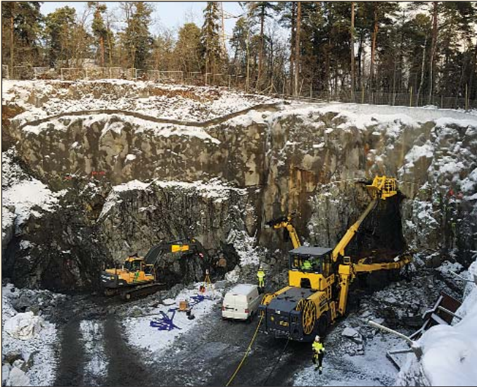
Obr. 1 Tunel Skärholmen, zahájení ražeb
