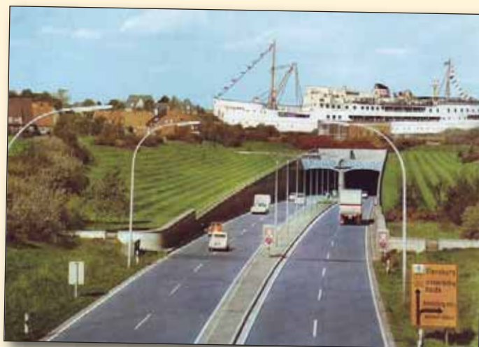
Obr. 10 Silniční tunel pod Severomořsko-Baltským kanálem
