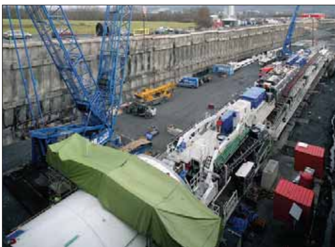
Obr. 5 Zařízení staveniště pro montáž štítu Fig. 5 The sheet assembly site facility
