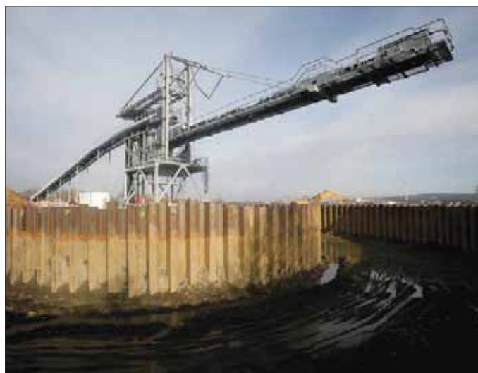
Obr. 6 Konstrukce otočného výsypného nosu na mezideponii rubaniny Fig. 6 The turning dumping arm structure at the intermediate stockpile of muck
