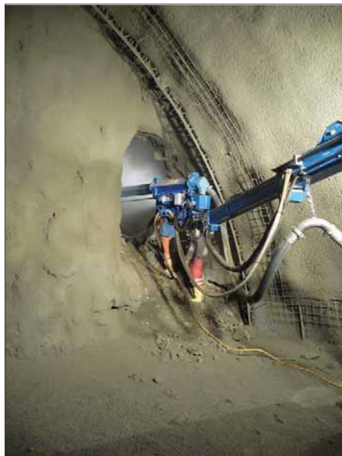
Obr. 6 Stabilizace kaverny ve staničení 580,01 (Zdroj: BeMo, 2010b) Fig. 6 Sealing the opening and the void at TM 580.01 (Source: BeMo, 2010b)
