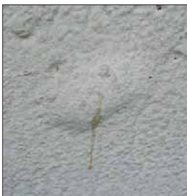
Obr. 2 Zpuchýřování Fig. 2 Blistering
