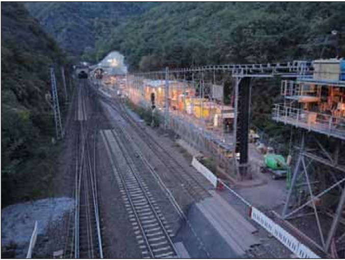
Obr. 3 Zařízení staveniště u ediger-ellerského portálu (Zdroj: BeMo, 2011) Fig. 3 Site installation at the Ediger-Eller portal (Source: BeMo, 2011)
