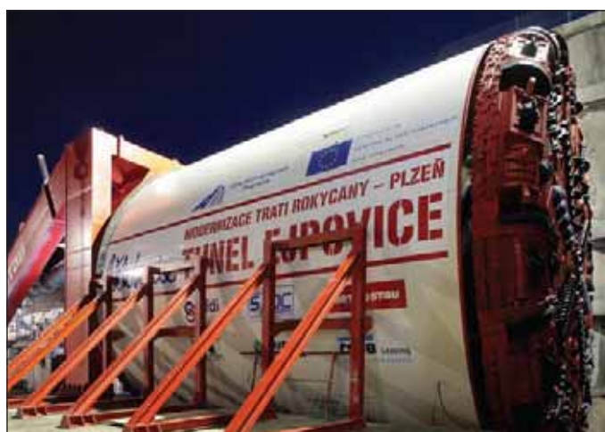
Obr. 4 Smontovaná obálka štítu a startovací rám Fig. 4 The assembled shield skin and thrust frame
