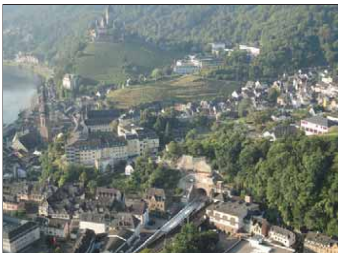
Obr. 1 Pohled na portál nového tunelu Kaiser Wilhelm ve městě Cochem (Zdroj: BeMo, 2012b)
