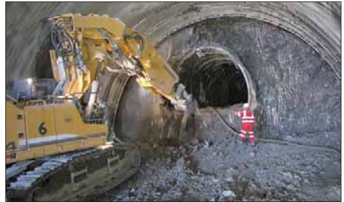
Obr. 2 Ovčiarsko, severná tunelová rúra od západného portálu Fig. 2 Ovčiarsko, northern tunnel tube viewed from the western portal
