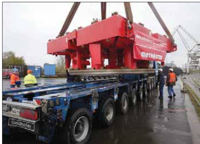
Obr. 2 Doprava štítu po kolech Fig. 2 Transporting the shield on wheels
