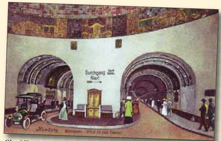
Obr. 4 Hamburg. Labský tunel, pohled do tunelu
