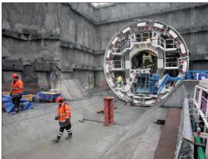
Obr. 3 Pohled na vjezdový portál a montáž obálky štítu Fig. 3 A view of the entrance portal and assembly of the shield skin
