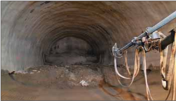
Obr. 8 Nástřik spodní klenby SB (na obr. je vidět horizontální členění výrubu) (foto Lukáš Kuča)
