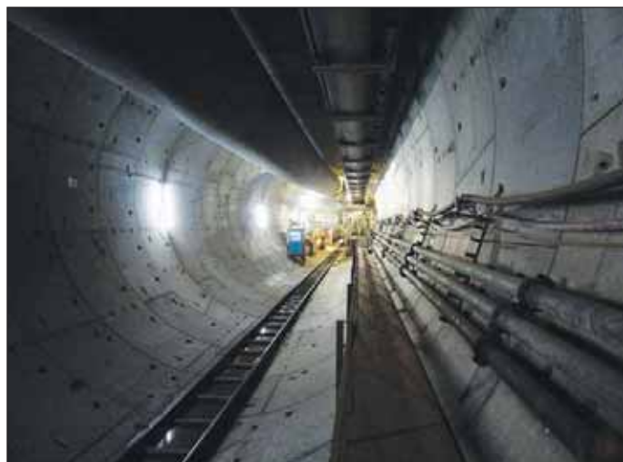
Obr. 10 Pohled do tunelu na konec závěsu plnoprofilového tunelovacího stroje (Zdroj: BeMo, 2011)
