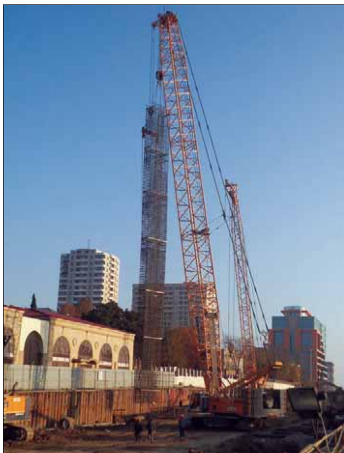
Obr. 3 Ukládání armokoše podzemní stěny Fig. 3 D-wall's steel cage placing
