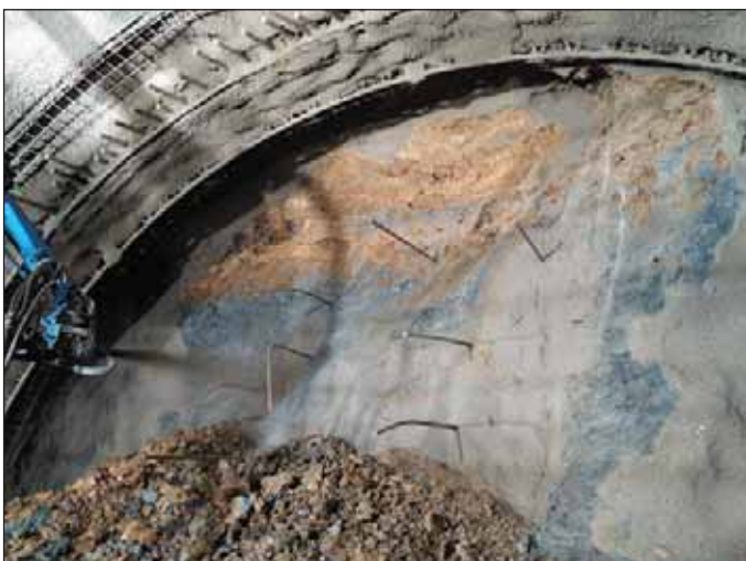
Obr. 5 Tunel Žilina, severná tunelová rúra od západného portálu Fig. 5 Žilina tunnel, northern tunnel tube viewed from the western portal
