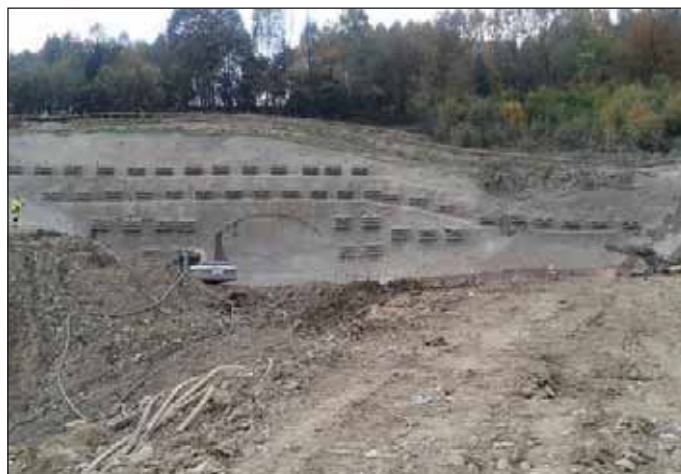
Obr. 5 Pohled na východní portál krátce před jeho dokončením (foto Lukáš Kuča)
