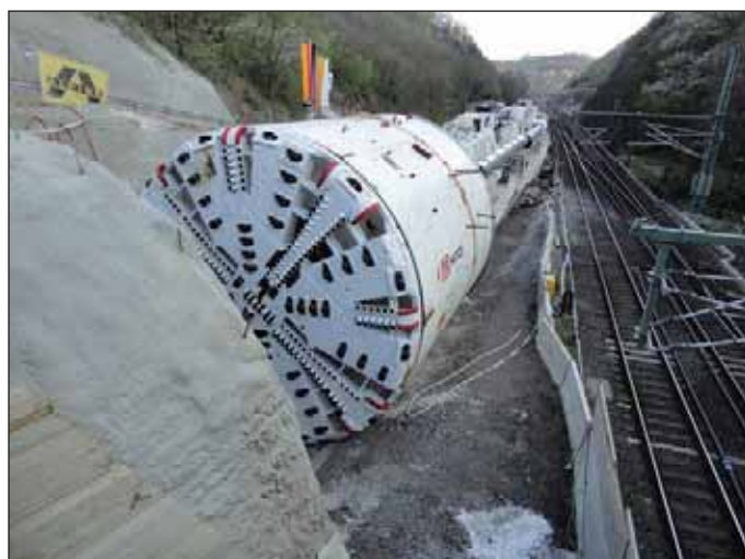
Obr. 2 Pohled na smontovaný plnoprofilový tunelovací stroj na ediger-eller-ském portálu (Zdroj: BeMo, 2010)
