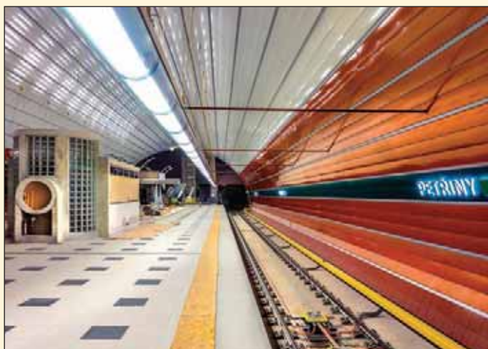
Obr. 1 Prakticky dokončená stanice Petřiny Fig. 1 Almost completed Petřiny station
