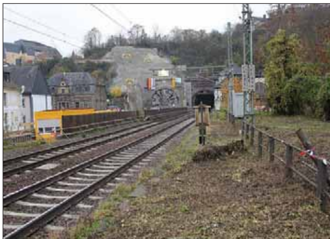
Obr. 7 Pohled na nový tunel Kaiser Wilhelm, cochemský portál (Zdroj: BeMo, 2011) Fig. 7 View of the New Kaiser Wilhelm Tunnel at Cochem portal (Source: BeMo, 2011)
