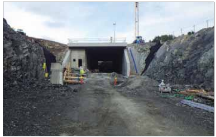
Obr. 9 Východní portál Sätamyrikulverten s technologickou místností Fig. 9 Sätamyrikulverten East with tunnel technical room
