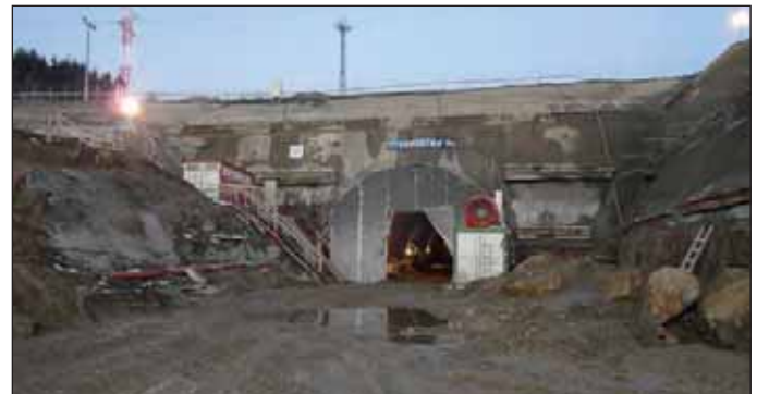
Obr. 4 Svrčinovec, západný portál Fig. 4 Svrčinovec, western portal
