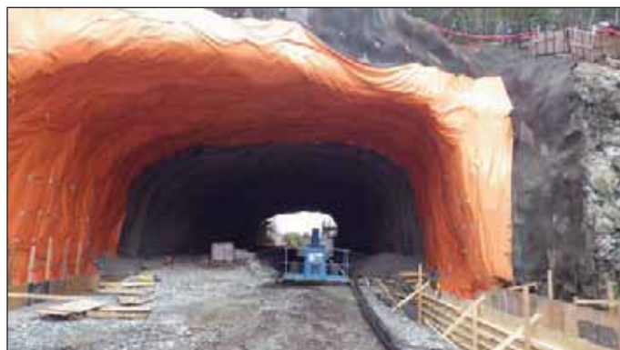
Obr. 8 Tunel Dyrhovd Fig. 8 Dyrhovd Tunnel
