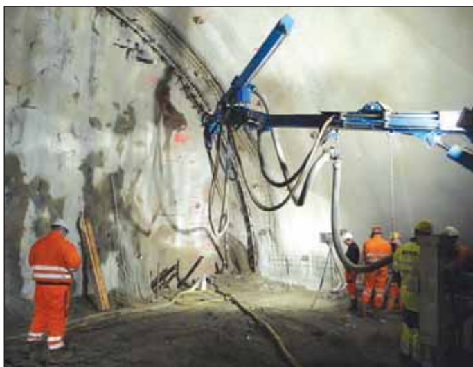
Obr. 11 Provádění sanačních prací (Zdroj: BeMo, 2010b) Fig. 11 Filling the invert with mortar through a pipe umbrella (Source: BeMo, 2010b)
