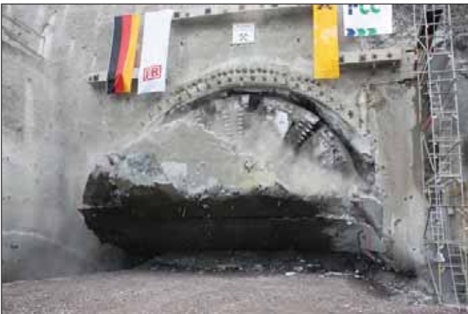
Obr. 6 Prorážka štítu, cochemský portál (Zdroj: BeMo, 2011) Fig. 6 TBM breakthrough at the Cochem portal (Source: BeMo, 2011)
