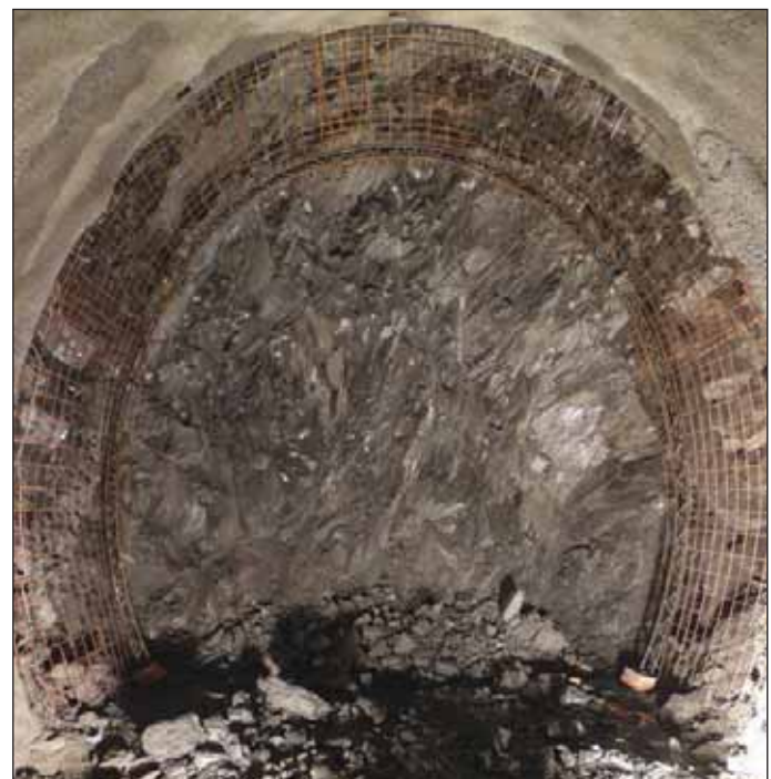
Obr. 6 Tunel Polana – úniková štôľňa Fig. 6 Polana tunnel – escape gallery
