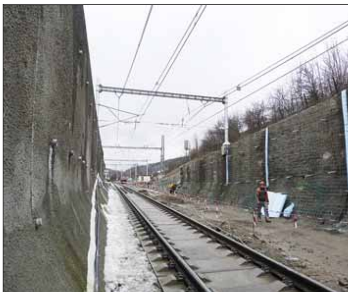
Obr. 3 Sanace předportálové zárubní zdi Fig. 3 Rehabilitation of pre-portal revetment walls
