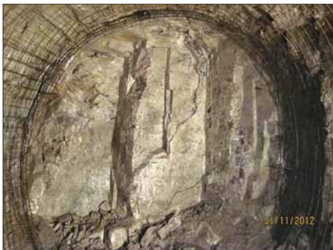
Obr. 10 Čelba nové odpadní štolý SO 05 – nezvětralá hornina
