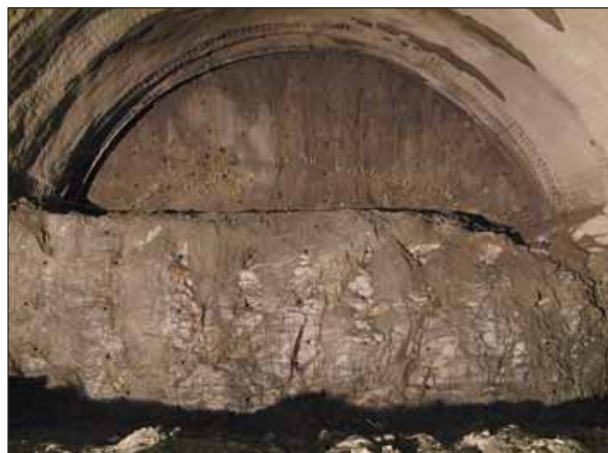
Obr. 4 Celá čelba připravená k odstřelu (kalota včetně opěří)
