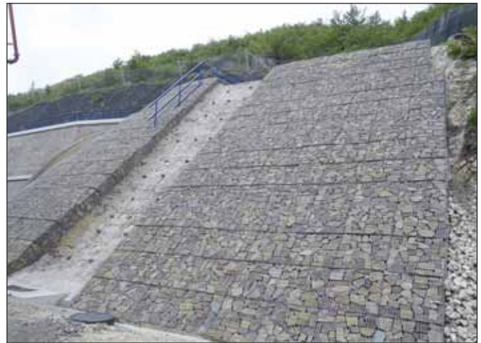
Obr. 2 Boční pohled na portálovou část s drátokamennými matracemi Fig. 2 A lateral view of the portal part with gabions
