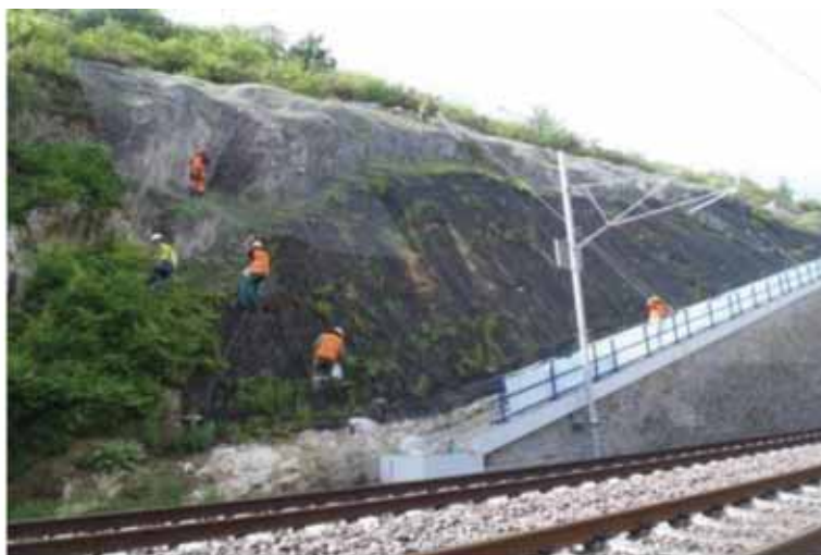
Stabilizace svahu ocelovou sítí TECCO – Tunel Turecký Vrch (SR)
