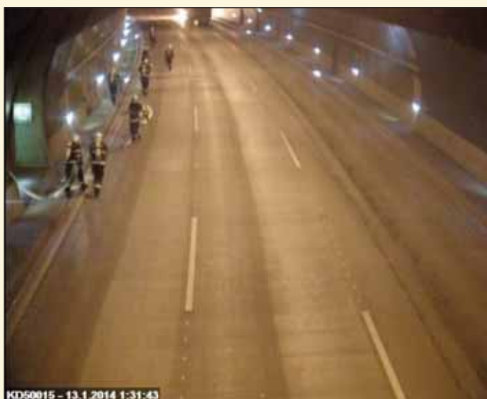
Obr. 2 Nástup hasičů z levé tunelové trouby v čase 1:31 (pohled z kamery CCTV)
