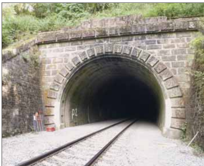
Obr. 1 Pohled na portál Prštického tunelu Fig. 1 A view of the Prštice tunnel portal
