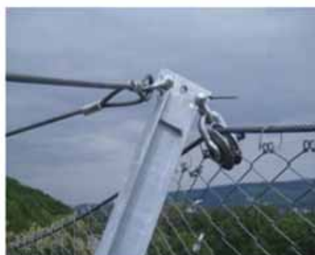
Detail hlavičky sloupku bariéry
