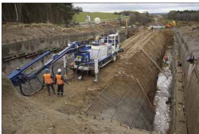
Obr. 5 Dno stavební jámy ve tvaru klenby tunelu (foto Mařík)
