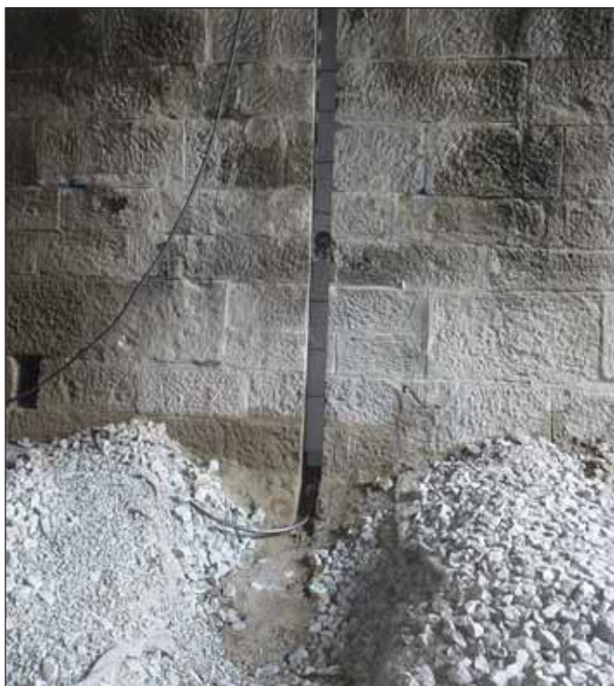
Obr. 5 Drenážní svodnice instalovaná do vyřezané drážky Fig. 5 Drainage water collecting duct installed in a cut-out groove
