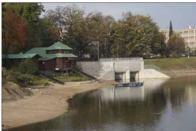
Obr. 14 Vtkový objekt po dokončení Fig. 14 Intake structure after completion
