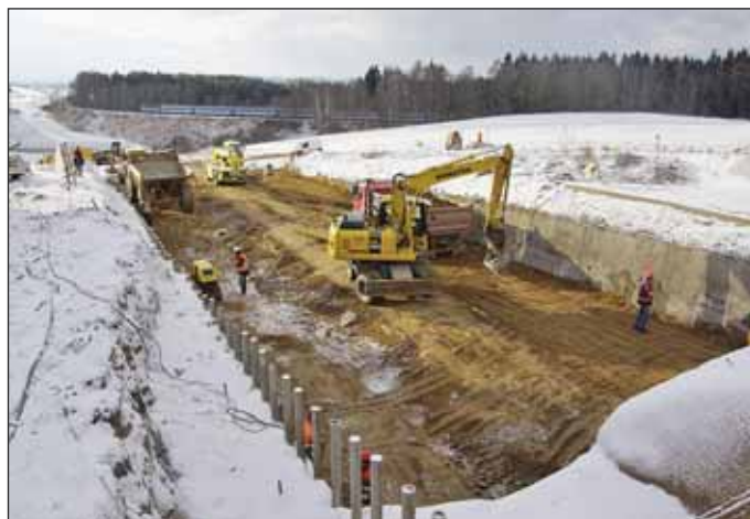
Obr. 3 Zasypávání jámy nad želvou 26. 11. 2013
