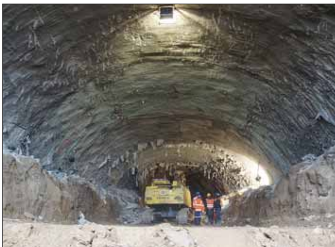
Obr. 4 Ražba kaloty pod želvou 12. 12. 2013
