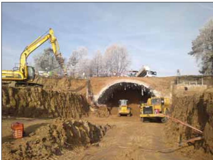
Obr. 10 Zářez před portálem – zahájení ražby (foto Jíra)
