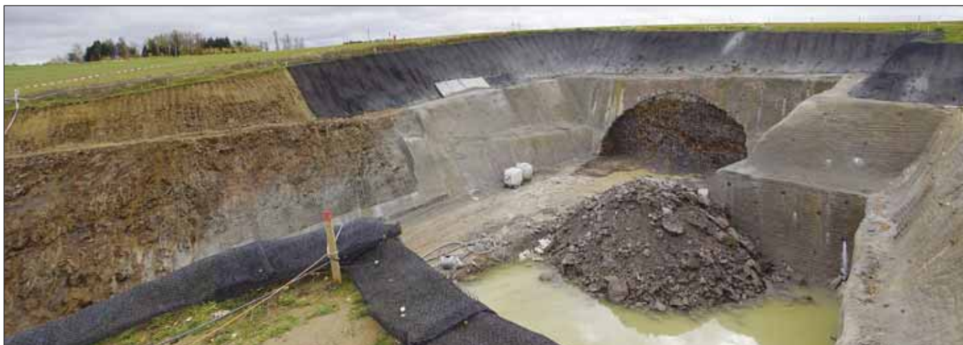
Obr. 1 Počátek hloubení severního portálu 10. 9. 2013
