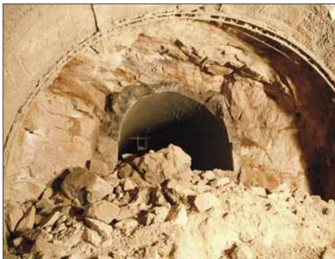
Obr. 7 Čelba SO 02 po odpalu Fig. 7 SO 02 heading after blasting
