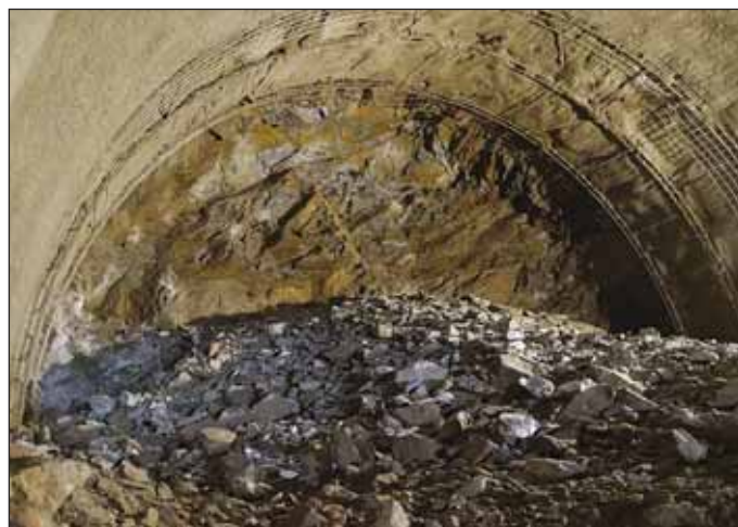
Obr. 5 Hornina na čelbě 100 m od portálu 11. 2. 2014
