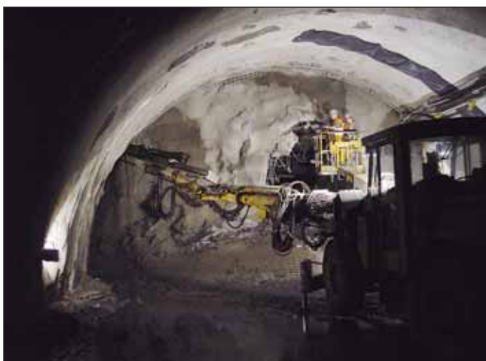
Obr. 3 Vrtání deštníku z jehel R 51 do nadloží tunelu
