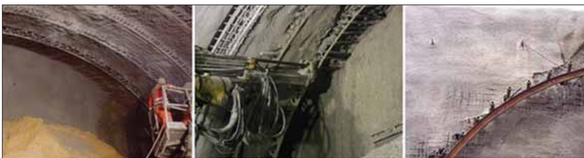
Obr. 2 Typická instalace SDA jehel – zleva SDA R38 (Německo), SDA R51 (Rakousko) a SDA T76 (Indie)
