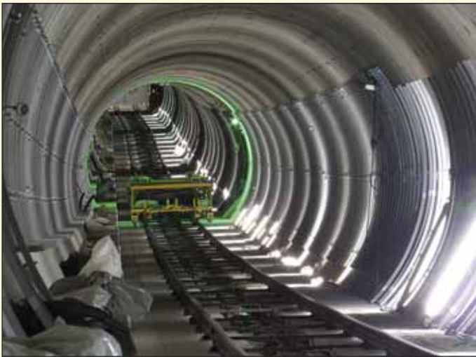
Obr. 2 Napojení levé koleje na stávající trasu Fig. 2 Connection of the left-hand track to the existing metro line
