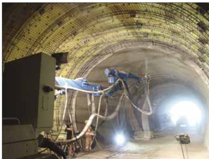
Obr. 4 Provádění stříkaného betonového ostění Fig. 4 Construction of shotcrete lining
