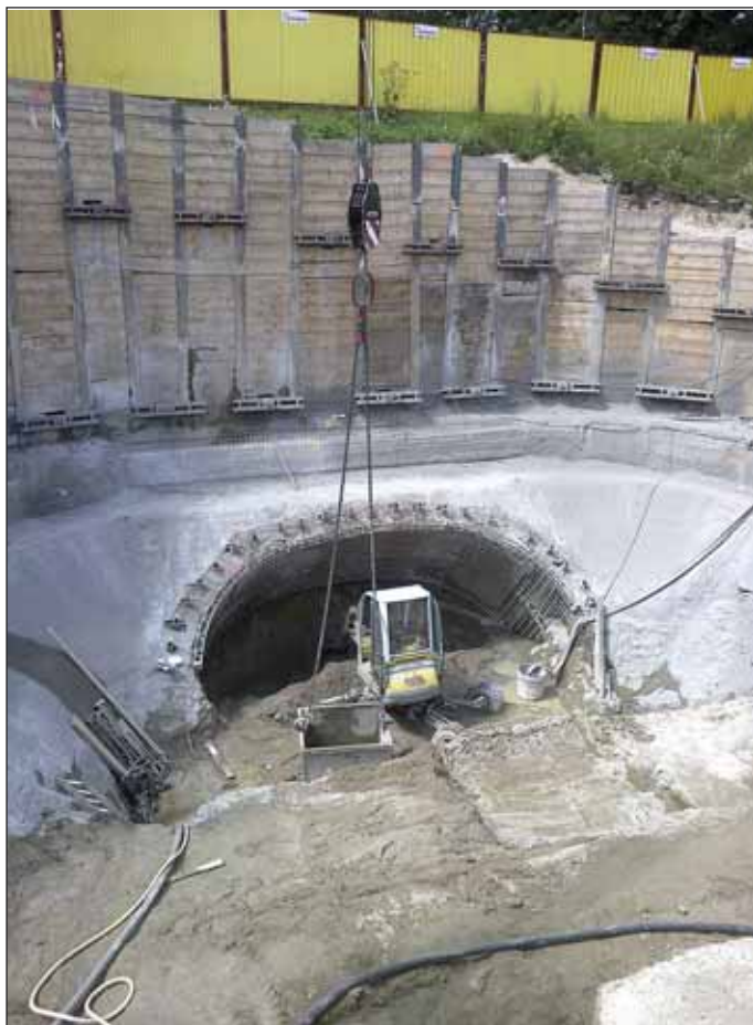
Obr. 8 Vtokový objekt SO 04 – zahájení úpadní ražby Fig. 8 Intake structure SO 04 – commencement of downhill excavation
