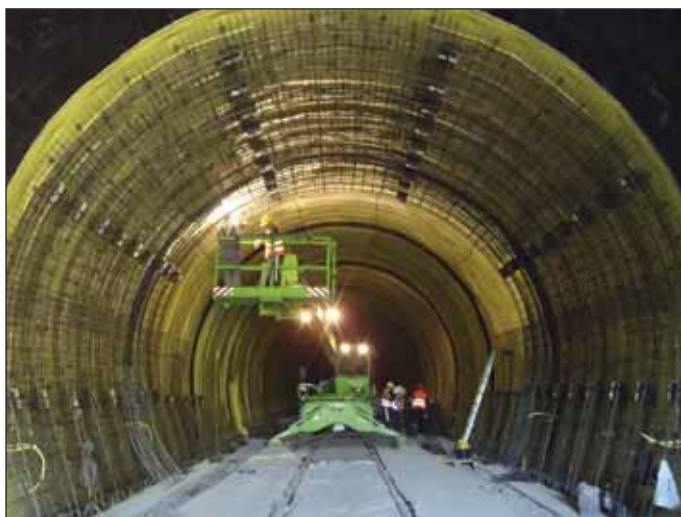
Obr. 3 Provádění nové fóliové hydroizolační vrstvy Fig. 3 Application of the new waterproofing membrane layer
