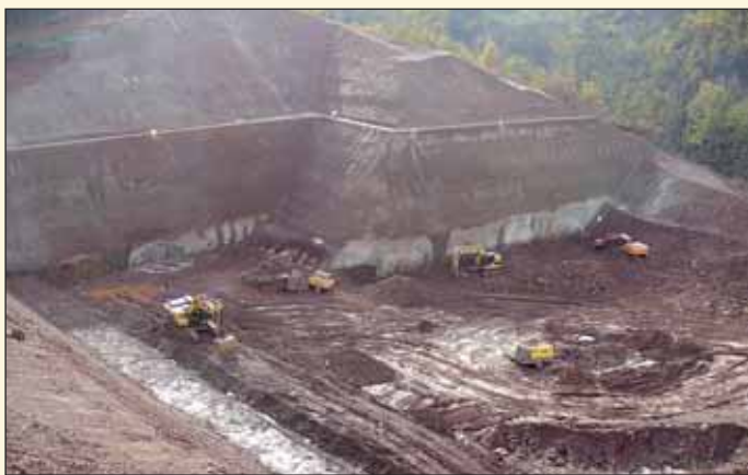
Obr. 3 Bancarevo – stavební jáma u západního portálu Fig. 3 Bancarevo – construction pit at the western portal
