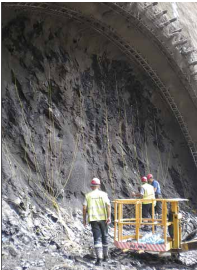
Obr. 5 Instalace neelektrického roznětu v čelbě tunelu na Letné Fig. 5 Installation of non-electric initiation at the tunnel heading in Letná
