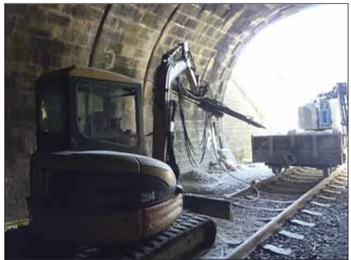
Obr. 6 Provádění odvodňovacích vrtů v místě drenážních svodnic Fig. 6 Drilling for drainage holes in the locations of drainage water collecting ducts
