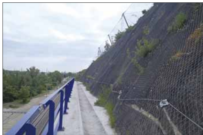
Obr. 5 Dynamické bariéry a zajištění svahu Fig. 5 Dynamic barriers and the slope stabilisation
