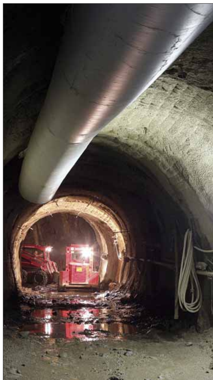
Obr. 12 Ražba nové odpadní štolý SO 05
