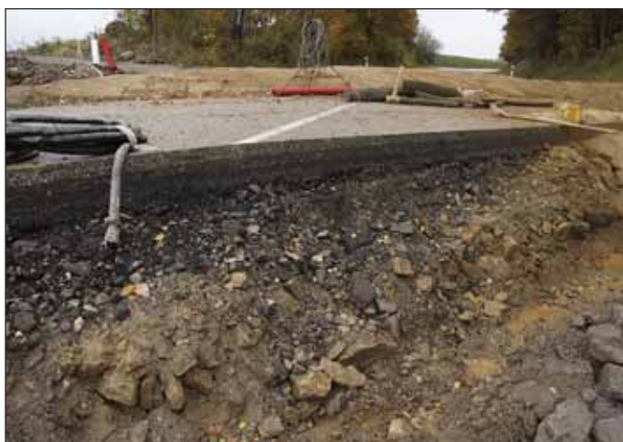
Obr. 3 Prostředí pod vrstvami vozovky v nadloží tunelu (foto Mařík)
