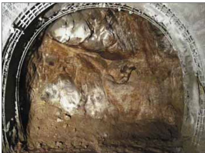
Obr. 11 Čelba nové odpadní štolý SO 05 – zvětralá čelba s bloky nezvětralé horniny
