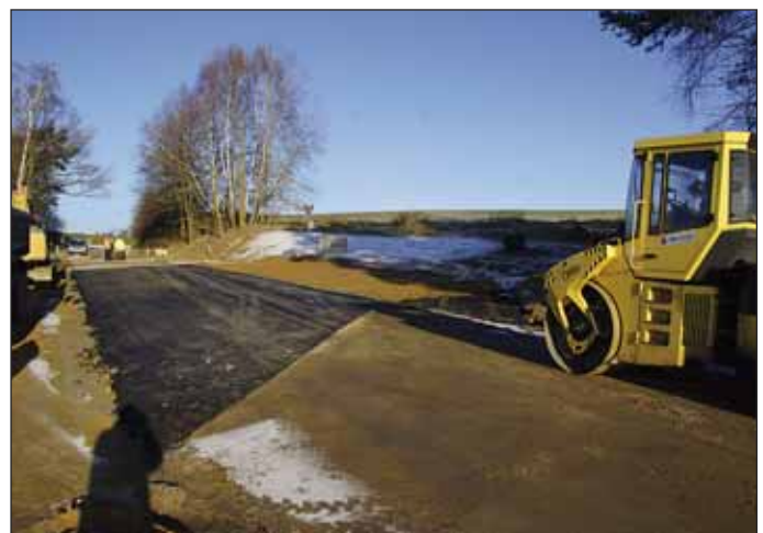
Obr. 8 Rozsah obnovení vozovky nad tunelem (foto Mařík) Fig. 8 The extent of the restoration of the road above the tunnel (photo by Mařík)
