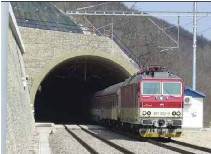
Obr. 1 Pohled na dokončený vjezdový portál Fig. 1 A view of the completed entrance portal
