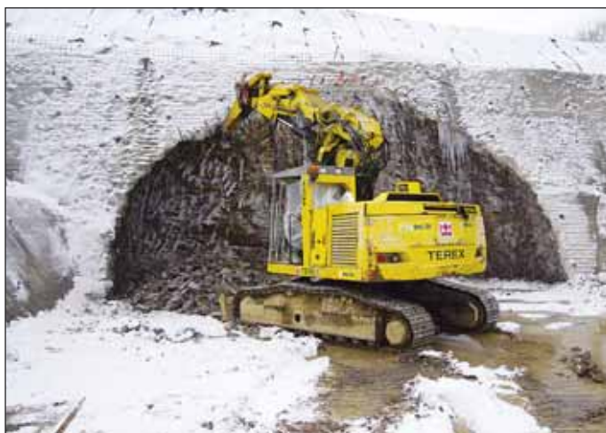
Obr. 11 Severní portál – čelba kaloty (foto Mařík)
