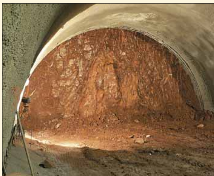
Obr. 2 Bancarevo – pohled na ražbu kaloty levého tubusu Fig. 2 Bancarevo – view of the left-hand tube top heading excavation
