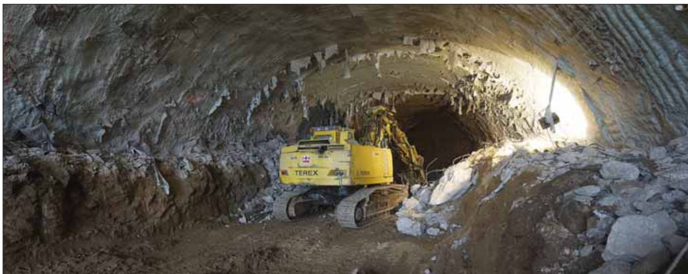
Obr. 9 Tvar kaloty pod želvou (foto Mařík)
