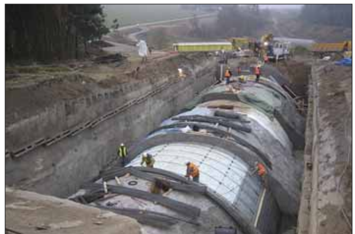
Obr. 7 Fáze výstavby želvy (foto Jíra) Fig. 7 The „tortoise shell“ construction phase (photo by Jíra)
