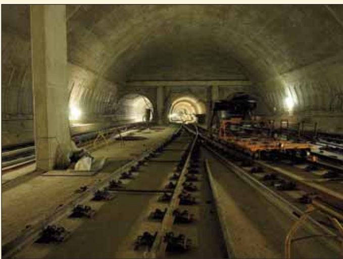
Obr. 3 Stanice Petřiny – pohled do obrátového tunelu Fig. 3 Petřiny station – view down the tunnel for dead-end tail track
