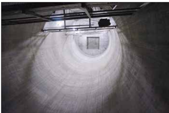
Obr. 13 Revizní šachta SO 05 – definitivní ostění Fig. 13 Inspection shaft SO 05 – final lining
