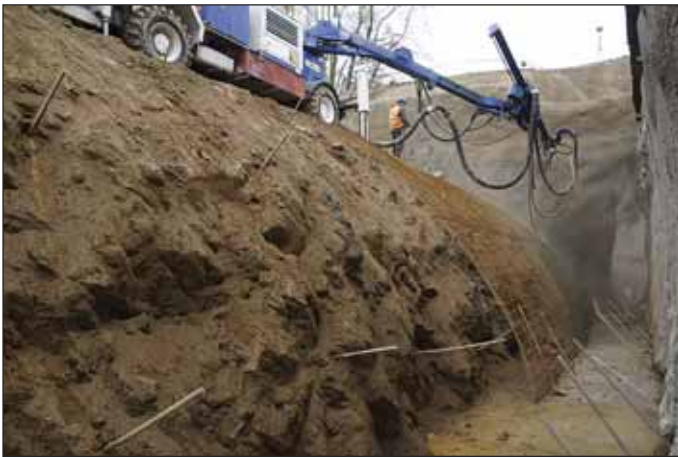
Obr. 6 Tvarování profilu želvy střikaným betonem (foto Mařík) Fig. 6 Shaping of the „tortoise shell“ surface with shotcrete (photo by Mařík)
