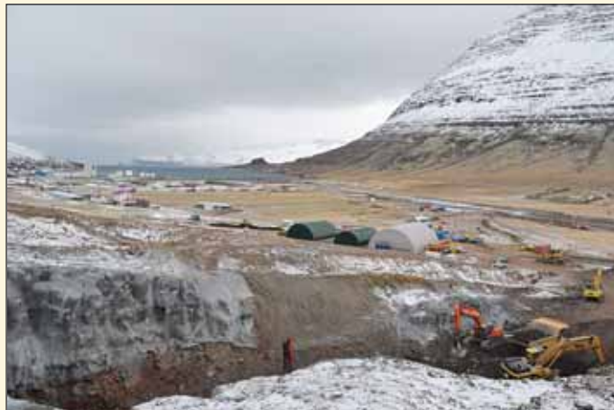
Obr. 3 Pohled na zařízení staveniště při portálu Eskifjörður Fig. 3 Construction facilities at Eskifjörður portal
