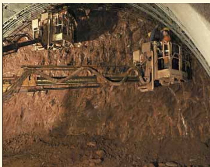
Obr. 1 Bancarevo – ražba levého tunelu Fig. 1 Bancarevo – left-hand tunnel tube excavation
