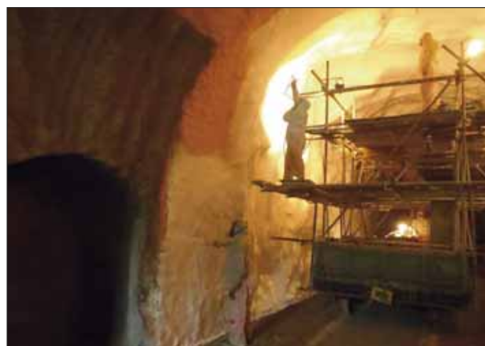
Obr. 14 Aplikace stříkané hydroizolace Fig. 14 Application of spray-on waterproofing
