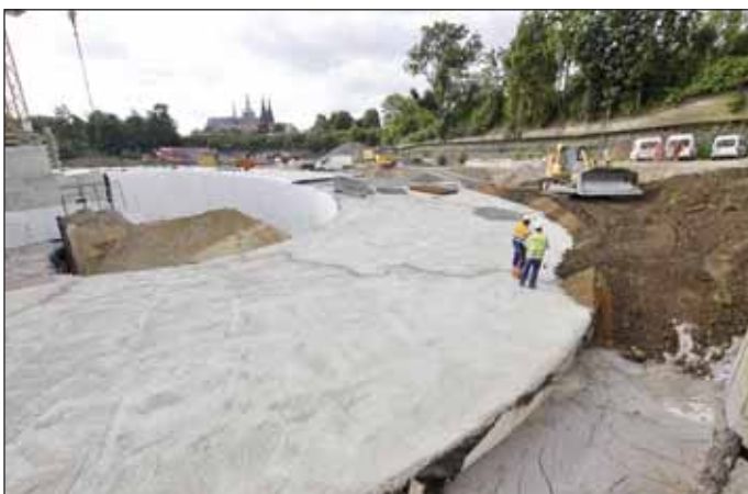
Obr. 3 Zásypy rampy podzemních garáží Prašný most (foto Jakub Karlíček)
