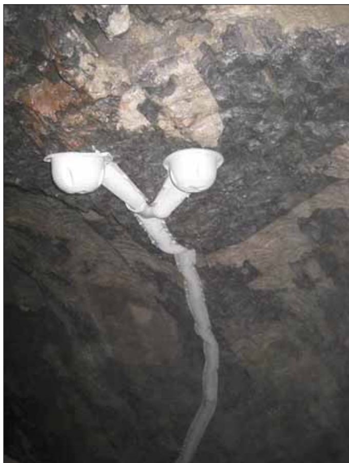
Obr. 11 Svodnice na líci výrubu Fig. 11 Cross-drain on the excavation surface
