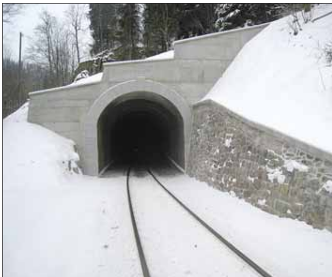
Obr. 15 Rekonstruovaný portál Domašovského tunelu Fig. 15 Reconstructed Domašov tunnel portal
