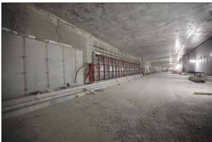
Obr. 1 Přibetonávka spodní části podzemních stěn (Archiv SMP CZ, a.s.) Fig. 1 Concrete layer cast on a part of diaphragm walls (SMP CZ, a. s., archives)
