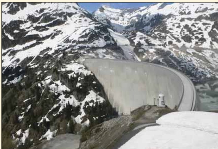
Obr. 5 Pohled na 180 m vysokou klenbovou hráz nádrže Emosson Fig. 5 View of the 180m high Emosson arch dam
