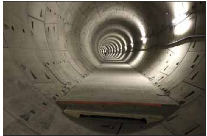
Obr. 3 Pohled na část zrealizovaných podkladních betonů
