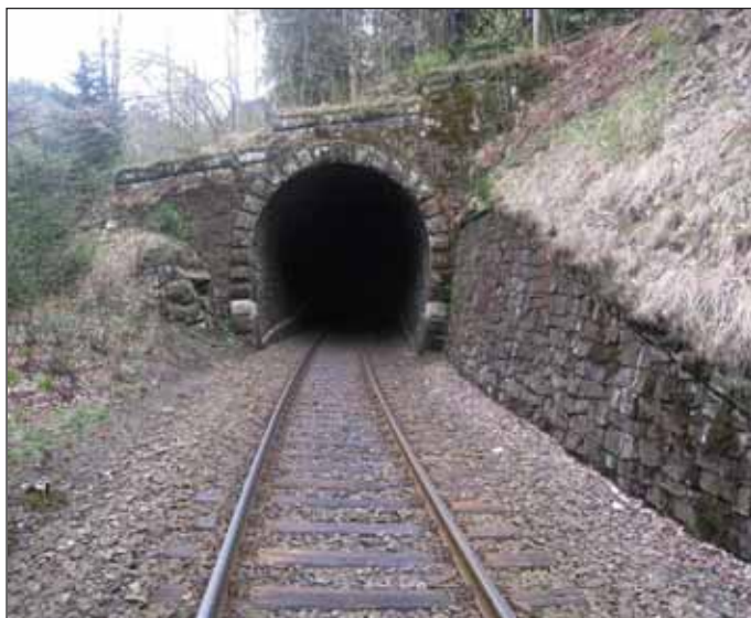
Obr. 1 Původní stav Domašovského tunelu Fig. 1 Domašov tunnel original condition
