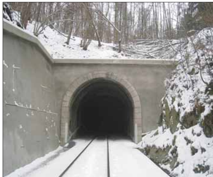
Obr. 16 Rekonstruovaný portál Jívovského tunelu Fig. 16 Reconstructed Jívová tunnel portal
