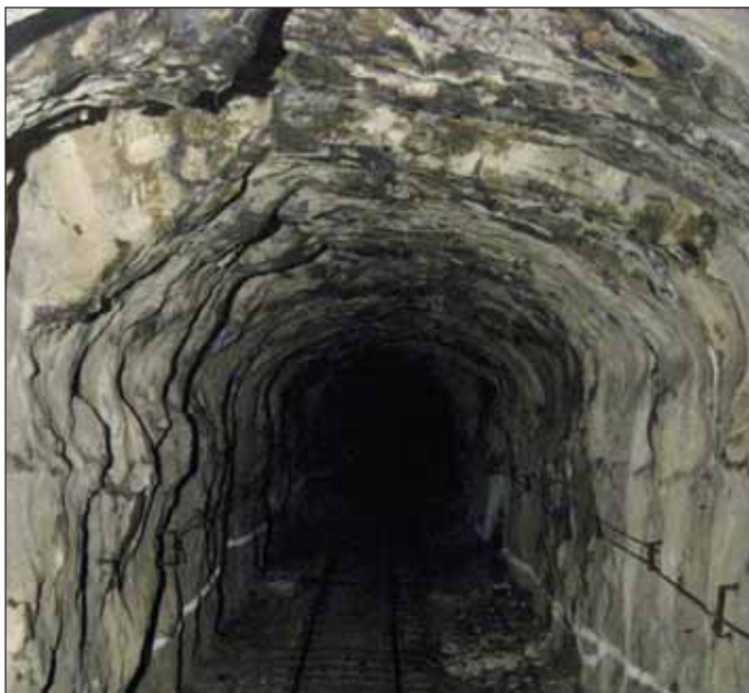
Obr. 9 Původní stav Jívovského tunelu Fig. 9 Original condition of the Jívová tunnel
