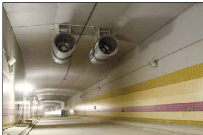
Obr. 5 Pohled na hotovou podzemní stěnu (Satra spol. s r.o.)
