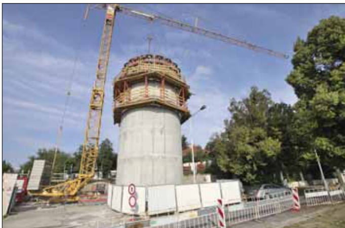
Obr. 1 Výstavba výdechového objektu v ulici Nad Octárnou (foto Jakub Karlíček)
