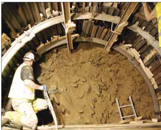
Obr. 8 Čelba odvodňovací stoly při ražbě v sutích Fig. 8 Drainage gallery excavation face during the course of driving through debris
