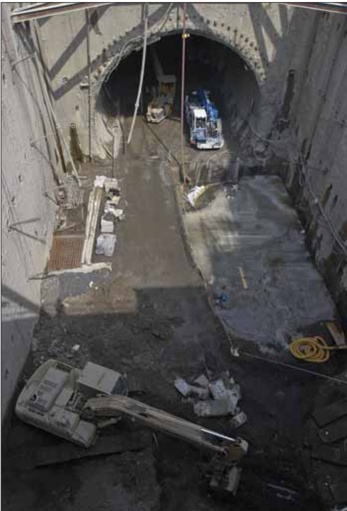
Obr. 4 Dotěžování zajištěné stavební jámy pro realizace sruženého VZT objektu
