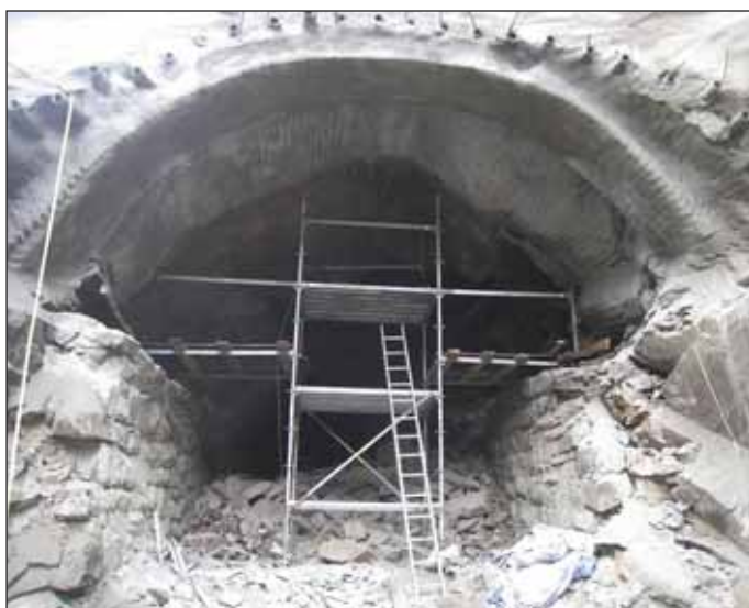
Obr. 7 Zajištění výrubu u portálu Domašovského tunelu Fig. 7 Excavation support at the Domašov tunnel portal
