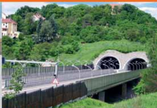
Pražská radiála v Brně, Stavba roku 1999
