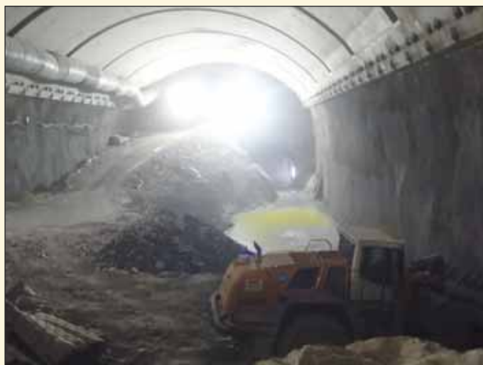
Obr. 7 Pohled na dokončené definitivní osěnění klenby kaverny a její pokračující výrub
