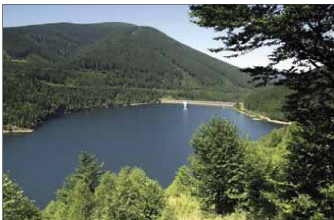
Obr. 1 Celkový pohled na přehradu Fig. 1 Overall view of the dam reservoir
