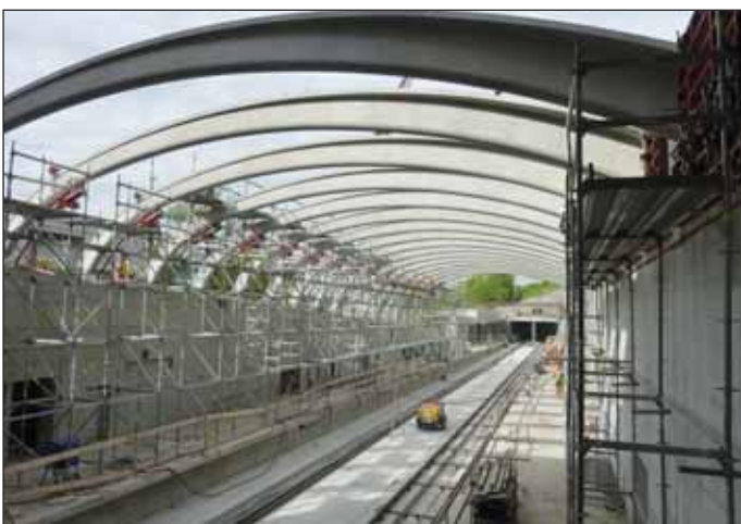
Obr. 3 Montáž rámu klenby hloubené stanice Motol (foto Jan Martinec)
