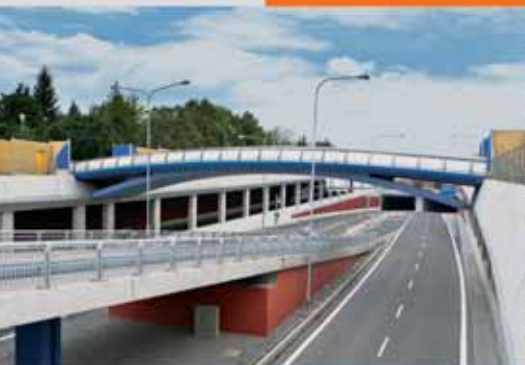
Silnice I/42 Brno, VMO Dobrovského
