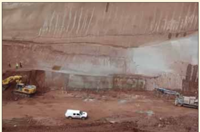
Obr. 2 Pohled na budování a zajišťování svahu hloubeného úseku tunelu Fig. 2 View of the cut-and-cover tunnel section construction and slope stabilisation
