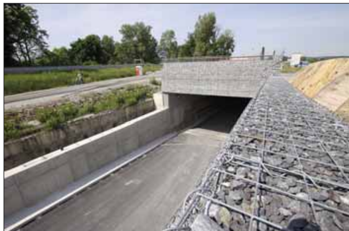
Obr. 4 Portál rampy 3 v Troji (foto Jakub Karlíček)
