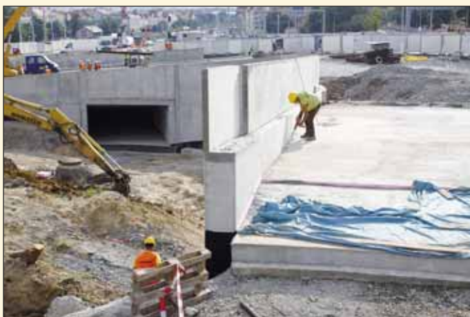
Výstavba podchodů na křižovatce Prašný most (foto Jakub Karlíček) Construction of subways at the Prašný Most intersection (photo Jakub Karlíček)
