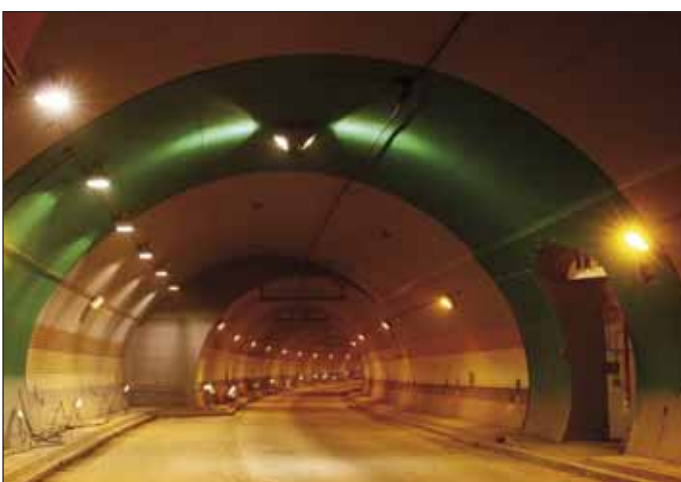
Obr. 5 Odstavný záliv v raženém Bubenečském tunelu (foto Jakub Karlíček)
