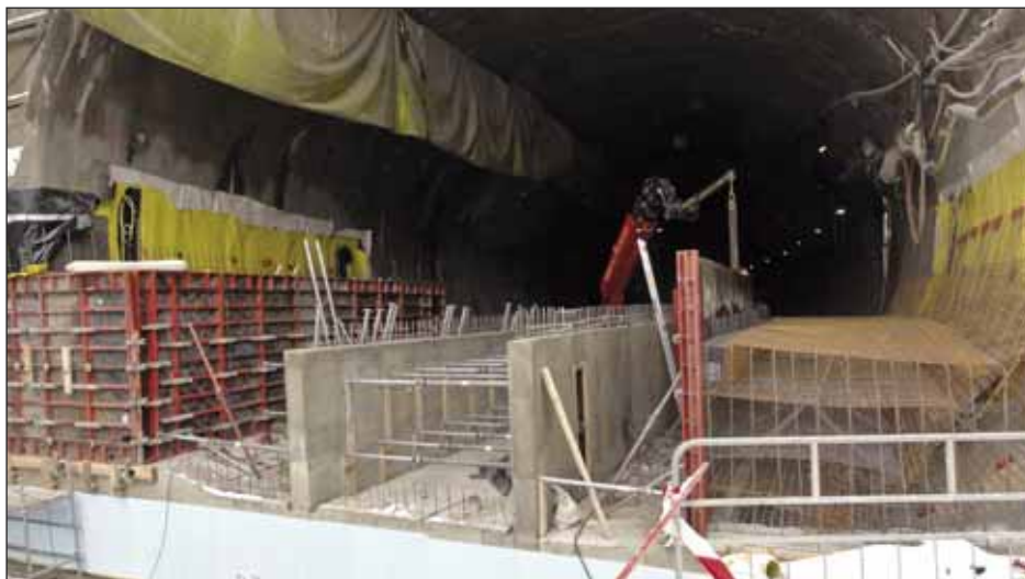
Obr. 3 Pohled na rozpracovanou první sekci spodní klenby v STT (zdroj: Archiv SMP CZ, a. s.) Fig. 3 View of the first section of the NTT invert in process (source: SMP CZ, a. s., archives)
