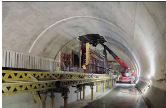
Obr. 2 Definitivní ostění stanice Petřiny včetně vstupu pro výtahovou šachtu (foto Josef Husák)
