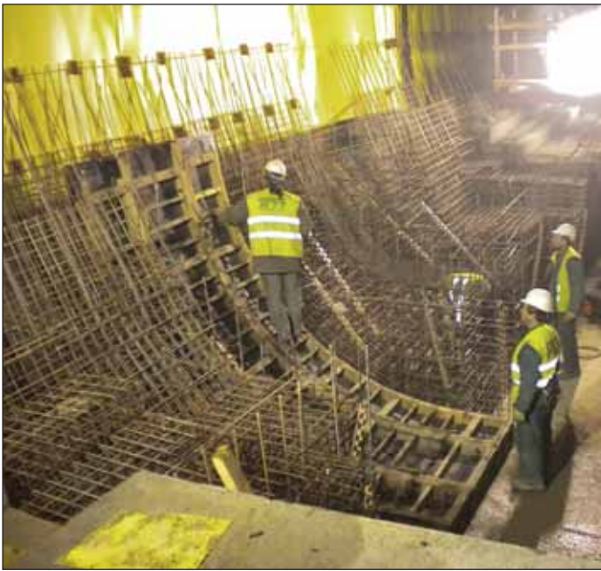
Obr. 4 Práce na kanálech VZT (zdroj: Archiv SMP CZ, a.s.) Fig. 4 Work on ventilation ducts (source: SMP CZ, a. s., archives)
