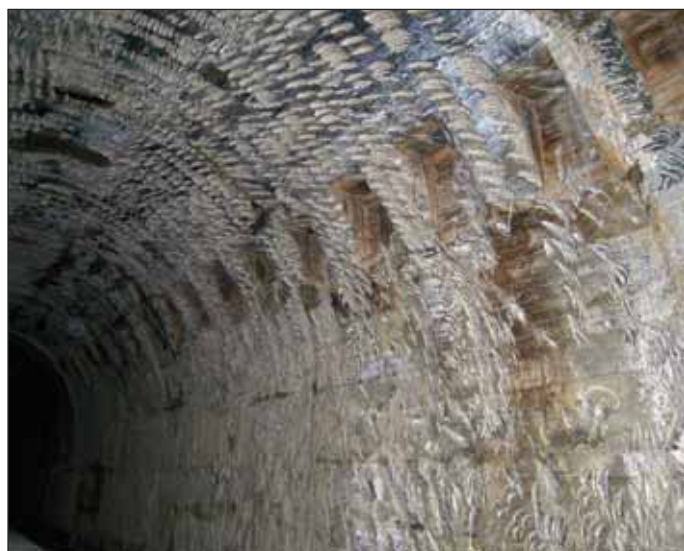
Obr. 13 Ofrézované původní ostění Fig. 13 Original lining treated by milling
