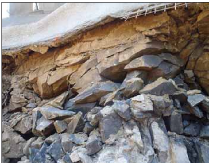
Obr. 2 Detail skalního masivu – narušená hornina Fig. 2 Detail of the rock mass – disturbed rock
