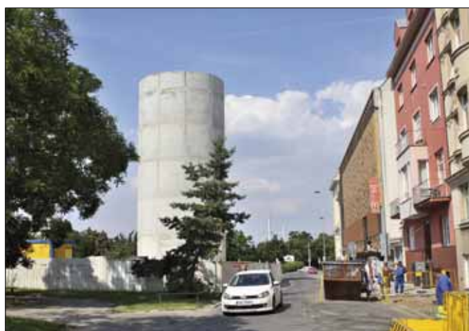
Obr. 6 Výstavba výdechového objektu v ulici Nad Královskou oborou (foto Jakub Karlíček)
