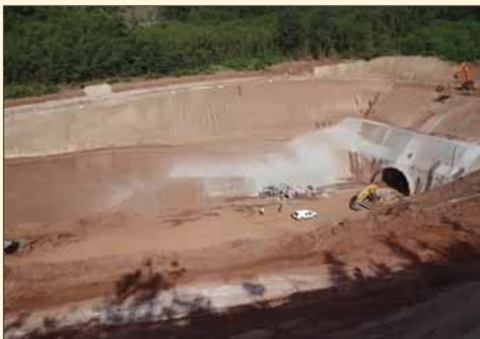
Obr. 1 Celkový pohled na mohutný portál a zářez tunelu Fig. 1 Overall view of the mighty tunnel portal and open cut
