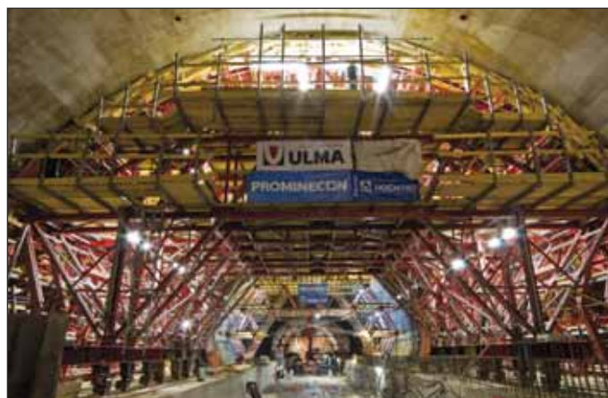
Obr. 6 Pracovní proud budování definitivního ostění stanice Bořislavka (foto Jan Martinec)
