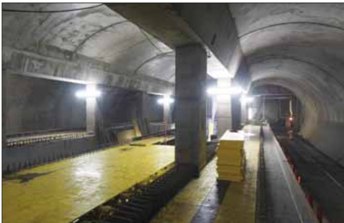
Obr. 1 Definitivní ostění ražené trojlovní stanice Veveslavín (foto Ing. Jiří Junek)
