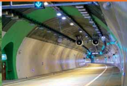
D4707 - tunel Křimkovic, Stavba Moravskoslezského kraje roku 2008
