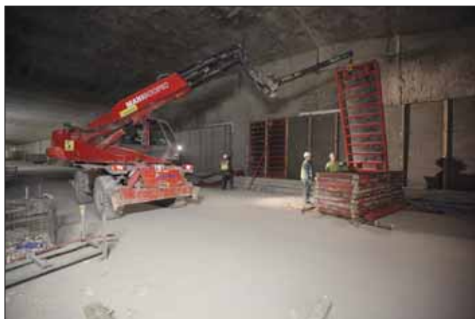
Obr. 2 Odbedňování přibetonávky (Archiv SMP CZ, a.s.) Fig. 2 Stripping the formwork from the cast-on layer (SMP CZ, a. s., archives)
