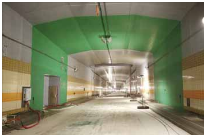
Obr. 2 Dokončovací práce v hloubeném tunelu Brusnice (foto Jakub Karlíček)
