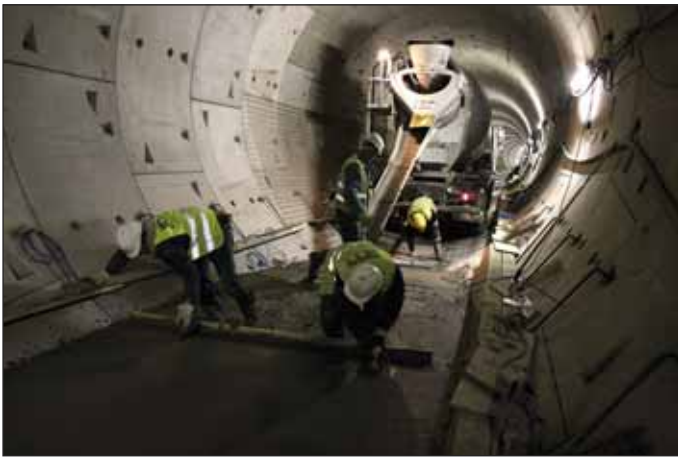
Obr. 2 Realizace podkladních betonů na úseku 06 – Nádraží Veveslavín – Petřiny
