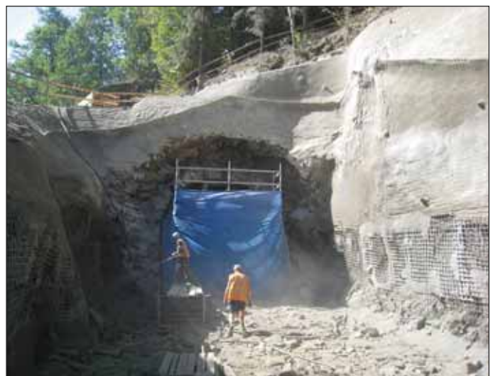
Obr. 6 Stavební jáma Domašovského tunelu Fig. 6 Domašov tunnel construction pit
