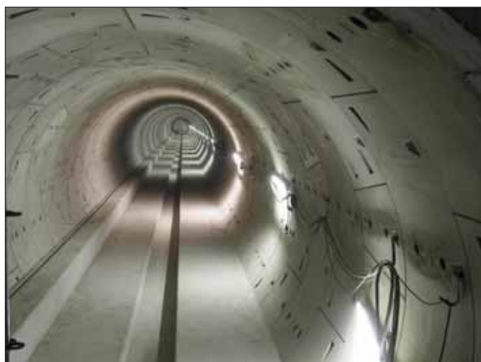
Obr. 4 Podkladní a kolejové betony v traťovém tunelu (foto Ing. Jiří Junek)
