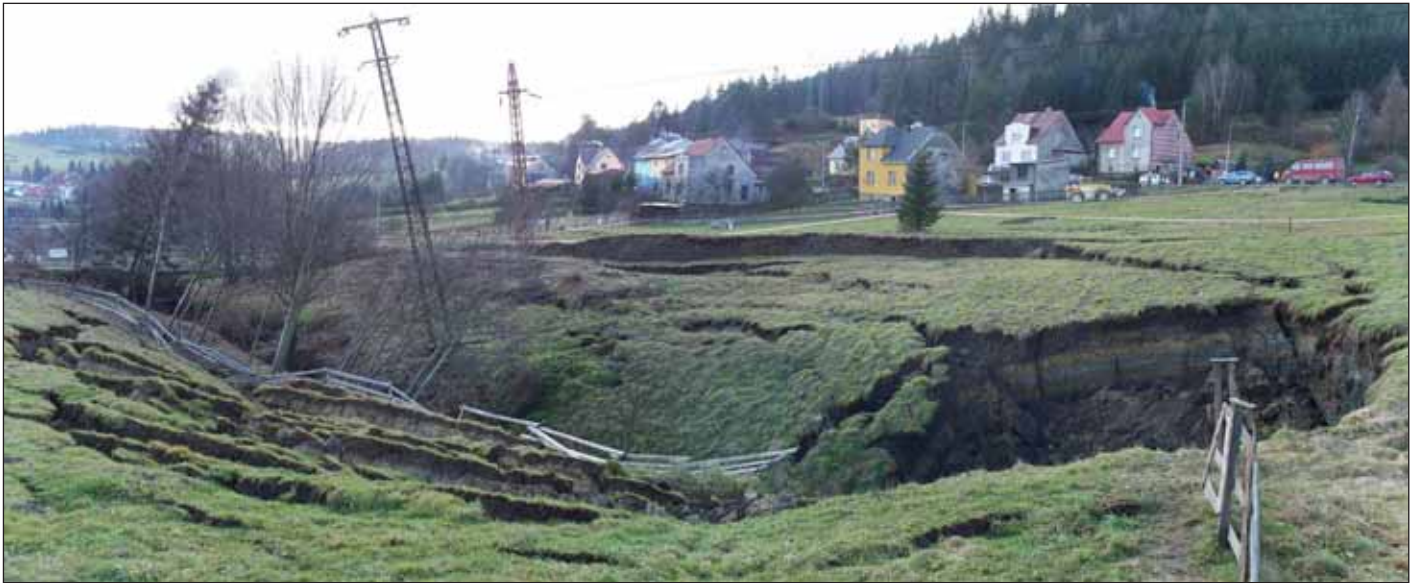
Obr. 6 Deformace terénu po závalových událostech (2009) Fig. 6 Terrain deformations after the collapse events (2009)
