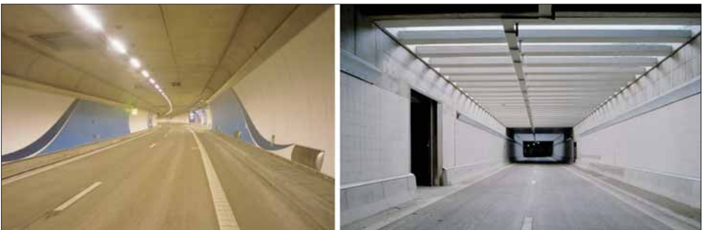
Obr. 3 Tunely Cointe ( http://minel-schreder.rs/en/applications/grouppreferences.html , 20. 3. 2012 ) a Kinkempois ( http://www.ori.be/fr/projets/tunnel-de-kinkempois , 20. 3. 2012 ) v Belgicku na E25-E40 v Liege s použitím CB vozovky
