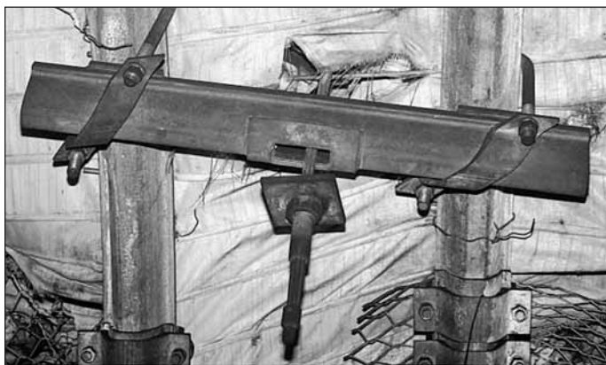
Obr. 8 Ilustrační foto pramencové kotvy ukotvené k obloukové výztuži pomocí rovného nosníku z válcovaného profilu TH (profil pro výrobu důlních obloukových výztuží)
