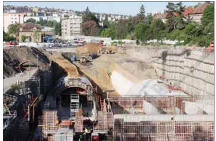
Obr. 2 Výstavba klenbových tunelů v jámě Patočkova Fig. 2 Construction of vaulted tunnels in the Patočkova construction pit
