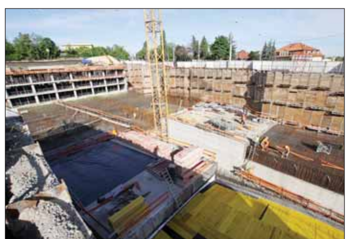
Obr. 6 Armování, bednění a betonáž stropu tunelů na Prašném mostě Fig. 6 Installation of reinforcement and formwork and casting of tunnel roof deck at Prašný Most
