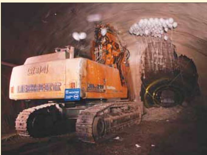
Obr. 1 Prorážka se uskutečnila v TM 480 Fig. 1 The tunnel broke through at tunnel chainage metre TM 480
