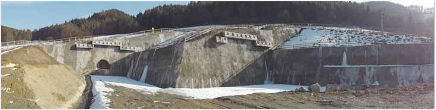
Obr. 7 Pohľad na dolnohričovský portál tunela Ovčiarsko na úseku D1 Hričovské Podhradie – Lietavská Lúčka Fig. 7 View of dolnohričovský portal of tunnel Ovčiarsko on D1 Hričovské Podhradie – Lietavská Lúčka
