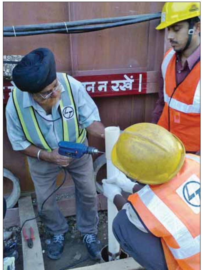
Obr. 3 Montáž inklinometrické pažnice ve vrtu
