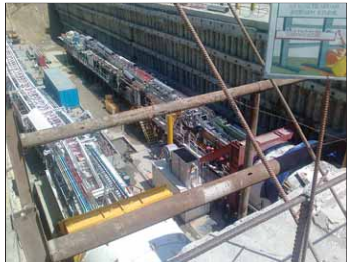
Obr. 2 Pohled na montáž štítů Robbins a Herrenknecht ve stavební jámě B01 Fig. 2 A view of the Robbins and Herrenknecht shields assembly in the B01 construction pit
