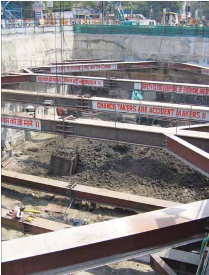
Obr. 3 Rozpíraná stavební jáma montážní šachty Nehru Park Fig. 3 Braced construction pit for the Nehru Park assembly shaft
