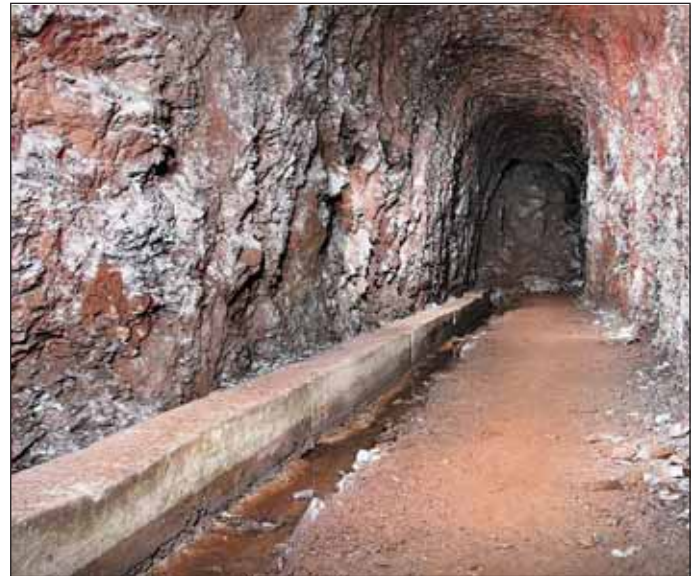
Obr. 3 Vybetonovaný základ ostění v podzemí tvrze Dobrošov Fig. 3 Completed concrete foundation of the lining in the Dobrošov fortress underground
