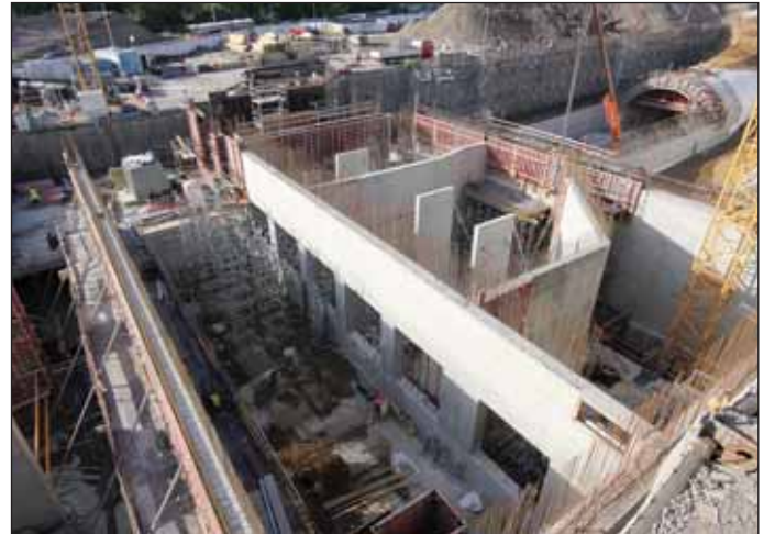
Obr. 4 Objekt technologického centra TGCI Myslbekova Fig. 4 TGCI Myslbekova service building
