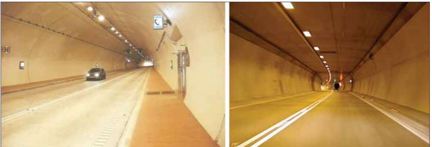
Obr. 2 Pohľady na CB vozovky na diaľnici D1 v tuneloch Bôrik (Ing. Ján Filipovský) a Branisko ( http://www.railweb.sk/Foto/Foto_bran.html , 20. 3. 2012 )
