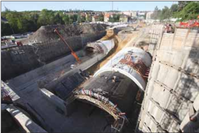
Obr. 1 Výstavba klenbových tunelů v jámě Patočkova Fig. 1 Construction of vaulted tunnels in the Patočkova construction pit
