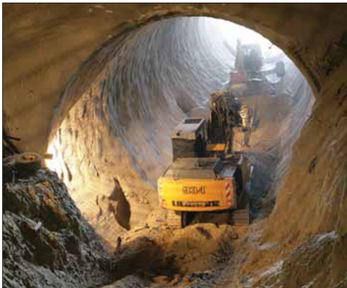
Obr. 3 Proražený eskalátorový tunel pro stanici Petřiny (foto: Josef Husák) Fig. 3 Escalator tunnel for the Petřiny station after breakthrough (Photo courtesy of Josef Husák)
