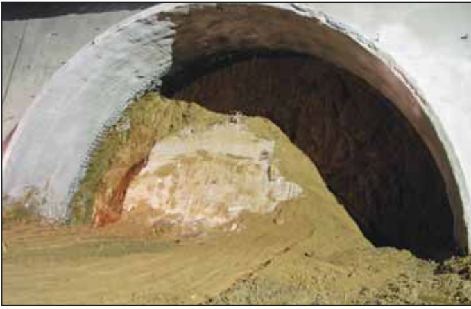
Obr. 2 Počátek ražeb z jižního portálu v silně zvětralých rulách (Ing. J. Svatoš) Fig. 2 Commencement of tunnelling through heavily weathered gneiss from the southern portal (Ing. J. Svatoš)
