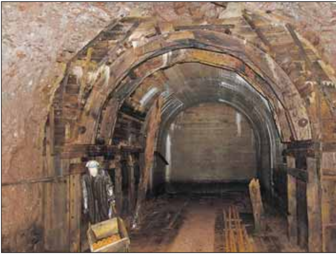
Obr. 9 Zednická výdřeva (skruže) v sále v podzemí tvrže Stachelberg Fig. 9 Bricklayers' timbering (centering) in a hall in the Stachelberg fortress underground
