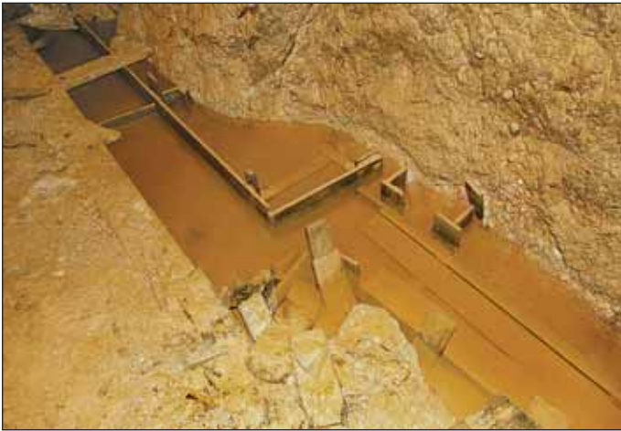
Obr. 2 Bednění základů ostění v podzemí tvrze Stachelberg Fig. 2 Formwork for foundations of the lining in the Stachelberg fortress underground
