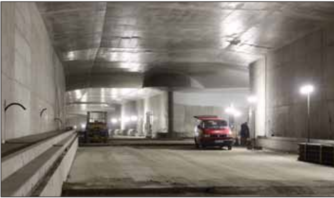
Obr. 7 Dokončovací práce v hloubených tunelech u Špejcharu Fig. 7 Finishing work in cut-and-cover tunnels at Špejchar
