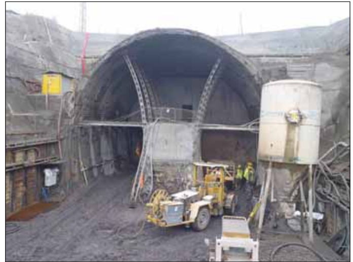
Obr. 7 Jižní portál tunelu Jablunkov – zmáhání závalů (12/2011)
