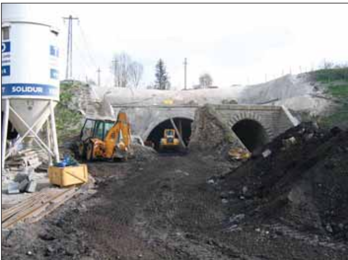
Obr. 4 Jižní portál tunelu Jablunkov č. II – výstavba nového portálu (2008) Fig. 4 Southern portal of the Jablunkov No. 2 tunnel – construction of a new portal (2008)
