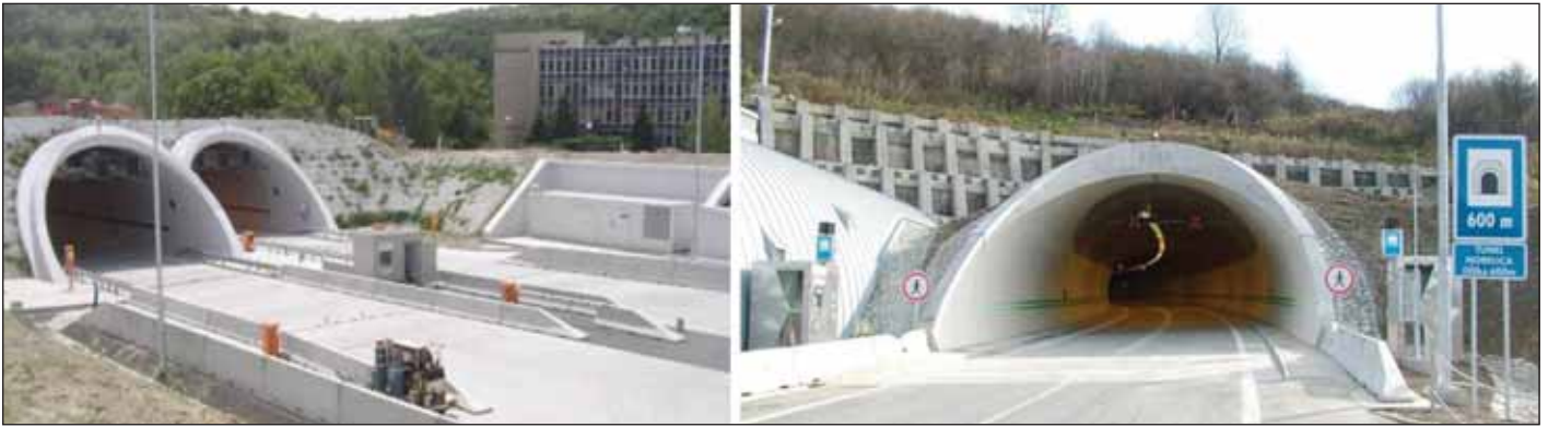
Obr. 1 Pohľady na CB vozovky – vľavo tunel Sitina na D2 (Ing. Dušan Todák), vpravo výjazd z tunela Horelica na trase D3 ( http://dialnice.szm.com/tunnels/Horelica.htm , 22. 3. 2012 )
