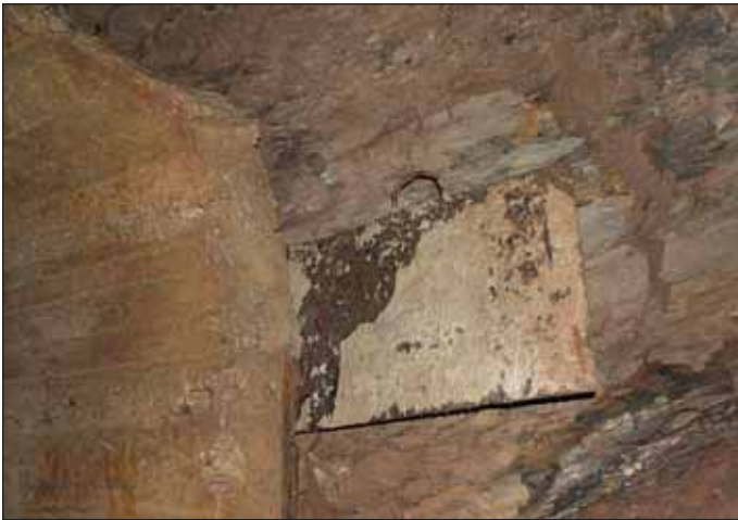
Obr. 7 Bednicí plech v podzemí tvrže Dobrošov Fig. 7 The steel sheet used for formwork in the Dobrošov fortress underground
