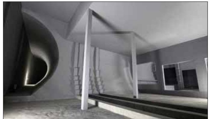
Obr. 10 Prostor pro ventilátory v ražené strojovně vzduchotechniky Fig. 10 Space for fans in the mined cavern for ventilation plant
