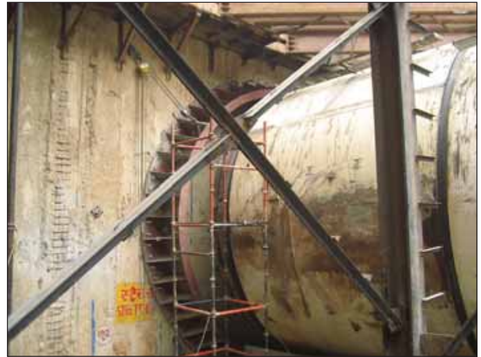
Obr. 6 Ocelový prstenc pro průchod EPBS z projektu metra v Dillí Fig. 6 Steel ring for the passage of the EPBS used on the Delhi Metro project
