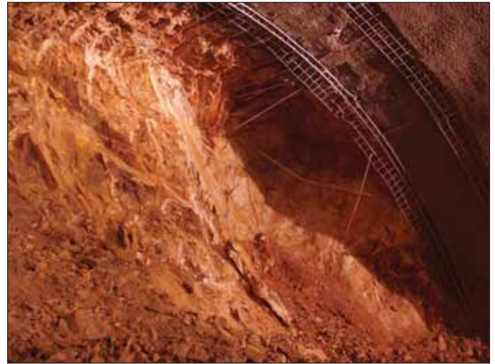
Obr. 8 Nadvýlom u tunelu Tomický I (Ing. J. Svatoš)
