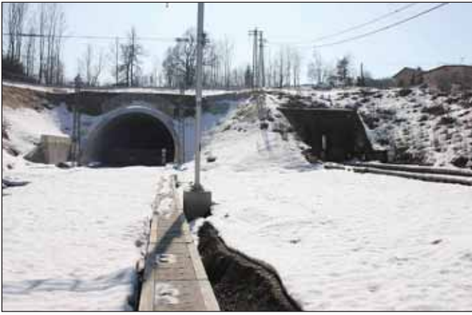
Obr. 5 Severní portály – nový a provozovaný tunel (2012) Fig. 5 Northern portals – the new tunnel and operating tunnel (2012)
