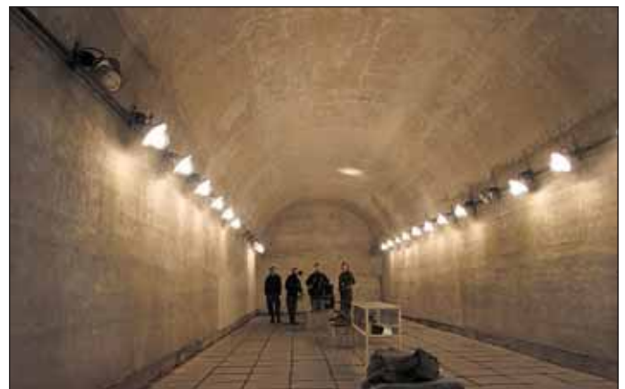
Obr. 15 Muniční sál profilu 520/460 v podzemí tvrze Dobrošov s definitivním ostěním; součást prohlídkového okruhu Fig. 15 A 520/460-profile ammunition store room in the Dobrošov fortress underground with the final lining installed - part of the guided tour
