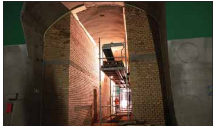
Obr. 12 Zdění příček v tunelové propojce TP12 Fig. 12 Erection of masonry partitions in cross passage TP12
