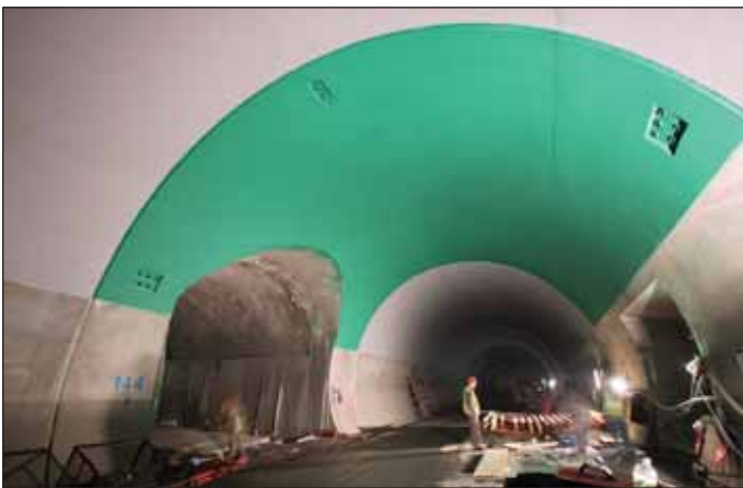
Obr. 9 Nátěr klenby raženého tunelu v křížení s tunelovou propojkou TP14 Fig. 9 Coating applied to the vault of the mined tunnel at the intersection with the cross passage TP14
