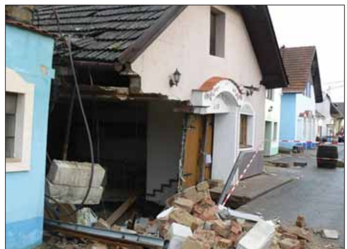
Obr. 9 Bořetice – Kraví hora, leden 2009; částečně zřícená lisovna č. 53 nad zavaleným sklepem p. Václava Bukovského
