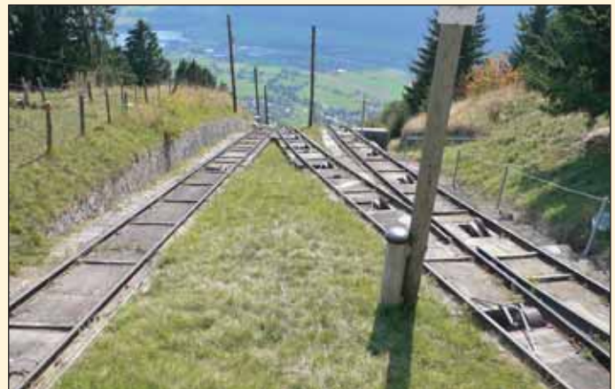
Obr. 4 Kolejiště lanovky pod přestupní stanicí Fig. 4 Funicular tracks under the transfer station
