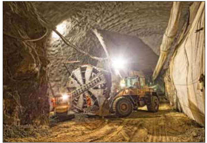
Obr. 4 Průnik technologií NRTM a EPBS ve stanici (foto Tatar)
