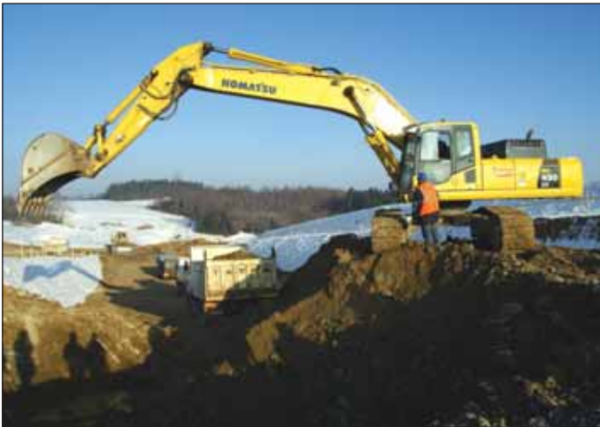
Obr. 1 Zahájení těžení jámy (01/2010) Fig. 1 Commencement of pit excavation (01/2010)
