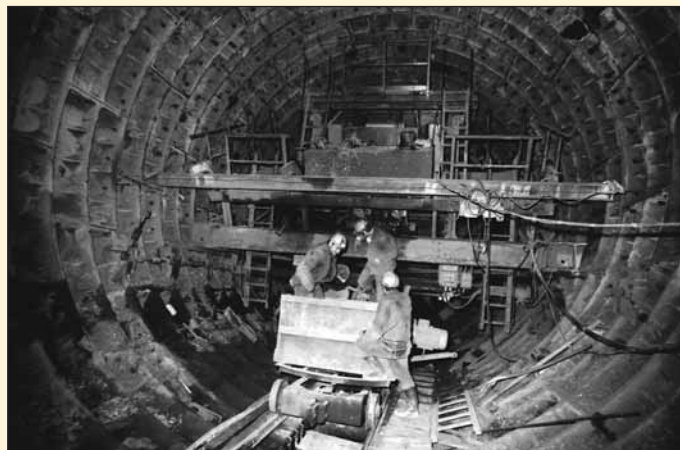
Obr. 3 Z výstavby stanice Fig. 3 From the construction of the station
