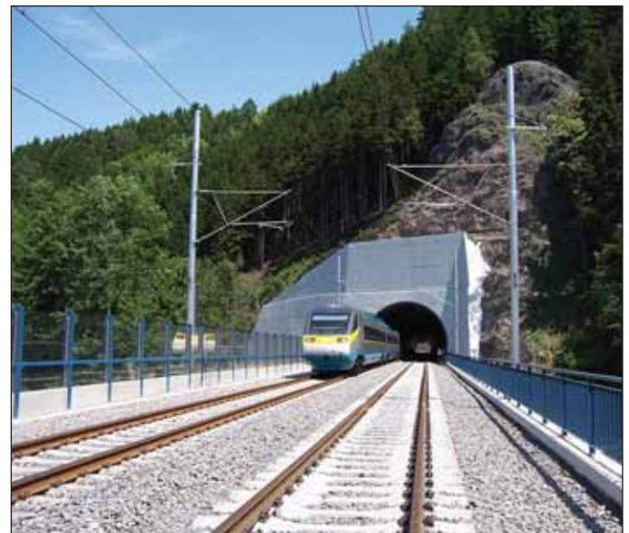
Obr. 10 Evropský železniční koridor I, tunel Hněvkov, 2006 Fig. 10 European railway corridor I, the Hněvkov tunnel, 2006
