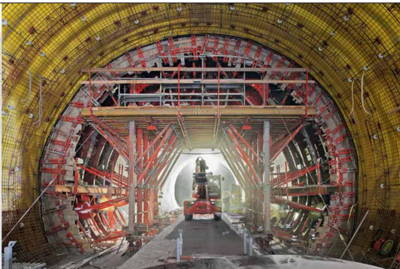
Tunelová forma s ocelovým pláštěm (Blanka)
