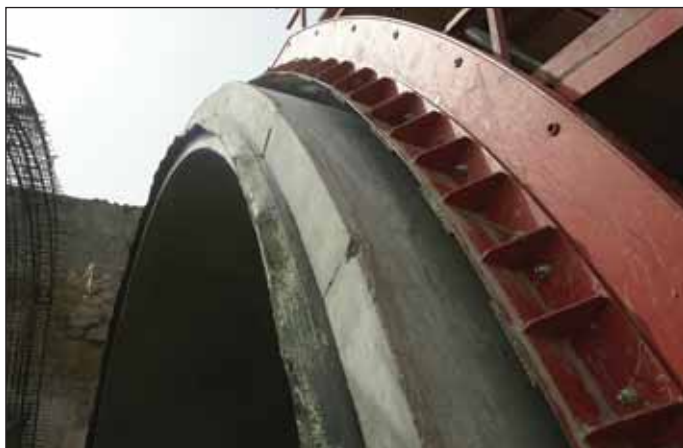
Obr. 10 Spárový pás Fig. 10 Waterstop
