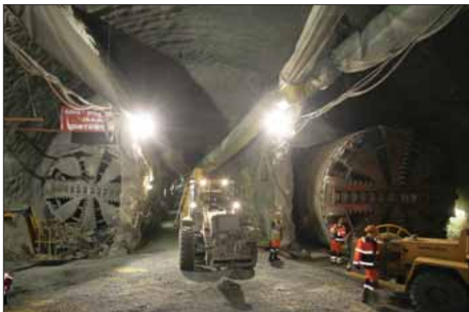
Obr. 5 Příprava štítů Tonda a Adéla před protažením stanicí (foto Husák)
