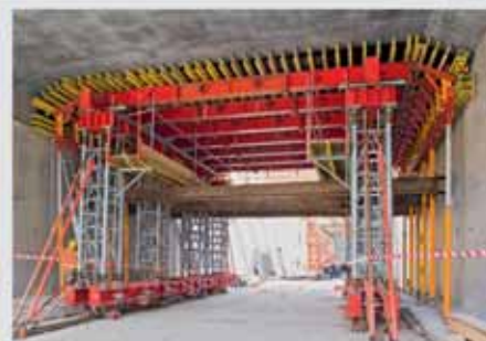
Pojízdné bednění stropu hloubeného tunelu se systémem STA44 (VMO Dobrovského)
