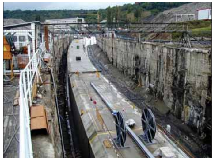
Obr. 4 Segment naplavovaného tunelu metra v suchém doku na břehu řeky Vltavy, 2001
