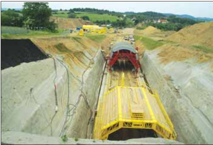
Obr. 3 Svahovaná stavební jáma výjezdového portálu Fig. 3 Sloped construction pit for the exit portal
