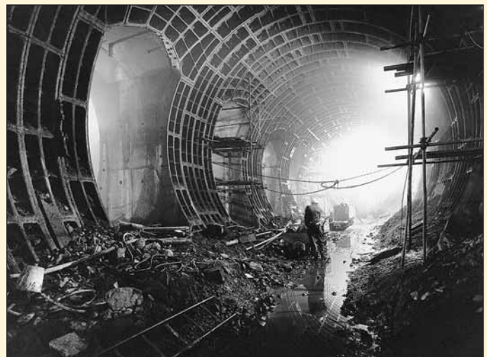
Obr. 4 Stanice Staroměstská Fig. 4 Staroměstská station
