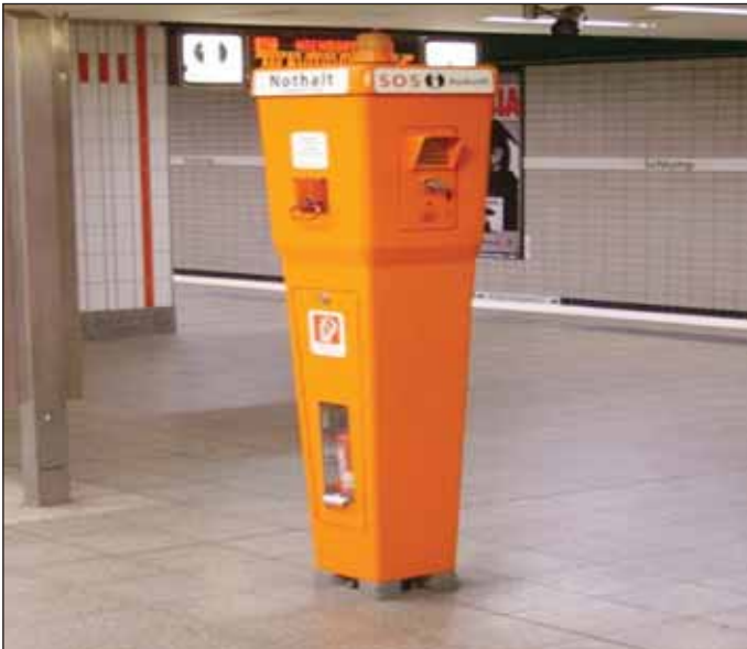
Obr. 10 Hlášky SOS na nástupišti Fig. 10 Emergency call boxes
