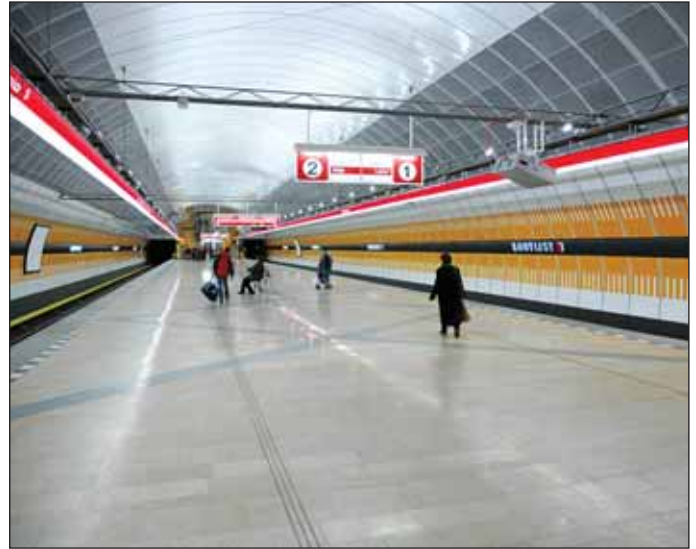
Obr. 8 Jednolodní stanice metra Kobyličky, 2004 Fig. 8 Kobyličky single-vault metro station, 2004
