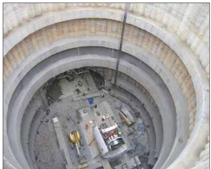
Obr. 12 Montáž zeminového štítu v jámě na staveništi Vypich, 2011 Fig. 12 Assembly of an Earth Pressure Balance Shield in a construction pit on Vypich site, 2011
