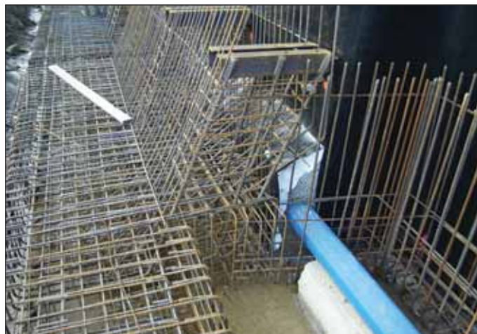
Obr. 9 Boční tunelová drenáž Fig. 9 Tunnel side drainage
