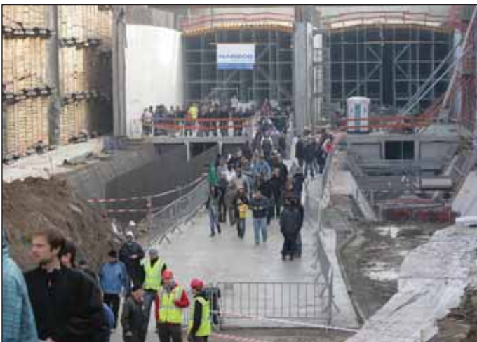
Obr. 3 Na Prašném mostě byly k vidění hloubené tunely v různých úrovních rozestavěnosti
