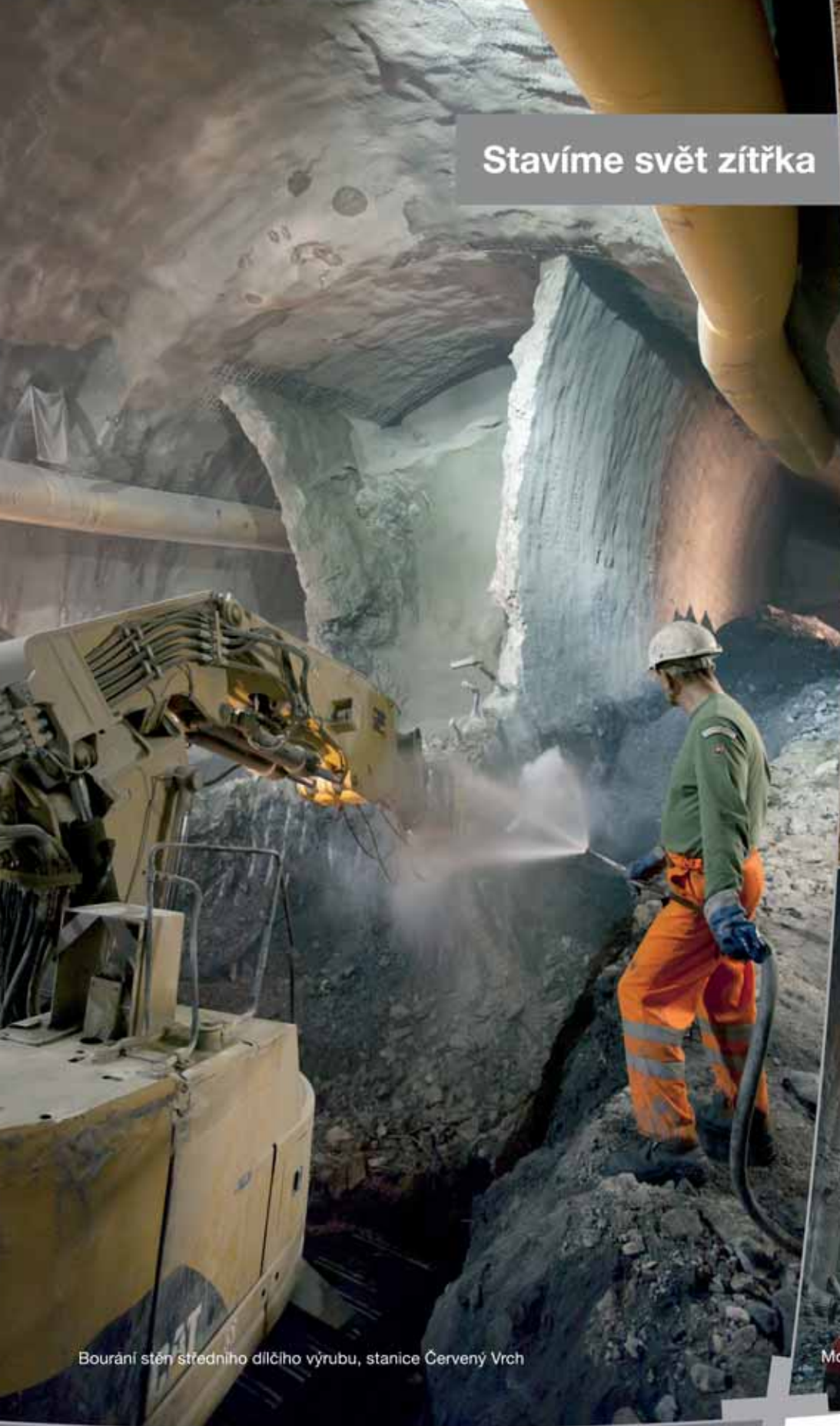
Razba dvoukolejného tunelu ze stanice Motol do stanice Vypich
