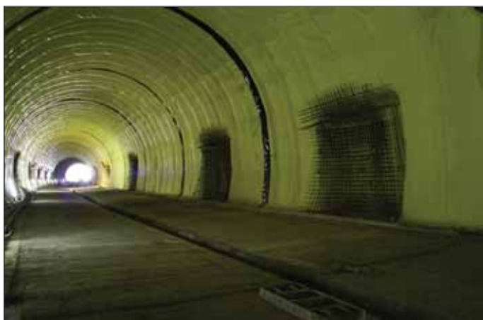
Obr. 11 Úsek tunelu s nevyztuženým ostěním Fig. 11 Tunnel section with non-reinforced concrete lining
