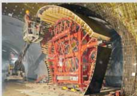
Systémové bednění krčku tunelové propojky (Blanka)
