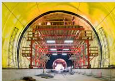
Pojízdný armovací vůz ze systému PERI VARIOKIT (Mosty u Jablunkova)
