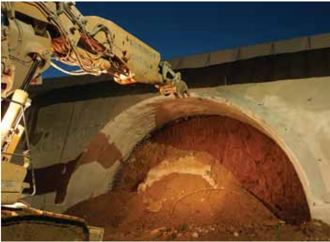
Obr. 7 Silně zvětralé eluvium na čelbě na vjezdovém portále Fig. 7 Heavily weathered eluvium at the heading at the entry portal
