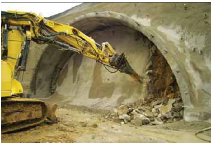
Obr. 4 Zahájení ražby pod zárodkem kaloty Fig. 4 Commencement of excavation under the top heading stub
