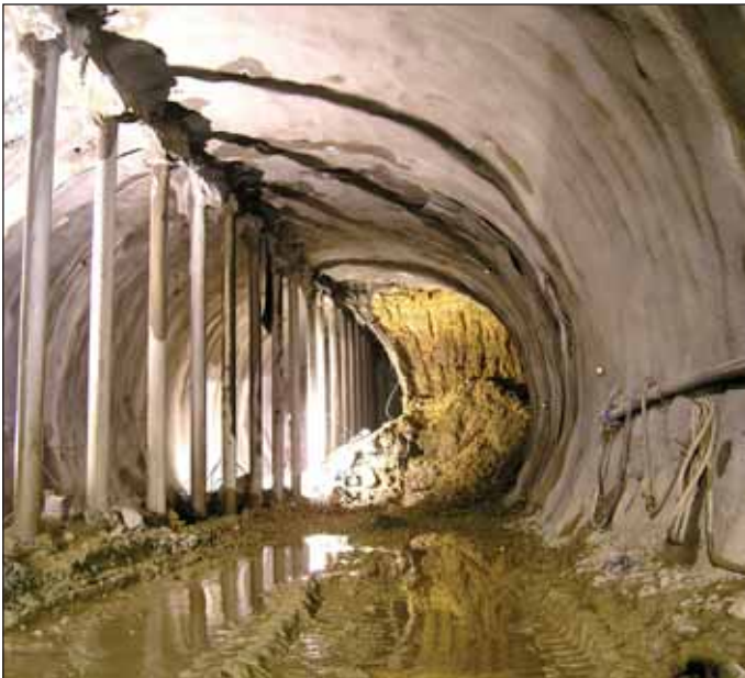
Obr. 9 Ražba tunelu metra pod ulicí Stoupačická v Praze 9, 2006 Fig. 9 Driving a metro tunnel under Stoupačická Street, Prague 9, 2006
