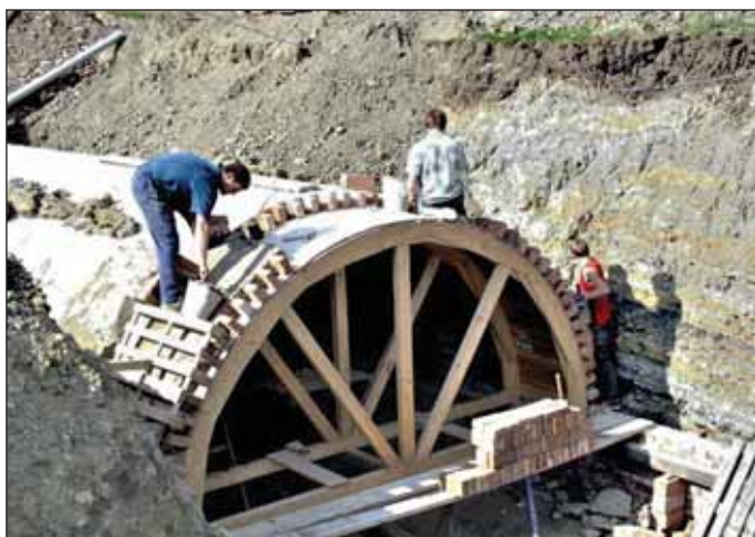
Obr. 2 „Kvelbení“ s výstavbou obezdívky v otevřeném výkopu; tloušťka obezdívky na 1 cihlu = 15 cm, sklep bude posléze zasyván [10]
