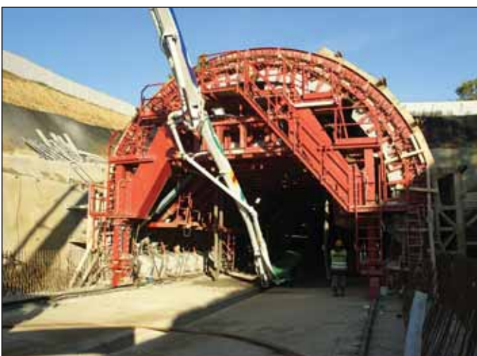
Obr. 8 Bednicí vůz ve stavební jámě Fig. 8 Traveller formwork in a construction pit
