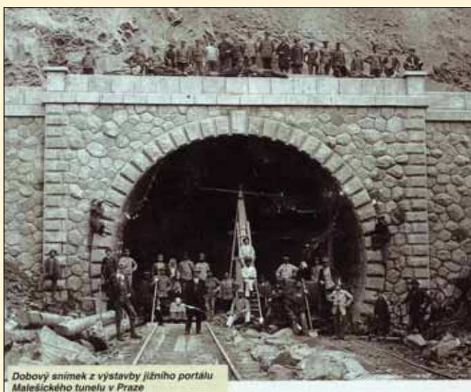
Obr. 4 Dobový snímek z výstavby jižního portálu Malešického tunelu [1]
