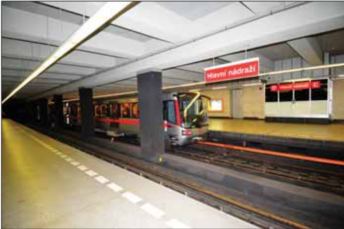
Obr. 1 Stanice pražského metra Hlavní nádraží, stavebně nejstarší stanice, 1974 Fig. 1 Hlavní Nádraží station of Prague metro – the oldest station constructed in Prague, 1974
