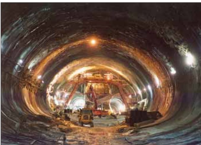
Obr. 5 Jednolodní stanice metra Kobylišy, primární ostění, 2002 Fig. 5 Kobylišy single-vault metro station, primary lining, 2002
