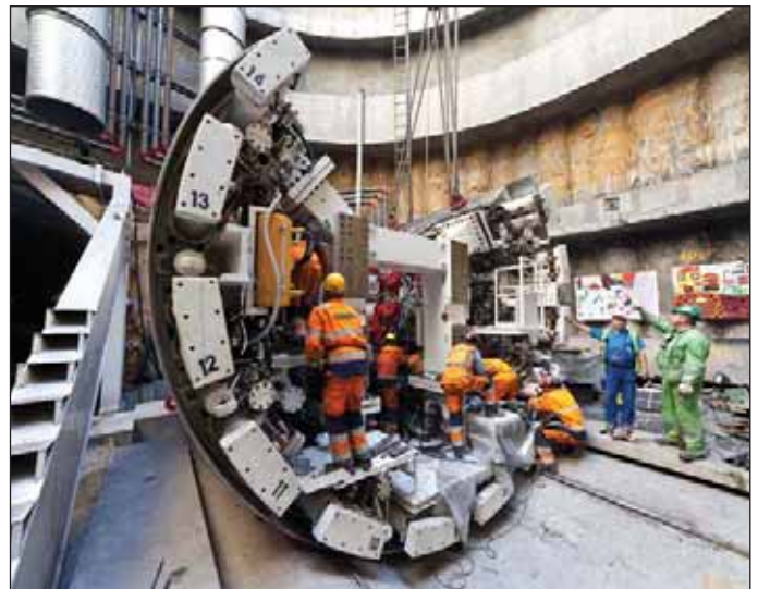
Obr. 10 Montáž stroje zeminového štítu Adéla (foto J. Tatar) Fig. 10 Assembly of Adéla EPB shield (photo courtesy of J. Tatar)
