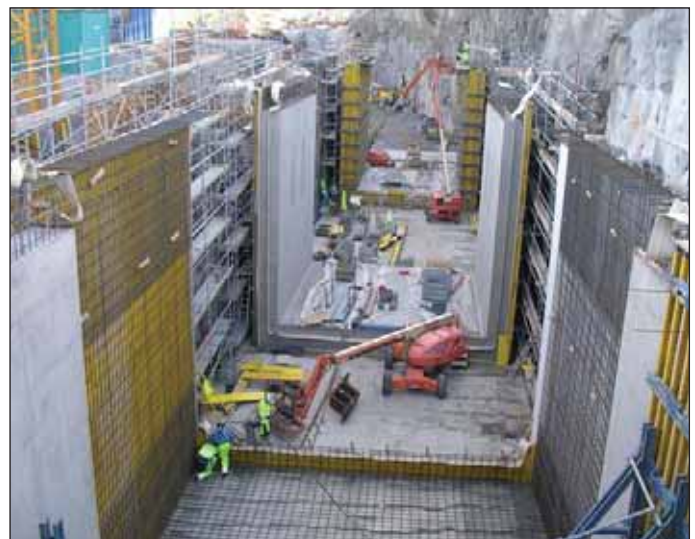
Obr. 9 Pohľad na postup výstavby Fig. 9 View of the construction process
