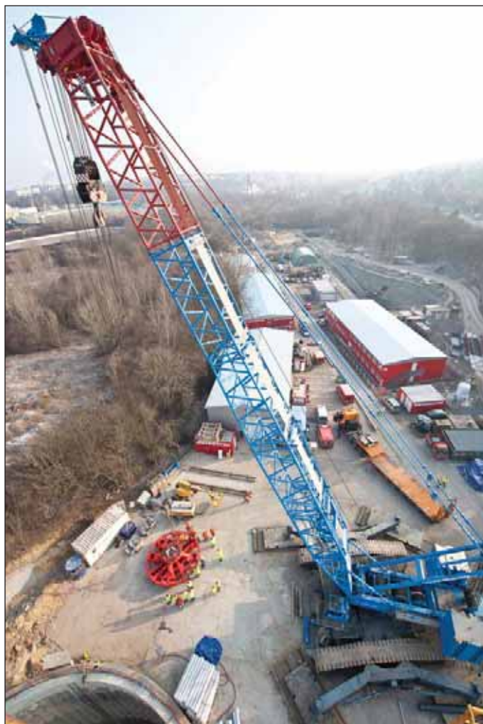
Obr. 1 Zařízení staveniště BRE1 – celkový pohled (foto Jan Tatar)
