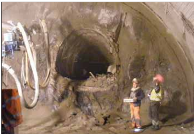
Obr. 7 Průzkumná štola tunelu Královská obora Fig. 7 Exploratory gallery for the Královská Obora tunnel
