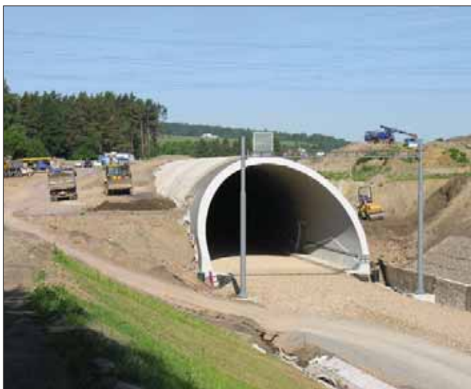
Obr. 7 Provádění zásypů v oblasti berounského portálu Fig. 7 Backfilling in the area of the Beroun portal
