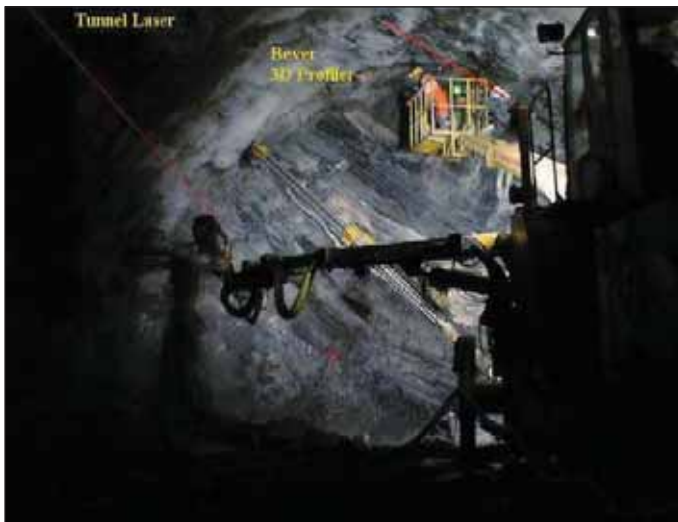
Obr. 9 Ukážka umiestnenia 3D profilera a navigácia vrtného voza líniovým laserom – systém Bever Control – Atlas Copco. Autor – Manuál k programu Bever Control
