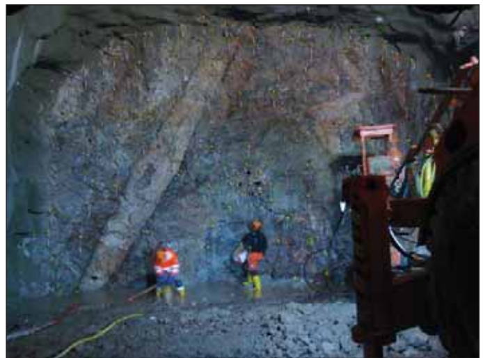
Obr. 5 Trhací práce v přístupovém tunelu Fig. 5 Blasting operations in an access tunnel
