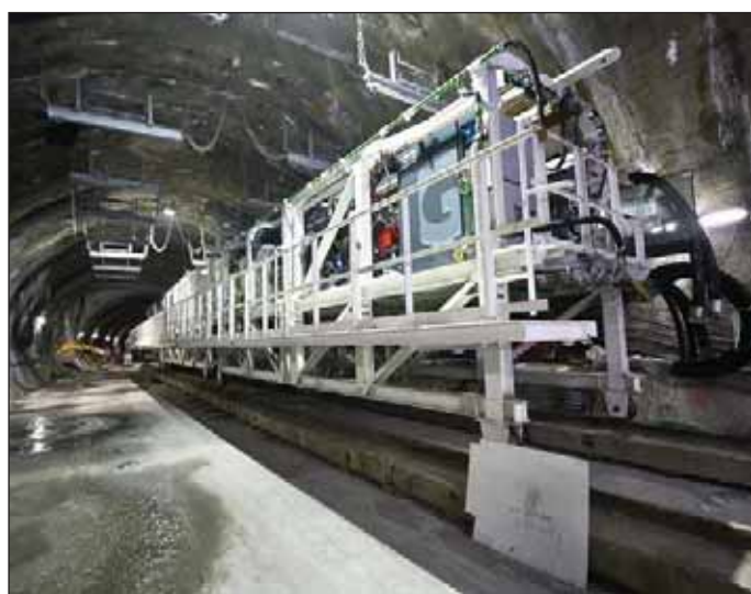
Obr. 2 Montážní komora s částí závěsu stroje EPBS (konkrétně návěsy č. 3, 4 a 5) (foto Jan Tatar)
