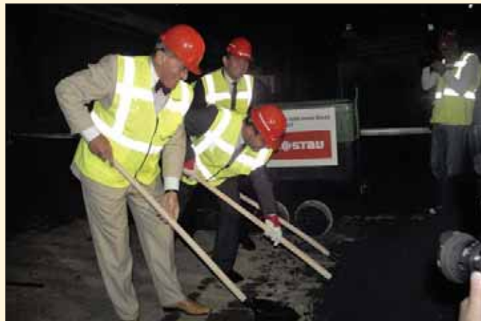
Obr. 1 Nakládání posledního kubíku horniny – vlevo pražský primátor MUDr. Bohuslav Svoboda, za ním jeho náměstek Ing. Karel Březina (foto: Ing. Libor Mařík) Fig. 1 Loading of the last cubic metre of ground – pictured left: MUDr. Bohuslav Svoboda, the Lord Mayor, Ing. Karel Březina, his deputy, behind him (photo courtesy of Libor Mařík)
