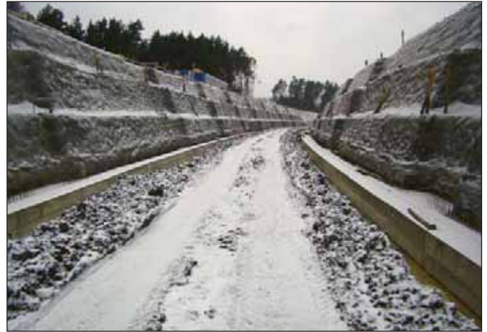
Obr. 2 Stavební jáma a základové pasy ostění Fig. 2 Construction trench and footings under the lining
