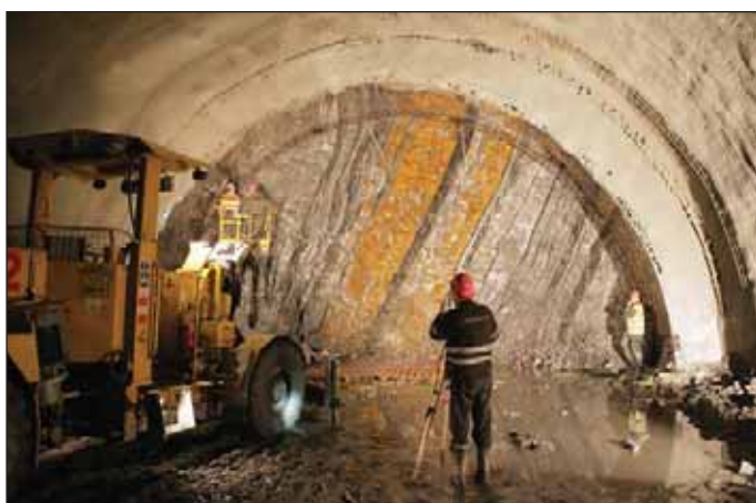
Obr. 3 Čelba dvoupruhového tunelu se zastiženou polohou křemenů při ražbě pod Vltavou
