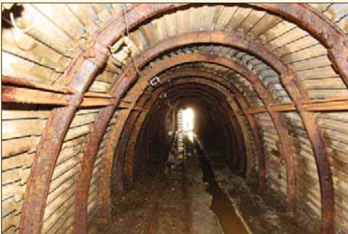
Obr. 2 Rekonstruovaná dědičná štola Jeroným Fig. 2 Reconstructed Jeroným sough
