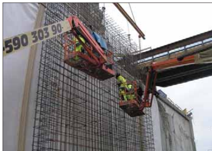
Obr. 11 Pracovníci pri montáži výstuže stien – osádzanie druhej mreže pomocou vežového žeriavu Fig. 11 Workers installing reinforcement of walls – placing the second net using a tower crane
