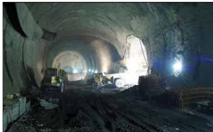
Obr. 5 Kaverna 2 – pohled na vyraženou strojovnu vzduchotechniky s boční rozrážkou kanálu 8
