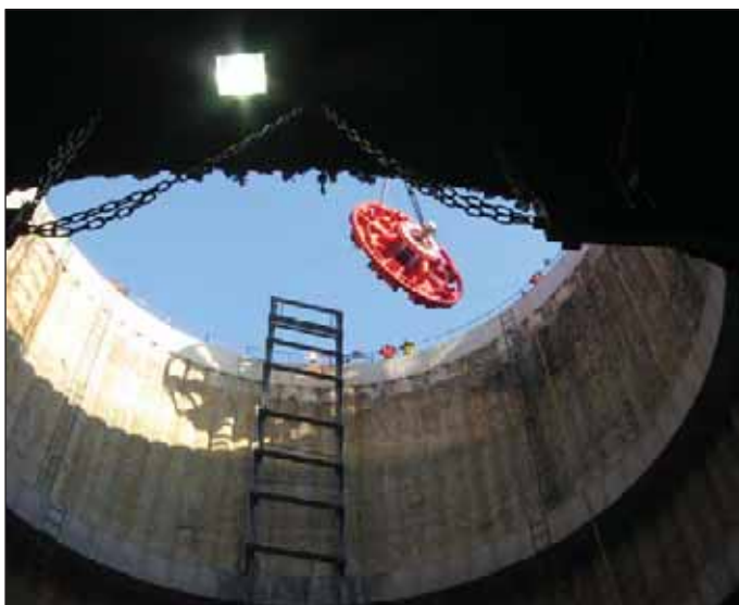
Obr. 5 Spouštění řezné hlavy montážní šachtou Fig. 5 Lowering the cutting head down the assembly shaft
