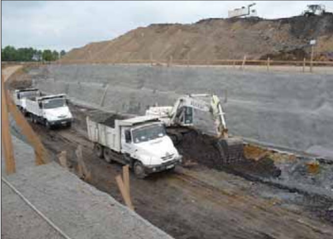
Obr. 1 Zemní práce a zajištění stavební jámy Fig. 1 Earthmoving work and stabilisation of construction trench
