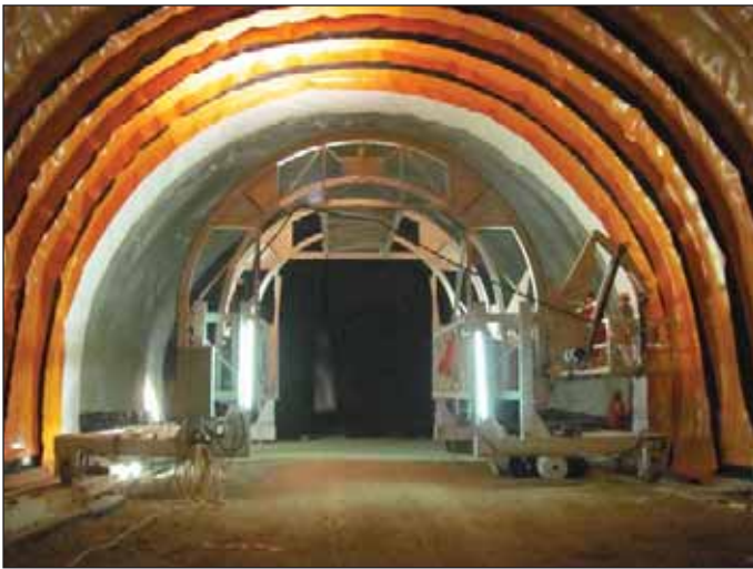
Obr. 7 Pohľad na izolátorský voz a realizáciu hydroizolácie tunelovej rúry Fig. 7 A view of a waterproofing installation travelling scaffold and the installation of the tunnel tube waterproofing
