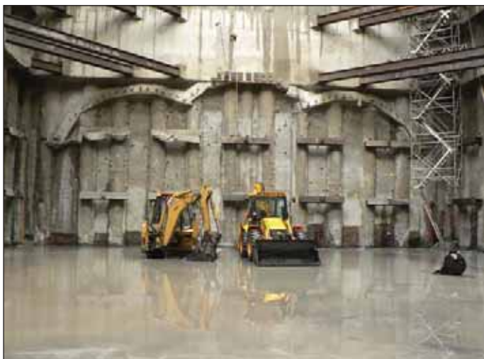
Obr. 3 Připravený portál pro ražbu trojlodní stanice ze stavební jámy Veveslavín (foto M. Chotár) Fig. 3 The portal prepared for the excavation of the triple-span station from the Veveslavín construction trench (photo courtesy of M. Chotár)
