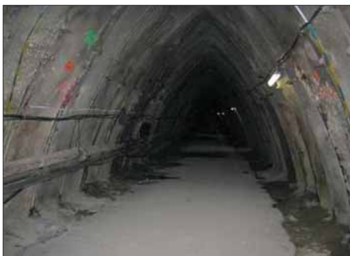
Obr. 5 Průzkumná štola Královopolského tunelu Fig. 5 Exploration gallery for the Královo Pole tunnel
