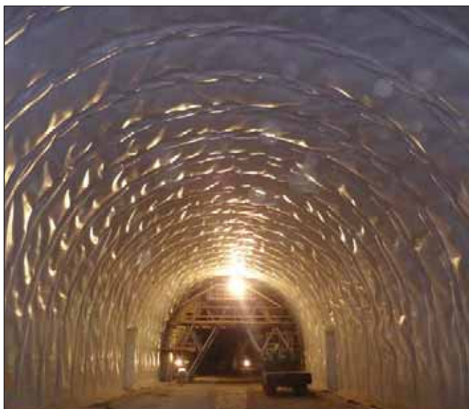
Obr. 3 Izolace osazená na primární ostění Fig. 3 Waterproofing installed on the primary lining
