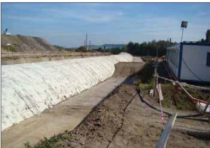
Obr. 5 Postupné symetrické zasypávání tunelu Fig. 5 Successive symmetric backfilling of the tunnel
