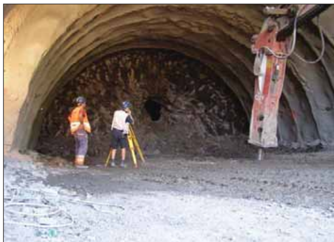
Obr. 8 Kontrola presnosti prerážky ľavej tunelovej rúry na Tuneli Barnica v Slovinsku. Autor – Ferančík Fig. 8 Checking on accuracy of the breakthrough of the left tunnel tube of the Barnica tunnel, Slovenia. Author – Ferančík
