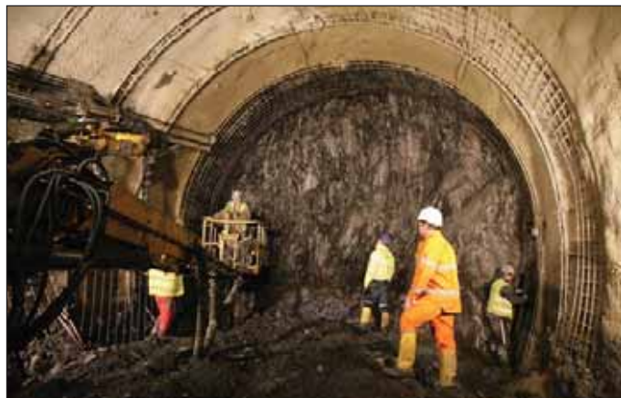
Obr. 6 Ražba přístupové štoly František do stanice Červený vrch (foto J. Husák) Fig. 6 Driving the František access tunnel to Červený vrch station (photo courtesy of J. Husák)
