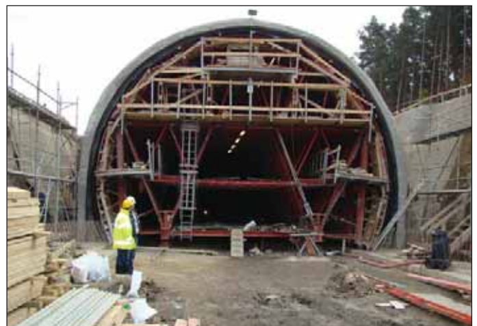
Obr. 6 Bednicí vůz pod „falešným“ primárním ostěním Fig. 6 Traveller formwork under the “false” primary lining
