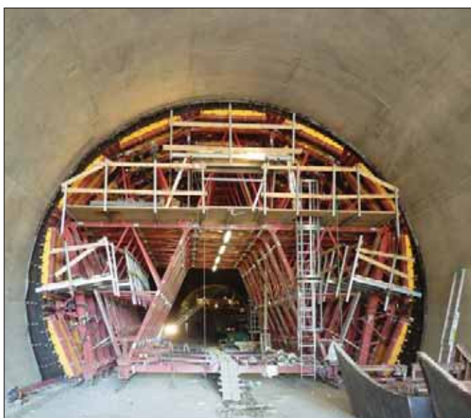
Obr. 5 Tunelová forma v pozici při přesunu Fig. 5 Tunnel formwork during transfer
