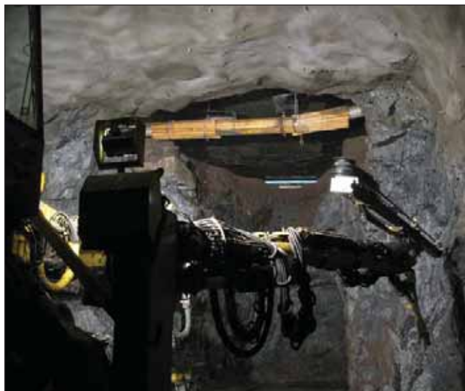
Obr. 4 Vrtanie na odstreľ pod tunelom Eugenia (Skanska Sverige AB) Fig. 4 Blasthole drilling under Eugenia tunnel (Skanska Sverige AB)
