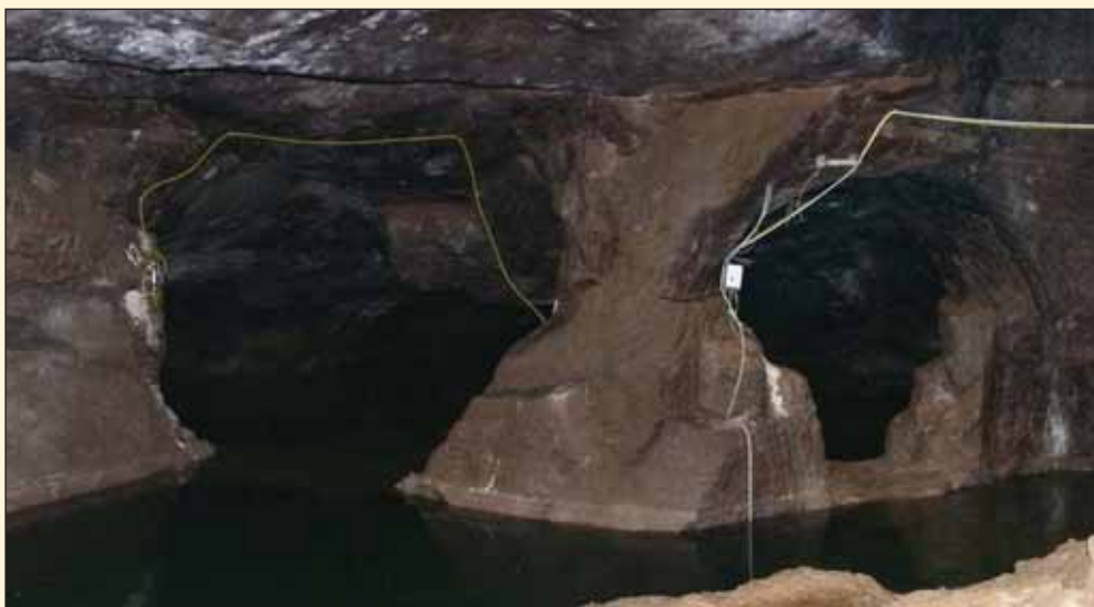
Obr. 8 Ukázka prostorového skeletu komory a pilířů nad hladinou podzemní vody – tzv. můstek Fig. 8 Illustration of a spatial skeleton of a chamber and pillars over the water table – the so-called bridge
