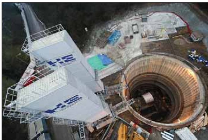
Obr. 7 Dvojice zásobníků pro dopravníkové pásy, stojících v blízkosti montážní šachty (foto Jan Tatar)
