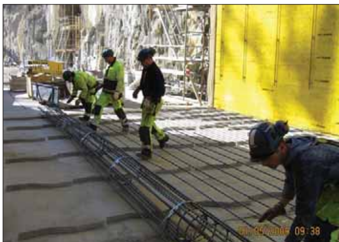
Obr. 10 Pracovníci pri rozbalňovaní rolky BAMTEC Fig. 10 Workers unrolling a BAMTEC roll
