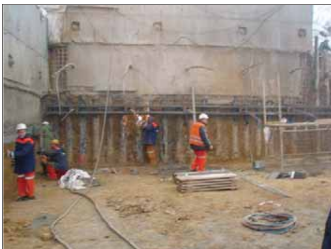
Obr. 2 Zárubná stena zo zvislých mikropilót opatrených vrstvou striekaného betónu a zaistená lanovými kotvami dĺžky 24 až 30 m Fig. 2 Retement wall made up of vertical micropiles provided with a layer of shotcrete and stabilised by 24 to 30 m long cable anchors
