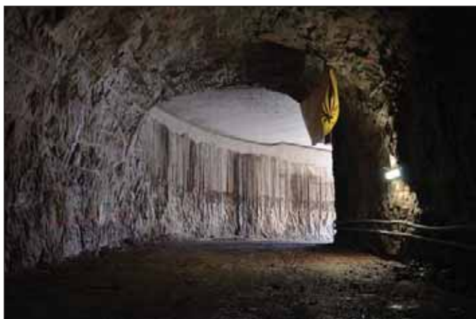
Obr. 6 Přístupový tunel Lauttasaari Fig. 6 Lauttasaari access tunnel
