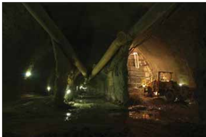
Obr. 4 Ražba a rozfázání stanice Petřiny (foto J. Junek) Fig. 4 Driving the Petřiny mined station tunnels (photo courtesy of J. Junek)
