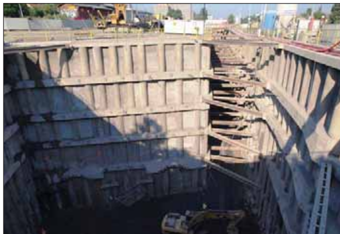
Obr. 2 Hloubení stavební jámy vč. sjízdné rampy pro ražbu stanice Veveslavín (foto J. Junek) Fig. 2 Digging the construction trench incl. the inclined ramp for construction of Veveslavín mined station (photo courtesy of J. Junek)
