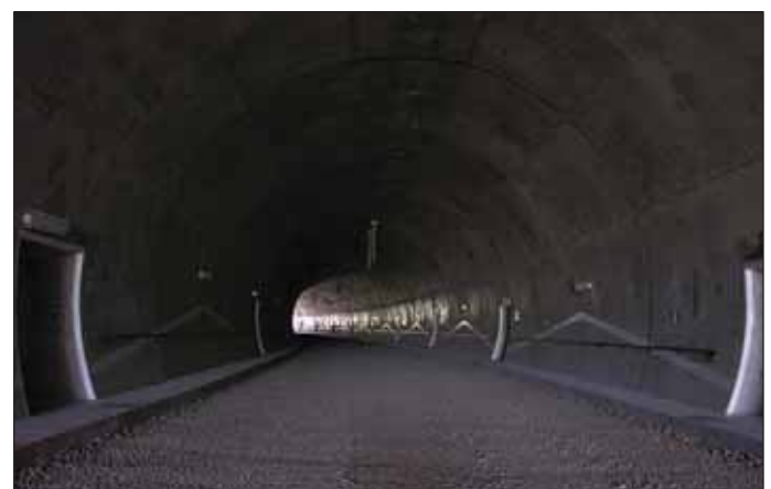
Obr. 6 Vnitřek tunelu po dokončení návozu šterkového lože Fig. 6 Tunnel interior after the completion of placing the gravel ballast
