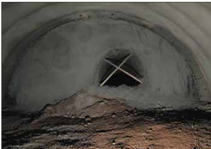
Obr. 6 Průzkumná štola tunelu Prackovice Fig. 6 Exploration gallery for the Prackovice tunnel
