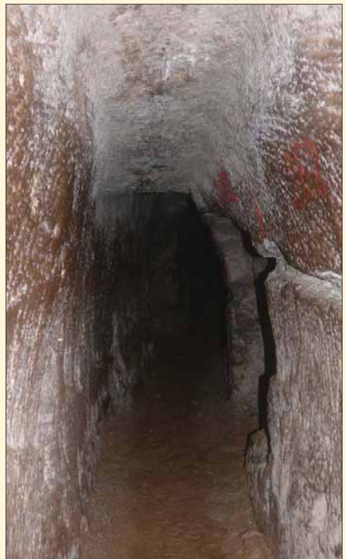
Obr. 4 Ukázka razící práce želízkem a mlátkem Fig. 4 Illustration of mining work using a drag and a holing pick
