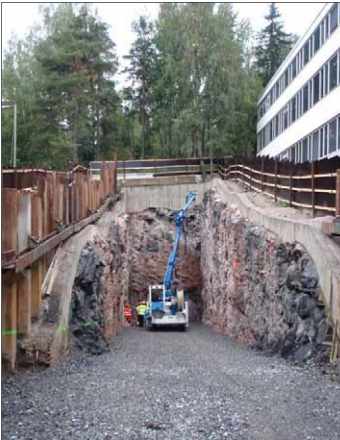
Obr. 2 Portál přístupového tunelu Myllykallio Fig. 2 Myllykallio access tunnel portal
