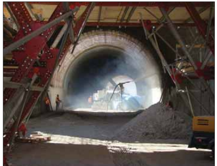
Obr. 4 Nástřik primárního ostění Fig. 4 Application of primary lining shotcrete
