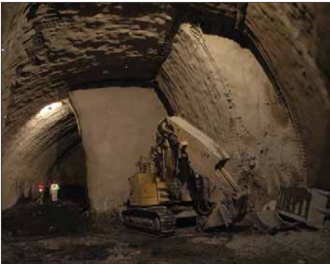
Obr. 7 Ražba stanice Červený vrch (foto J. Junek) Fig. 7 Driving Červený vrch station tunnels (photo courtesy of J. Junek)
