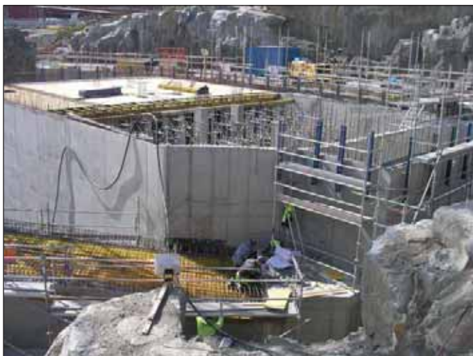
Obr. 12 Pohľad na objekt 162 Fig. 12 View of structure 162
