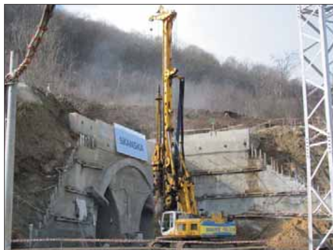
Obr. 3 Budovanie pilótovej steny Ø 1200 mm, ktorá tvorí opornú konštrukciu dolnej klenby hĺbeného úseku tunela Fig. 3 Construction of a pile wall (piles 1200 mm in diameter), forming the support for the invert of the cut-and-cover section of the tunnel
