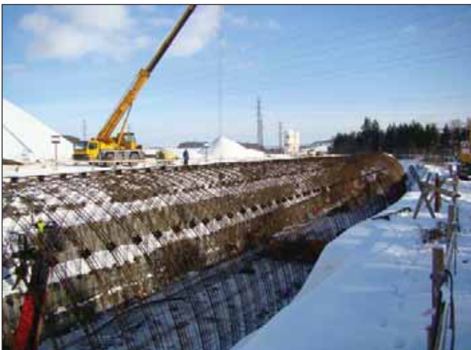
Obr. 3 Ocelové rámy samonosné výztuže „falešného“ primárního ostění Fig. 3 Steel frames forming the self-supporting reinforcement of the “false” primary lining
