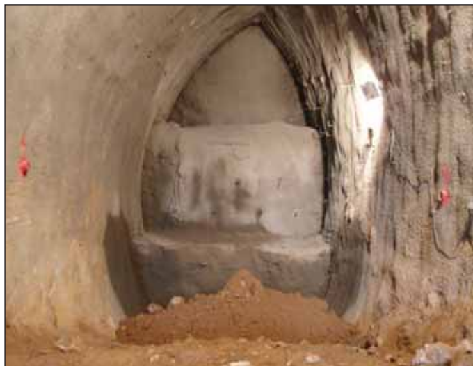
Obr. 5 Horizontálne členenie ľavého bočného výrubu
