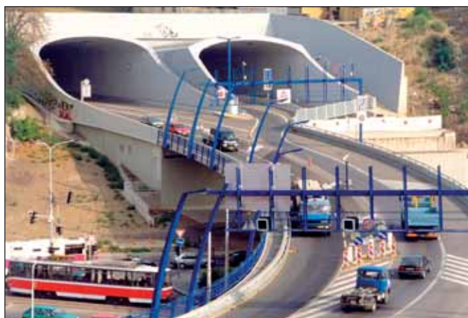
Obr. 6 Pohled na jižní portál Strahovského tunelu (projekt i průzkum PÚDIS). Foto J. Husák
