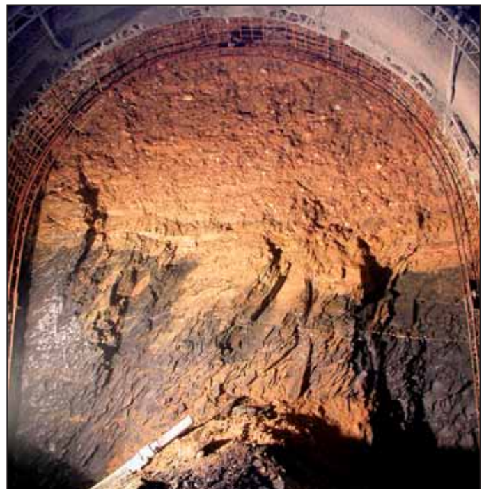
Obr. 10 Ražba pražských kolektorů Vodičkova v oblasti Václavského náměstí Fig. 10 Excavation of utility tunnels in Vodičkova Street in the Wenceslas Square area, Prague
