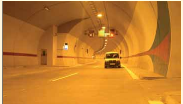
Obr. 4 Pohľad do núdzového zálivu s SOS kabínou Fig. 4 A view of the lay-by with an SOS cabin
