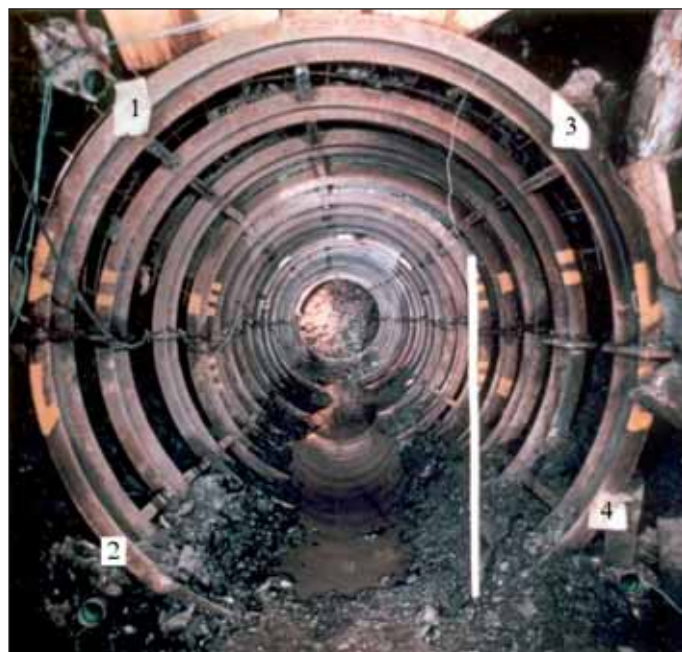
Obr. 5 Celkový pohled do pokusné odlehčovací štoly (rok 1973 – I. provozní úsek trasy A metra)
