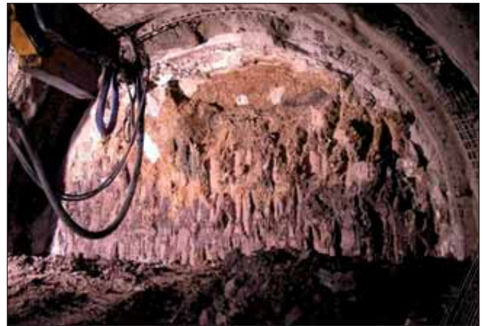
Obr. 7 Účinek tryskové injektáže v první sekci zmáhání závalu (foto P. Svoboda)
