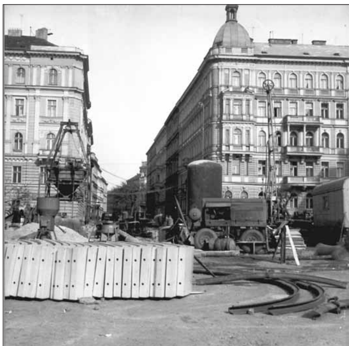
Obr. 2 Povrchová část pracoviště pokusného výrubu na Fügnerově náměstí, v popředí ocelová výztuž VKD n. p. (rok 1968 – 1. stavba I. provozního úseku trasy C metra)
