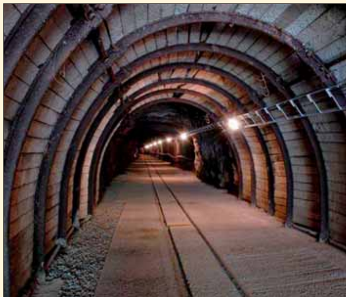
Obr. 2 Část rekonstruované páteřní štoly Fig. 2 Part of the reconstructed arterial gallery
