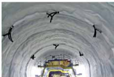
Liboucheč - dálniční tunel
