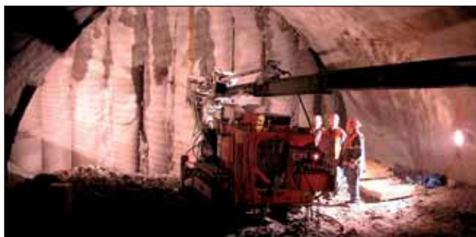
Obr. 6 Realizace jádrových vrtů do profilu tunelu z prostoru před pilotovou přepážkou (foto M. Hilar)
