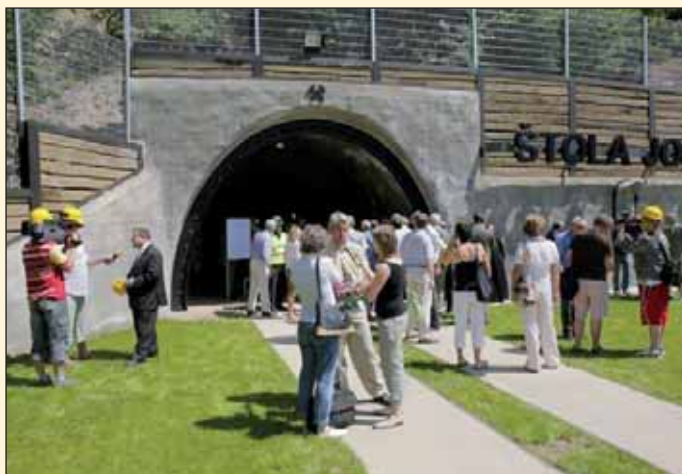
Obr. 1 Vstupní portál štoly Josef Fig. 1 The entrance portal of the Josef gallery
