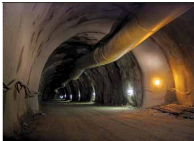
Obr. 7 Nouzový záliv v rozšíření v km 25+371 Fig.7 The lay-by in the widened section at km 25+371
