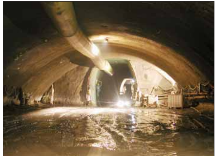
Obr. 13 Pohled do monitorované výhybny průzkumné štoly Lahovská o velikosti kaloty třípruhového tunelu Fig. 13 A view in the monitored passing area of the exploration gallery "Lahovská" with the three-lane tunnel top heading size
