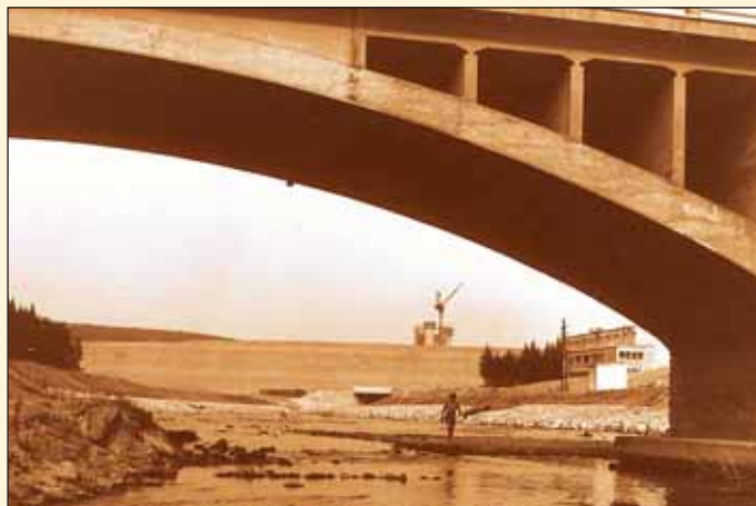
Obr. 4 Pohled stejným směrem po dosypání hráze na kótu první etapy Fig. 4 A view in the same direction, after the completion of the 1 st stage of the embankment
