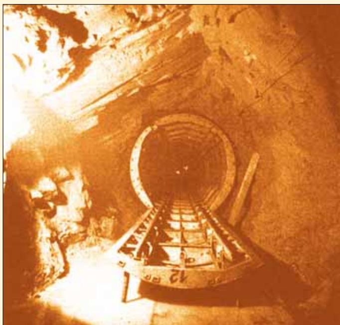
Obr. 6 Lože pro montáž soupravy CIFA k betonáži štolového přivaděče Fig. 6 The bed for the assembly of a CIFA formwork set for casting of the aqueduct tunnel lining
