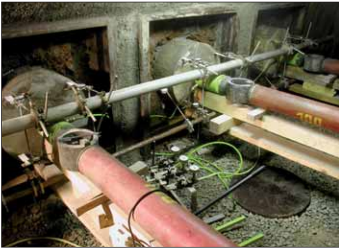
Obr. 9 Aparatury pro dlouhodobé zatěžovací zkoušky deskou ověřující reologické přetváření a bobtnání (rok 2005 – D8 průzkumná štola pro tunel Prackovice)
