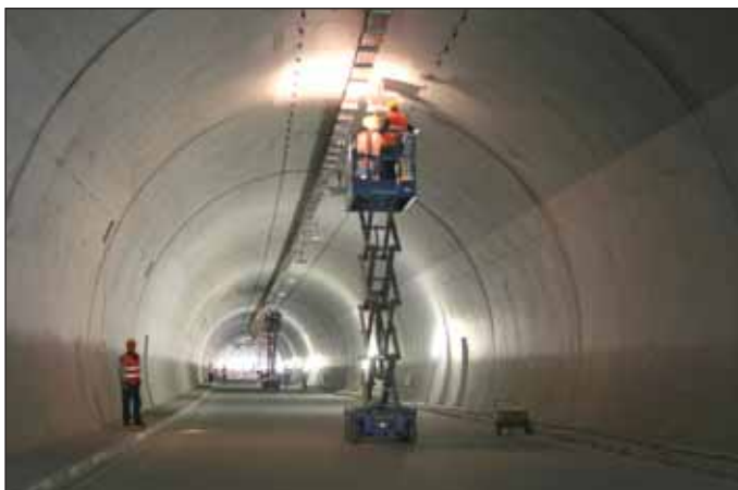
Obr. 1 Instalace technologického vybavení v tunelu Sitina Fig. 1 Installation of technical equipment in the Sitina tunnel
