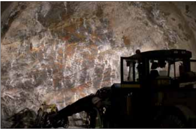
Obr. 5 Příprava na vrtání Fig. 5 Preparation for the drilling
