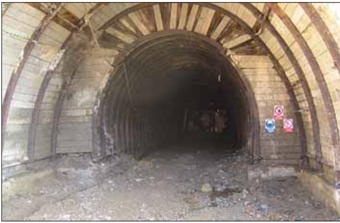
Obr. 9 Portál štoly po otevření v září 2006
