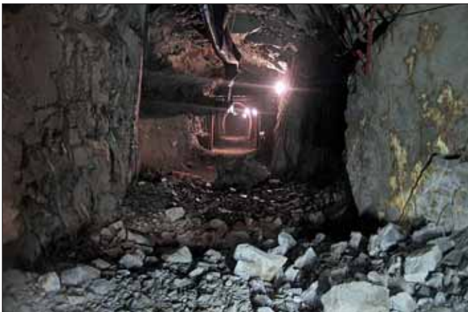
Obr. 6 Flexibilní lutny v překopu SCH-Z/SP 11 Fig. 6 Flexible pipes in the cross-cut SCH-Z/SP 11
