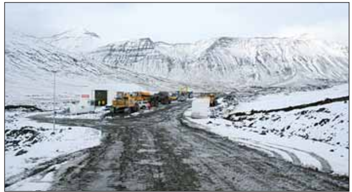
Obr. 3 Zařízení staveniště Siglufjörður Fig. 3 Site Arrangements in Siglufjörður
