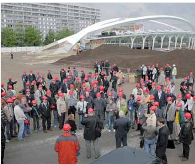
Obr. 31 Nejvíce navštívenou exkurzí byla návštěva stavby prodloužení trasy C pražského metra z Ládví do Letňan Fig. 31 The most attended excursion was the visit to the extension of Line C of the Prague metro from Ládví to Letňany
