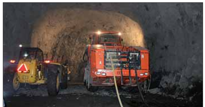
Obr. 5 Vrtací vůz na čelbě tunelu Fig. 5 Drill Rig at the Tunnel Face
