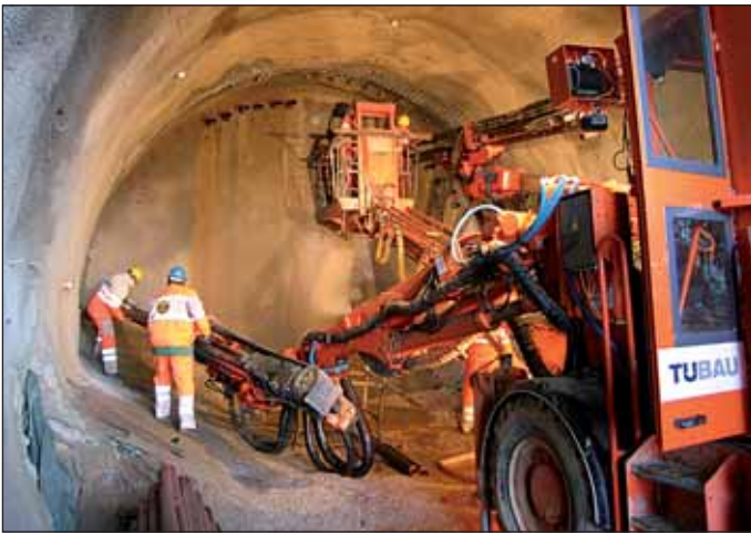
Obr. 4 Vrtanie mikropilotového dáždnika v tuneli Fig. 4 Drilling for the canopy tube pre-support in the tunnel
