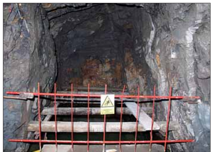
Obr. 4 Usazovací jámka ve štolě Fig. 4 Sump in the gallery
