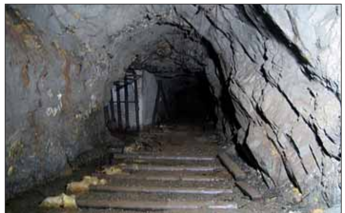
Obr. 2 Odbočení k akumulátorovně, původní stav po otevření štoly Fig. 2 Turning to battery charging station, original situation after gallery opening
