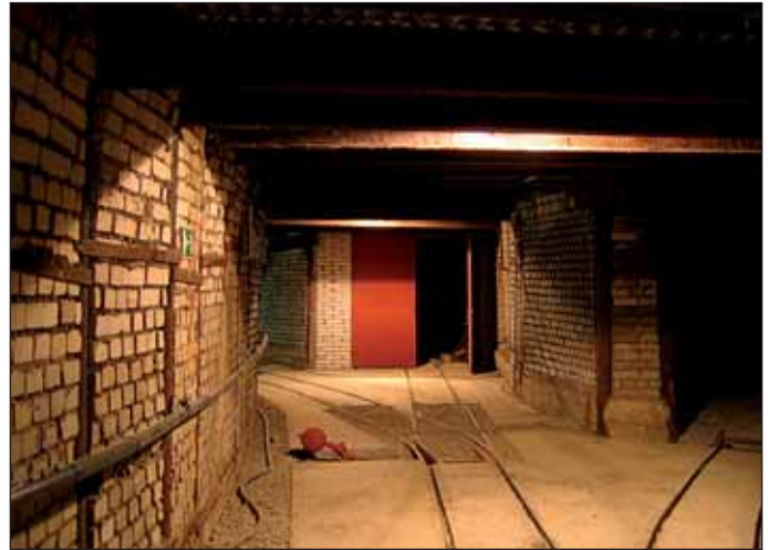
Obr. 7 Větrná vrata na překopu Fig. 7 Air-lock door of the cross-cut
