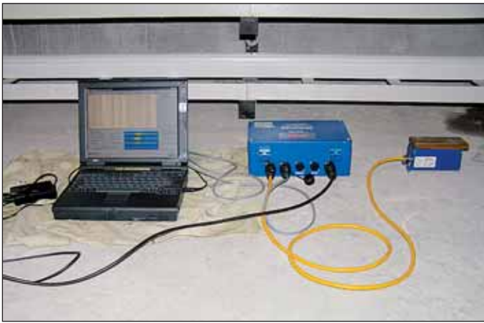
Obr. 6 Aparatura GeoSIG GCR-16 s rychlostním senzorem při měření v kolektoru Centrum v Ostravě
