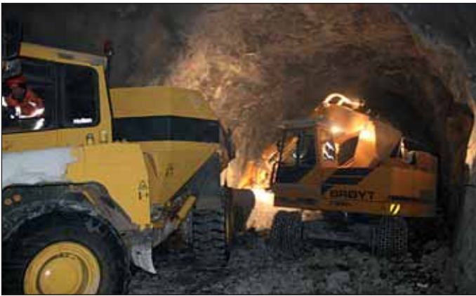
Obr. 7 Injektážní souprava v tunelu Fig. 7 Grouting Unit in the Tunnel
