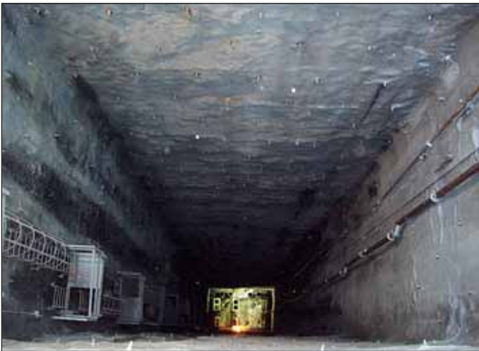
Obr. 5 Šachta pre hradidlové vráta po vyrazení Fig. 5 The power intake gate shaft sinking completed
