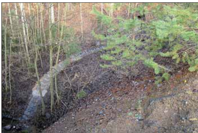
Obr. 5 Zaústění odvodnění do potoka Fig. 5 Outlet of the drainage system
