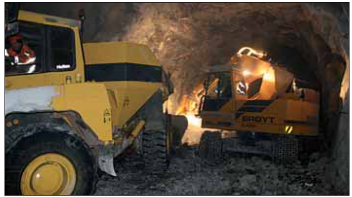
Obr. 6 Bagr Broyt při nakládání v tunelu Fig. 6 Broyt Loader in Action
