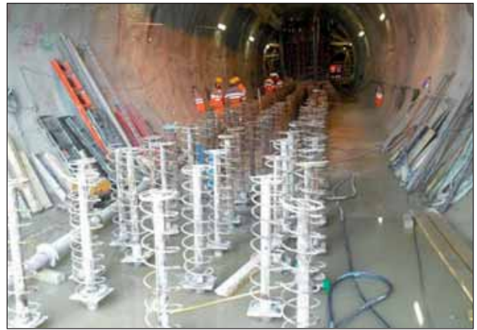
Obr. 7 Železobetónový pilier je založený na mikropilotách s hlavicami Fig. 7 The reinforced concrete pillar is founded on micropiles with heads
