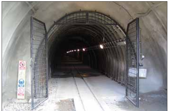
Obr. 10 Portál štoly po osazení mřížových vrat v únoru 2007
