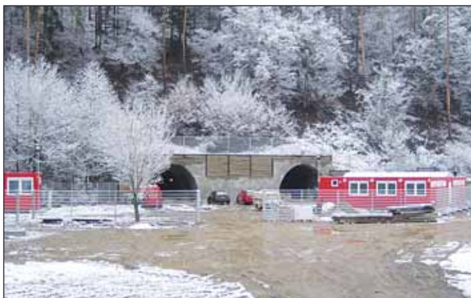
Obr. 1 Pohled na portály v únoru 2007 Fig. 1 View of the portals in February 2007
