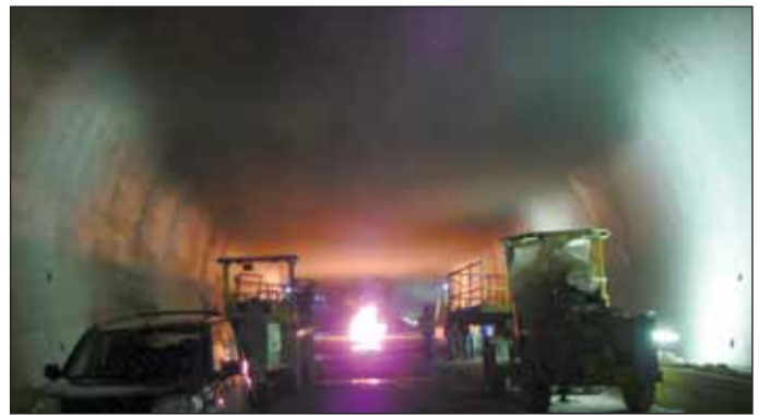
Obr. 2 Stratifikovaná vrstva kouře při požární zkoušce v tunelu Klimkovice Fig. 2 The stratified smoke layer at the fire testing in the Klimkovice tunnel
