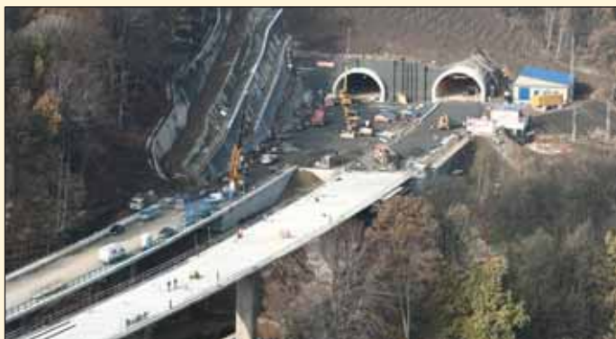
Obr. 1 Pohled na jižní portál tunelu Libouchec Fig. 1 A view of the southern portal of the Libouchec tunnel
