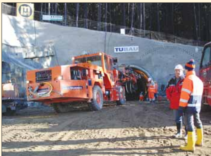
Obr. 2 Práce na západnom portáli tunela Bôrik Fig. 2 The west portal of the Bôrik tunnel
