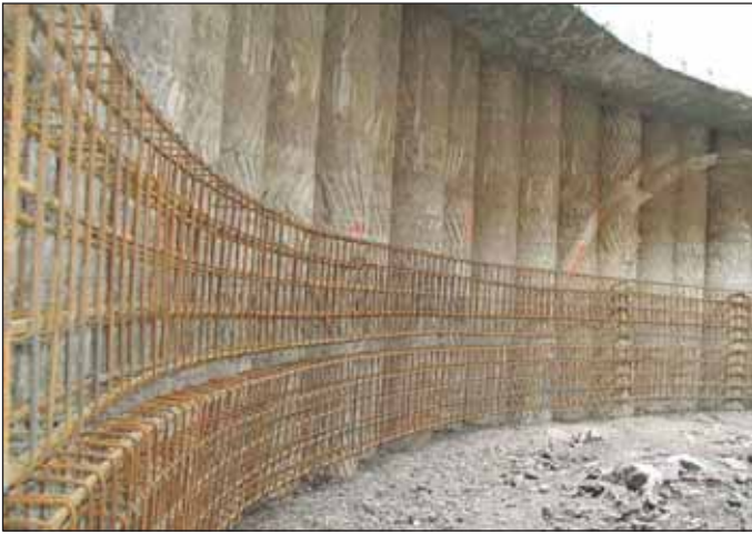
Foto 3 Počátek zřizování ztužujících prstenců 3 m pod převázkou 3 Photo 3 Reinforcing rings below Ring Beam 3
