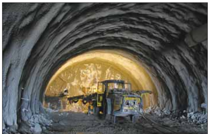
Obr. 2 Ražba kaloty od jižního portálu – 4/2005 Fig. 2 Top heading drive from the southern portal – 04/2005
