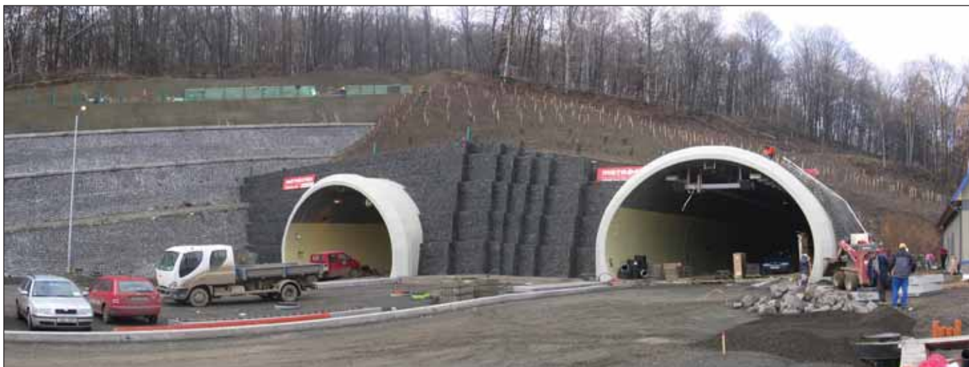
Obr. 10 Celkový pohled na jižní portál před dokončením Fig. 10 Overall view of the southern portal before completion
