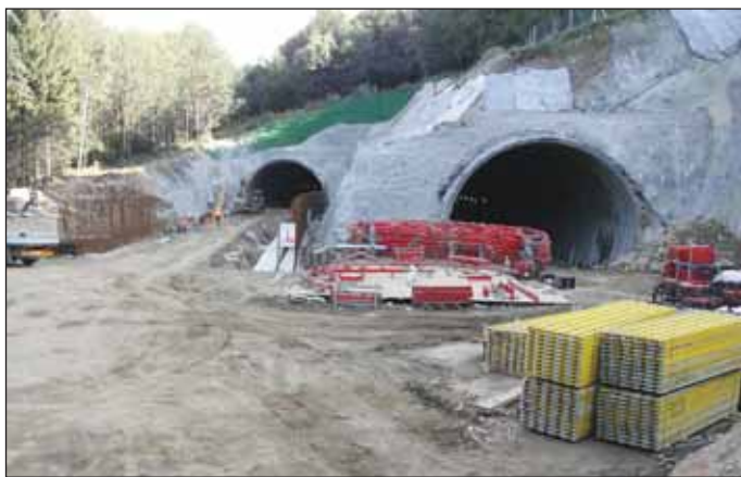
Obr. 3 Betonáž základových pasů hloubených tunelů – severní portál 09/2005 Fig. 3 Casting of the cut-and-cover tunnel strip foundation – northern portal 09/2005
