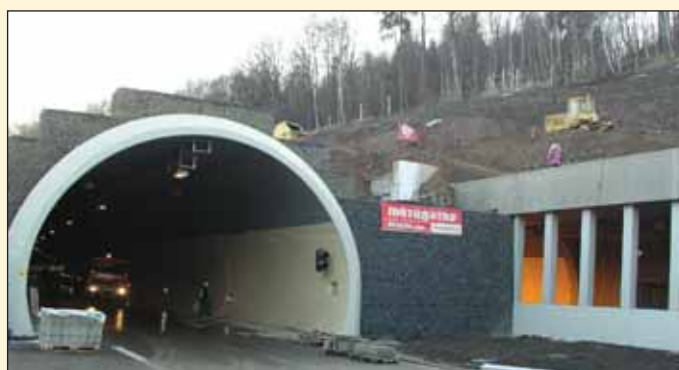
Obr. 4 Terénní úpravy u severního portálu tunelu Libouchec Fig. 4 Terrain finishes at the northern portal of the Libouchec tunnel
