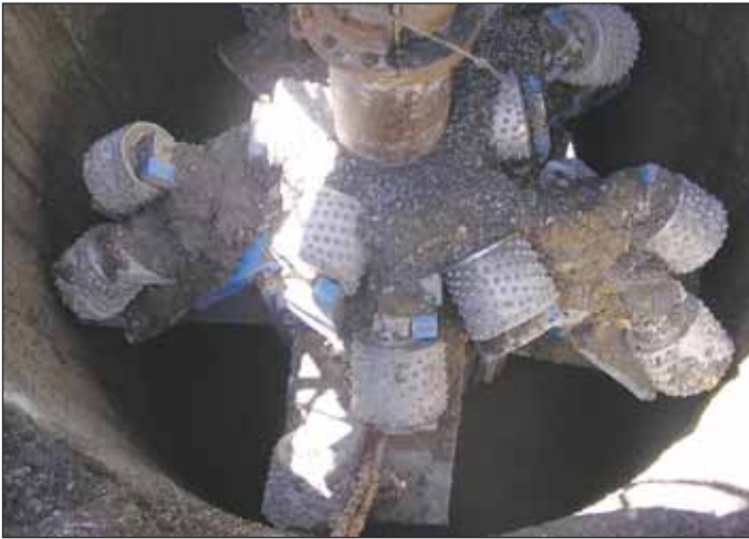
Obr. 2 Hlava stroje po dokončení rozšíření Fig. 2 The back-reaming head after the reaming completion
