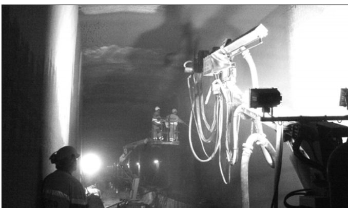
Obr. 5 Aplikace stříkané protipožární malty pomocí automatických robotů Fig. 5 Robotic application of spray applied fire protection mortar
