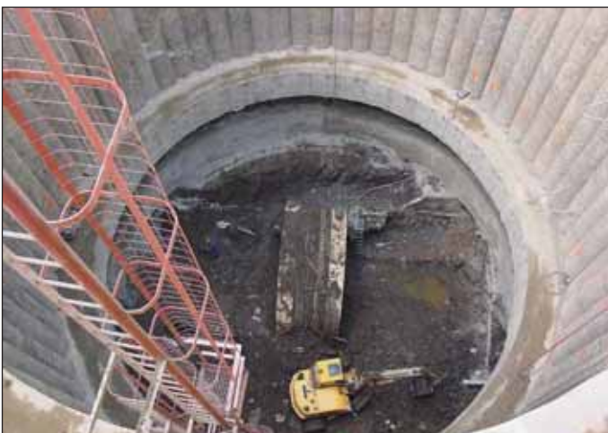
Foto 4 Hloubení šachty v oblasti zavaleného stroje Perforex Photo 4 Excavation in the vicinity of the buried Perforex machine
