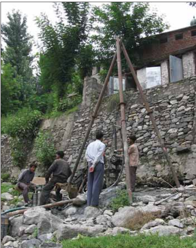
Obr. 3 Vrtání průzkumného vrtu u města Ramban Fig. 3 Exploratory borehole drilling by the Ramban town
