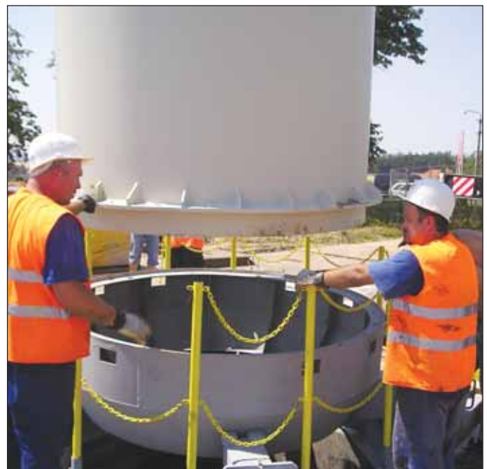
Obr. 3 Naváděcí prstenec na popouštěcí stolici Fig. 3 The guide ring on the lowering stand
