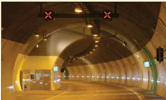
Obr. 5 Nouzový zářív v tunelu Panenská Fig. 5 An emergency stand-by in the Panenská tunnel
