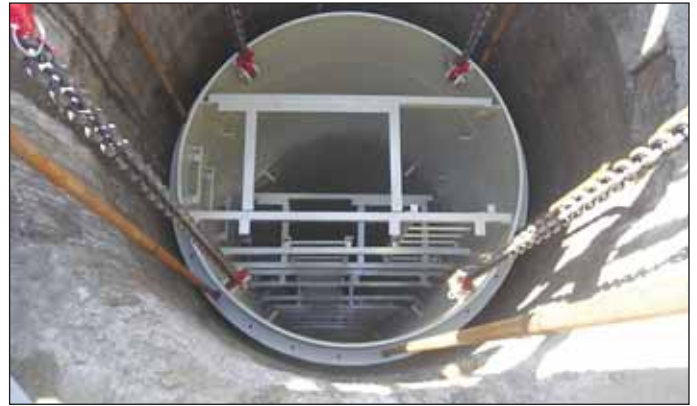
Obr. 5 Výškové usazení na řetězových závěsech Fig. 5 The pipe on suspension chains
