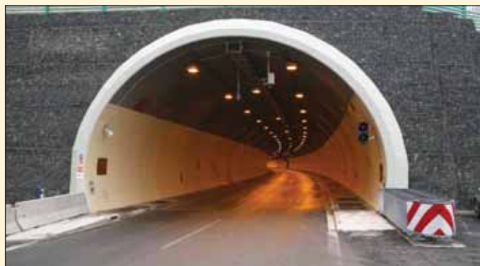
Obr. 2 Jižní portál tunelu Libouchec Fig. 2 The southern portal of the Libouchec tunnel
