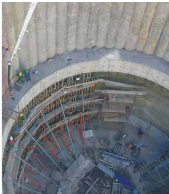
Foto 5 Betonáž ztužující stěny B samohutnícím betonem Photo 5 Casting of wall B by self-compacted concrete mix
