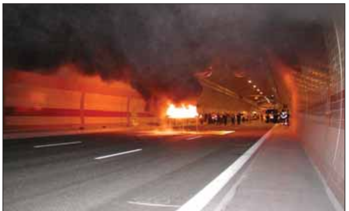
Obr. 5 Zkouška horkým kouřem (ražený třípruh) Fig. 5 The hot smoke test (the mined three-lane tunnel)
