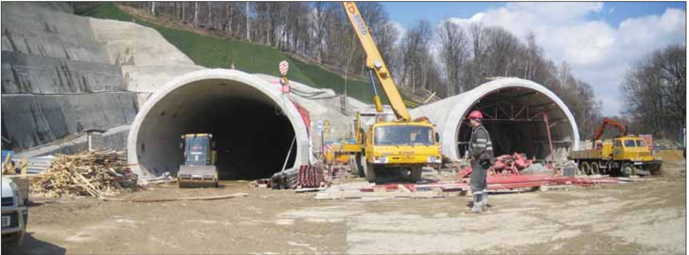
Obr. 4 Hloubené tunely na jižním portále Fig. 4 Cut-and-cover tunnels at the southern portal
