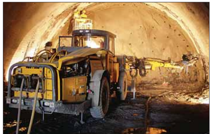
Obr. 4 Vrtání kaloty STT Fig. 4 NTT top heading drilling
