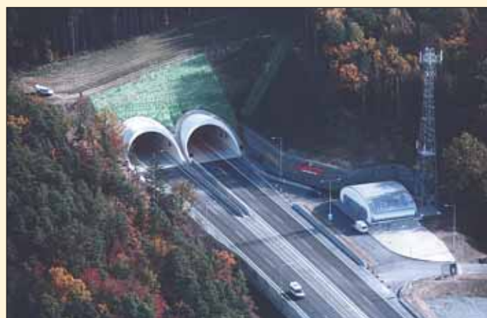
Obr. 8 Letecký pohled na rozvadovský portál po uvedení tunelu Valík do provozu Fig. 8 An aerial view of the Rozvadov portal after the Valík tunnel opening to traffic
