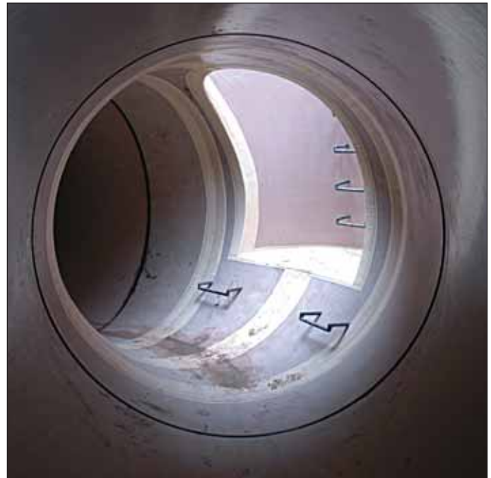
Obr. 5 Pohled na část hotového díla Fig. 5 A view of a part of the complete work
