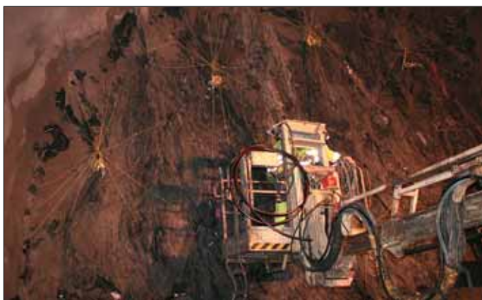
Obr. 4 Čelba cestného tunela a zapojenie rozvetnenej siete neelektrického systému NONEL
