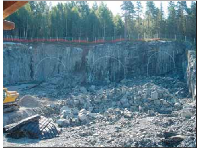
Obr. 2 Severný portál s tunelmi B, A, R pred začiatkom razenia
