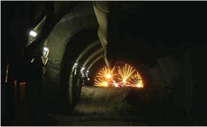
Obr. 5 Provedení odstřelu pomocí neelektrického roznětu Fig. 5 The non-electric shot firing system
