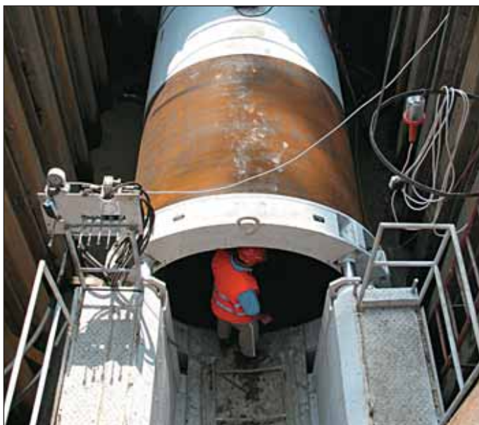
Obr. 1 Tlačná stanice na dně stavební jámy Fig. 1 The jacking station
