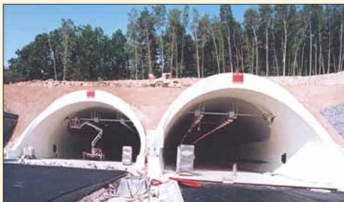
Obr. 1 Dokončovací práce u pražského portálu Fig. 1 Finishing work at the Prague portal
