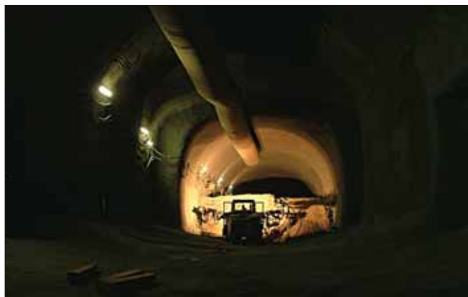
Obr. 3 Práce na levém opěří JTT Fig. 3 Work in the left side-wall area
