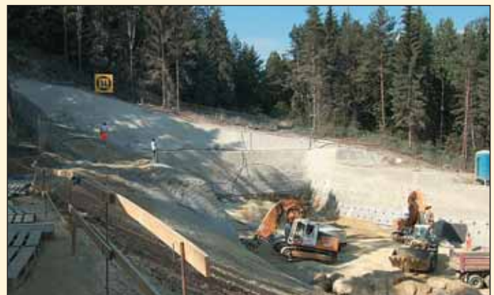
Obr. 2 Práce na východnom portáli tunela Bôrik Fig. 2 The work on the eastern portal of the Bôrik tunnel
