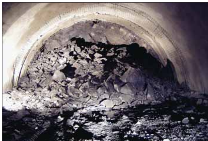
Obr. 7 Kalota po odpalu Fig. 7 Top heading after a blast
