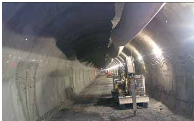
Obr. 4 Pohled do vyražené JTT před rozrážkou tunelové propojky Fig. 4 A view down the excavated STT before the commencement of the cross passage excavation
