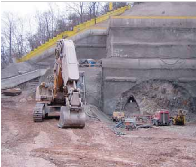
Obr. 1 Západní portál JTT včetně průzkumné štol Fig. 1 The western portal of the NTT, including exploration gallery
