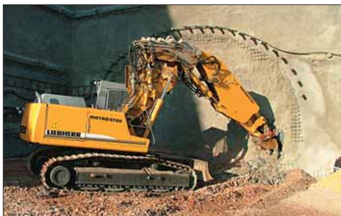
Obr. 1 Rozrážka jižní tunelové trouby (JTT) vítkovského tunelu Nového spojení Fig. 1 Excavation of the Southern Tunnel Tube (STT) of the Vítkov tunnel of the New Connection project
