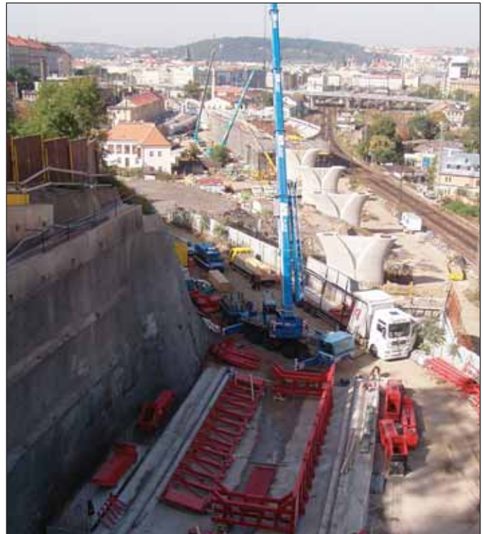
Obr. 8 Montáž bednicího vozu před západním portálem
