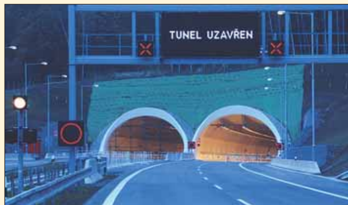
Obr. 2 Rozvadovský portál před otevřením tunelu Fig. 2 The Rozvadov portal before the tunnel inauguration
