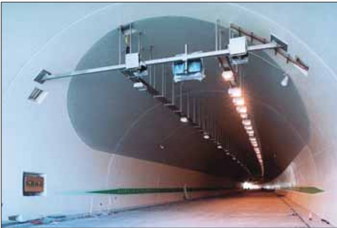
Obr. 3 Pohled na dokončené definitivní ostění tunelu Fig. 3 A view of the completed final lining
