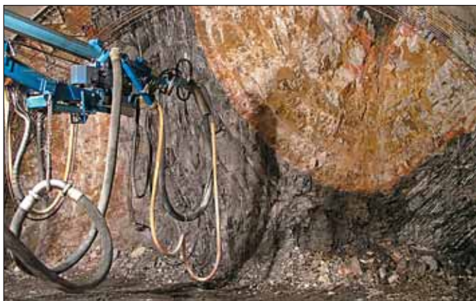
Obr. 2 Záběrový krok v kalotě JTT před nanášením stříkaného betonu Fig. 2 An excavation cycle in the STT top heading before application of shotcrete
