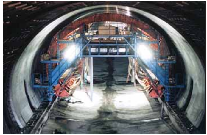
Obr. 2 Bednicí vůz po odbednění bloku
