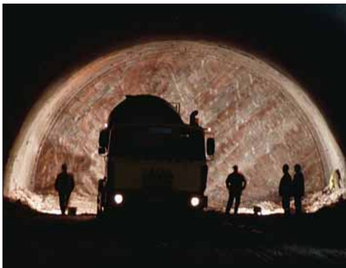
Obr. 6 Kalota STT z východu Fig. 6 NTT top heading from the west
