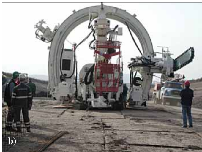
Obr. 16 Tunel Břežno a) portál; b) vrubovací stroj při zahájení ražby Fig. 16 The Břežno tunnel a) the portal; b) the pre-cutting machine at the beginning of the excavation
