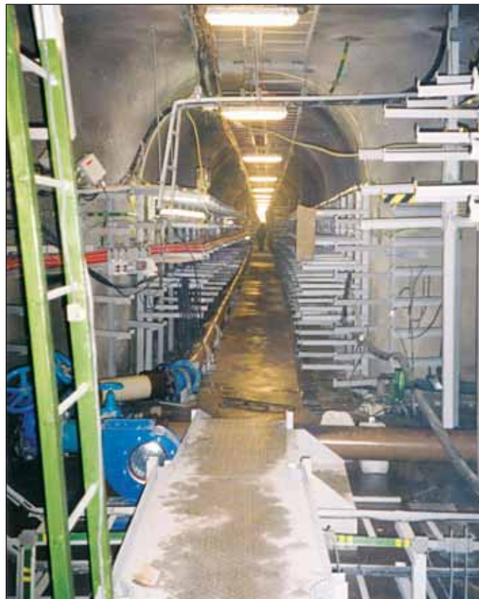
Obr. 5 Fotografie z realizace kolektoru Na Příkopech – definitivní stav Fig. 5 A picture from the work on the Na Příkopech utility subway – final state
