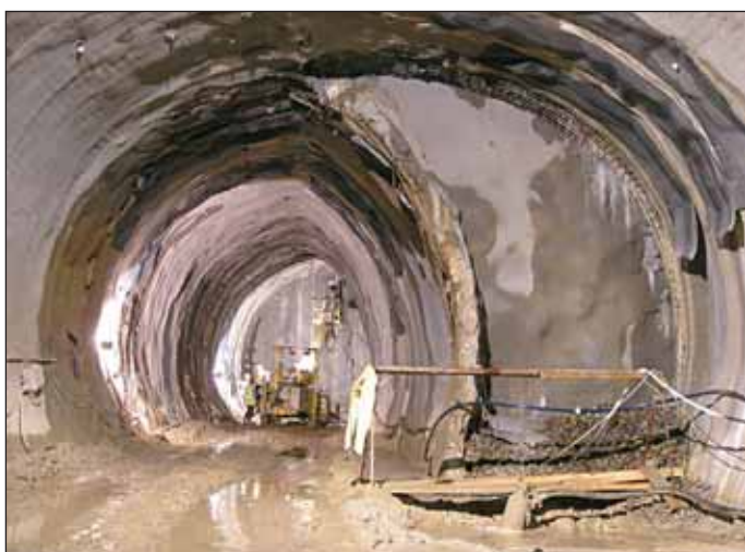
Obr. 4 Tunel s vertikálním členěním výrubu Fig. 4 The tunnel with the vertical excavation sequence
