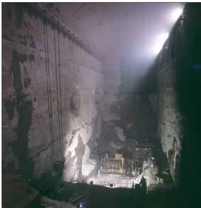
Obr. 2 Kaverna pro elektrárnu – plný výlom Fig. 2 The fully excavated cavern
