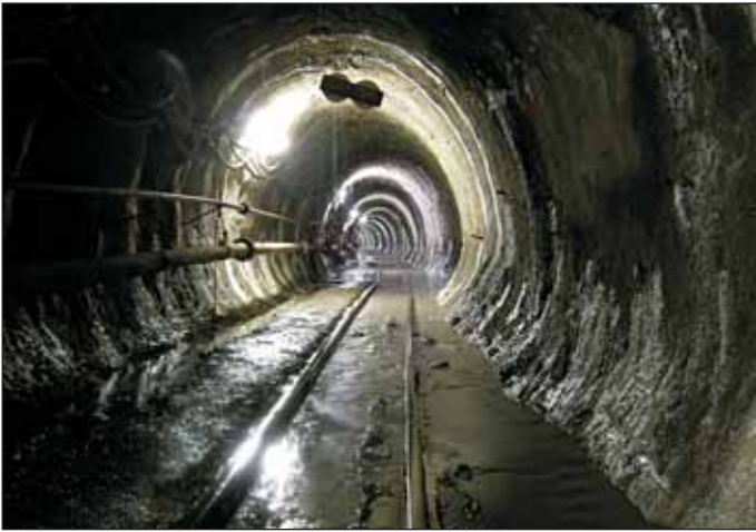
Obr. 4 Fotografie z realizace průzkumné štoly Fig. 4 Execution of the exploration gallery
