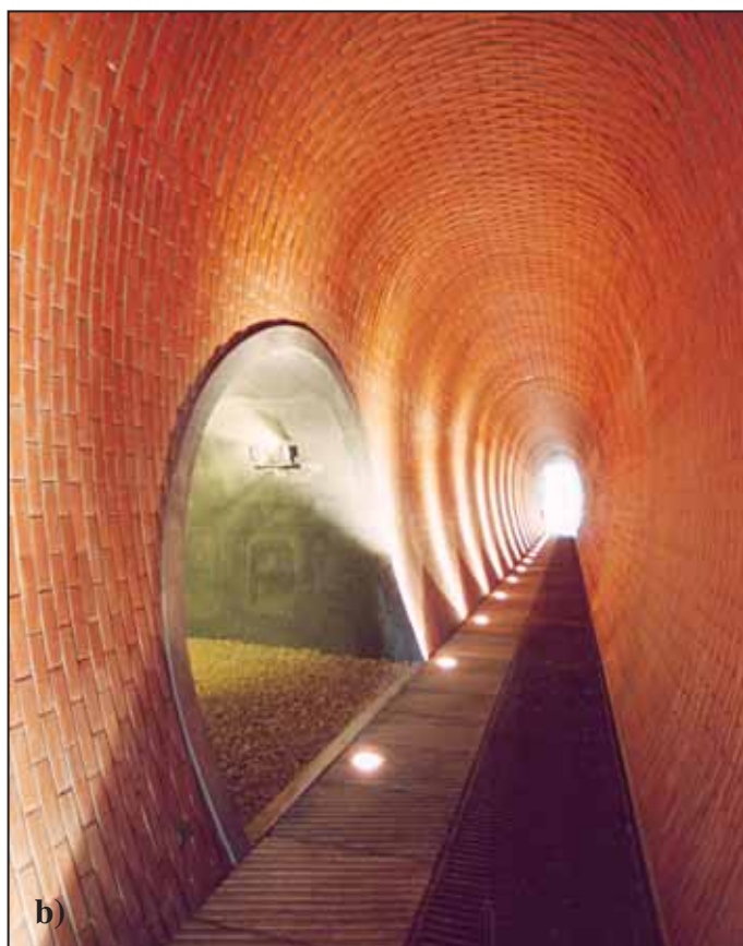
Obr. 21 Tunel pro pěší na Pražském hradě a) ražba plného profilu; b) cihelná obezdívka po dokončení Fig. 21 The pedestrian tunnel at Prague Castle a) the full-face excavation; b) the brick lining after completion
