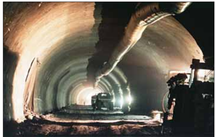
Obr. 6 Střední část východní tunelové trouby Fig. 6 Central part of eastern tunnel tube
