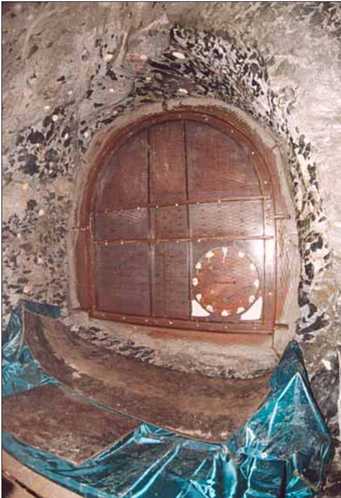
Obr. 27 Uzavírací pancíř tlakové zátky podzemního zásobníku plynu před nástříkem drátkobetonu
