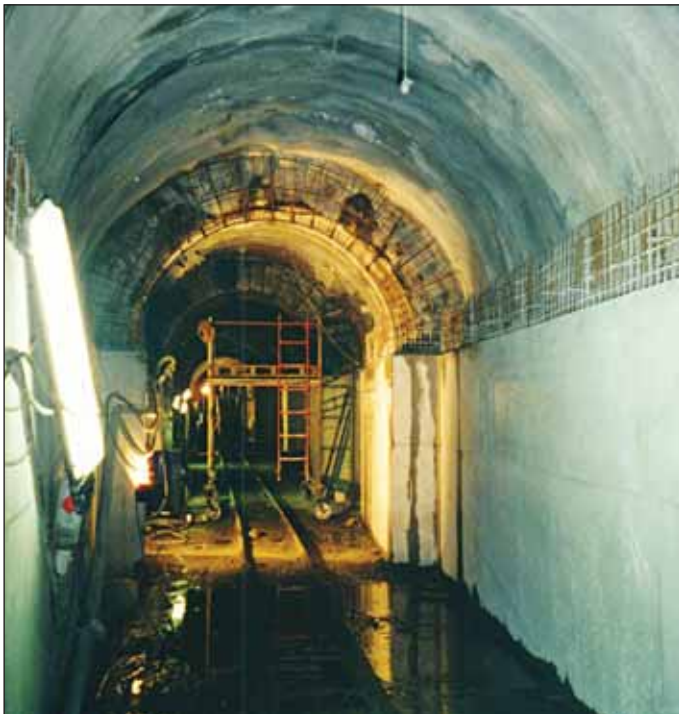
Obr. 3 Fotografie z realizace kolektoru Na Příkopech – výstavba Fig. 3 A picture from the work on the Na Příkopech utility subway – construction
