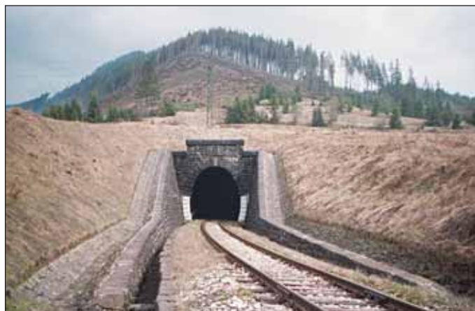
Obr. 4 Telgártsky tunel Fig. 4 The Telgárt Tunnel
