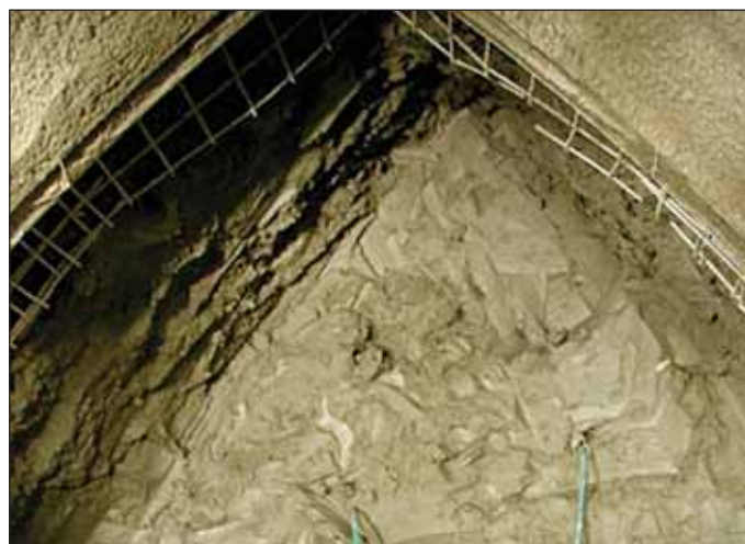
Obr. 3 Čelba průzkumné štoly
