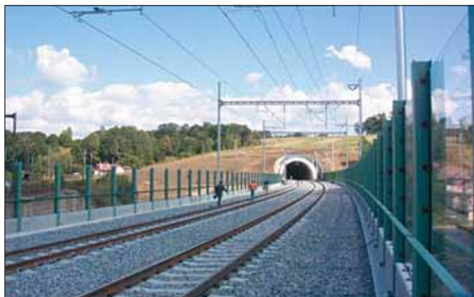
Obr. 2 Tunel Krasíkov – vjezdový portál
