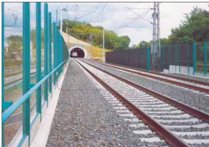
Obr. 15 Tunel Vepřek Fig. 15 The Vepřek tunnel
