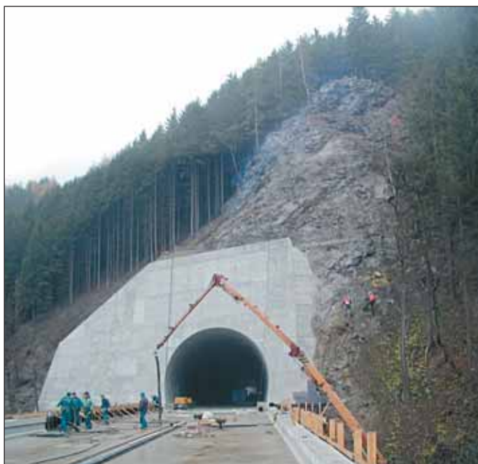
Obr. 5 Tunel Hněvkov II – vjezdový portál ve skalní stěně Fig. 5 The Hněvkov II tunnel entrance portal in the rock wall
