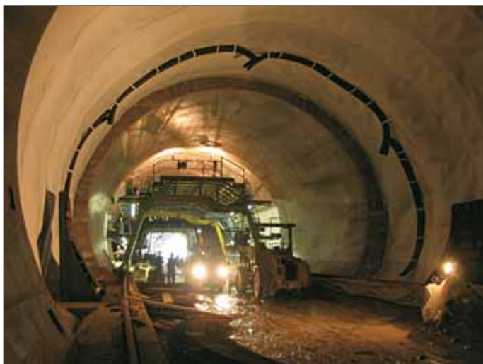
Obr. 3 Šachovnicová betonáž definitivního ostění Fig. 3 Staggered pattern of the final liner casting
