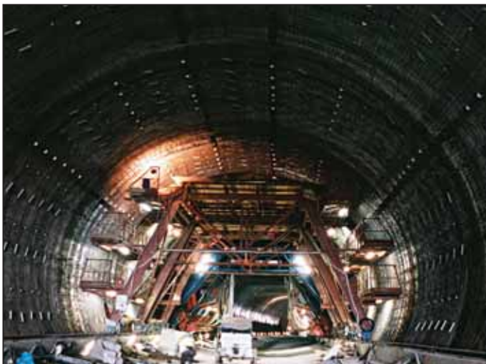
Obr. 4 Montáž výztuže definitivního ostění
