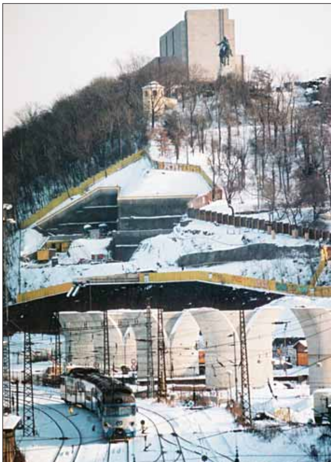
Obr. 5 Pohled na západní portálovou jámu. V popředí pilíře čtyřkolejné železniční estádky, nad portálem památník na hoře Vítkov s jezdeckou sochou Jana Žižky z Trocnova
