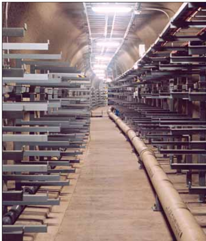
Obr. 25 Brněnské kolektory – konečný stav Fig. 25 Brno utility tunnels – final state
