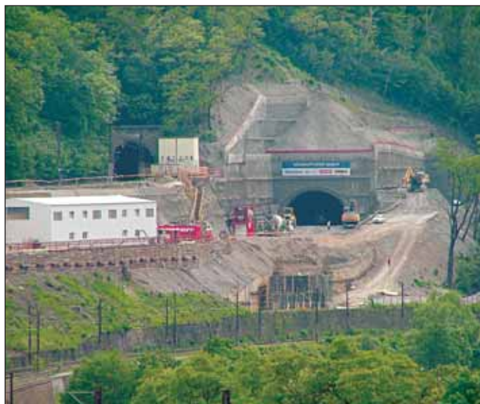
Obr. 3 Stavební jáma východních portálů Fig. 3 The construction trench at the eastern portals
