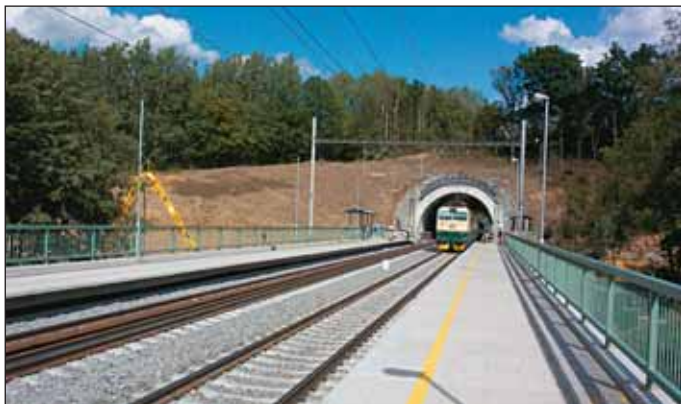
Obr. 3 Železniční zastávka na mostě s portálem Tatenického tunelu Fig. 3 The intermediate station on the bridge before the Tatenice tunnel portal
