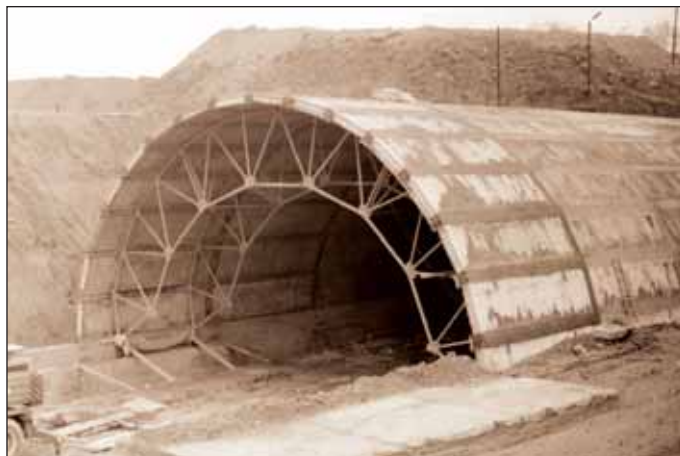
Obr. 14 Tunelové ostění systému BEBO Fig. 14 The BEBO system tunnel lining
