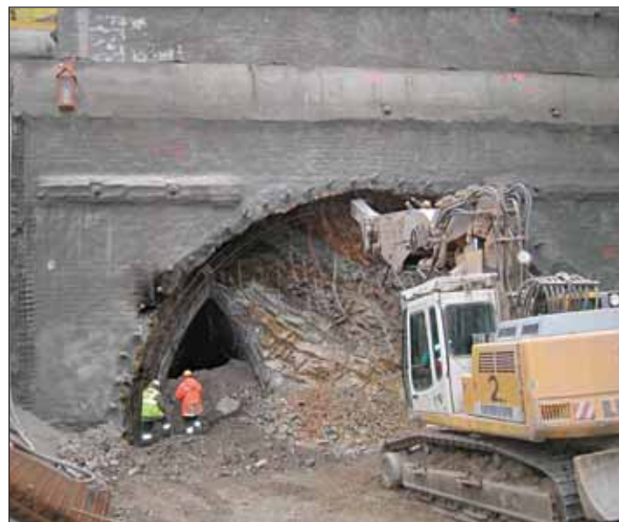
Obr. 4 Západní ražený portál jižního tunelu Fig. 4 The mined west portal of the southern tunnel
