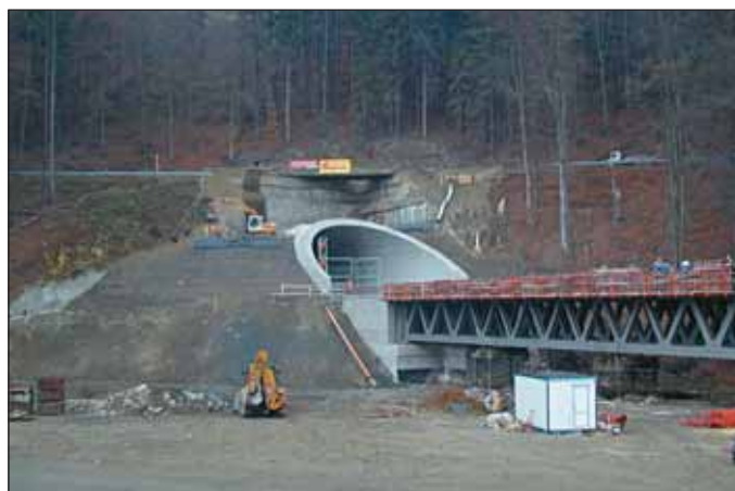
Obr. 6 Tunel Hněvkov II – výjezdový portál Fig. 6 The Hněvkov II tunnel exit portal
