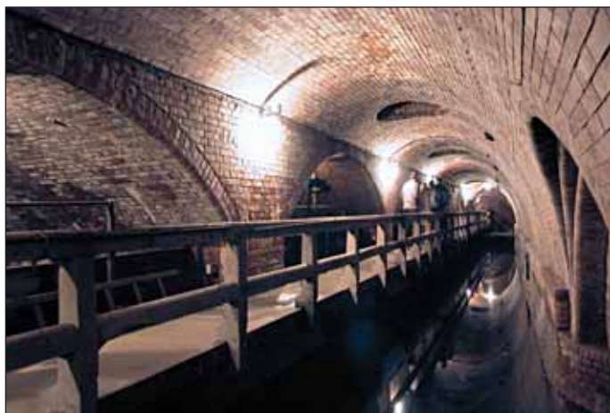
Obr. 7 Podzemí první pražské čistírny odpadních vod Fig. 7 The underground space of the first sewage treatment plant in Prague
