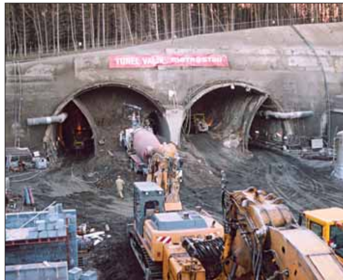
Obr. 3 Západní portál v průběhu ražeb Fig. 3 The west portal during the excavation operations
