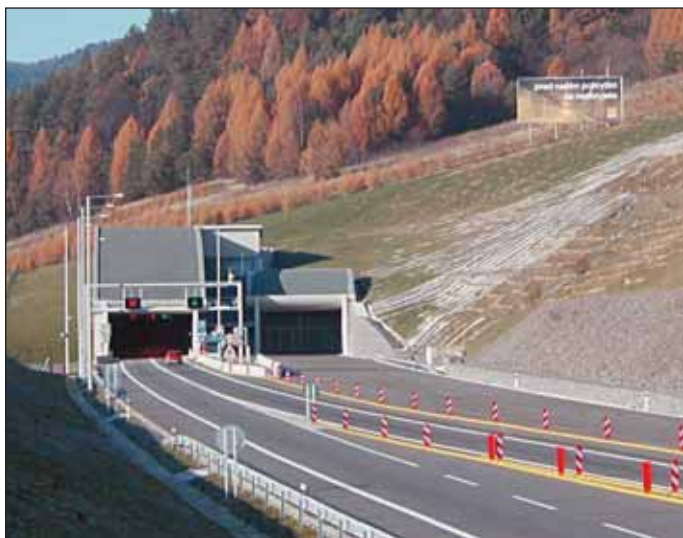
Obr. 6 Východný portál tunela Branisko
