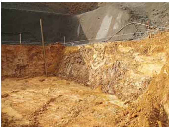
Obr. 1 Jižní portál východního tunelu – zóna zvětrání zasahuje až do úrovně kaloty Fig. 1 The South Portal of the Eastern Tunnel Tube – the zone of weathering extending to the top heading level
