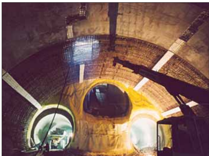
Obr. 23 Jednolodní stanice „Kobylisy“ na prodloužení trasy „C“ metra Fig. 23 The single-vault station “Kobylisy” on the Line “C” extension
