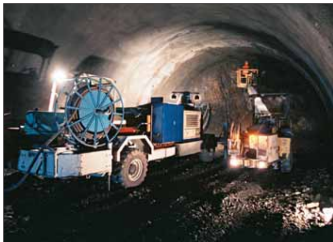
Obr. 6 Záběr z ražby kaloty Fig. 6 Top heading excavation
