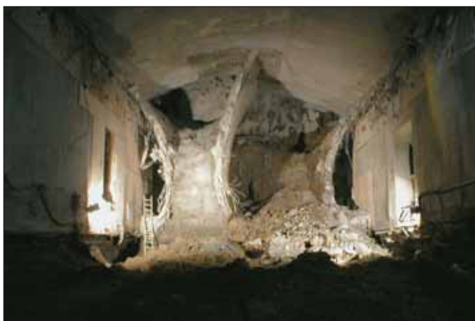
Obr. 8 Dortmund – zložitosť postupu prác dokazuje aj horizontálne a vertikálne členenie čelby
