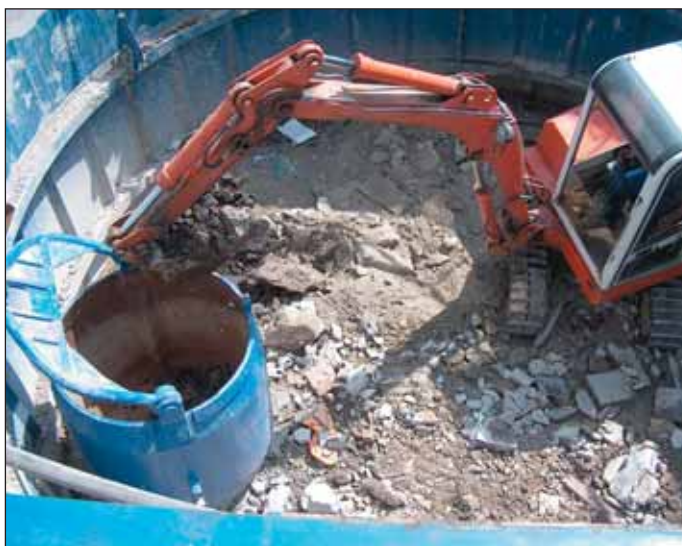
Obr. 4 Nakladač při hloubení šachty Fig. 4 Loader during shaft excavation
