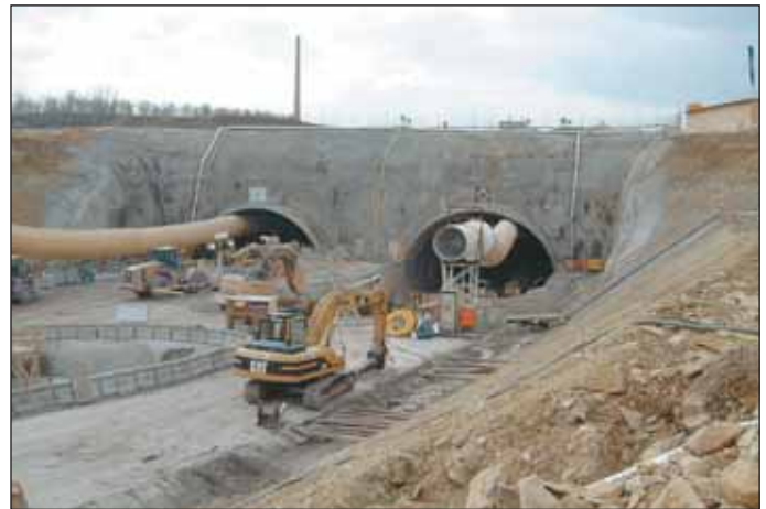
Obr. 2 Západný portál tunela Dölzschena Fig. 2 Portal West of the Dölzschena tunnel
