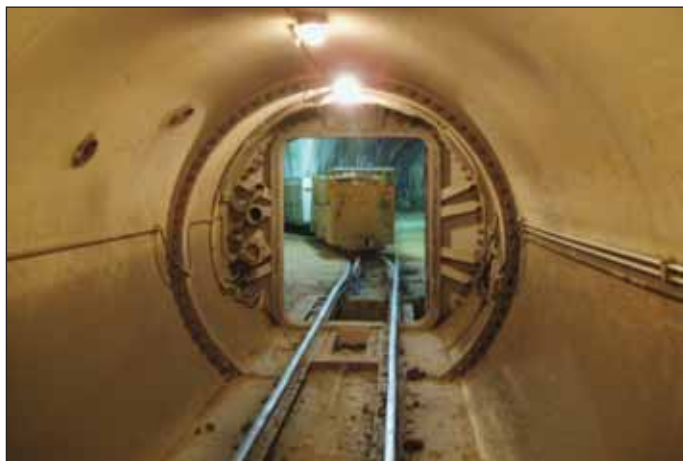
Obr. 1 Materiálová komora Fig. 1 Material chamber
