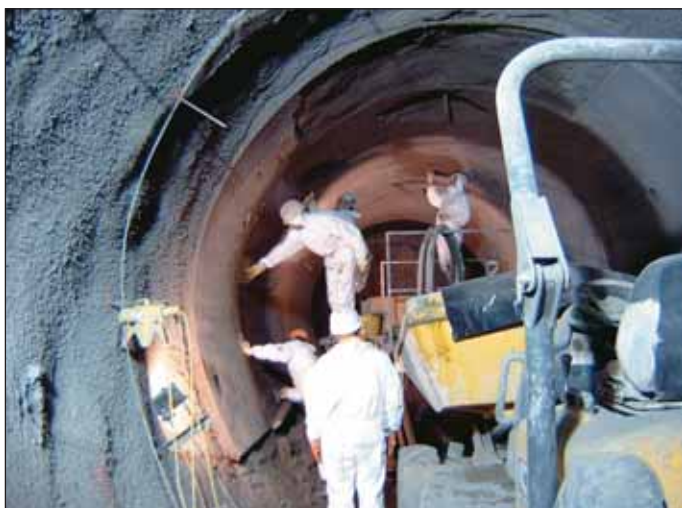
Obr. 5 Ruční upravování dokončující vrstvy Fig. 5 Hand trowelling off the finishing layer
