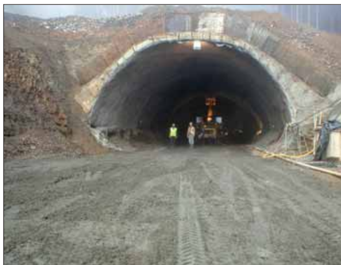
Obr. 5 Pohled do kaloty u výjezdového portálu
