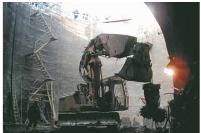
Obr. 3 Dortmund – tunelbáger Liebherr 934 v štartovacej jame Fig. 3 Dortmund – Liebherr 934 tunnel excavator in the starting shaft
