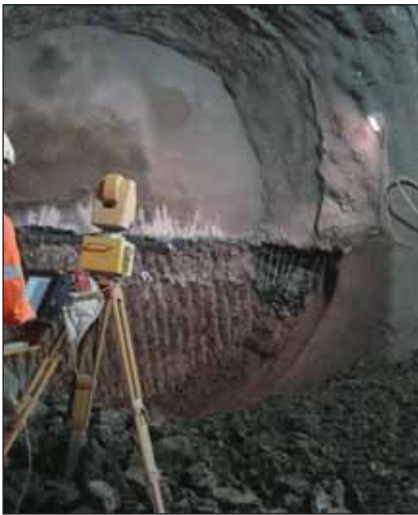
Obr. 14 Inženýr směny používá TunnelBeamer™ pro zaznamenání tvaru výrubu Fig. 14 Shift engineer using TunnelBeamer™ to record the excavation geometry
