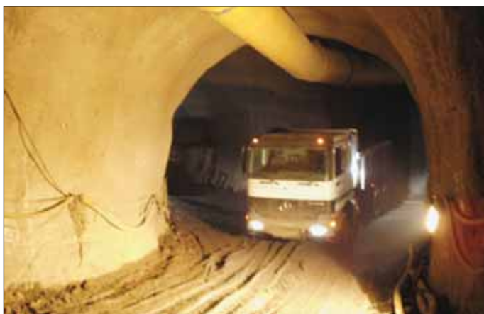
Obr. 4 Prístupová chodba k privádzacím do turbín – rozvádzačom Fig. 4 Access adit to headrace tunnels – distributors
