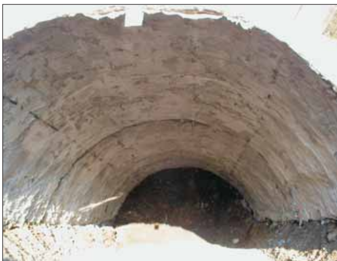
Obr. 4 Vytěžená kalota tunelu
