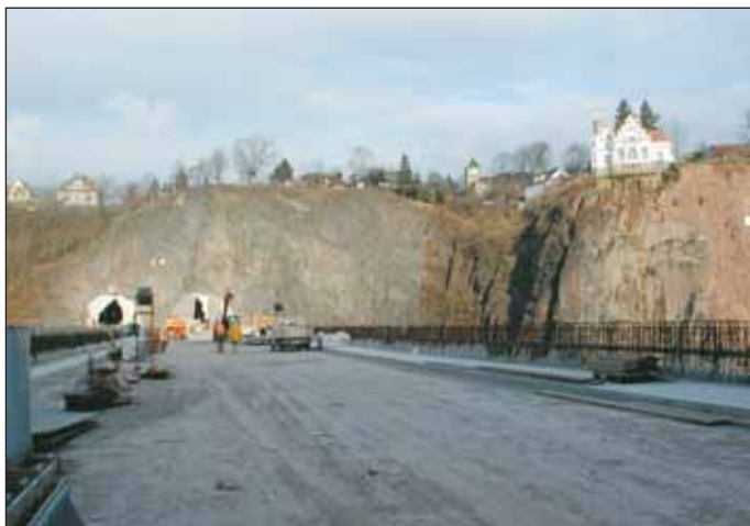
Obr. 5 Východný portál tunela Dölzsch Fig. 5 Portal East of the Dölzsch tunnel
