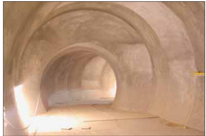
Obr. 15 Silniční tunel na letištní straně (ART) – místnost zabezpečení po dokončení
