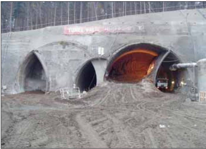
Obr. 6 Zahájení ražby hlavní kaloty JTT Fig. 6 Starting the excavation of the STT top heading
