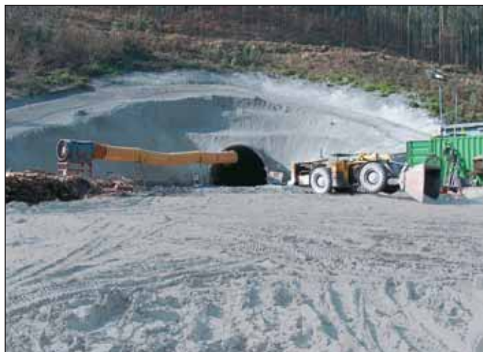
Obr. 1 Portál pro ražbu odvodňovací štoly
