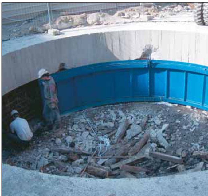
Obr. 5 Usazování bednění Fig. 5 Formwork setting
