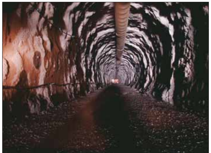
Obr. 3 Pohľad do odtokového tunela z podzemnej elektrárne Fig. 3 A view inside the discharge tunnel from the underground power plant
