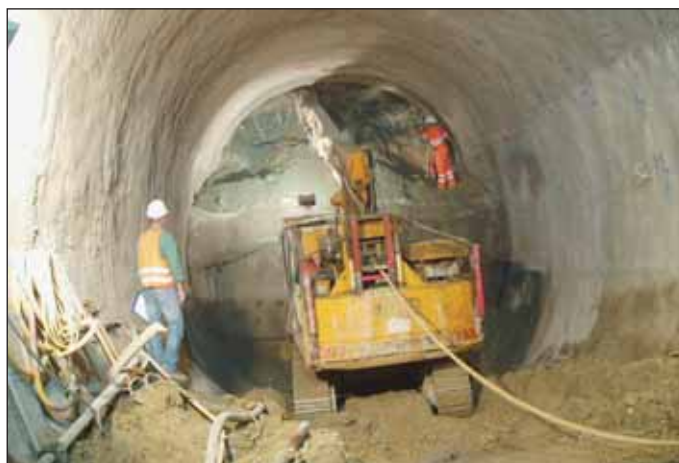
Obr. 5 Výlom kaloty tunelovým bagrom so záberom 1,0 m Fig. 5 Top heading excavation with a tunnel excavator; round length of 1.0m
