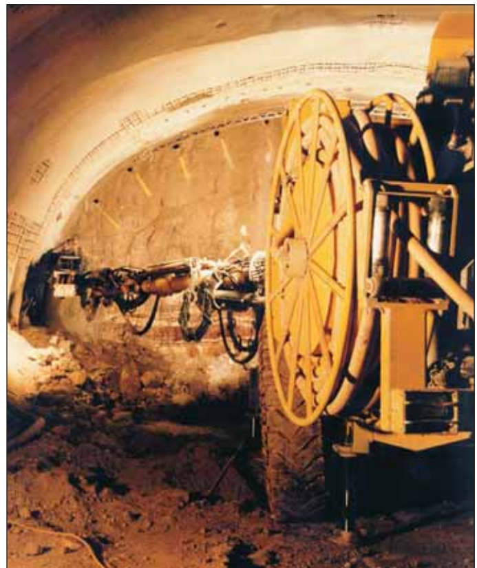
Obr. 6 Vrtanie špeciálneho mikropilotového dáždnika Fig. 6 Drilling for a special canopy pre-support
