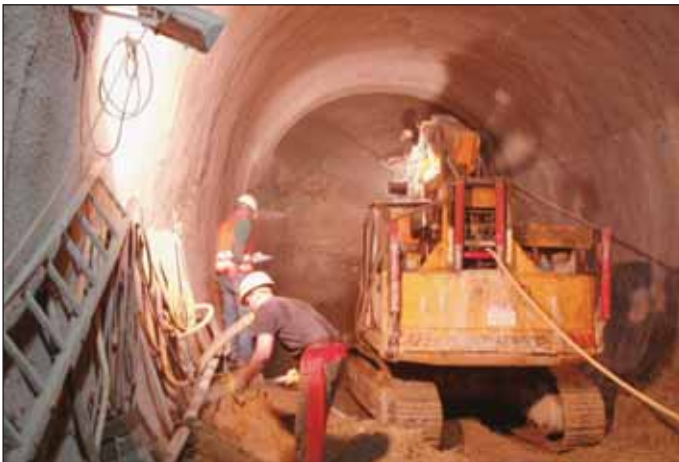
Obr. 7 Zaisťovanie výlomu striekaným betónom mokrou cestou Fig. 7 Excavation support by shotcrete – wet process
