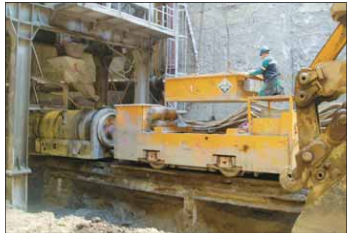
Obr. 8 Výroba mokrej zmesi SB a vyklápanie vozov umiestnené v štartovacej jame Fig. 8 Production of shotcrete wet mix and tipping of cars in the starting chamber
