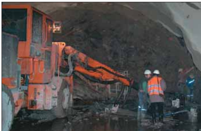
Obr. 4 Pohled na čelbu při ražbě kaloty tunelu
