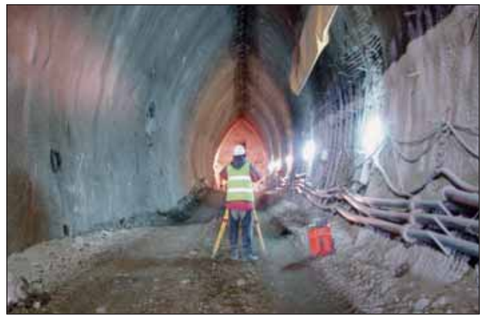
Obr. 9 Měření KVG bodů v bočním tunelu JTT Fig. 9 Measurement of CVG points in the STT
