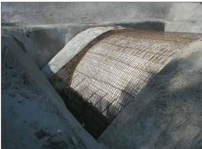
Obr. 3 Střídaně zabetonované bloky klenby výjezdového portálu Fig. 3 Staggered casting of vault blocks of the exit portal
