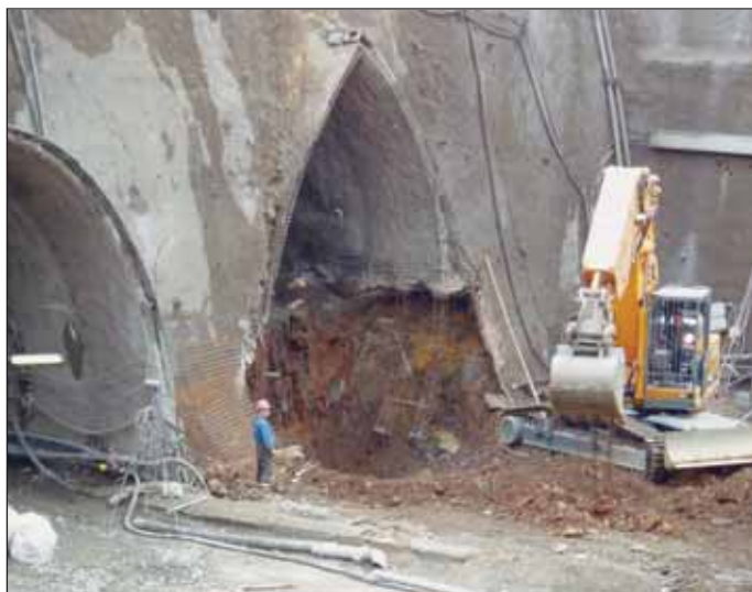
Obr. 5 Před výlomem střední části JTT v portálové rozvadovské oblasti Fig. 5 Bench excavation in the STT, in the Rozvadov portal section
