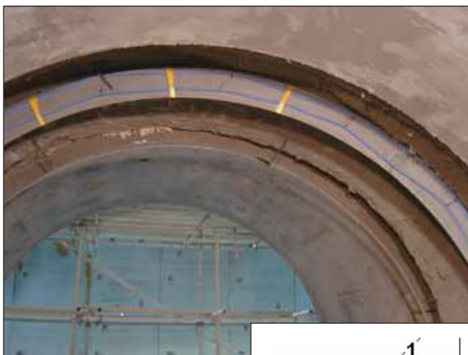
Obr. 9 „Budič spár“ před zastríkááním betonem
