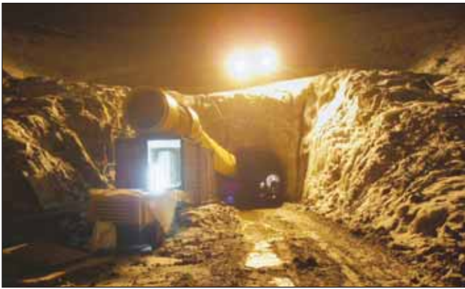
Obr. 2 Zárez portálu káblového tunela Fig. 2 Open trench at the portal of the cable tunnel
