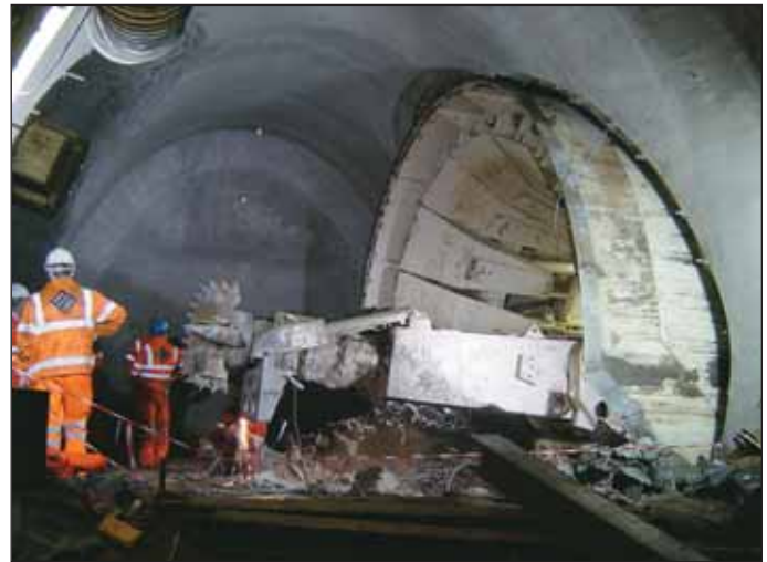
Obr. 12 Prorážka štítu Dosco do propojovací chodby T5C HEXEx Fig. 12 Dosco shield breakthrough in T5C HEXEx Downline cross-passage
