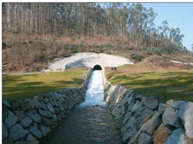
Obr. 2 Pohled na dokončený portál štoly
