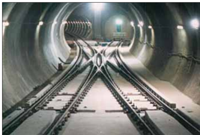
Obr. 1 Komora křížení železničních tratí tunelů Heathrow Express Fig. 1 Heathrow Express Crossover tunnel
