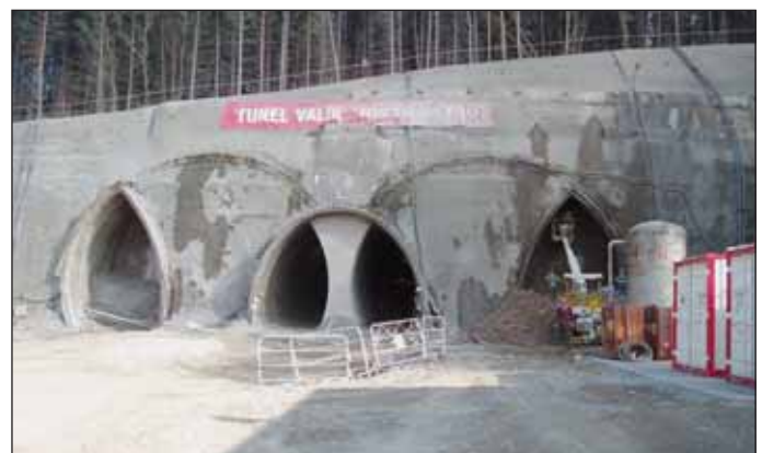
Obr. 4 Pohled na ražbu bočních tunelů STT a JTT a železobetonový pilíř Fig. 4 Excavation of the NTT and STT and the central pillar
