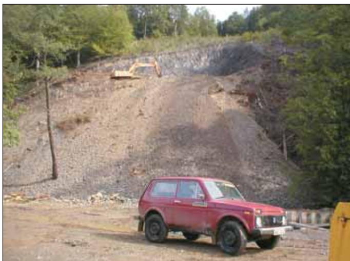
Obr. 1 Výkop zářezu vjezdového portálu Fig. 1 Open cut for the entrance portal
