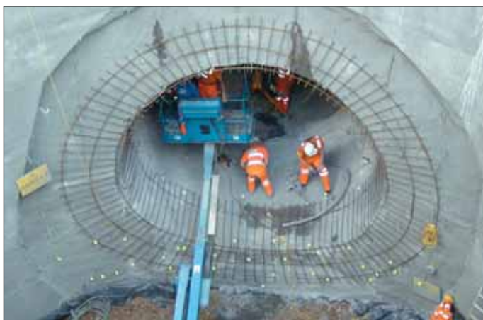
Obr. 8 Montáž výztuže v místě napojení tunelu (rozrážka horní propojky T5C ze šachty T5C PiccEx)
