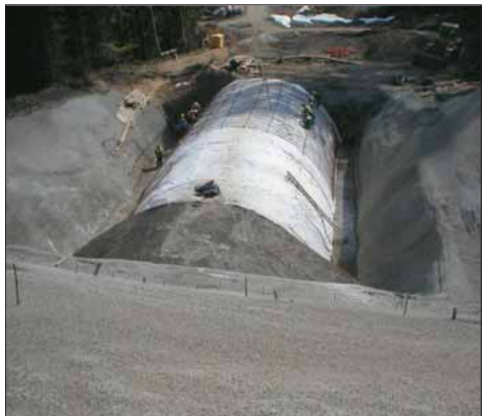
Obr. 2 Montáž armatury klenby výjezdového portálu Fig. 2 Placement of reinforcement of the exit portal
