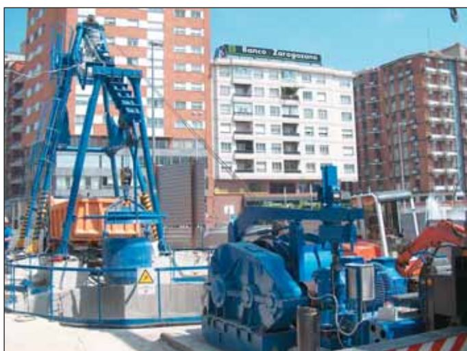
Obr. 3 Zahlubovací zařízení Kudlanka s vratem Fig. 3 Shaft sinking equipment "Kudlanka" with winding machine
