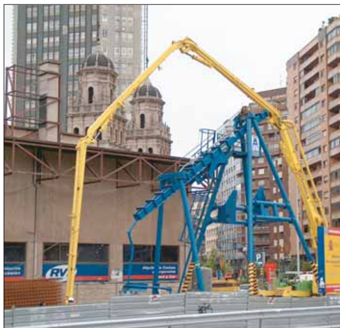
Obr. 2 Čtyřramenný separátní výložník pro betonáž Fig. 2 Four-arm separate boom for concrete placement
