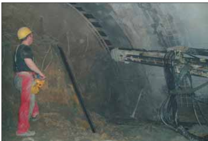
Obr. 4 Hnané paženie z ocelových plechov Fig. 4 Forepoling using steel sheets
